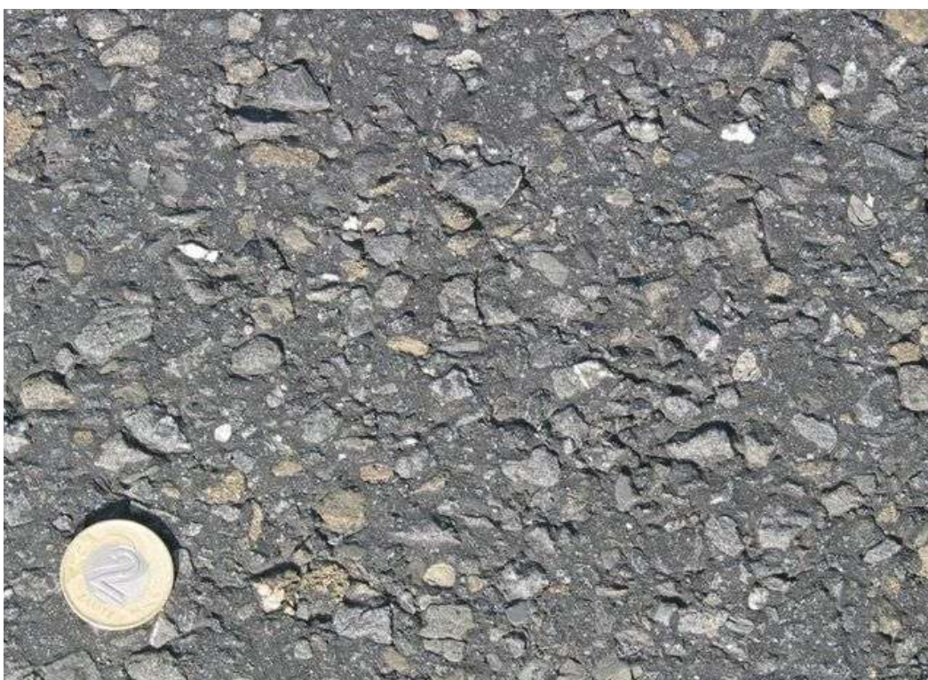
Foto 23 Widok nawierzchni na odcinku 16b, DK17 – Cienka warstwa na zimno
