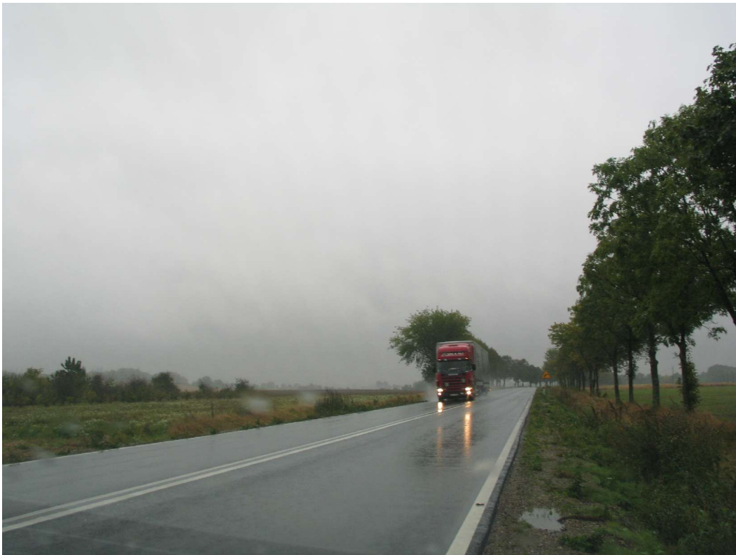
Foto 20 Widok odcinka badawczego nr 3, nawierzchnia z SMA12.
