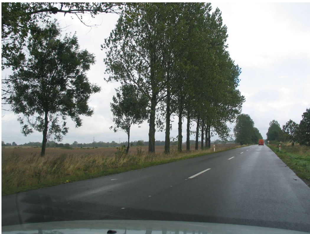
Foto 19 Widok odcinka badawczego nr 2, nawierzchnia z BA16.
