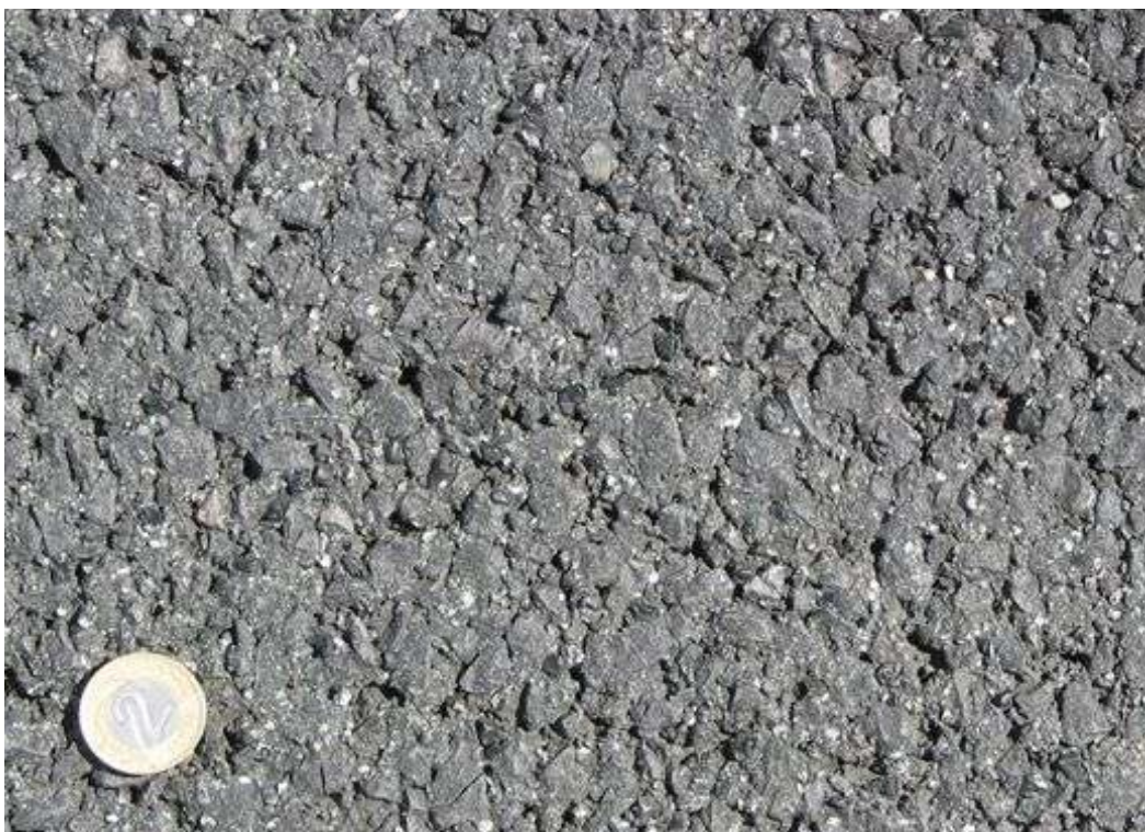
Foto 22 Widok nawierzchni na odcinku 15b, DK11 – Gufi
