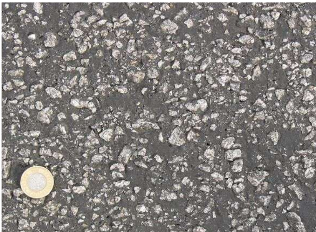
Foto 24 Widok nawierzchni na odcinku 17a, DW541 – Cienka warstwa na zimno
