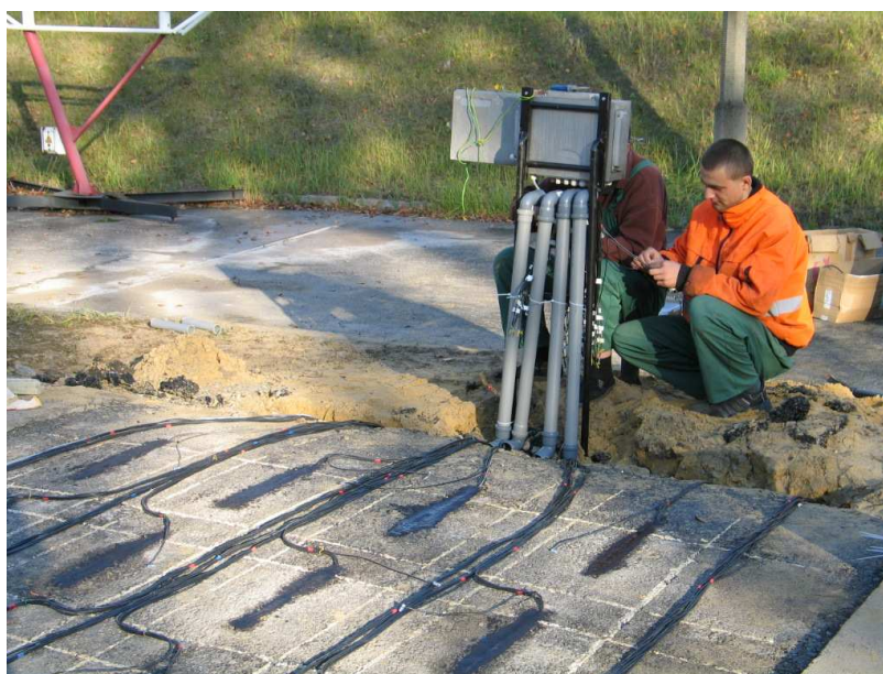
Rysunek 3.15 Montaż przewodów w skrzynce zbiorczej
