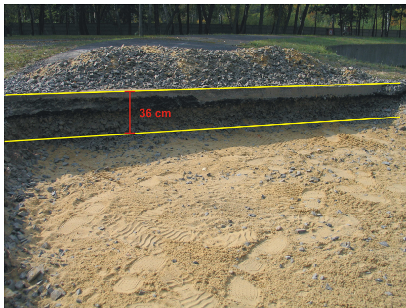
Rysunek 3.7 Przygotowanie warstwy odcinającej
