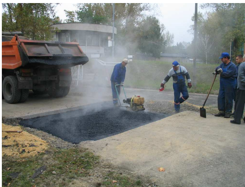
Rysunek 3.9 Wykonywanie warstwy wiążącej z betonu asfaltowego
