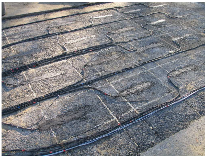
Rysunek 3.14 Wyprowadzenia wiązek przewodów z miejsc pomiarowych
