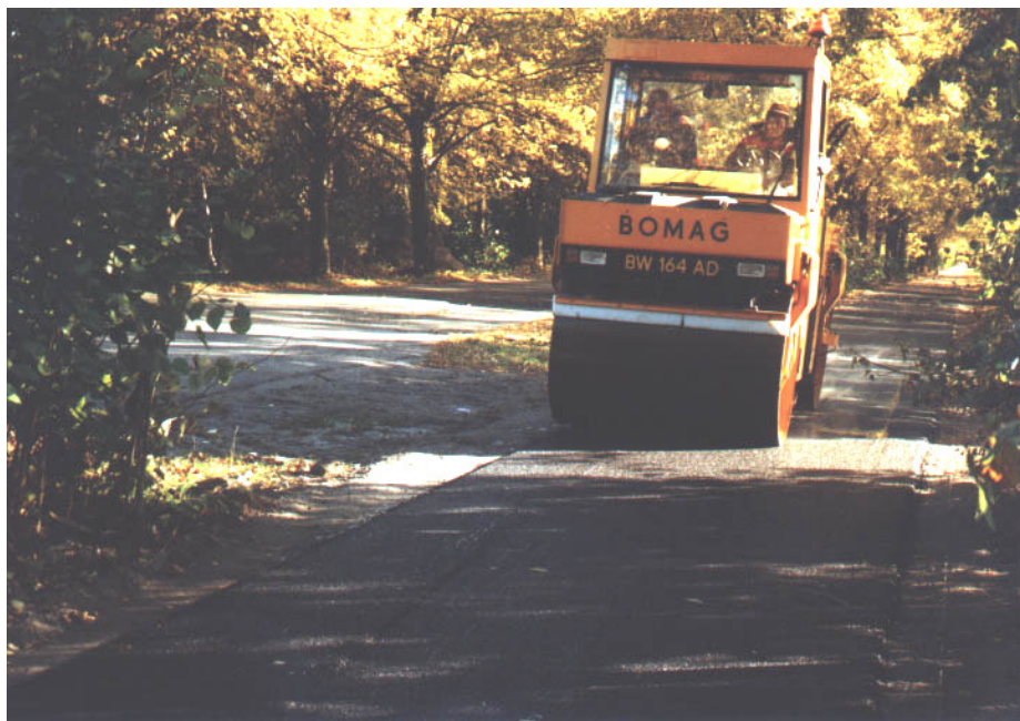
Fot 4. Układanie mieszanki MNU 0/6 mm z granulatem gumowym 2/7 mm
