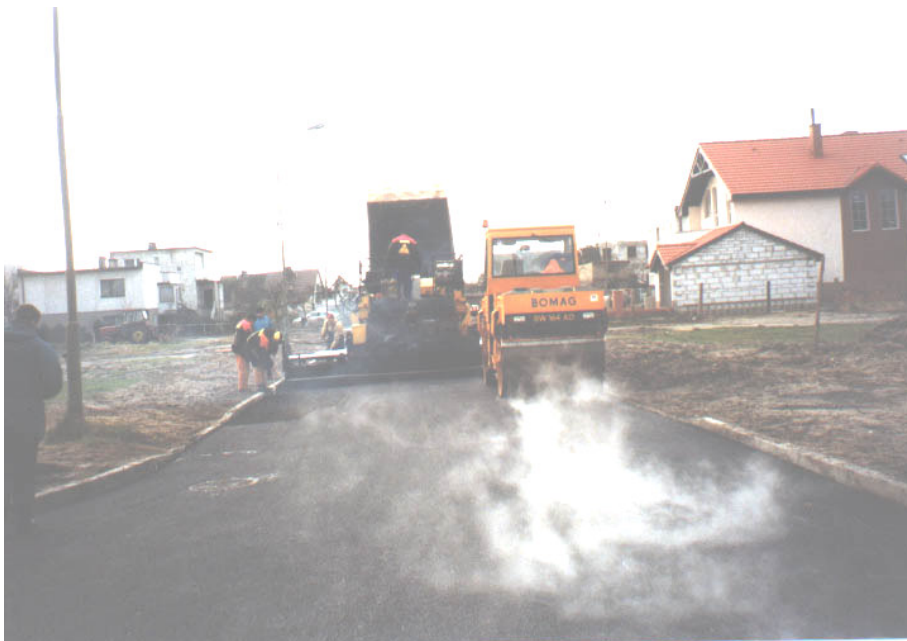
Fot 2. Układanie mieszanki SMA 0/12,8 mm z granulatem gumowym 0,1 mm
