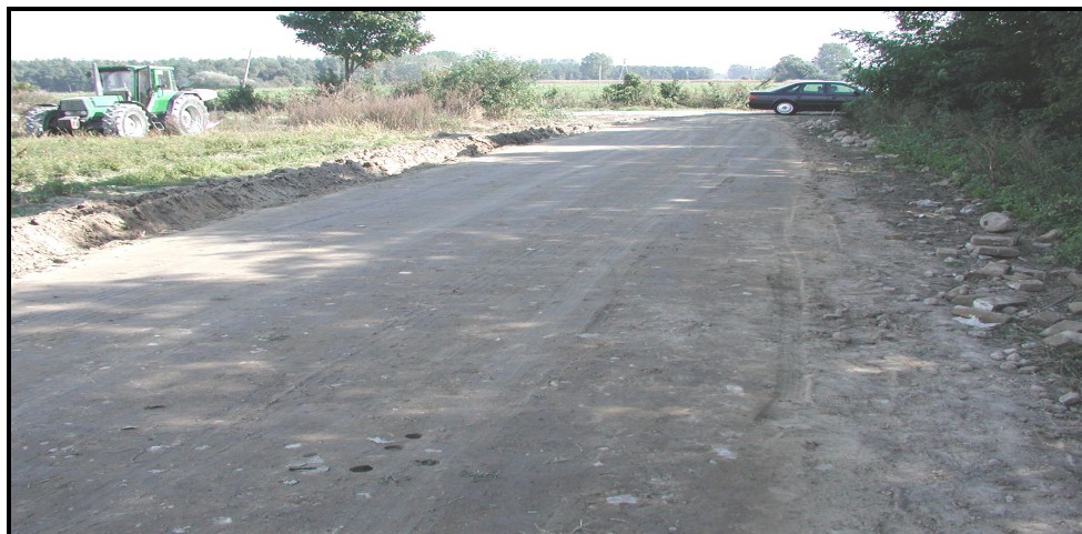
Fot. 1 – widok odcinka po wykonaniu przed przykryciem pospółką (październik 2002 r.)
