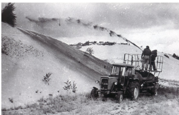
Fot. 34 Hydroobsiew - przykłady a), b) poprawnego wykonywania hydroobsiewu, c) deszczowania wykonywanego przed hydroobsiewem właściwym
