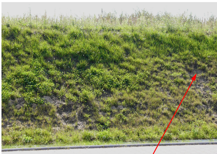
Fot. 7. Skarpa wykopu drogi w Luboniu o wystawie zachodniej (fot. B. Gajewska)
