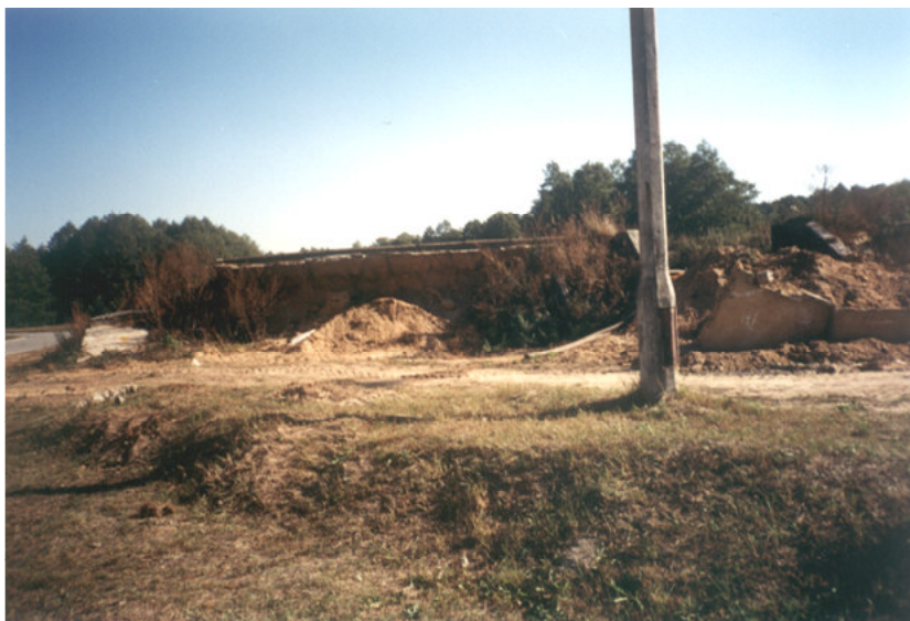
Fot. 31 Przykład nieprawidłowego składowania „humusu” (fot. M. Głazewski).
