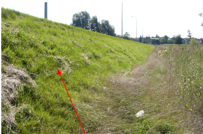
Fot. 9. Skarpa budowli 2 całkowicie pokryta roślinnością trawiastą (fot. B. Gajewska)
