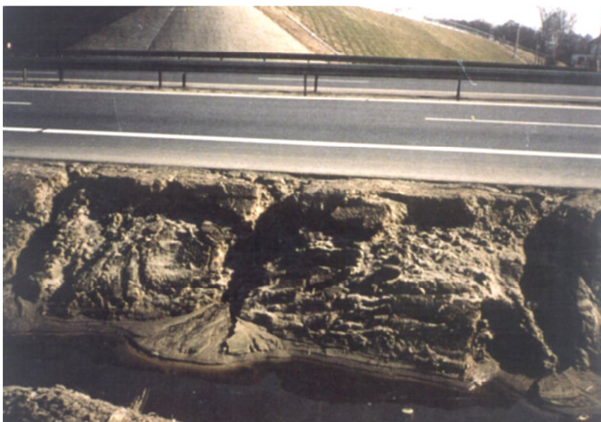
Rys. 26. Przykłady zniszczeń erozyjnych
