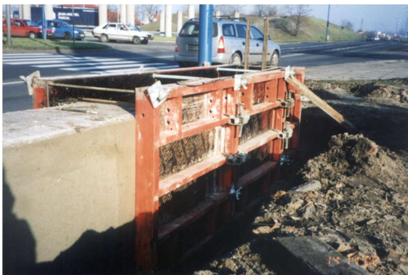
Fot. 13. Fundament pod ekran przeciwhałasowy w ciągu Trasy Toruńskiej (fot. B. Gajewska)
