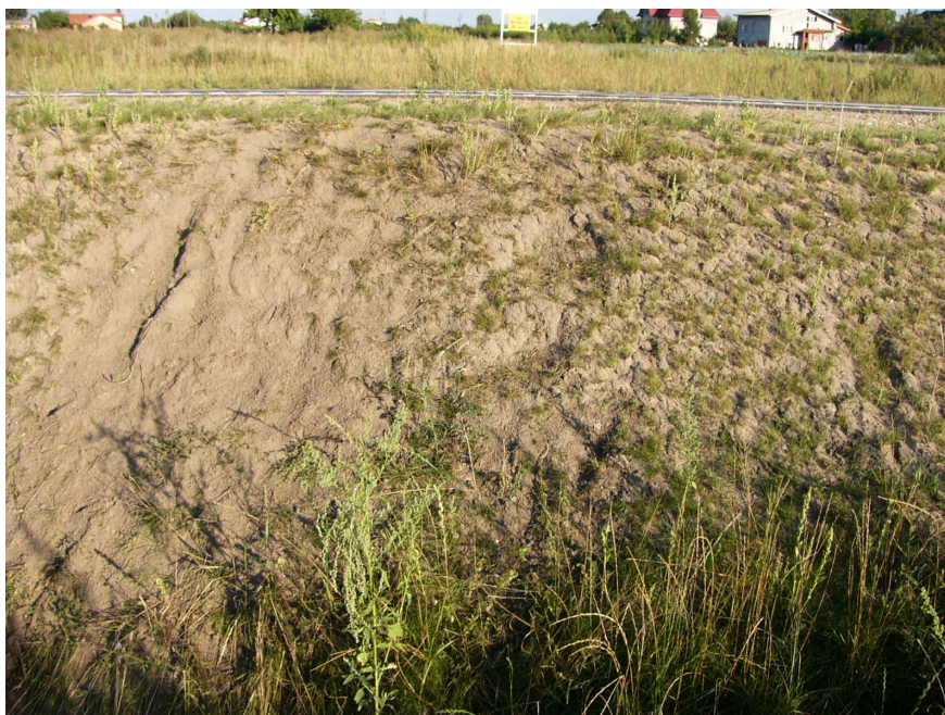
Fot. 11. Skarpa nasypu budowli 3 (fot. B. Gajewska)
