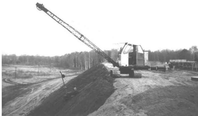
Fot. 22. Układanie „humusu” na powierzchni skarpy [17]
