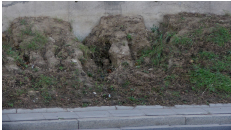
Fot. 15. Zerodowana skarpa budowli 4 (fot. B. Gajewska)
