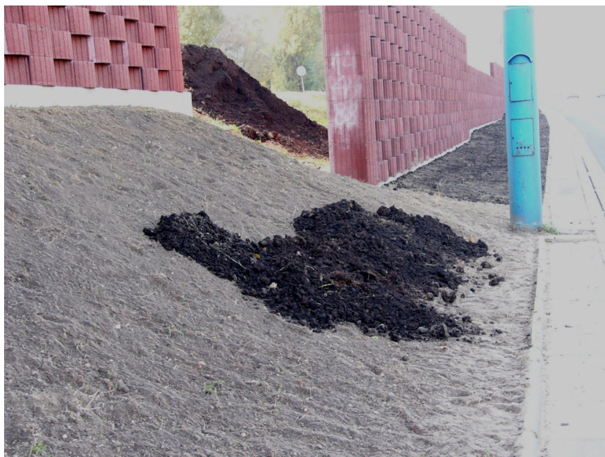
Fot. 17. Posypywanie zagrabionej skarpy „humusem” (fot. B. Gajewska)
