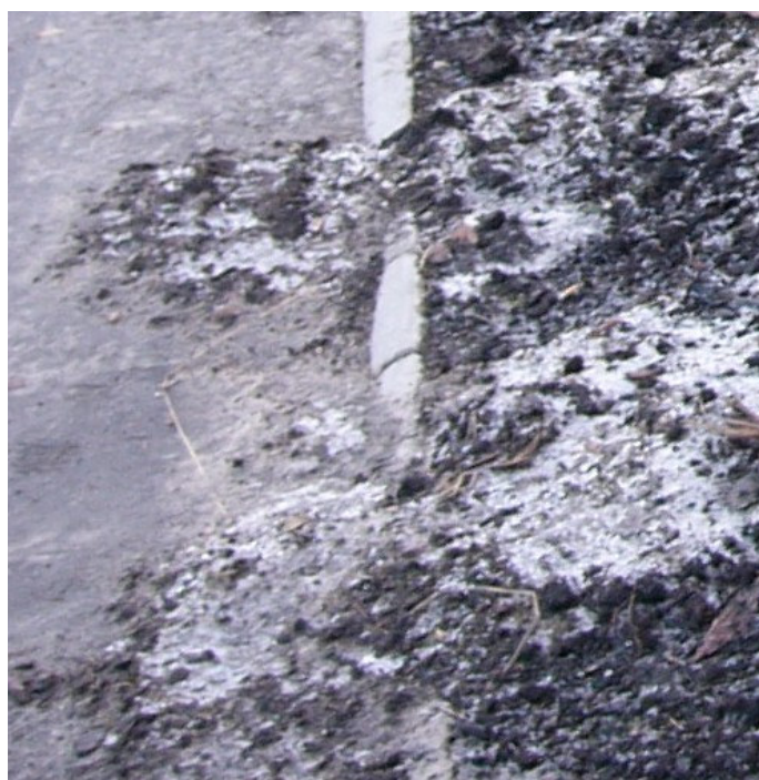
Fot. 19. Skarpa obiektu 4 w niecały miesiąc po dokonaniu napraw i ponownym wysiewie traw (fot. B. Gajewska)
