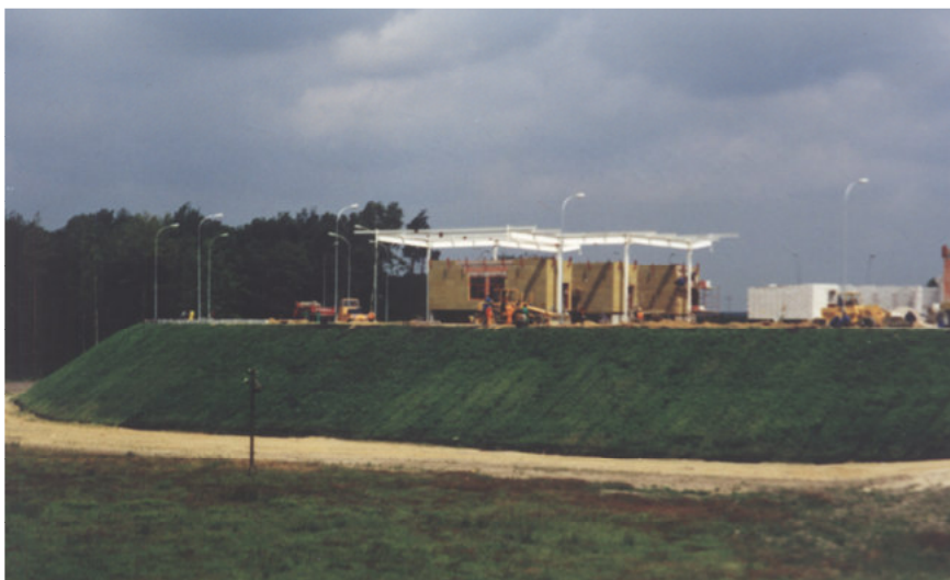
Fot. 29. Ogólny widok skarpy o wystawie południowej po 40 dniach od wykonania hydroobsiewu (w fazie 3-go listka) [17]
