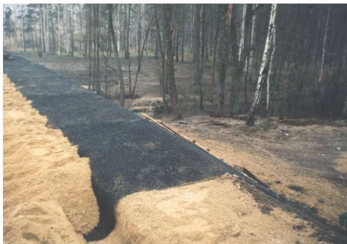
Fot. 24. Geomata była kotwiona na szczycie skarp w rowkach kotwiących [17]
