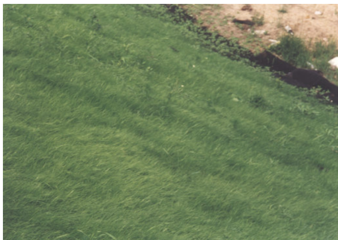
Fot. 26. Stopień pokrycia skarp roślinnością trawiastą w fazie 3-go listka, po 40 dniach od wykonania hydroobsiewu [17]
