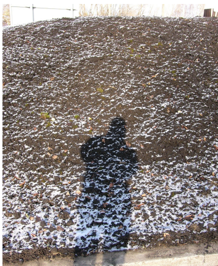
Fot. 21. Widok skarpy, na której „humus” został dogęszczony (fot. B. Gajewska)
