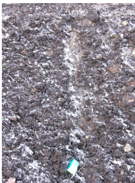
Fot. 20. Bruzda erozyjna na powierzchni „naprawionej” skarpy obiektu 4 (fot. B. Gajewska)
