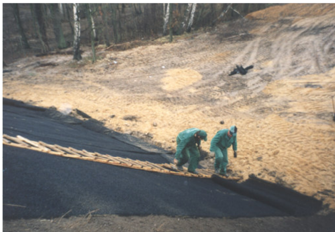
Fot. 25. Podczas mocowania geomaty do gruntu robotnicy przemieszczali się po ułożonej na jej powierzchni drabinie [17]
