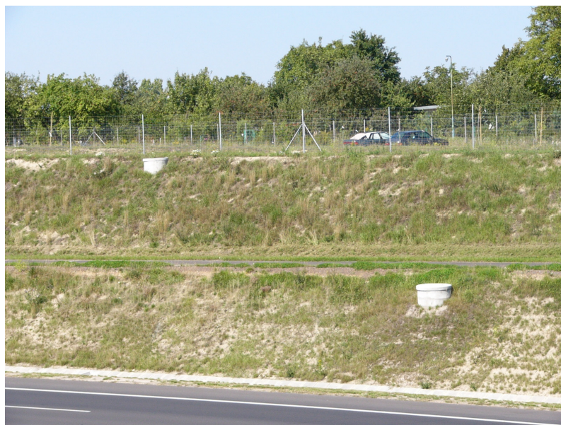
Fot. 5. Skarpy budowli 1 o wystawie południowej (fot. B. Gajewska)
