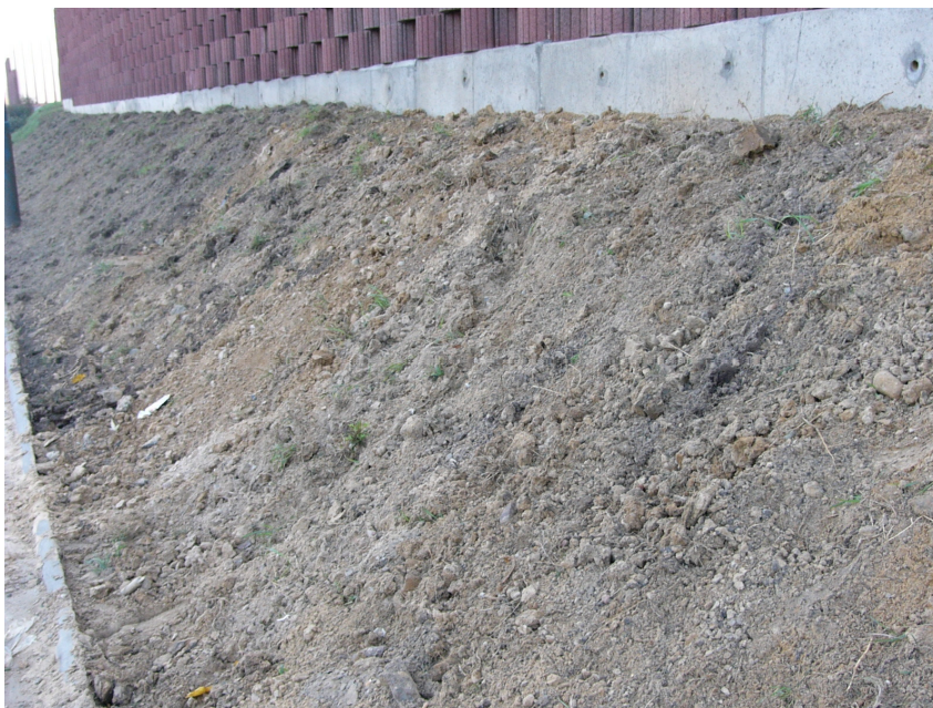
Fot. 16. Powierzchnia skarpy budowli 4 po zgrubnym wyrównaniu (fot. B. Gajewska)
