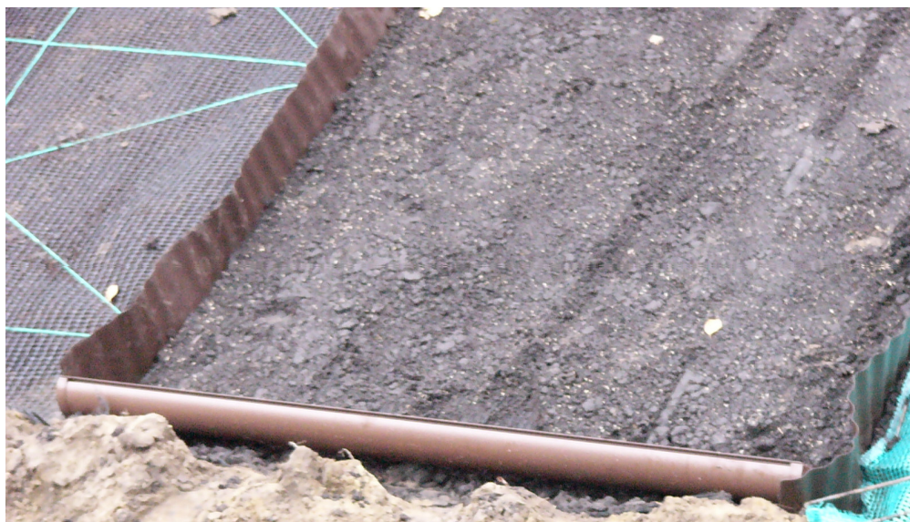
Rys. 57. Mocowanie rynny w dolnej części skarpy (fot. B. Gajewska)
