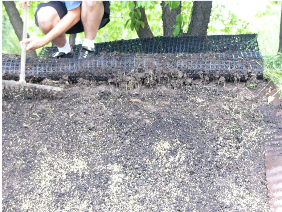
Rys. 70. Zagrabianie powierzchni skarpy (fot. B. Gajewska)
