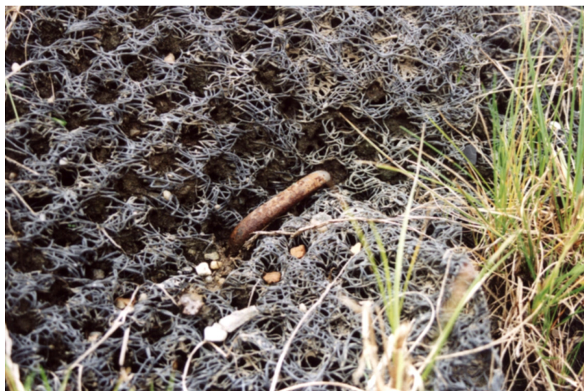
Rys. 24. Szpilka kotwiąca geomatę do powierzchni skarpy (fot. B. Gajewska)
