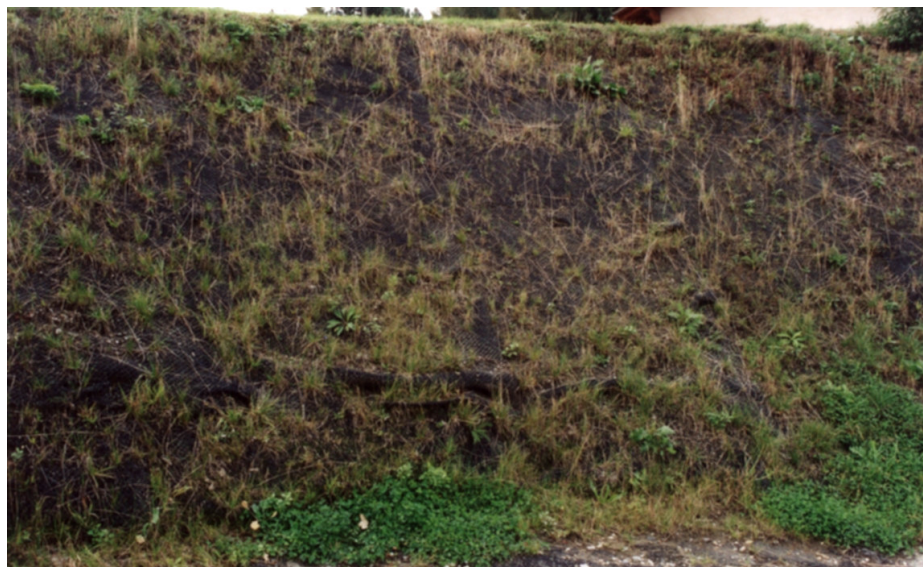
Rys. 21. Widok skarpy zabezpieczonej przed erozją powierzchniową za pomocą geomaty VHVD (fot. B. Gajewska)
