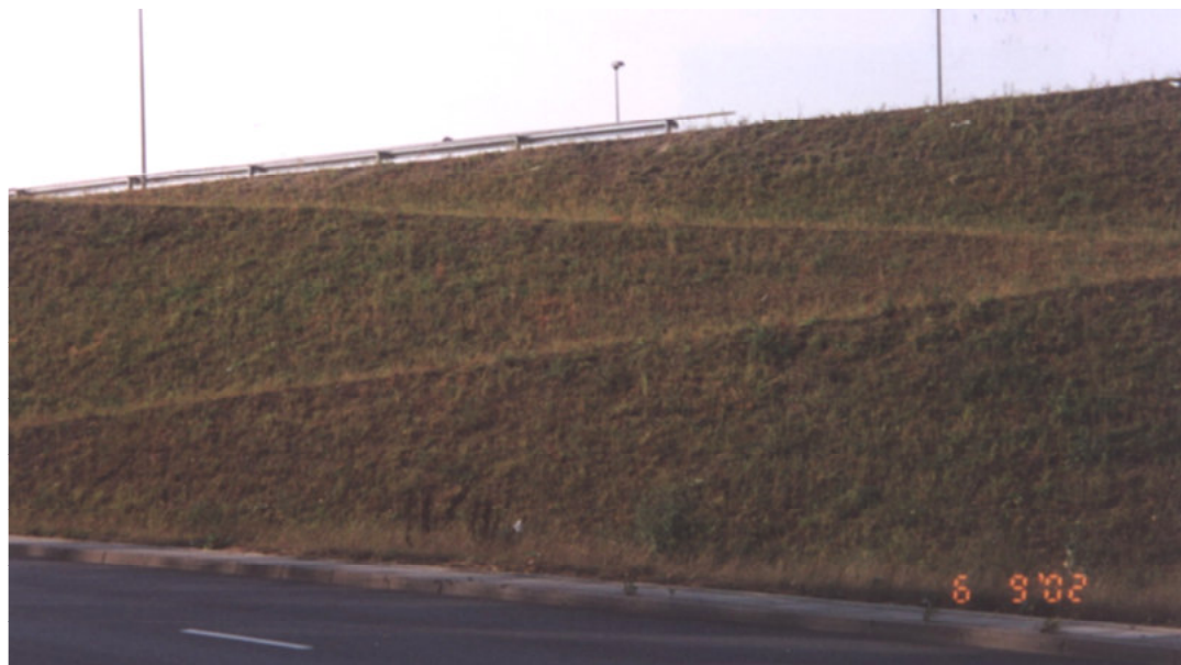
Rys. 8. Widok skarpy północnej budowli 1 (fot. B. Gajewska)
