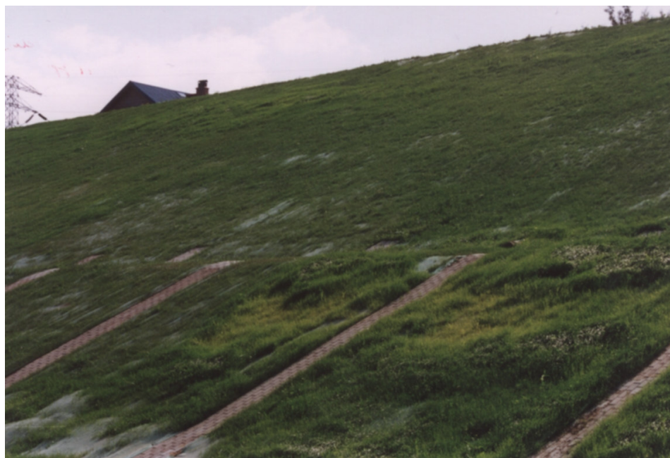
Rys. 17. Skarpa północno-wschodnia budowli 3 (fot. B. Gajewska)
