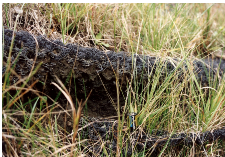
Rys. 22. Fragment skarpy ze sfaldowaną geomatą VHVD (fot. B. Gajewska)
