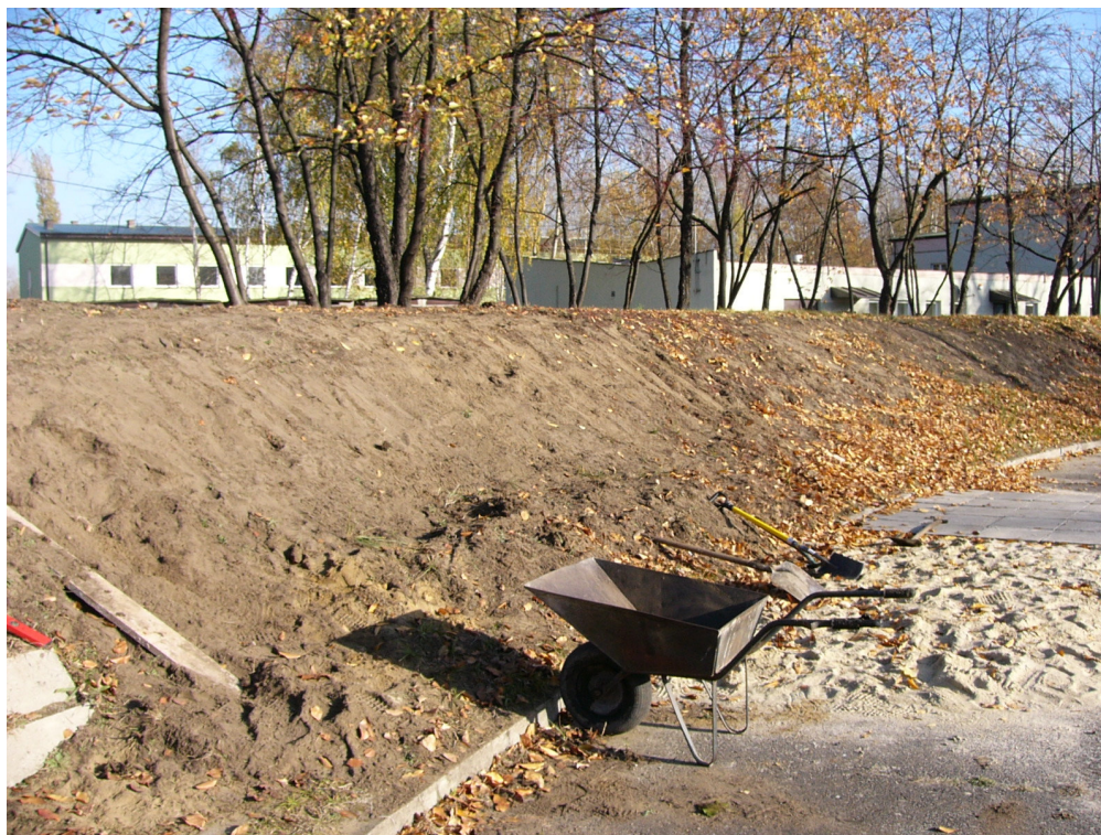
Rys. 41. W celu nadania skarpie odpowiedniego pochylenia podcięto jej dolną część (fot. B. Gajewska)
