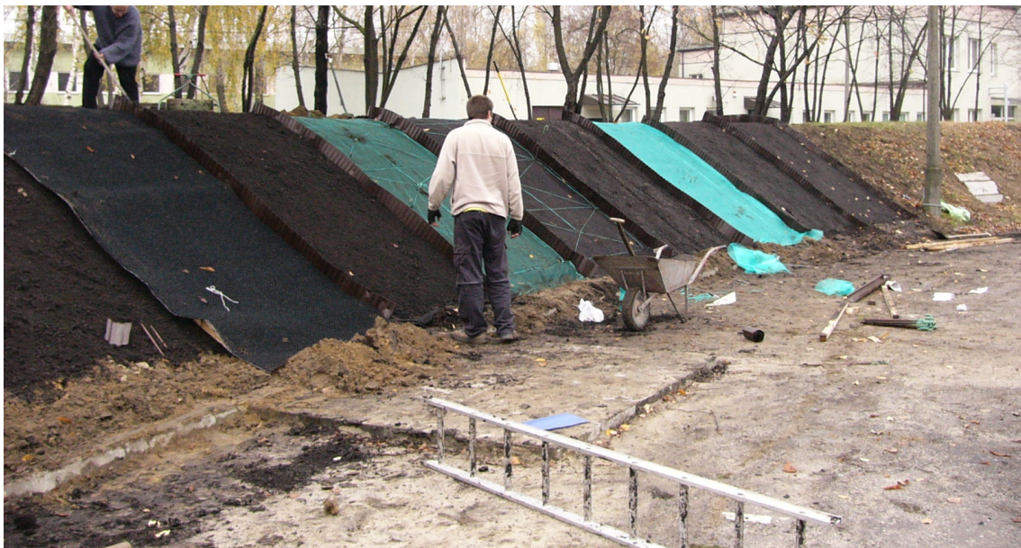
Rys. 56. Wypełnianie geomaty humusem (fot. B. Gajewska)
