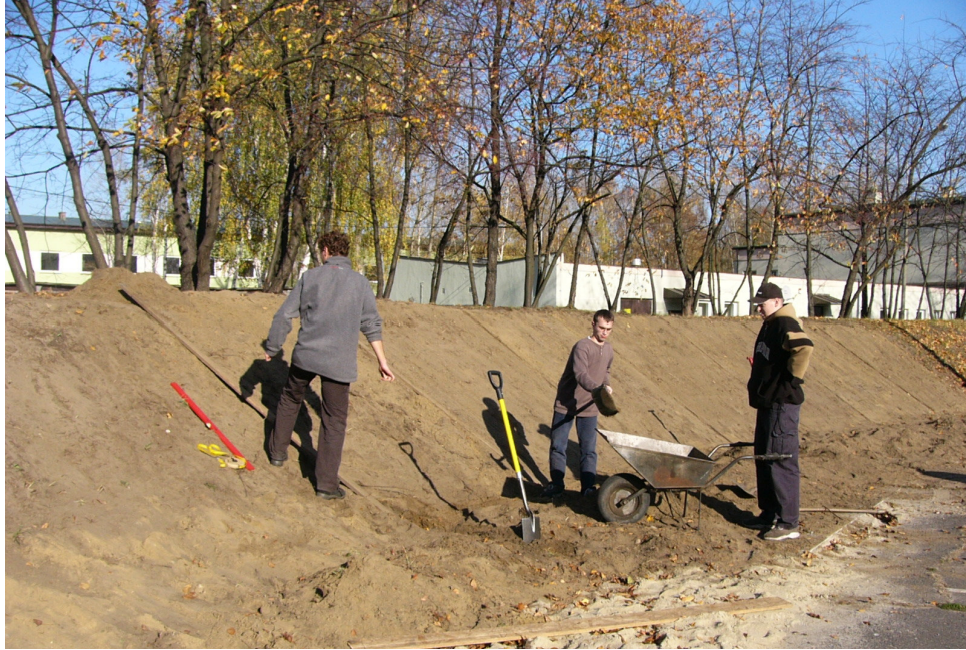
Rys. 42. Formowanie skarpy (fot. B. Gajewska)
