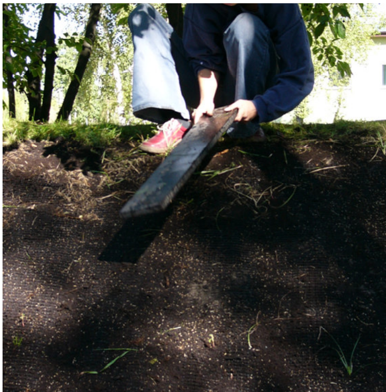
Rys. 78. Dogęszczanie powierzchni poletka po podsiewie (fot. M. Gajewski)
