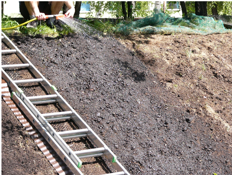
Rys. 69. Obfite podlewanie powierzchni skarpy (fot. B. Gajewska)
