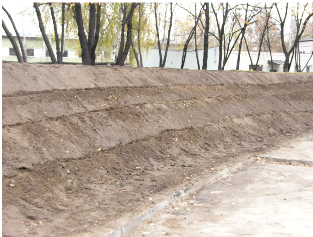
Rys. 45. Rowki podłużne na powierzchni skarpy (fot. B. Gajewska)
