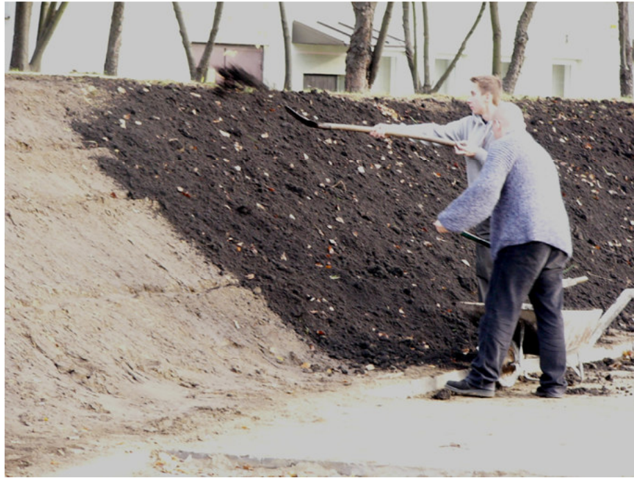
Rys. 46. Układanie humusu na skarpie (fot. B. Gajewska)
