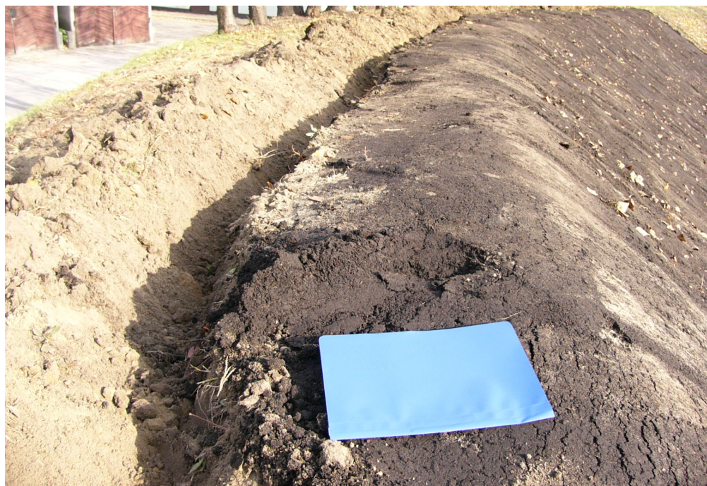
Rys. 48. Rowek kotwiący na szczycie skarpy (fot. B. Gajewska)
