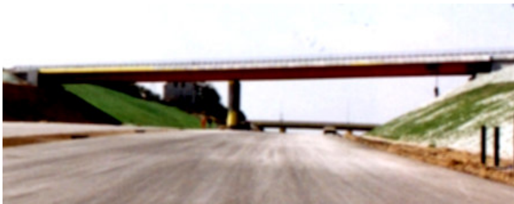
Rys. 15. Widok skarp budowli 3 zabezpieczanych przed erozją powierzchniową z użyciem geosiatek SLOVARM (fot. B. Gajewska)
