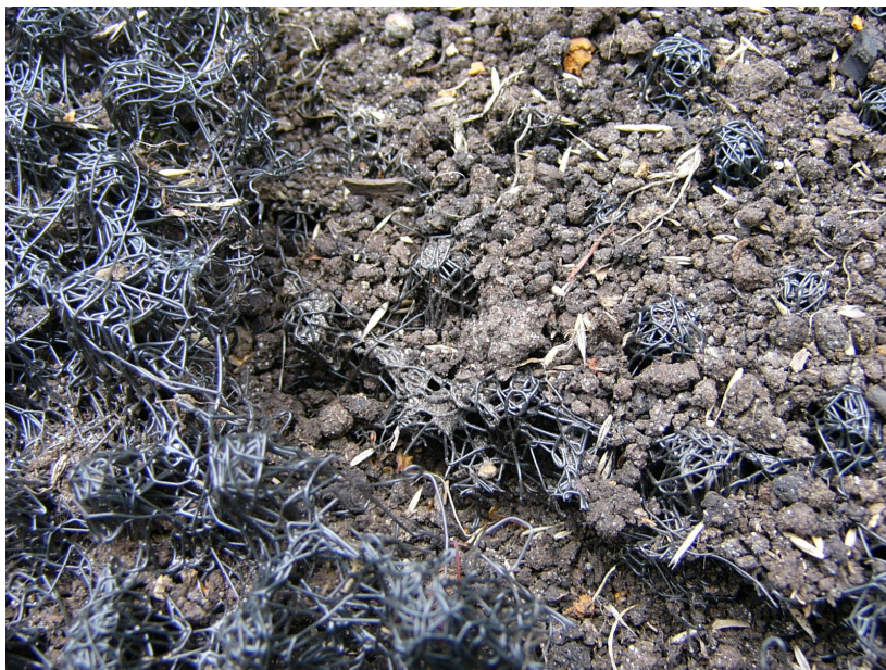
Rys. 87. Rozerwana geomata na poletku nr 9 (12 sierpnia) (Fot. B. Gajewska)
