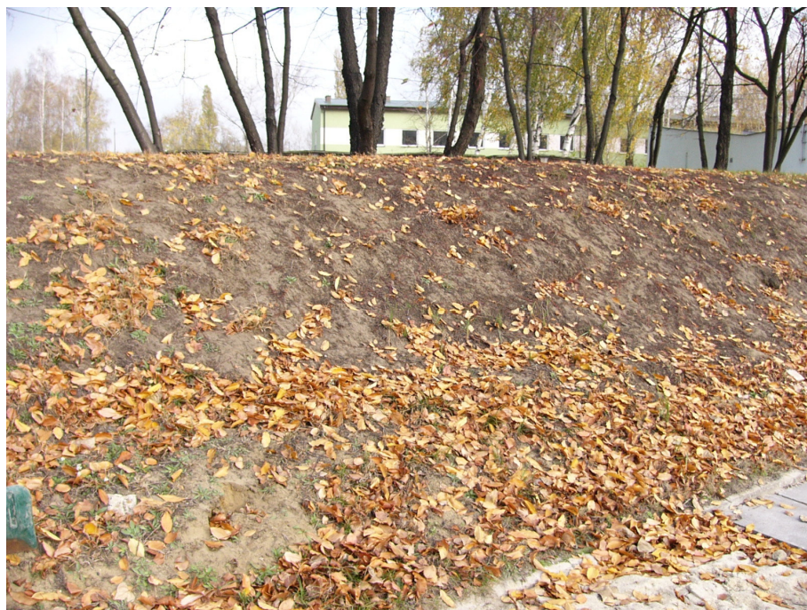
Rys. 40. Widok skarpy przed przystąpieniem do robót (fot. B. Gajewska)
