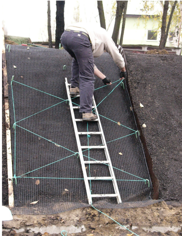
Rys. 55. Mocowanie sznurka w systemie INORGREENING firmy INORA (fot. B. Gajewska)
