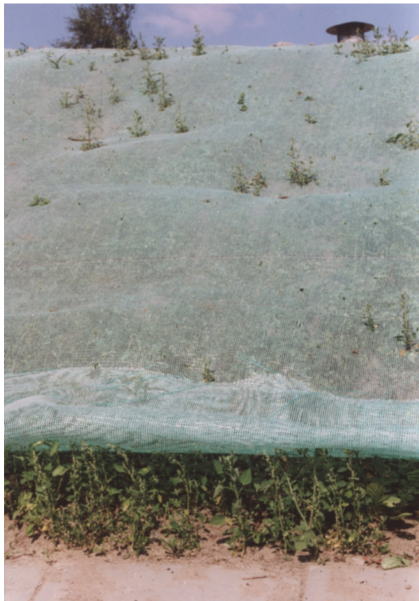
Rys. 19. Geosiatka uniesiona przez rośliny dwuliścienne (fot. B. Gajewska)
