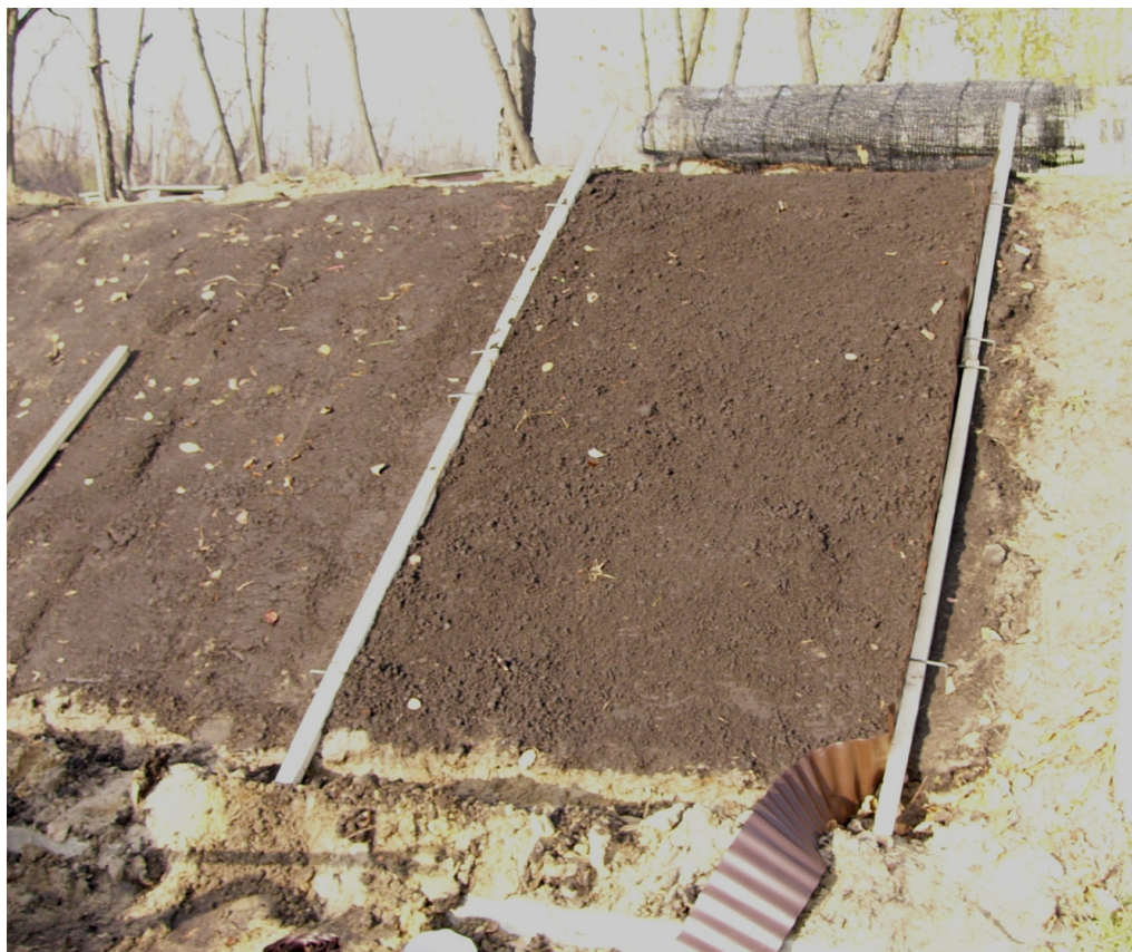
Rys. 49. Poletko przygotowane do układania geosyntetyku; na górze zwinięte pasmo geosyntetyku zakotwione w rowku kotwiącym (fot. B. Gajewska)
