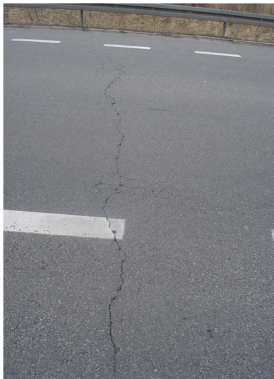
Fotografia 5.3. Spękanie poprzeczne, nieregularne (DK 6)
