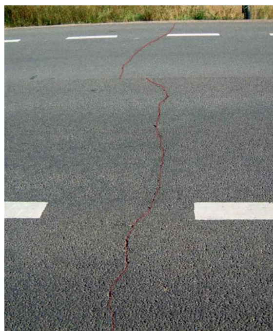
Fotografia 5.10 Spękanie poprzeczne (DK 5/10)
