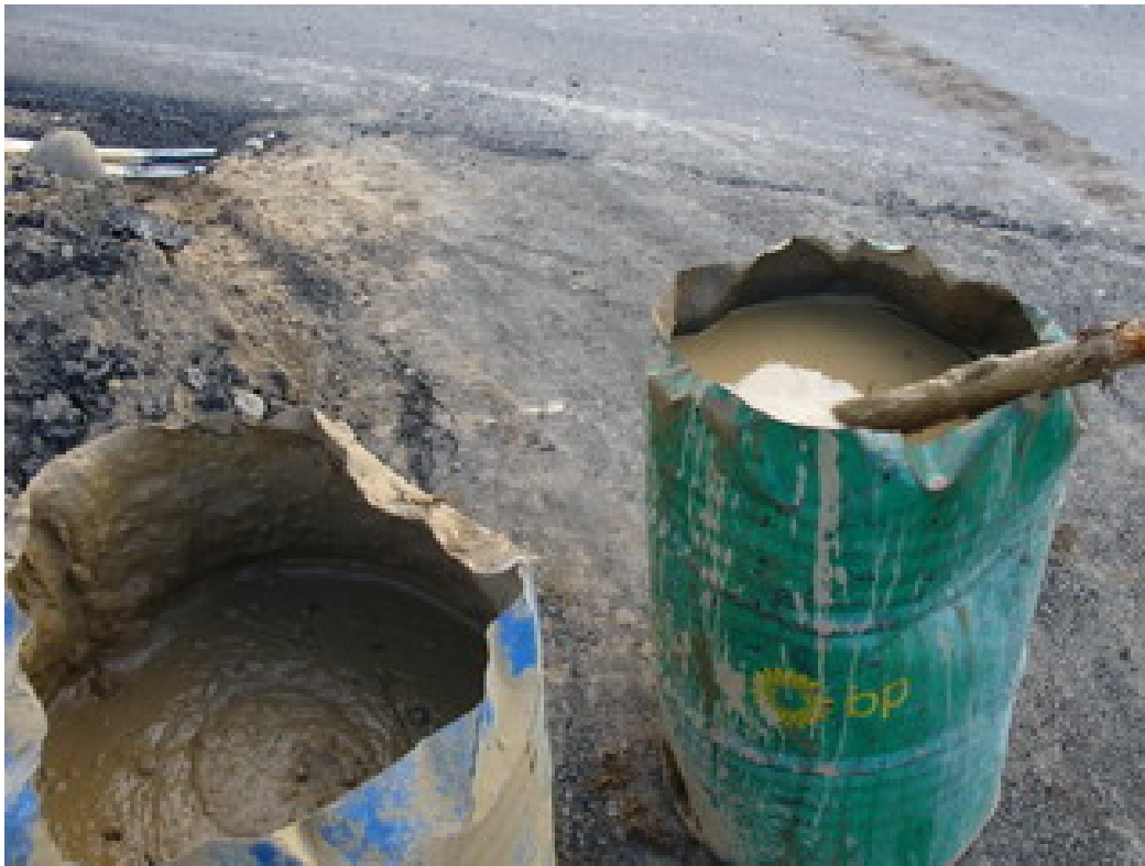
Rysunek 4.10. Widok przygotowanego zaczynu gliniastego do warstwy szepnej
