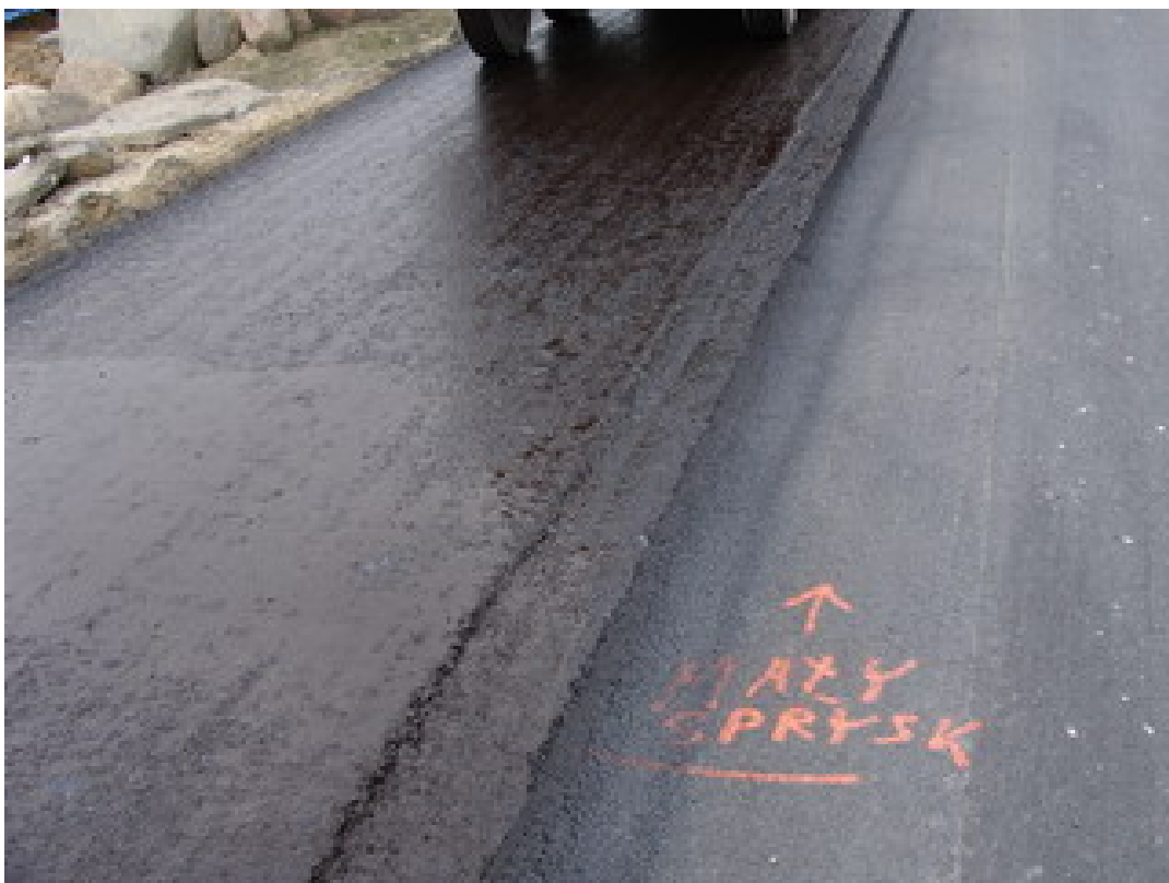
Rysunek 4.13. Sprysk z emulsji asfaltowej. Granica różnej ilości sprysku międzywarstwowego.
