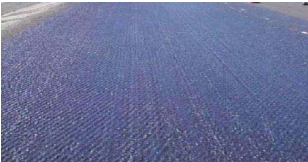
Rysunek 2.4. Właściwie wykonana, równomiernie rozpylona warstwa szepna
