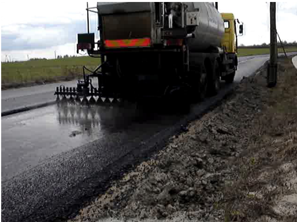
Rysunek 4.7. Widok spryskiwarki podczas wykonywania sprysku międzywarstwowego
