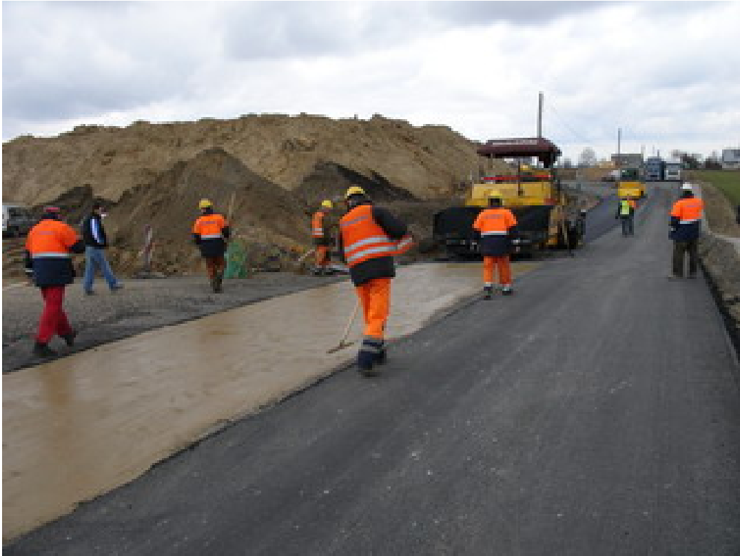
Rysunek 4.12. Gotowa warstwa szepna z zaczynu gliniastego
