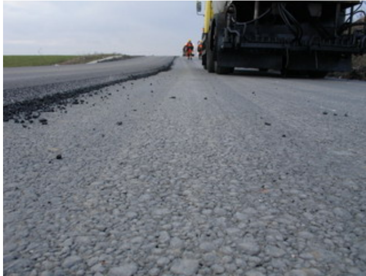
Rysunek 4.4. Widok przygotowanego podłoża (warstwy niższej leżącej) pod sprysk międzywarstwowy
