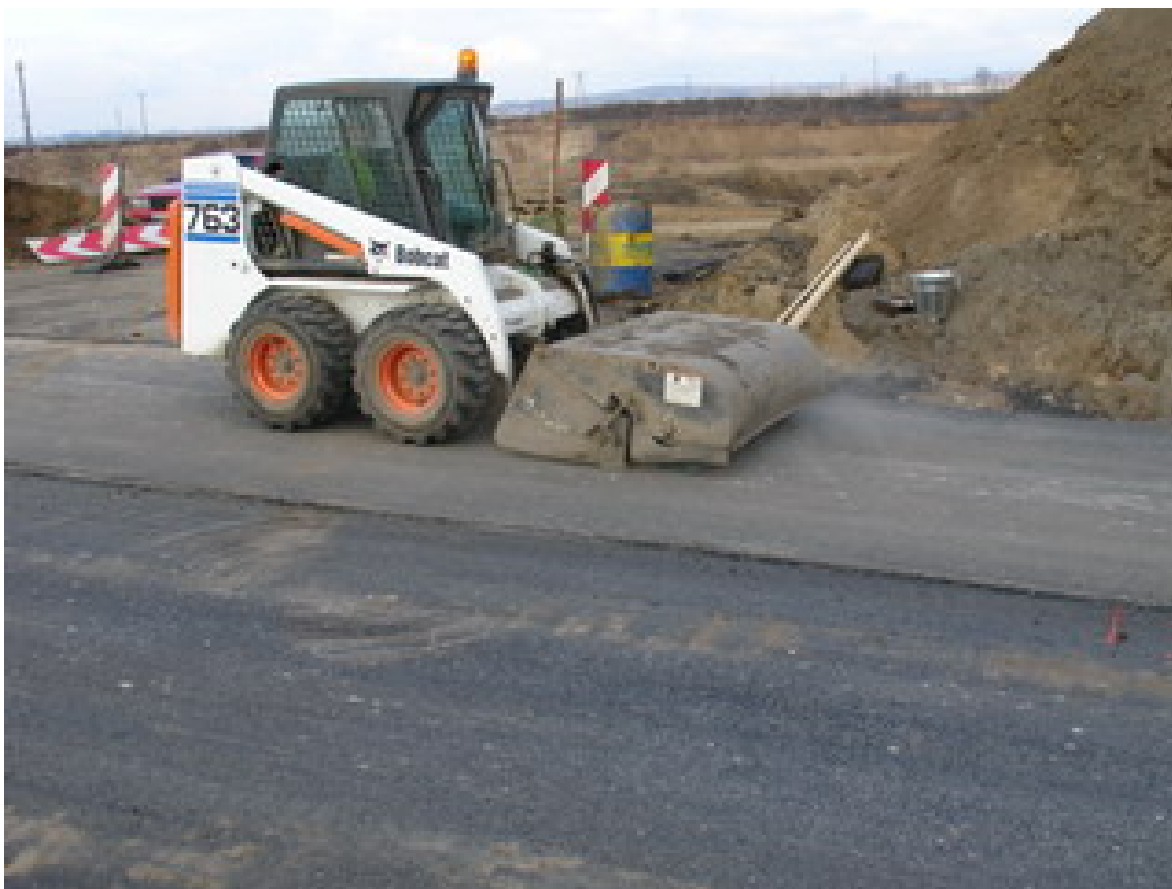
Rysunek 4.1. Oczyszczenie podłoża (warstwy niżej leżącej) mechaniczną szczotką pod sprysk międzywarstwowy
