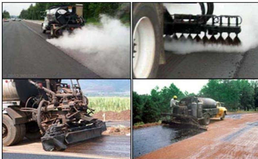
Rysunek 2.2. Wykonywanie warstwy szepnej, proces automatyczny.
