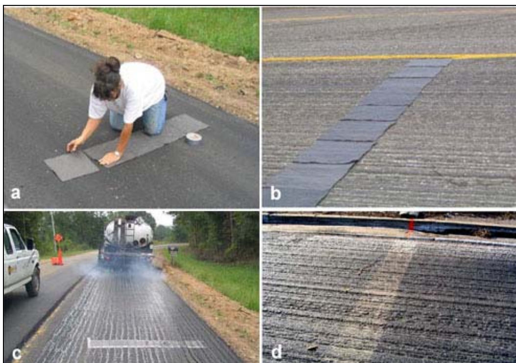
Rysunek 2.5. Kontrola wielkości sprysku: a) i b) ułożenie podkładek z geowłókniny, c) sprysk, d) "czyste" miejsce po zdjęciu podkładek
