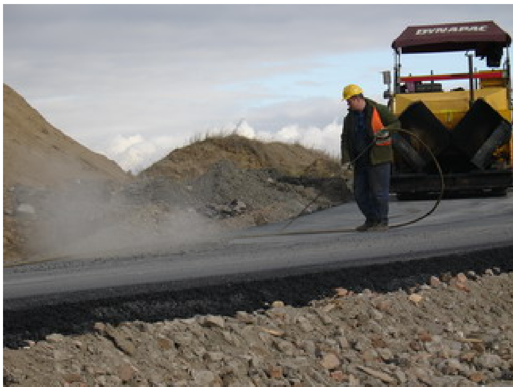
Rysunek 4.2. Oczyszczenie podłoża (warstwy niżej leżąca) sprężonym powietrzem pod sprysk międzywarstwowy
