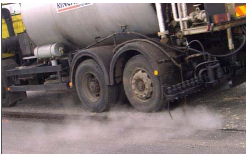
Rysunek 2.3. Sprysk szwu technologicznego
