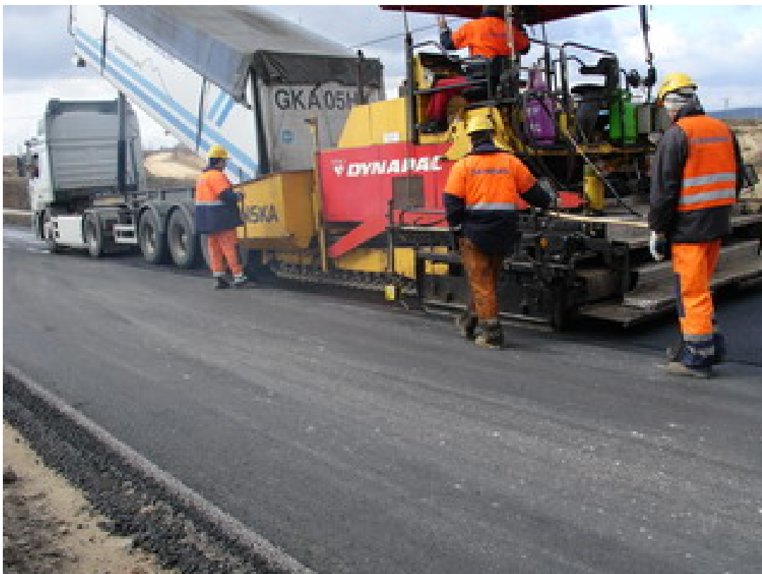
Rysunek 4.15. Wbudowywanie warstwy wiążącej z betonu asfaltowego na przygotowane warstwy szpewnej
