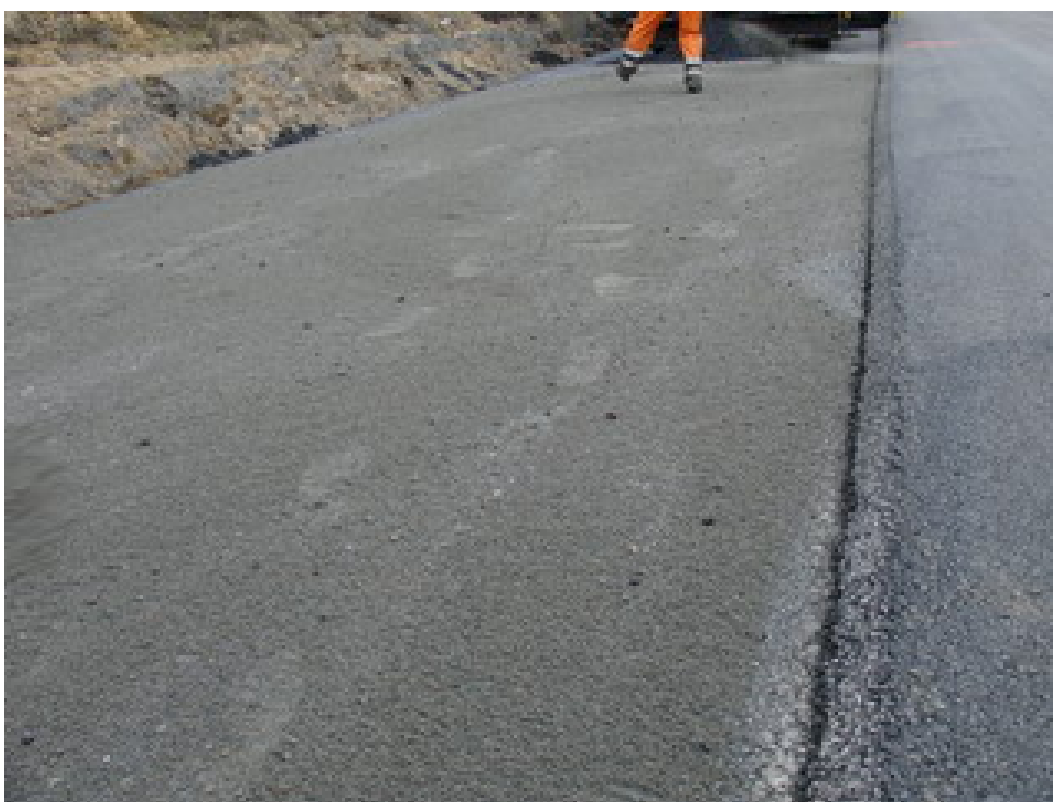
Rysunek 4.9. Widok warstwy szepnej z pyłów z odpylania WMB
