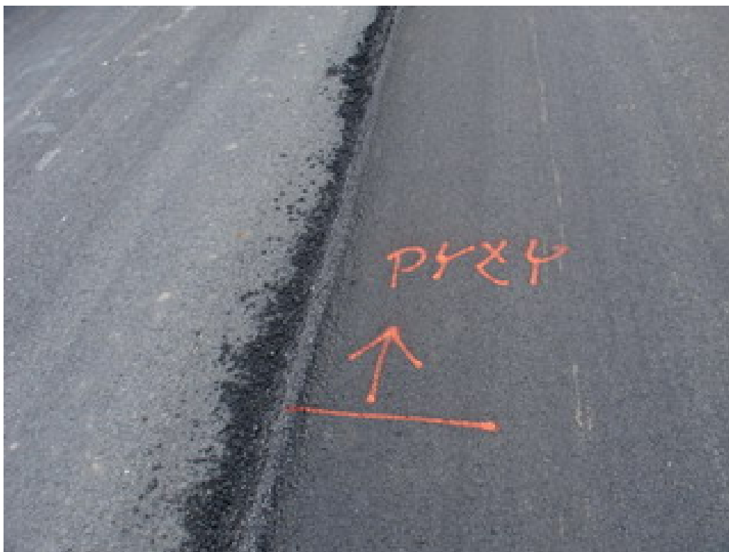
Rysunek 4.8. Widok przygotowanego podłoża warstwy podbudowy pod warstwę szepną z pyłów z odpylania WMB
