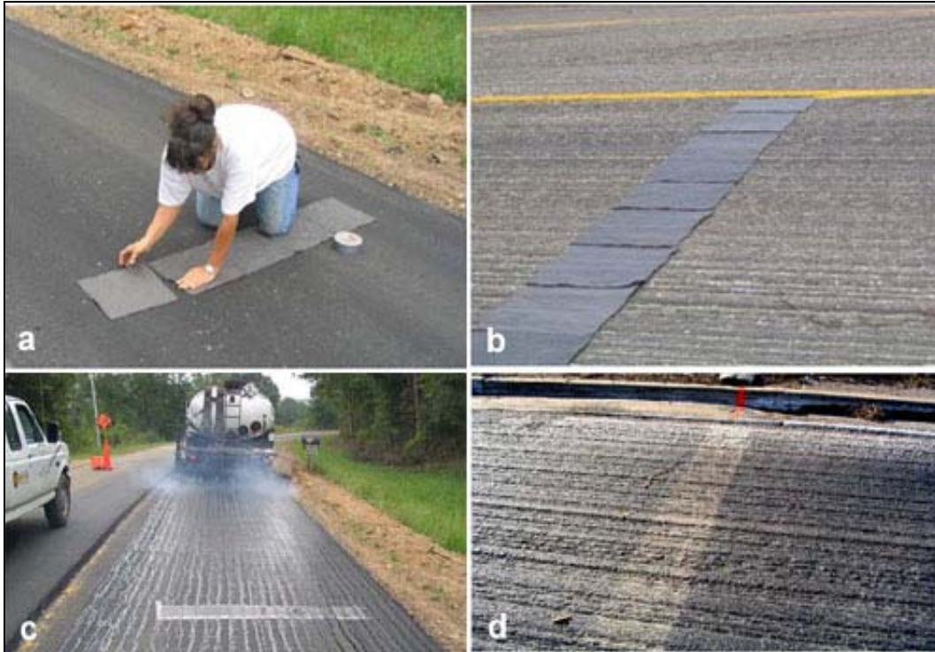
Rysunek 1. Kontrola wielkości sprysku: a) i b) ułożenie podkładek z geowłókniny, c) sprysk, d) "czyste" miejsce po zdjęciu podkładek
