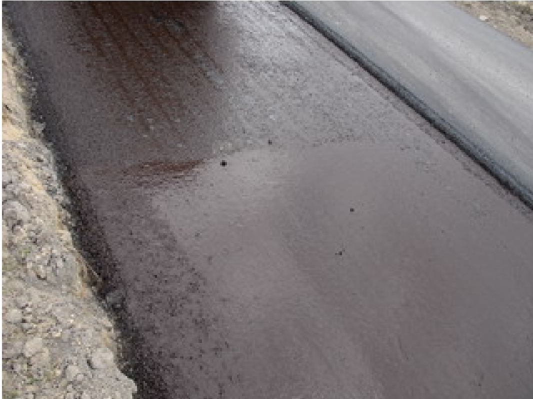
Rysunek 4.14. Sprysk z emulsji asfaltowej. Granica różnej ilości sprysku międzywarstwowego.
