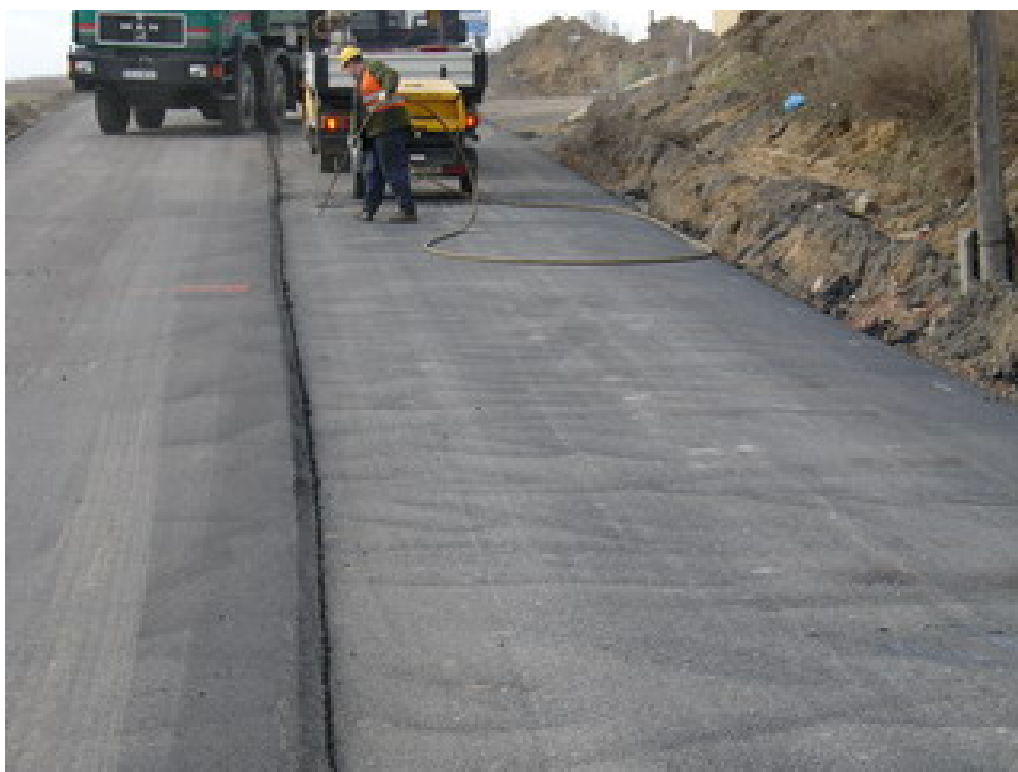
Rysunek 4.3. Oczyszczenie podłoża (warstwy niżej leżąca) sprężonym powietrzem pod sprysk międzywarstwowy
