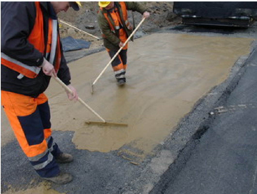
Rysunek 4.11. Wykonywanie warstwy szepnej z zaczynu gliniastego
