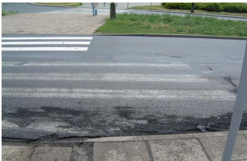
Rys.2.2. Widok całkowitego poślizgu warstwy na skutek braku szczepności międzywarstwowej (fot. P. Jaskuła).
