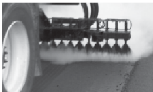
Rys. 3.9. Widok kształtu strumienia emulsji na wyjściu z dyszy spryskiwarki.
