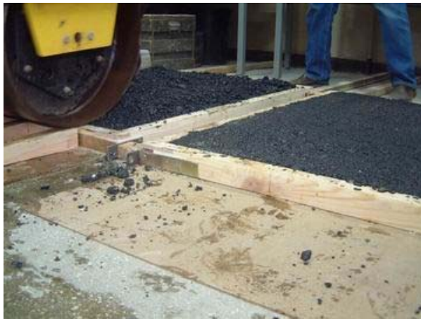
Rys. 3.4. Zagęszczanie betonu asfaltowego do warstwy wiążącej walcem stalowym.
