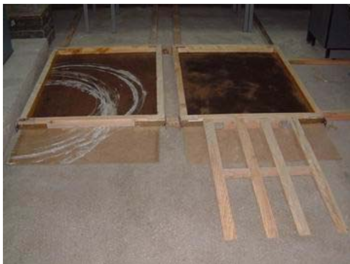
Rys.3.1. Przygotowane formy do zagęszczania warstwy wiążącej.
