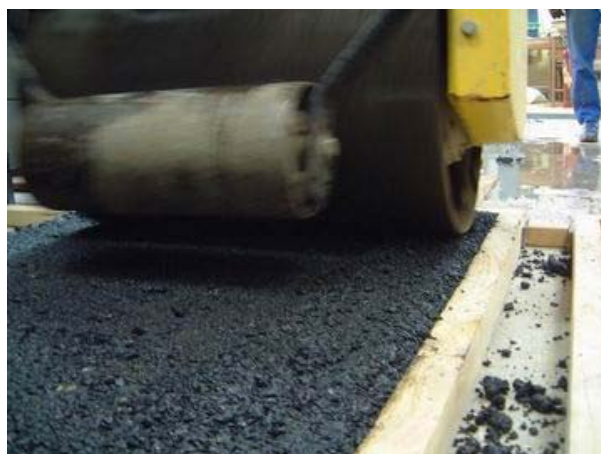
Rys. 3.3. Zagęszczanie betonu asfaltowego do warstwy wiążącej walcem stalowym.
