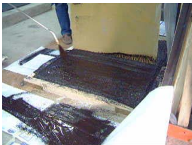
Rys. 3.10. Wykonanie warstwy szepnej. Natrysk emulsji asfaltowej.
