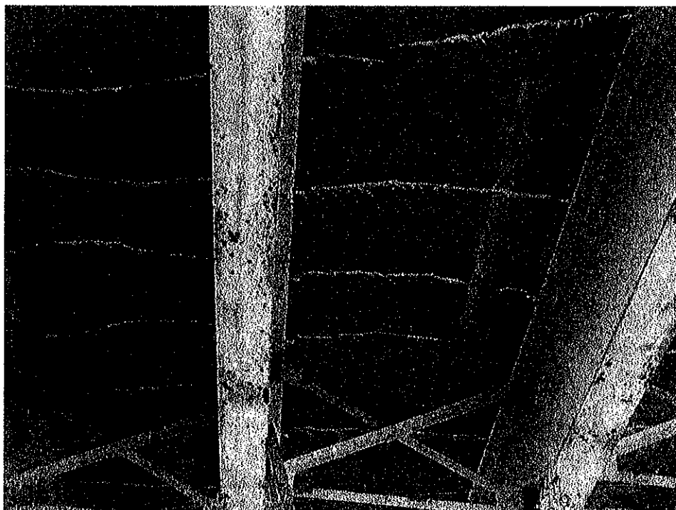
Rys.1.6. Rysy skurczowe w płycie mostu (Michigan USA, zdjęcie ze zbiorów A. Szweda). Spękania poprzeczne występują średnio co dwa metry.
