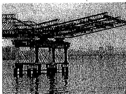
c) Widok mostu w trakcie nasuwania
