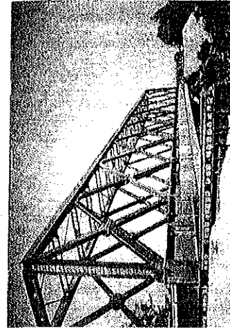
Rys. 3.51. Wiadukt objazdowy z konstrukcji KD-66-C (zmontowany i gotowy do przesunięcia)
