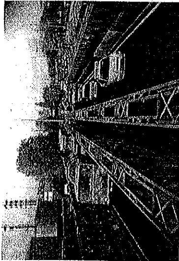
Rys. 3.8. Budowa wiaduktu dojazdowego z konstrukcji składanej
