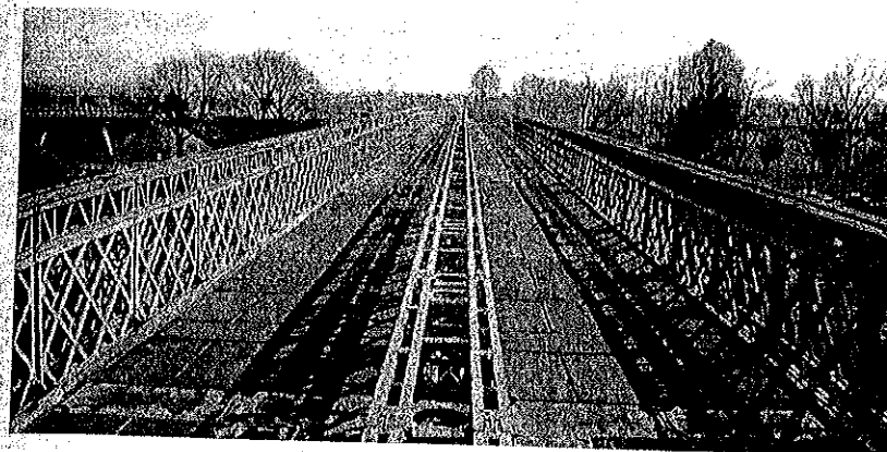
Rys. 3.25. Najdłuższy most objazdowy zbudowany z konstrukcji DMS-65 włączony – oddany do eksploatacji
