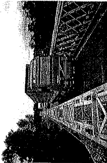
Rys. 3.12. Most objazdowy z konstrukcji DMS-65 w dużym spadku, rz. Narew m. Różan 2001 r.
