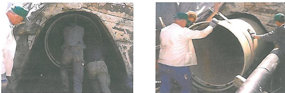
Rys.5.2. Przykład renowacji przepustu.
