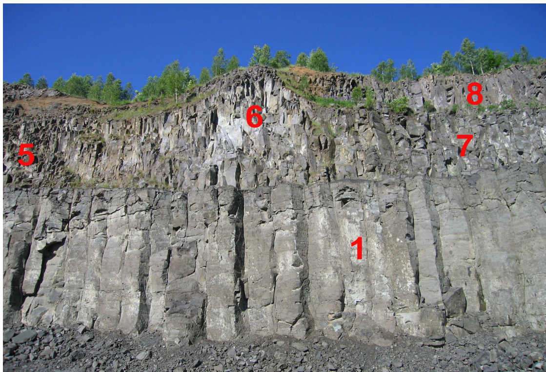
Rys. 3. Widok bazaltowej ściany wybranej do produkcji kruszyw kontrolnych i wzorcowych dla badania polerowalności PSV na wyrobisku „KSIĘGINKI-PÓŁNOC” wraz z elementami charakterystycznymi nad wybraną ścianą
