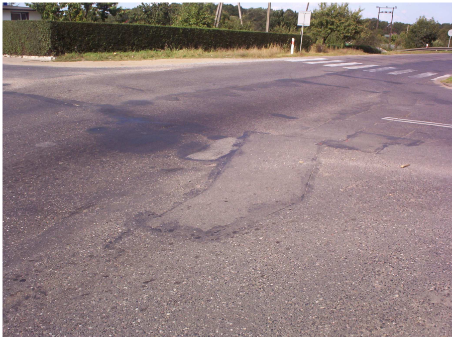
Rys.3 Widok nawierzchni w strefie skrzyżowania przed wzmocnieniem
