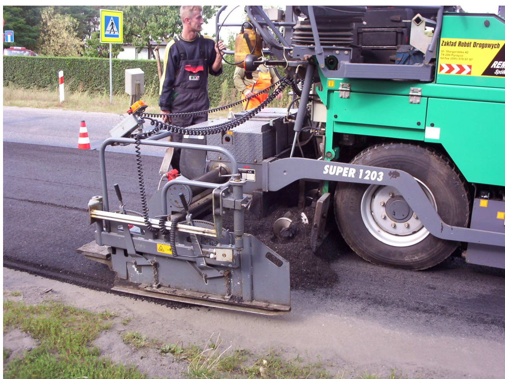
Rys. 8 i 9 Układanie warstwy GE na pierwszej części odcinka doświadczalnego
