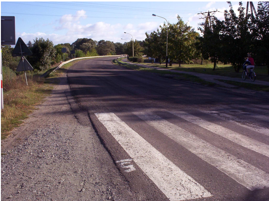
Rys. 13 Zakończenie robót na I części odcinka doświadczalnego
