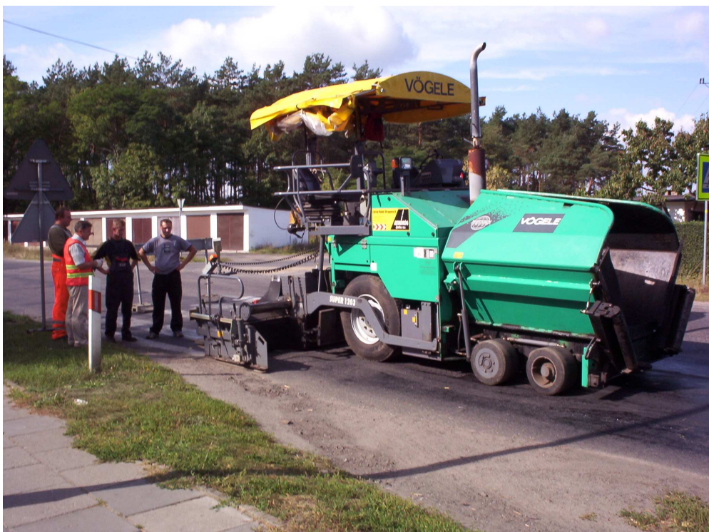
Rys. 7 Przygotowanie do rozpoczęcia układania mieszanki GE
