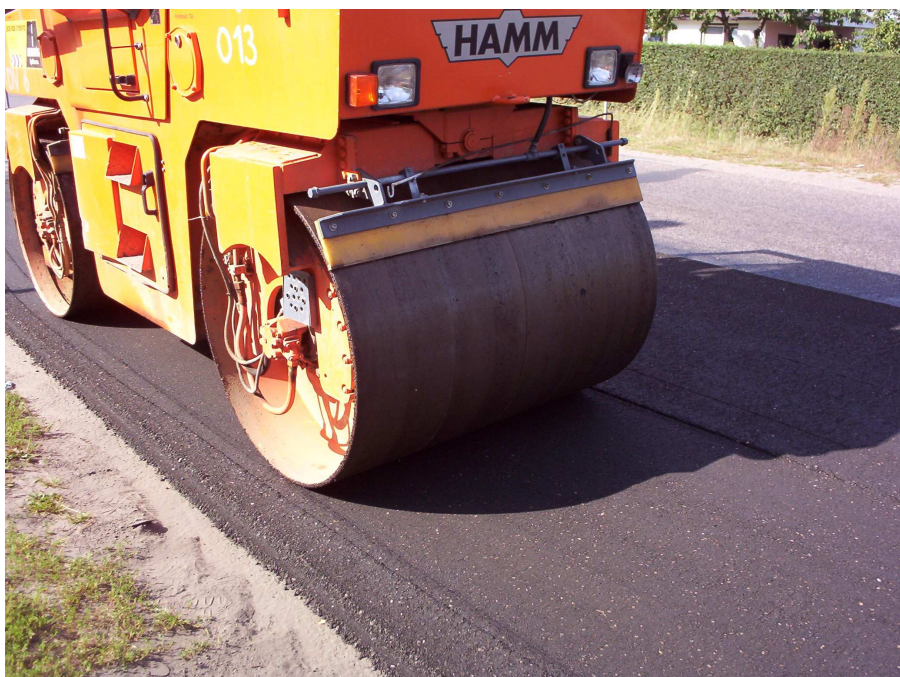
Rys. 10 i 11 Wałowanie warstwy wzmacniającej z mieszanki GE
