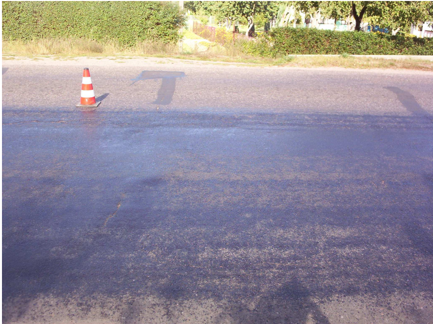
Rys. 4 Fragment nawierzchni spryskanej emulsją asfaltową wolnorozpadową
