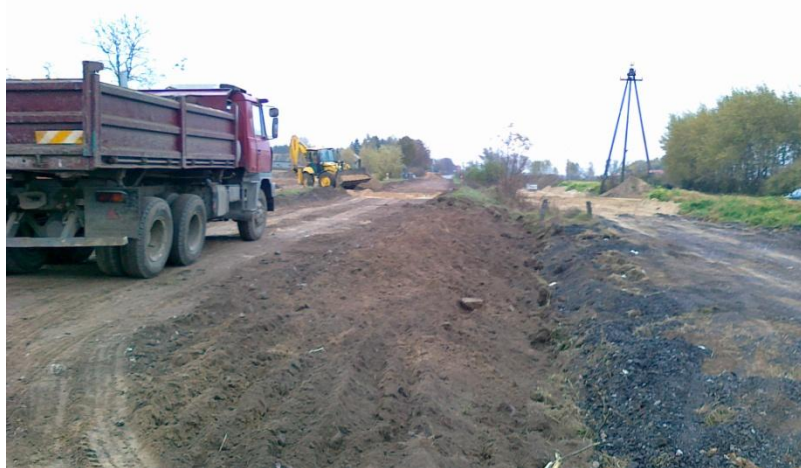
Rysunek 7.7 Odcinek remontowanego dojazdu do przejazdu kolejowego w koło Nasielska
