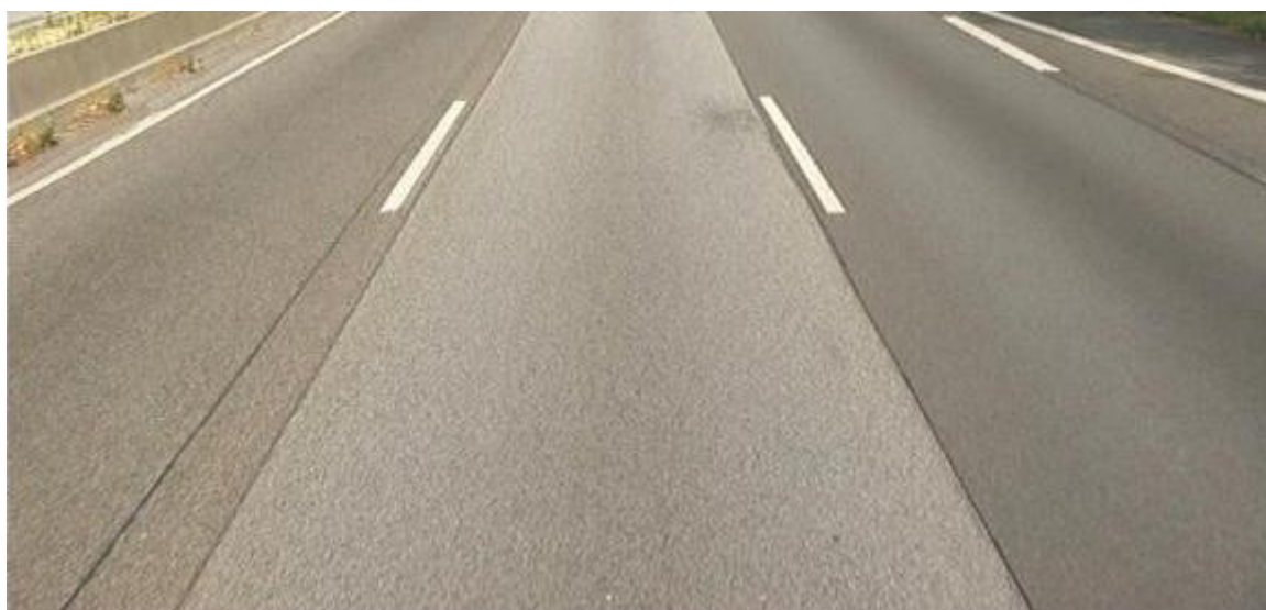
Rysunek 20: Spojenia technologiczne wzdłuż kierunku jazdy widziane na zdjęciu pasa ruchu (fragment)
