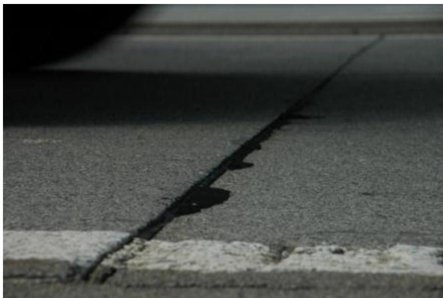
Rysunek 29: Masa bitumiczna przy krawędzi płyt (bez UK)
