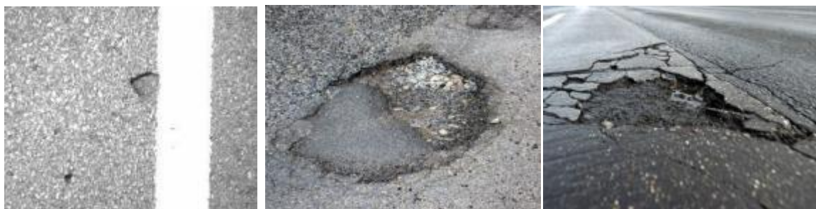
Rysunek 19: Różne przykłady wybojów (WYB)
