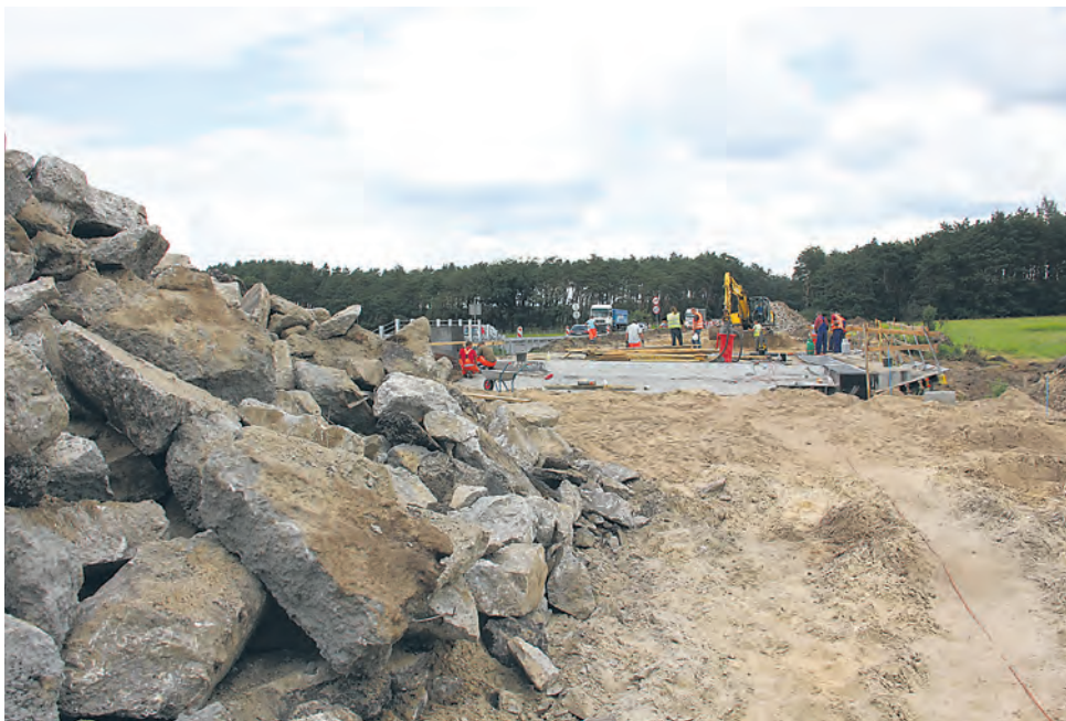
Przebudowa mostu na rzece Cheliszcząca
