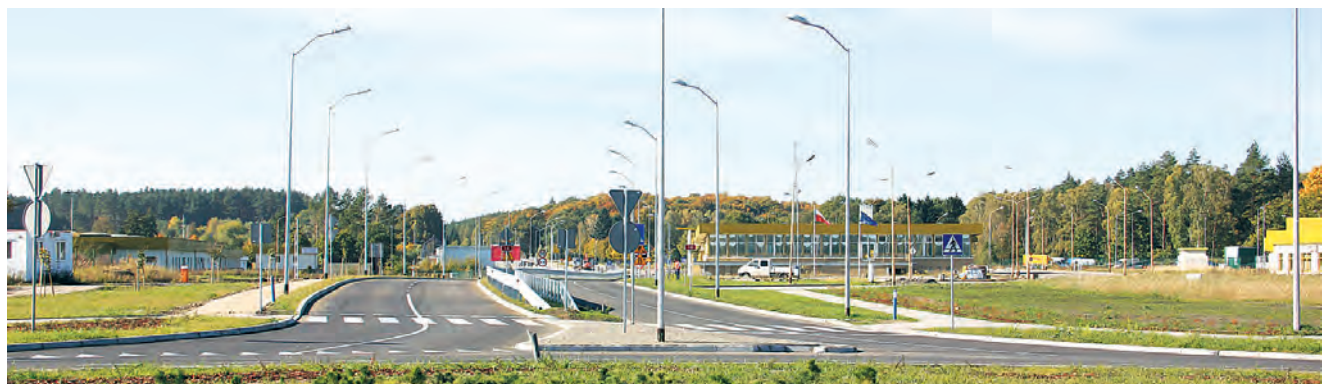
Jesienią zakończyła się przebudowa przejścia granicznego w Lubieszynie.
