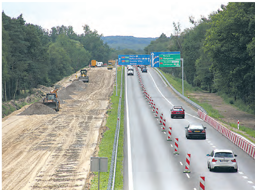
Modernizacja jezdni powodowała utrudnienia komunikacyjne.
