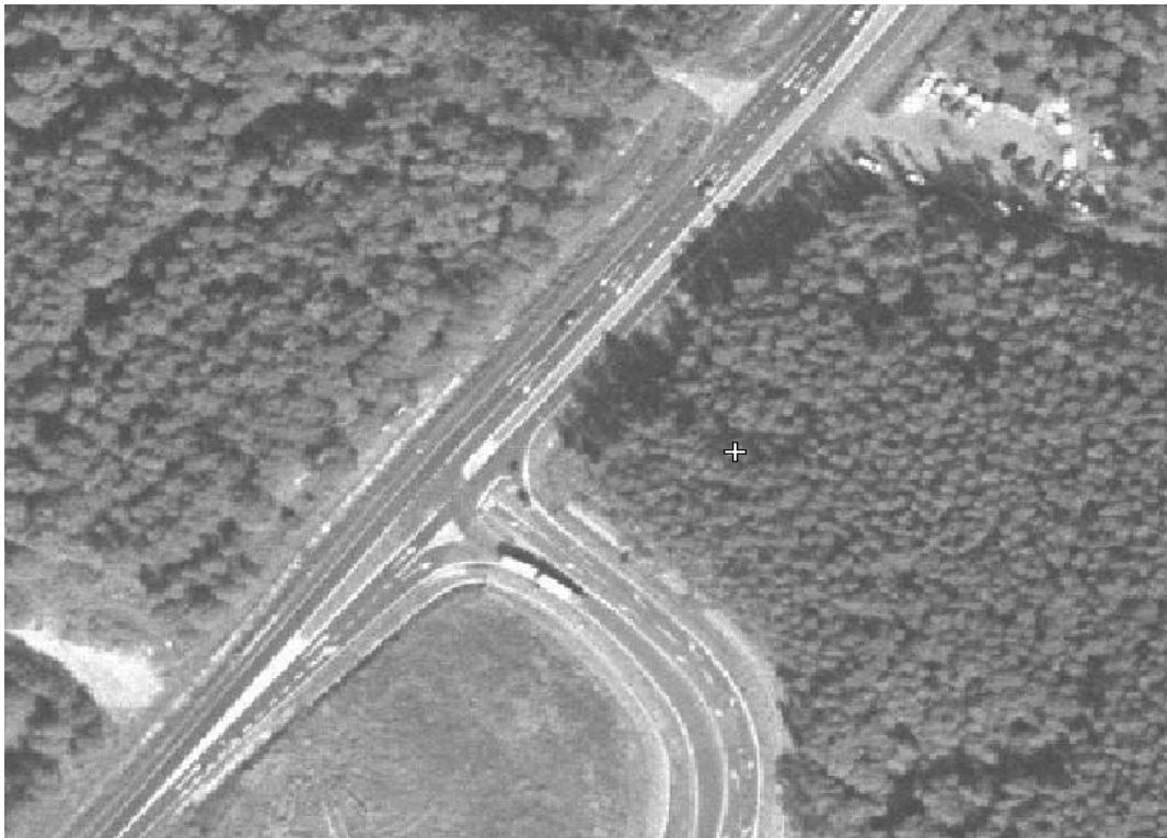
Rys. 3.70. Skrzyżowanie drogi krajowej Nr 46 z łącznicą A4 przed przebudową.
