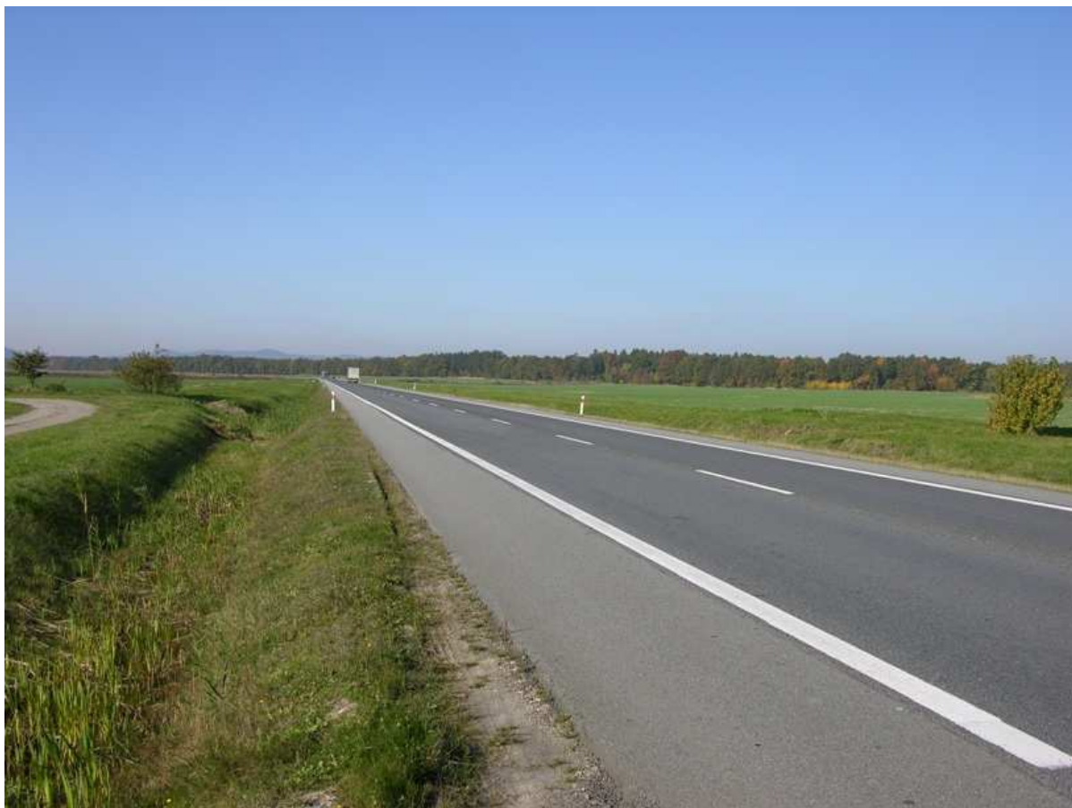
Rys. 3.55. Odcinek drogi krajowej Nr 46 obejście m. Kamienica.
