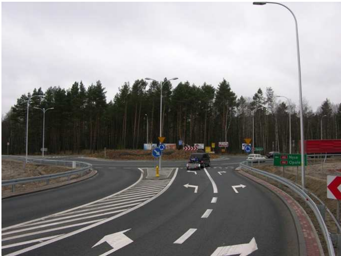
Rys. 3.71. Skrzyżowanie drogi krajowej Nr 46 z łącznicą A4 po przebudowie.
