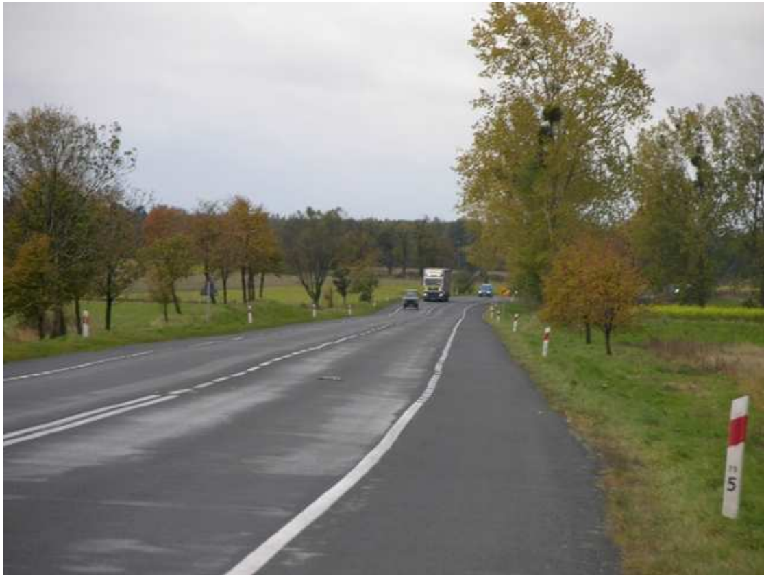
Rys. 3.64. Drogi krajowa Nr 46 – obw. Grabina.
