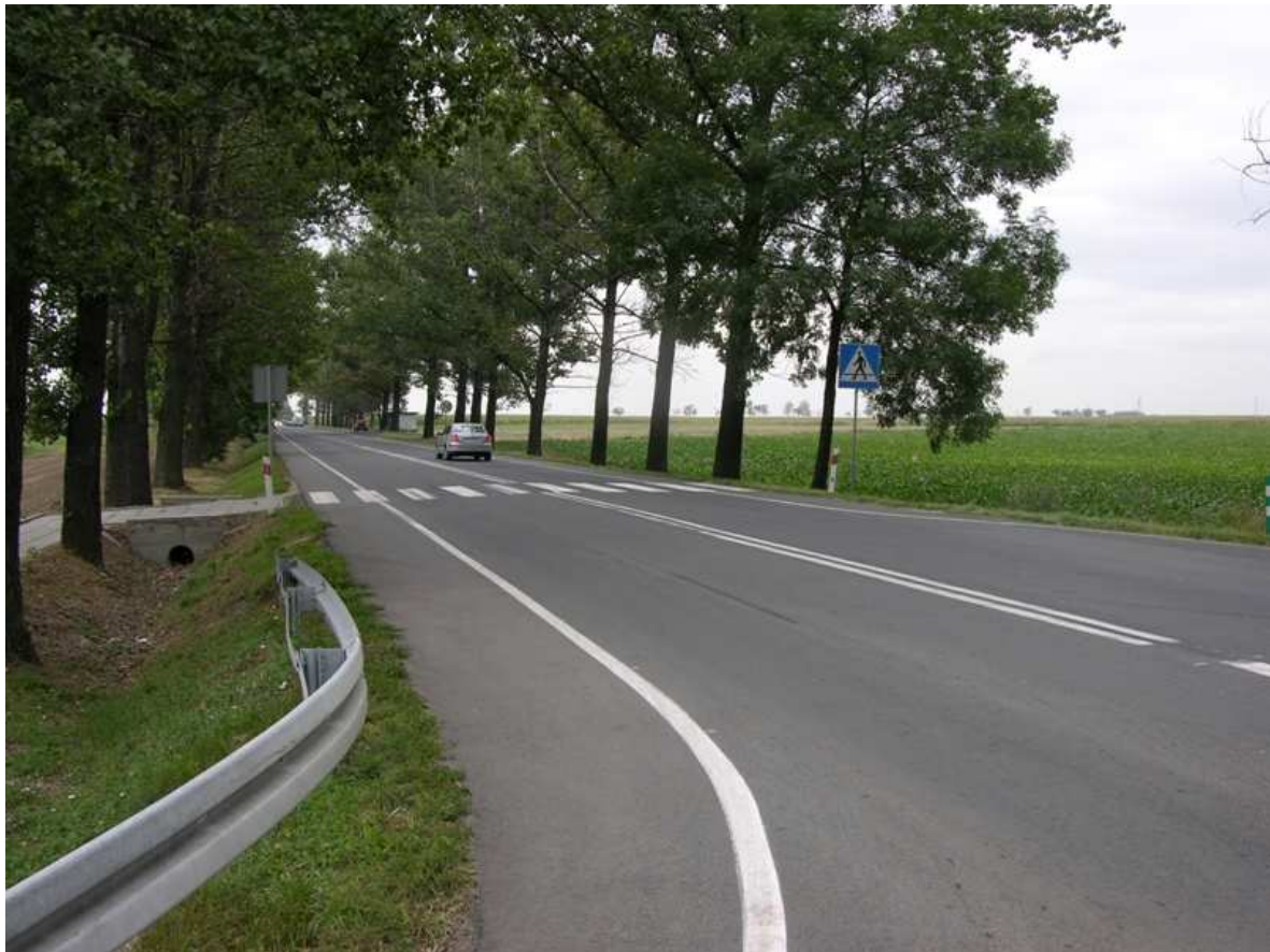
Rys. 3.62. Droga krajowa Nr 46 w m. Strobice.
