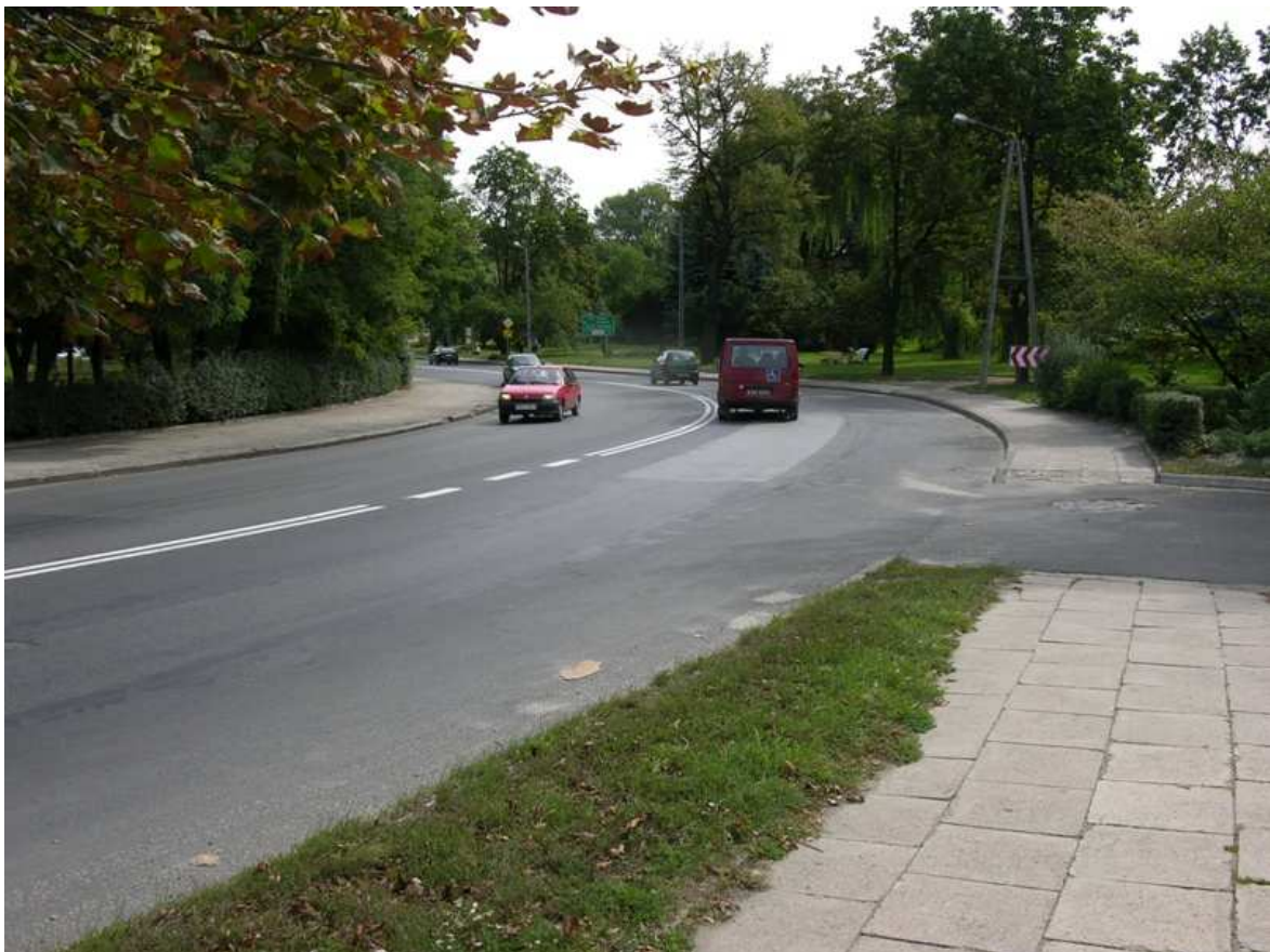
Rys. 3.58. Nysa ul. Ujejskiego – niebezpieczny łuk w km 52+600.
