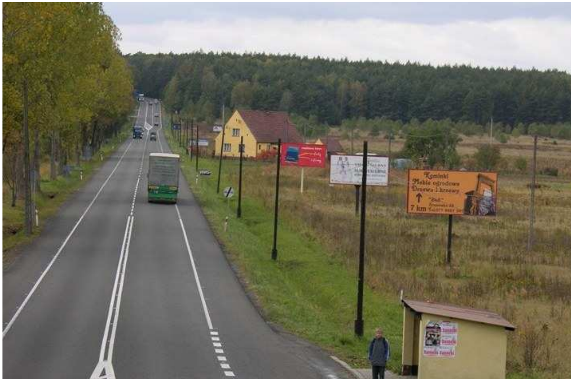
Rys. 3.73. Droga krajowa Nr 46 w m. Dąbrowa – widok z kładki dla pieszych.
