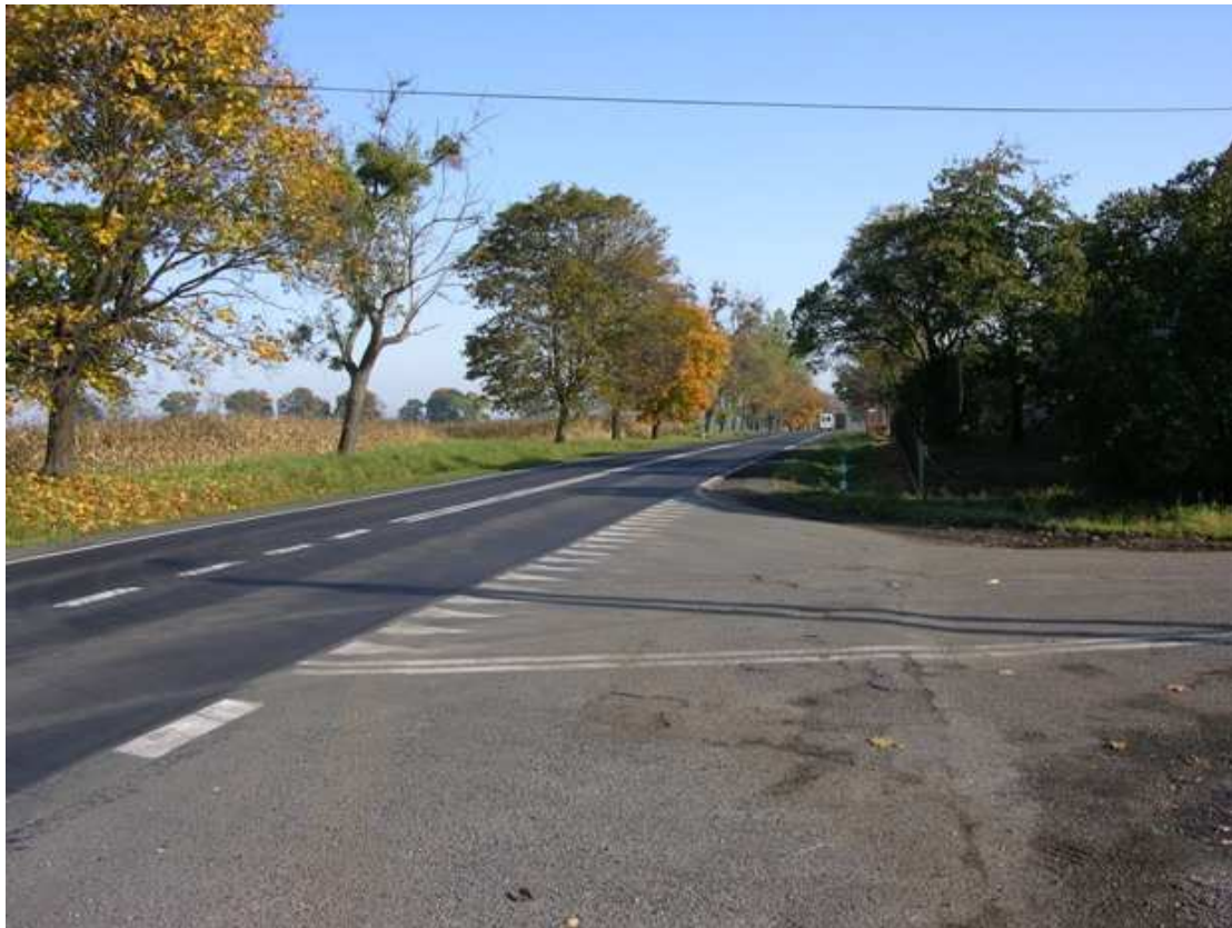
Rys. 3.66. Skrzyżowanie drogi krajowej Nr 46 z dp do Szydłowa.
