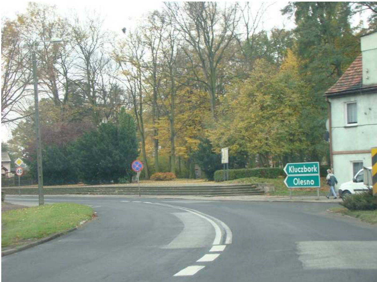
Rys. 3.35. Gorzów Śląski – skrzyżowanie w obrębie ostrego łuku poziomego.
