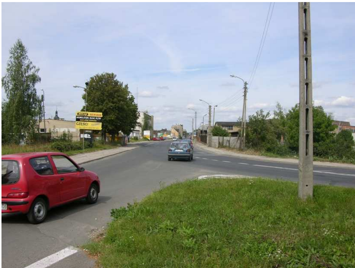
Rys. 3.30. Nysa skrzyżowanie ul. Piłsudskiego (droga krajowa Nr 41) z ul. Czarneckiego.
