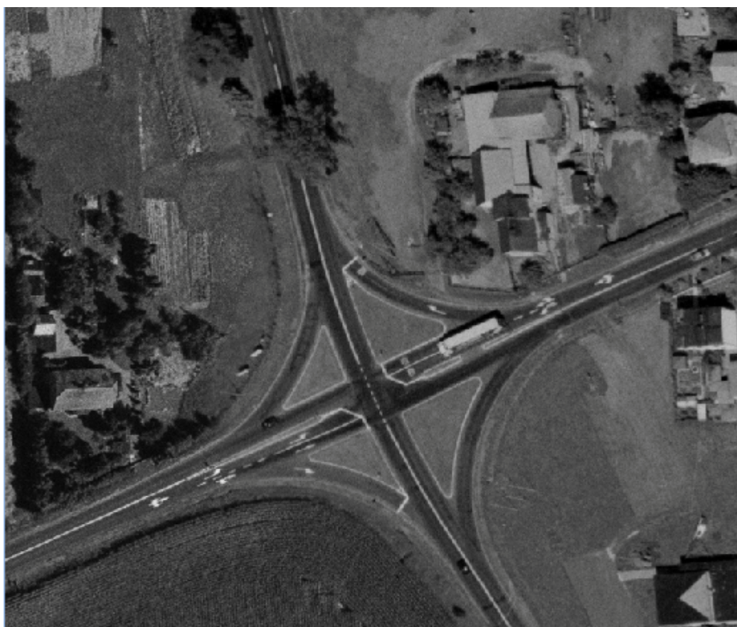
Rys. 3.38. Reńska Wieś skrzyżowanie dróg krajowych Nr 38 i 45 - zdjęcie satelitarne.
