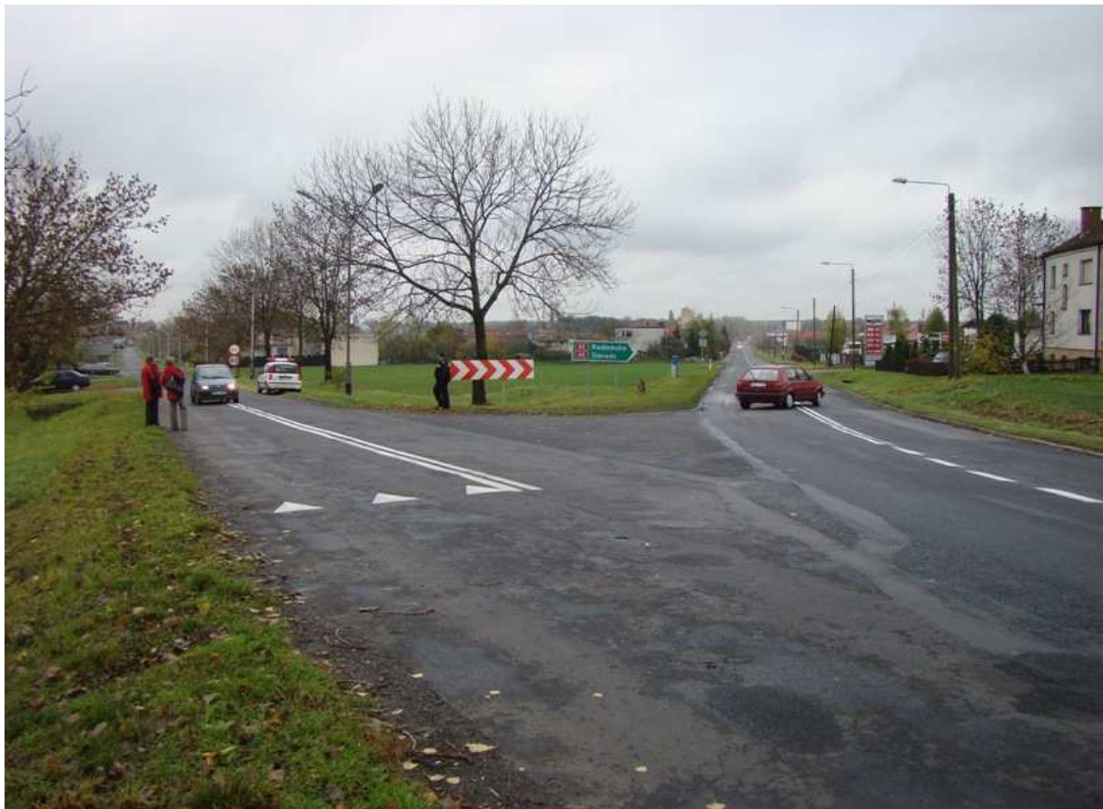
Rys. 3.33. Gorzów Śląski skrzyżowanie DK 42/45 z drogą gminną.
