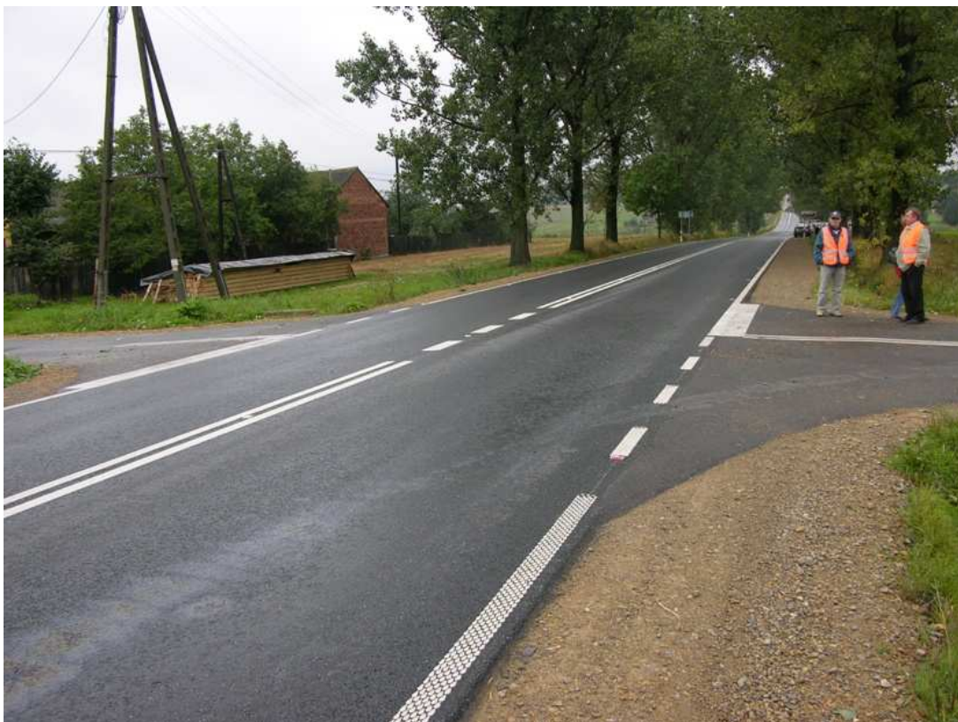
Rys. 3.37. Młyny skrzyżowanie z drogami gminnymi (droga krajowa Nr 43).
