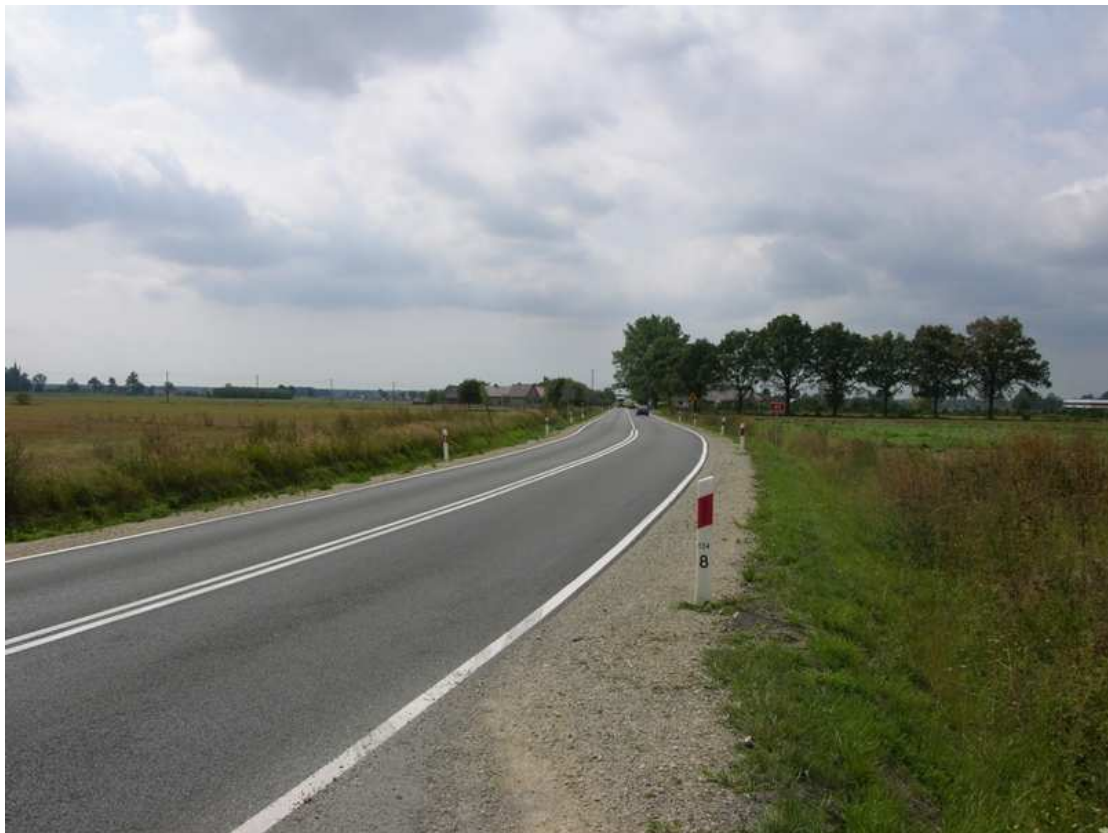
Rys. 3.50. Jełowa odcinek drogi krajowej Nr 45 w km 124+800.
