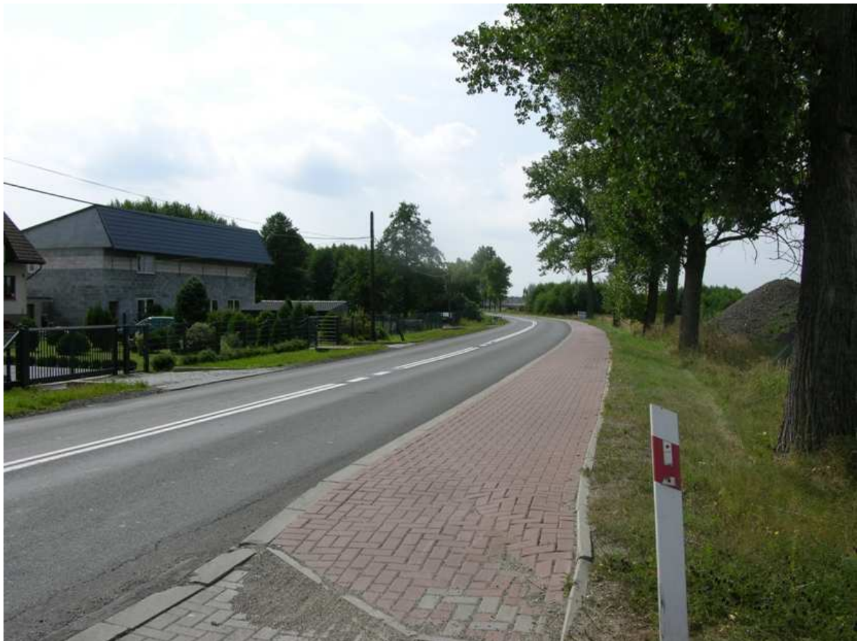
Rys. 3.47. Jełowa ul. Opolska (droga krajowa Nr 45).
