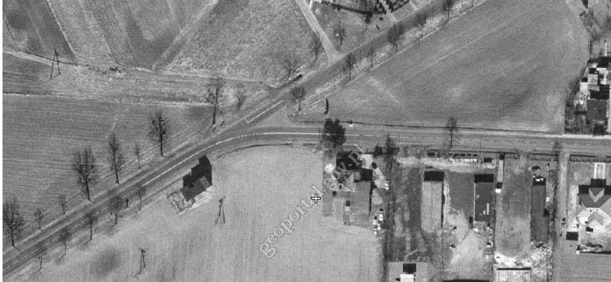
Rys. 3.32. Gorzów Śląski skrzyżowanie DK 42/45 z drogą gminną – zdjęcie satelitarne.
