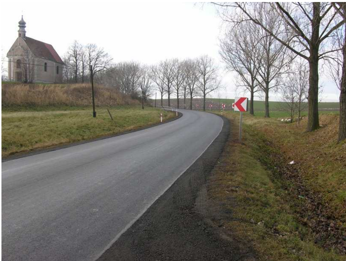
Rys. 3.20. Odc. Wierzch - Mochów (droga krajowa Nr 40) „Gliniana Górka”.
