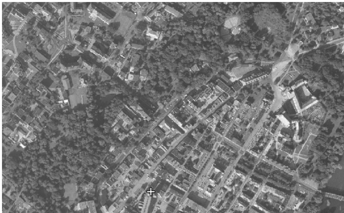
Rys. 3.13. Droga krajowa Nr 39 w m. Brzeg – ul. Jagiełły.
