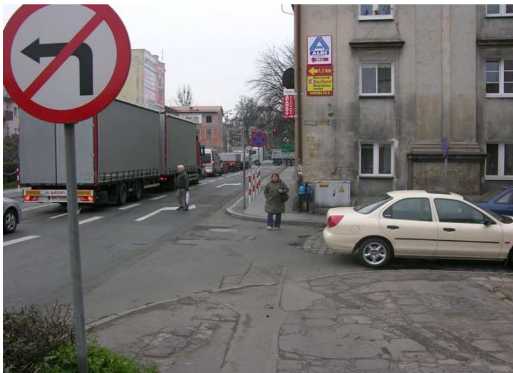
Rys. 3.14. Droga krajowa Nr 39 w m. Brzeg – ul. Jagiełły.
