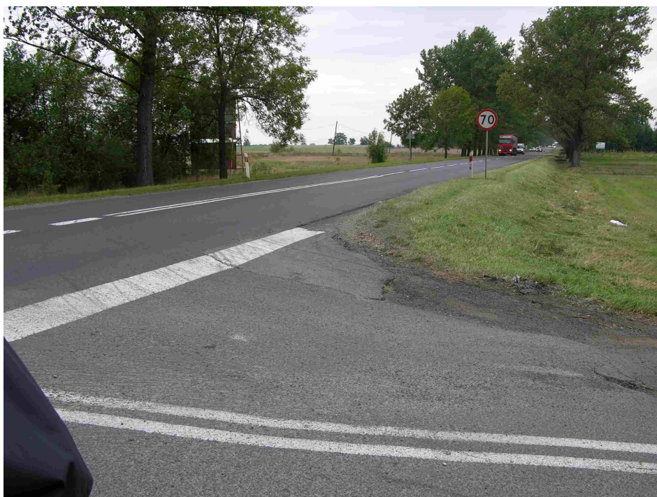
Rys. 22. Wjazd z drogi krajowej nr 46 do Stobice – odcinek nr 26.
