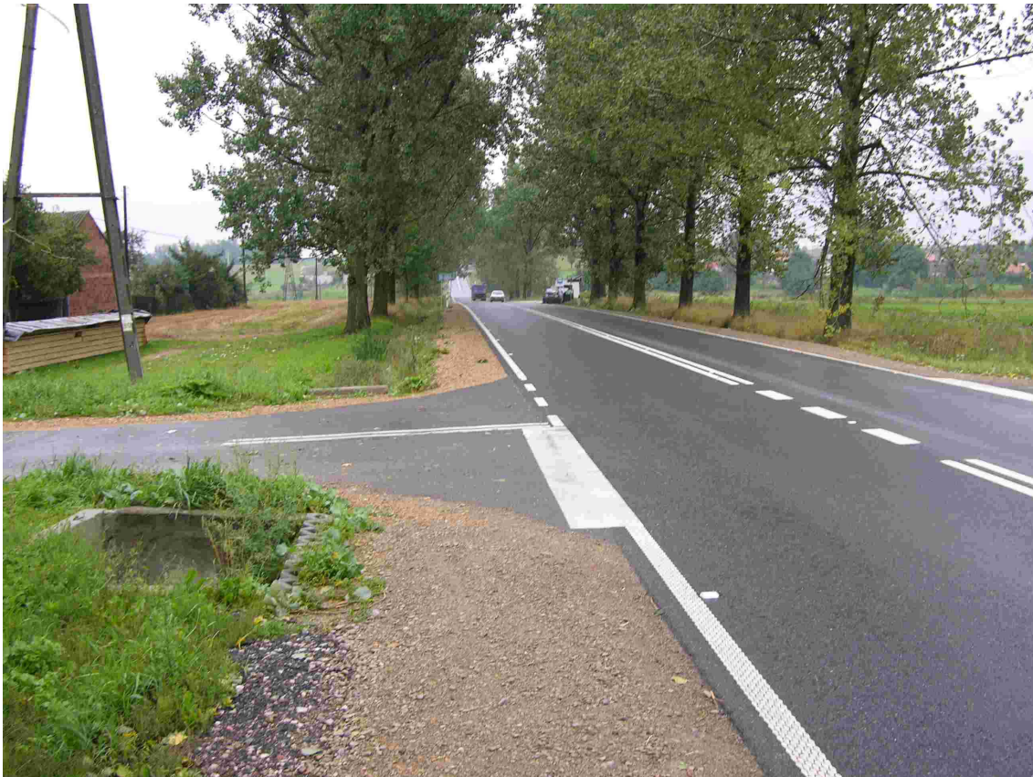
Rys. 11. Młyny skrzyżowanie z drogami gminnymi (droga krajowa Nr 43) – odcinek nr 14.
