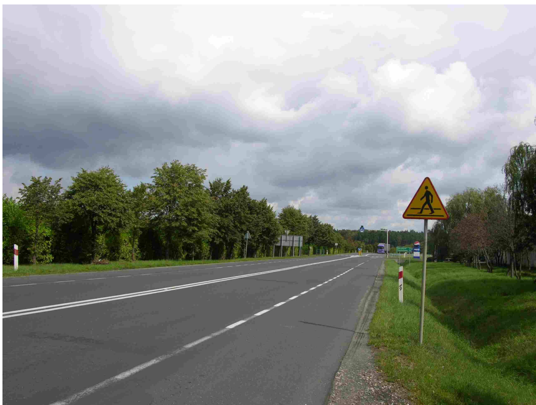
Rys. 26. Droga krajowa nr 46 w m. Ozimek – odcinek nr 33.
