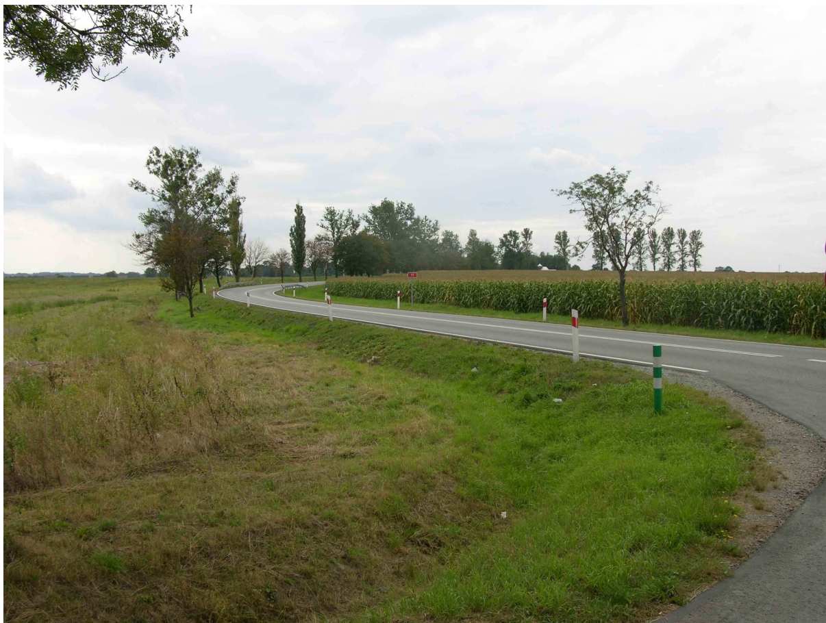
Rys. 2. Droga krajowa Nr 11 w km 479,8 – odcinek nr 2.
