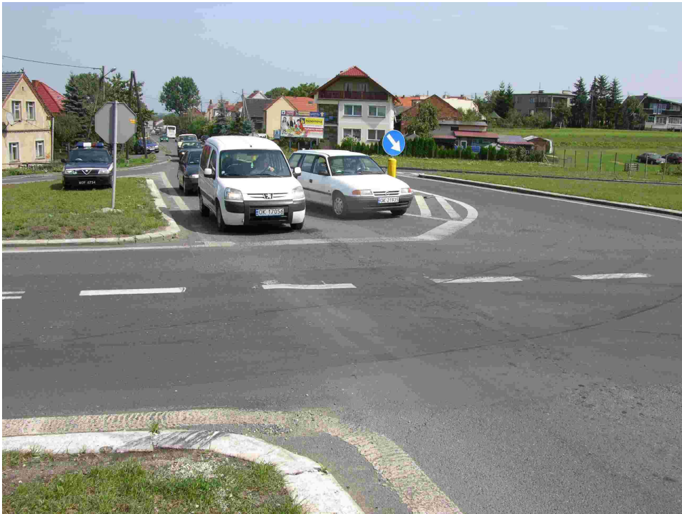
Rys. 12. Reńska Wieś skrzyżowanie dróg krajowych Nr 38 i 45 – odcinek nr 15.
