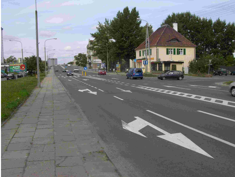
Rys. 10. Nysa ul. Piłsudskiego (droga krajowa Nr 41) – odcinek nr 11.
