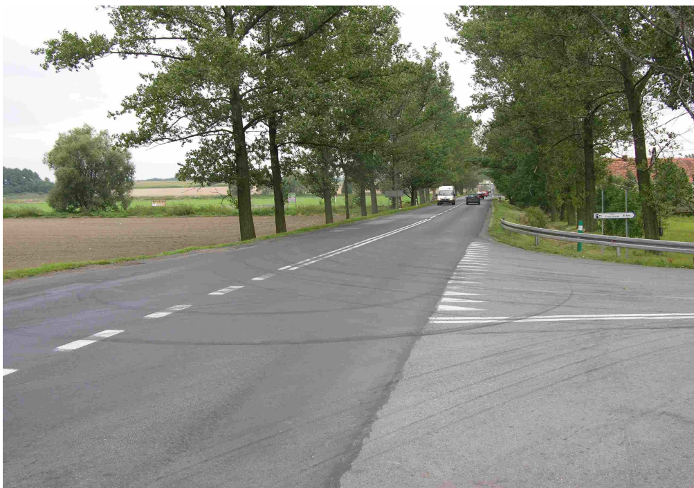
Rys. 23. Skrzyżowanie drogi krajowej nr 46 z drogą do Pakosławic – odcinek nr 27.
