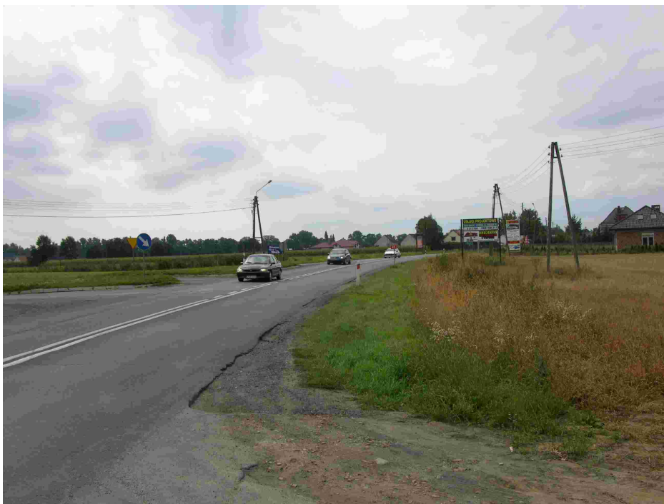
Rys. 14. Skrzyżowanie drogi krajowej Nr 45 z dp do Turawy w m. Zawada – odcinek nr 18.
