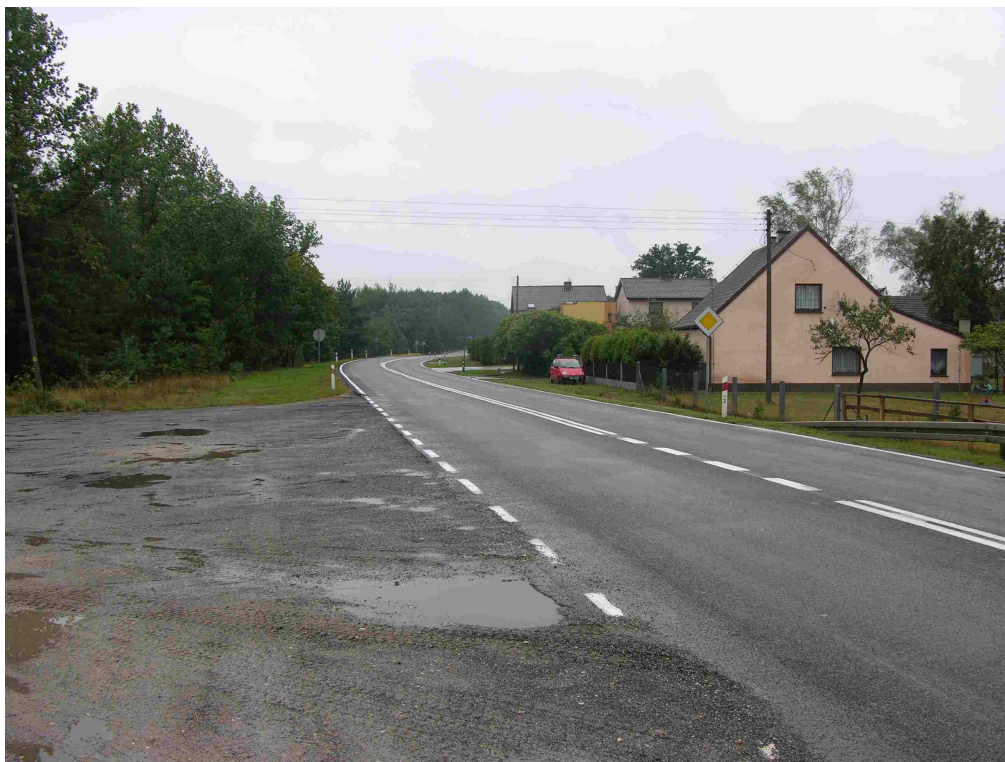
Rys. 27. Myślina (droga krajowa nr 46) – odcinek nr 34.
