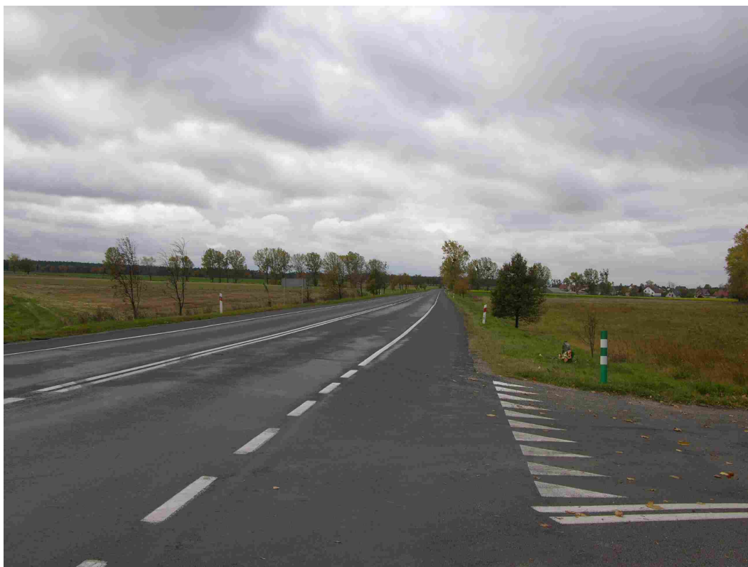
Rys. 24. Skrzyżowanie drogi krajowej nr 46 z dp do Grabina – odcinek nr 28.
