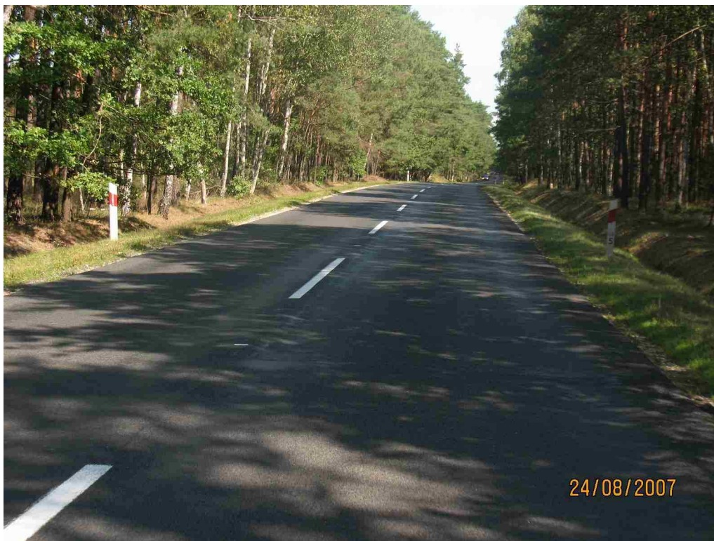
Rys. 18. Odcinek drogi krajowej Nr 45 Lasowice W. – Jasienie w km 138,5 – odcinek nr 21.
