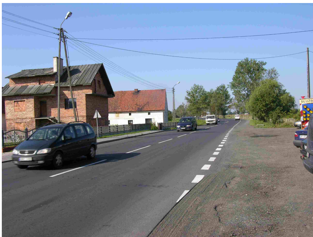
Rys. 25. Wjazd do m. Sosnówka (droga krajowa nr 46) – odcinek nr 30.
