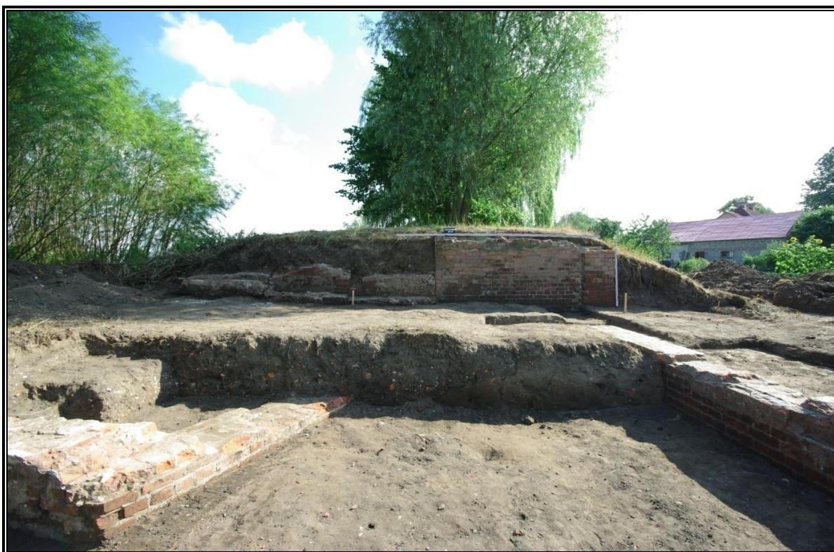
Fot. 7.87 Pozostałości po założonym na nasypie wiatraku z okresu nowożytnego na trasie planowanej budowy drogi ekspresowej S7 Koszwały - Kazimierzowo.
