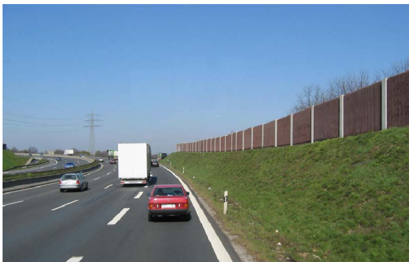
Fot. 3 Zabezpieczenie stanowiące kombinację ekranu ziemnego z ekranem akustycznym
