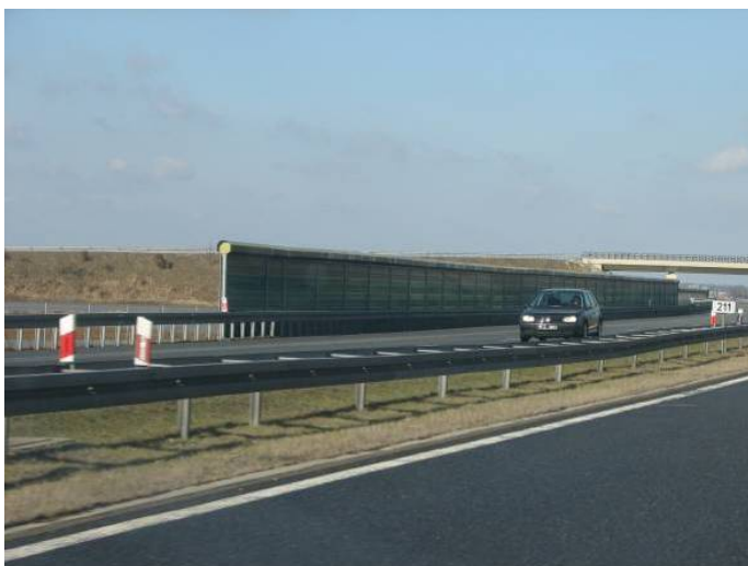
Fot. 2 Ekran akustyczny typu ściana
