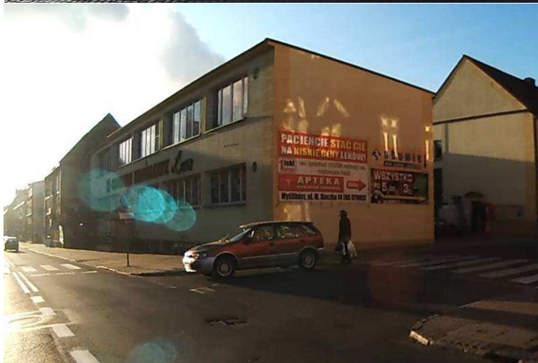
DK 26 (zabudowa na odcinku Myślibórz Przejsćie)
