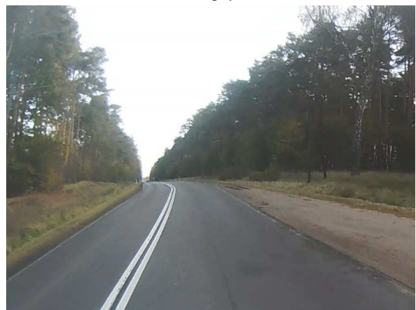
DK11 Las na odcinku drogi krajowej
