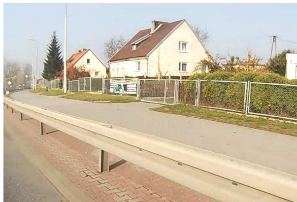
DK92 Zabudowa jednorodzinna w miejscowości Gaj Wielki
