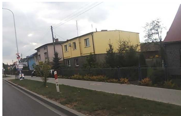
DK11 Zabudowa jednorodzinna na odcinku Kępno - Przejście
