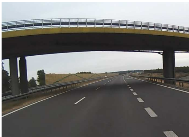
A2 Wiadukt oraz ekran akustyczny na 116+400 kilometrze
