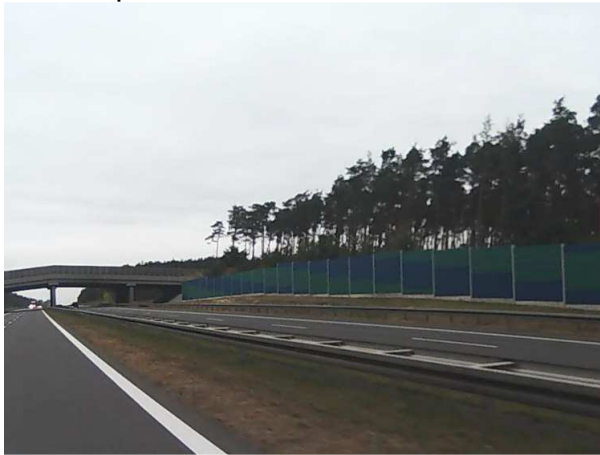
A2 Ekran akustyczny w kilometrze 65+000
