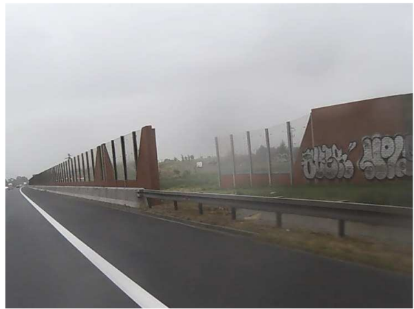
A2 Ekran akustyczny w kilometrze 2+200
