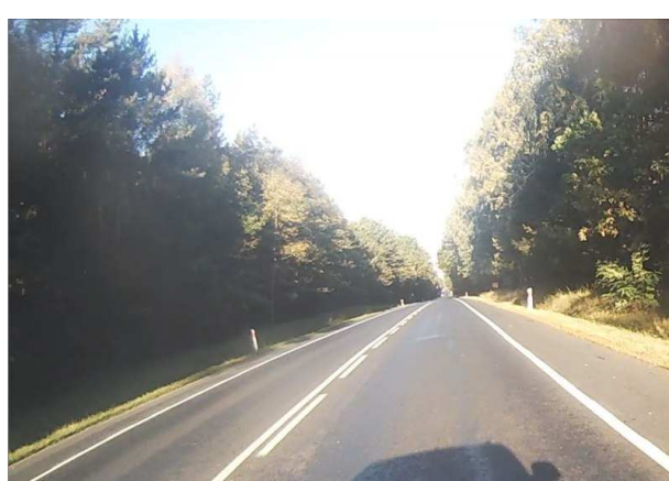
DK11 Lasy wzdłuż odcinka drogi krajowej
