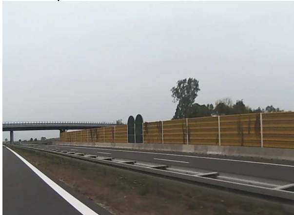
A2 Ekran akustyczny w kilometrze 25+900
