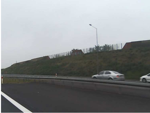
A2 Ekran akustyczny w kilometrze 5+850
