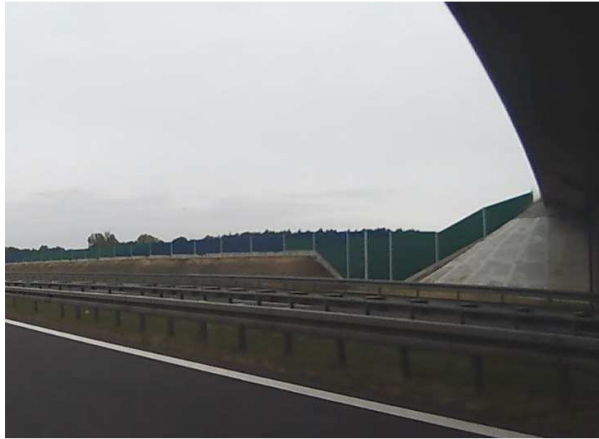
A2 Ekran akustyczny w kilometrze 94+250
