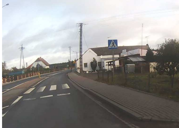
DK11 Zabudowa jednorodzinna w miejscowości Podgaje
