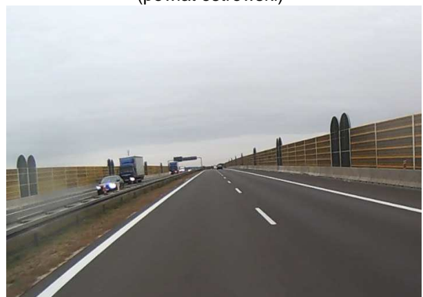
A2 Ekrany akustyczne przy autostradzie (powiat wrzesiński)
