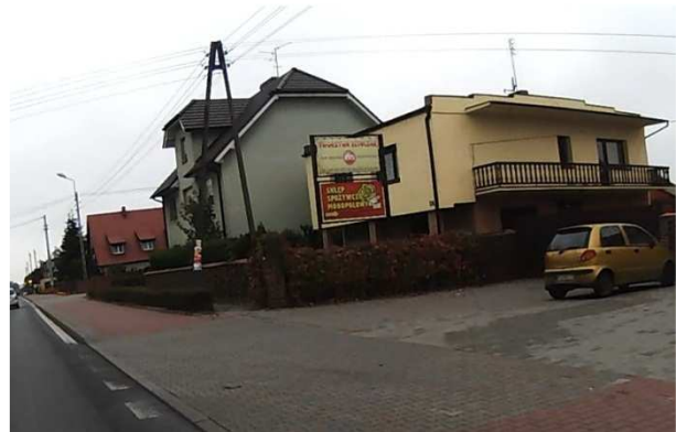
DK5 Zabudowa jednorodzinna i usługowa w miejscowości Dębienko
