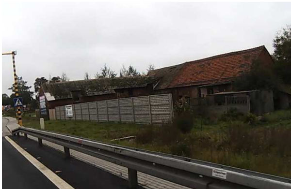
DK5 Zabudowa zagrodowa w miejscowości Ponin
