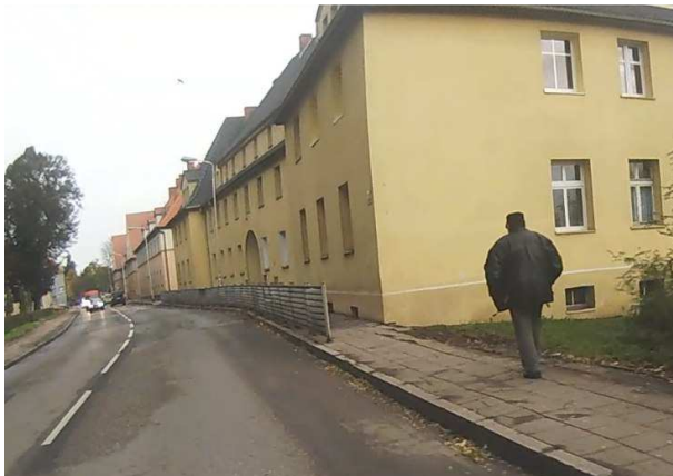
DK11 Zabudowa wielorodzinna oraz szkoła w miejscowości Piła
