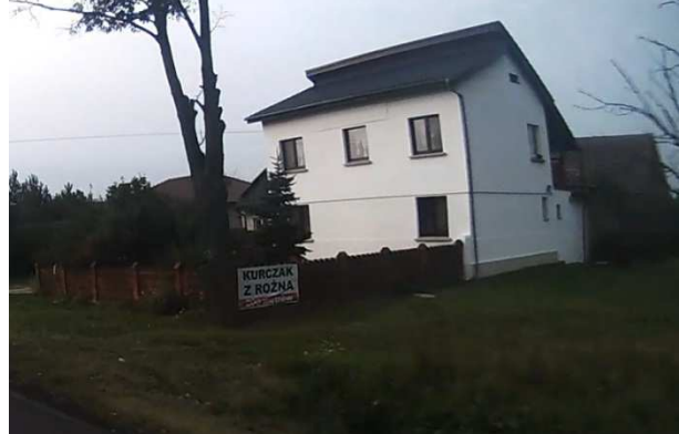
DK11 Zabudowa zagrodowa w miejscowości Cielcza
