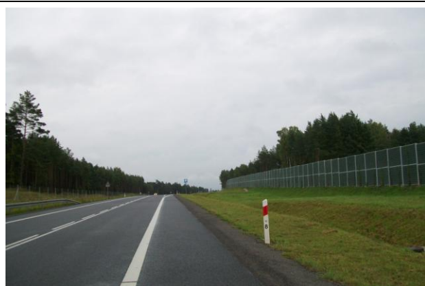
Droga krajowa nr 16c, odcinek WN_7_0811_16c o nazwie WĘŻEŁ BARCZEWO-BISKUPIEC, km 11+707 - 13+600
