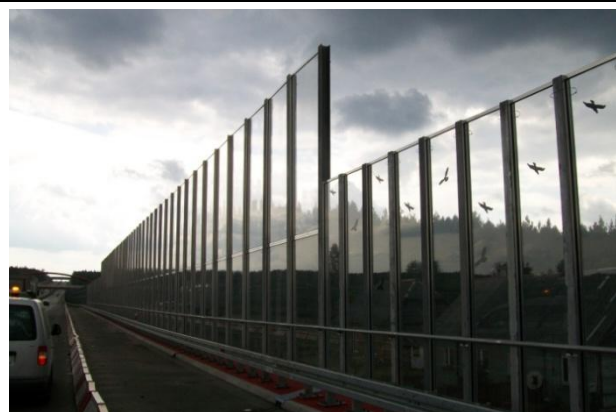
Ekrany akustyczne zlokalizowane wzdłuż drogi krajowej nr 7, odcinek 914 o nazwie SKARŻYSKO KAM.-SUCHEDNIÓW, km 515+055 – 520+627
