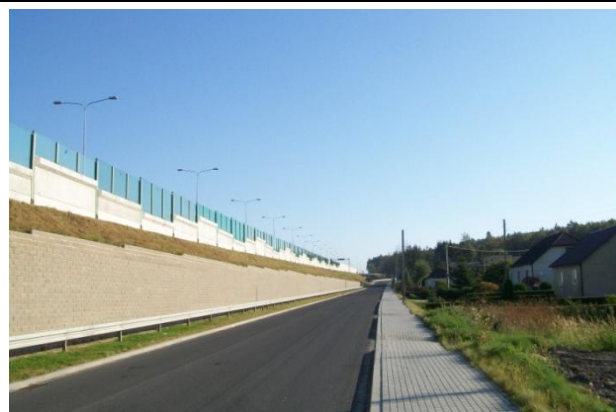
Ekrany akustyczne zlokalizowane wzdłuż drogi krajowej nr 7e, odcinek 916 o nazwie WYSTĘPA-WIŚNIÓWKA, km 0+000 – 6+513
