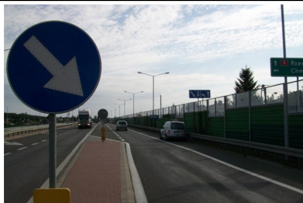
Ekrany akustyczne zlokalizowane wzdłuż drogi krajowej nr 9, odcinek 923 o nazwie RUDNIK-OSTROWIEC ŚW (Boksycka), km 55+735 – 64+390
