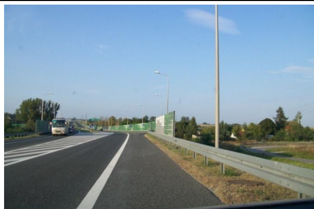
Droga krajowa nr 7c, odcinek 921 o nazwie JĘDRZEJÓW /OBWODNICA B/, km 2+732 – 5+796
