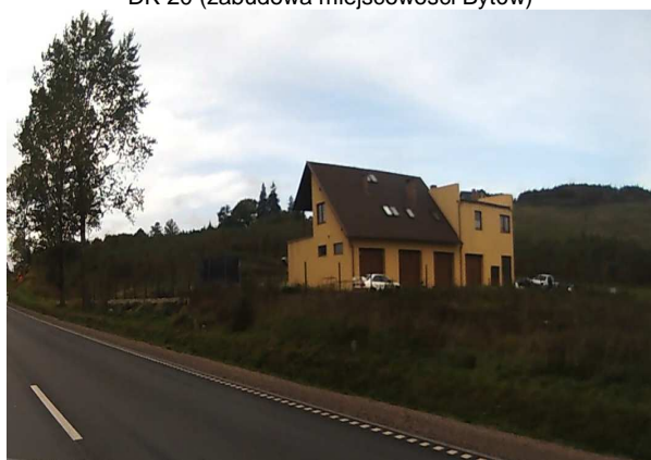
DK 20 (zabudowa na odcinku Miszewo - Chwaszczno)
