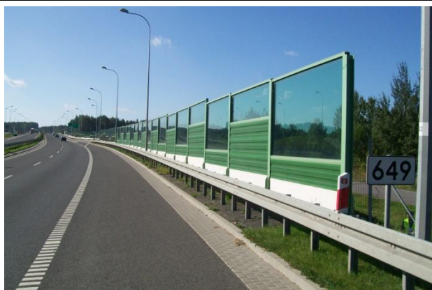
Ekrany akustyczne zlokalizowane wzdłuż drogi krajowej nr 8, odcinek 711 o nazwie BIAŁYSTOK-RYBNIKI km 647+841– 658+866
