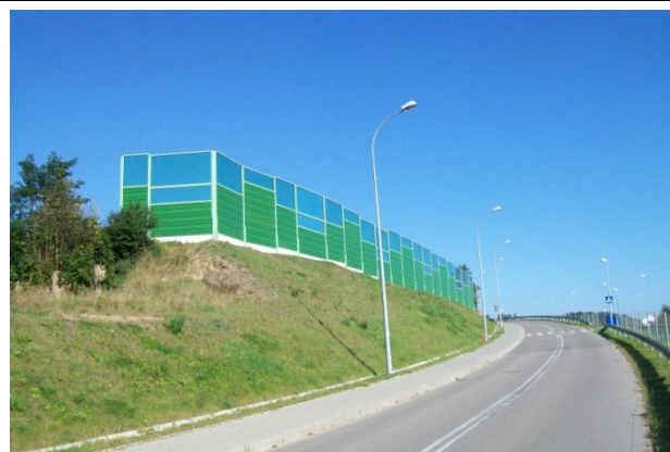
Ekrany akustyczne zlokalizowane wzdłuż drogi krajowej nr 8, odcinek 711 o nazwie BIAŁYSTOK-RYBNIKI km 647+841– 658+866
