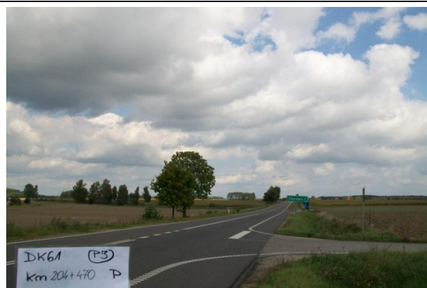
Droga krajowa nr 61, odcinek 727 o nazwie SZCZUCZYN-GRAJEWO km 201+812 – 212+845
