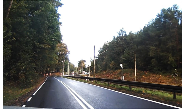
DK77 Lasy wzdłuż odcinka drogi krajowej
