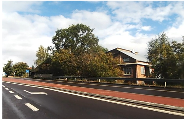
DK77 Zabudowa jednorodzinna na odcinku Radymno - Żurawica
