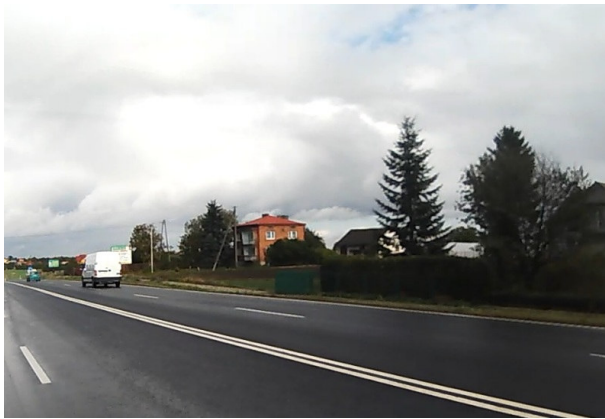
DK77 Zabudowa jednorodzinna na odcinku Radymno - Żurawica
