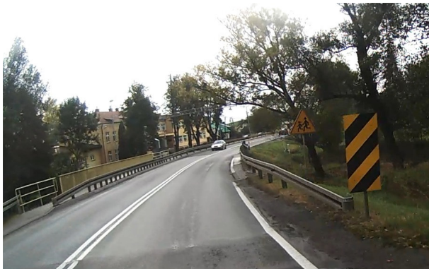
DK4 Budynek szkoły na odcinku Łańcut - Przeworsk
