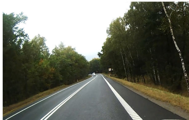
DK9 Lasy wzdłuż odcinka drogi krajowej
