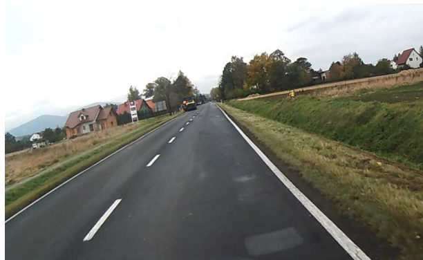
DK40 Pola uprawne wzdłuż odcinka drogi krajowej
