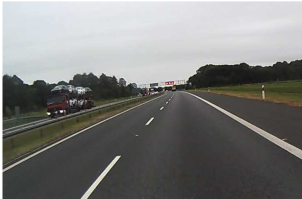
A4 Pola uprawne oraz zalesienia wzdłuż odcinka autostrady
