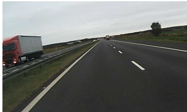
A4 Pola uprawne wzdłuż odcinka autostrady
