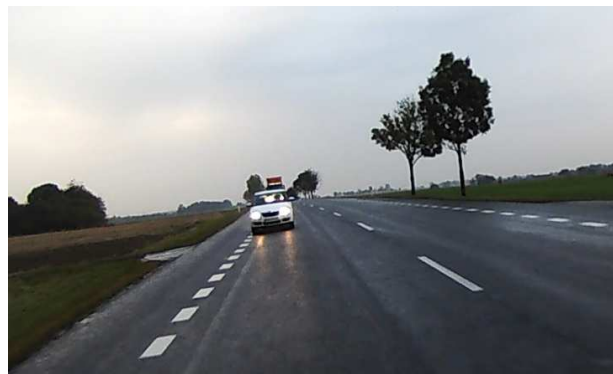
DK40 Pola uprawne wzdłuż odcinka drogi krajowej
