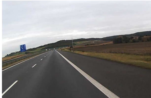
A4 Pola uprawne wzdłuż odcinka autostrady
