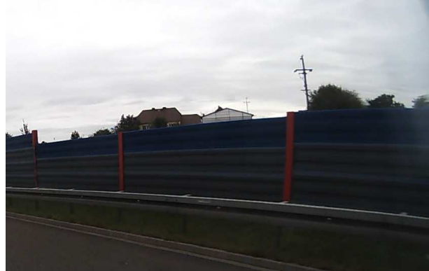
A4 Ekranowana zabudowa zagrodowa na odcinku Gogolin-Olszowa
