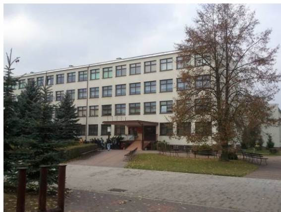
Fot. 34 Szkoła w miejscowości Kozienice przy DK 79 na odcinku Kozienice /Przejście/
