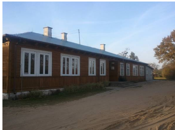
Fot. 106 Szkoła w miejscowości Broszków przy DK 2 na odcinku Broszków – Siedlce
