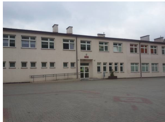
Fot. 126 Szkoła w miejscowości Słupno przy DK 62 na odcinku Sokółów Podlaski /Przejście/
