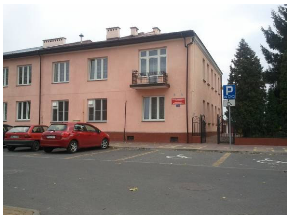
Fot. 33 Przedszkole w miejscowości Kozienice przy DK 79 na odcinku Kozienice /Przejście/
