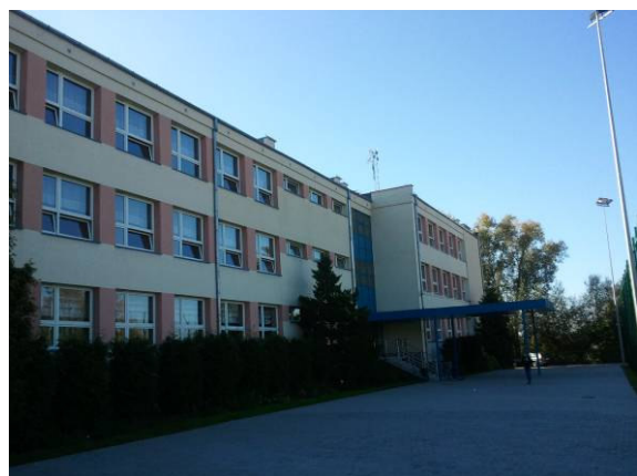
Fot. 80 Szkoła w miejscowości Góra Kalwaria przy DK 79 na odcinku Łubna – Góra Kalwaria
