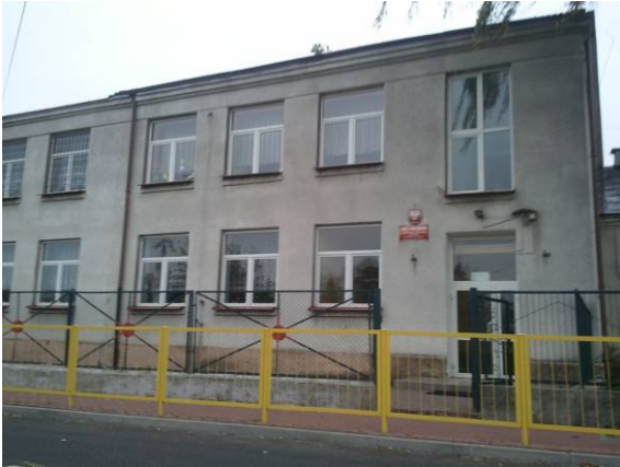
Fot. 115 Szkoła w miejscowości Grabiec przy DK 10 na odcinku Sierpc – Zawidz Kościelny
