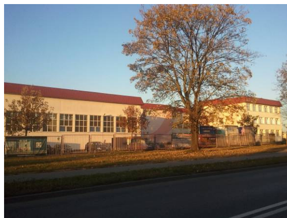
Fot. 10 Szkoła w miejscowości Ciechanów przy DK 60 na odcinku Ciechanów - /Przejście I/
