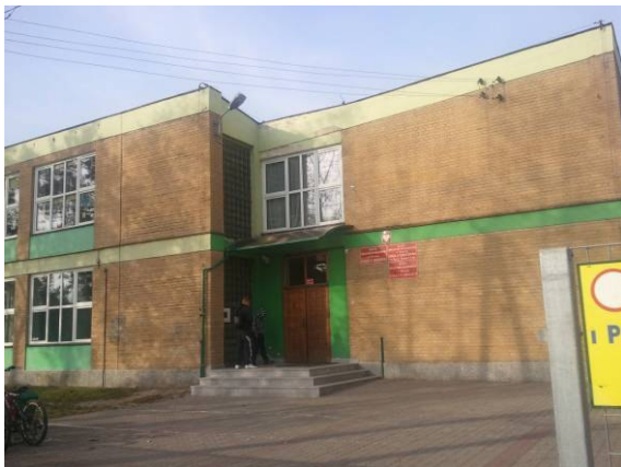
Fot. 105 Przedszkole w miejscowości Strzała przy DK 63 na odcinku Chodów – Siedlce
