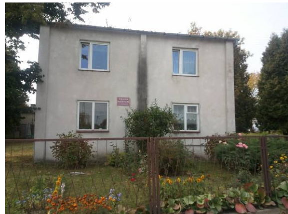
Fot. 16 Przedszkole w miejscowości Gończyce przy DK 17 na odcinku Garwolin – Gończyce – Granica województwa
