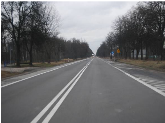
Fot. 65 DK 8 na odcinku Dybki – Ostrów Mazowiecka
