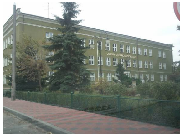
Fot. 32 Szkoła w miejscowości Kozienice przy DK 79 na odcinku Kozienice /Przejście/
