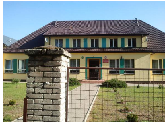
Fot. 66 Szkoła w miejscowości Dybki przy DK 8 na odcinku Poręba – Ostrów Mazowiecka
