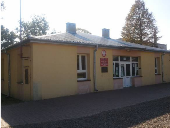
Fot. 107 Szkoła w miejscowości Bojmie przy DK 2 na odcinku Kałuszyn – Broszków
