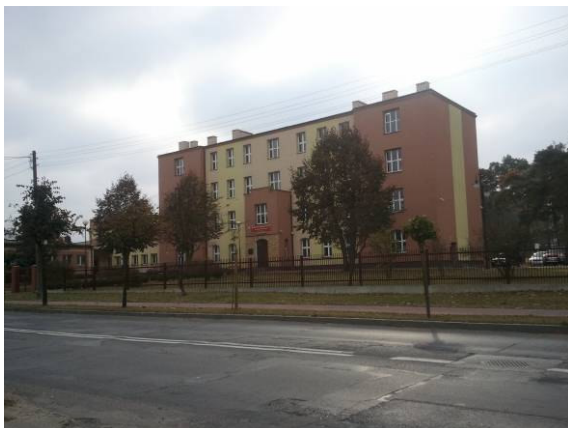
Fot. 31 Szkoła w miejscowości Kozienice przy DK 79 na odcinku Kozienice /Przejście/
