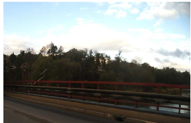
DK75 Lasy wzdłuż odcinka drogi krajowej
