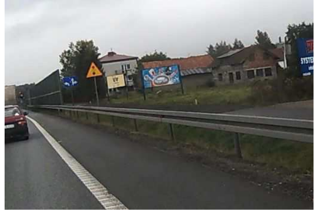
DK4 Zabudowa zagrodowa oraz ekran akustyczny w miejscowości Mikołajowice
