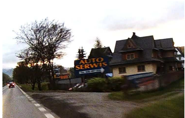
DK47 Zabudowa jednorodzinna oraz usługowa w miejscowości Zakopane
