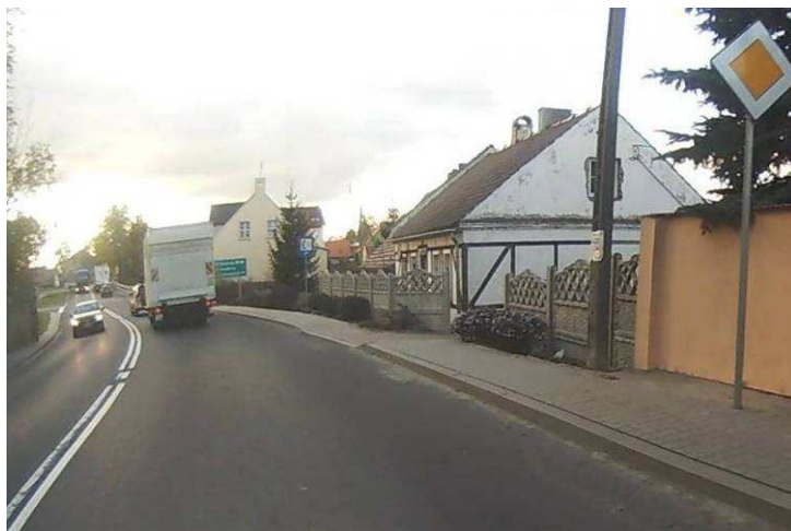
DK 32 (zabudowa miejscowości Leśniów Wielki)
