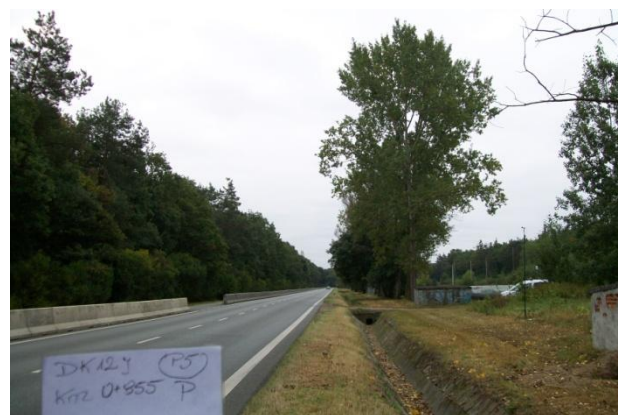
Punkt pomiarowy DK12j_P5, na drodze krajowej nr 12j, odcinek LU_7_0742_12j o nazwie PUŁAWY AL.1000-LECIA P.P., przekrój pomiarowy w km 0+855
