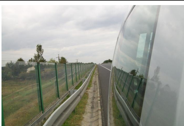
Ekrany akustyczne zlokalizowane wzdłuż drogi krajowej nr 19a, odcinek LU_7_0771_19a o nazwie LUBARTÓW/OBWODNICA/, km 0+000 – 6+200; 0+000 - 2+000
