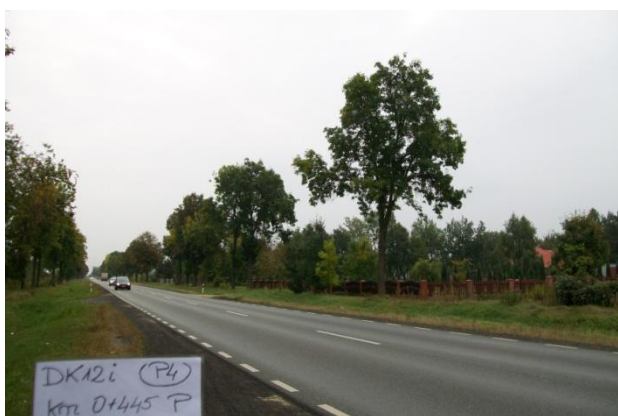
Droga krajowa nr 12h, 12i, odcinek LU_7_0740_12h o nazwie GR.WOJ.- ANIELIN, km 0+000 – 2+100; 0+000 - 0+600
