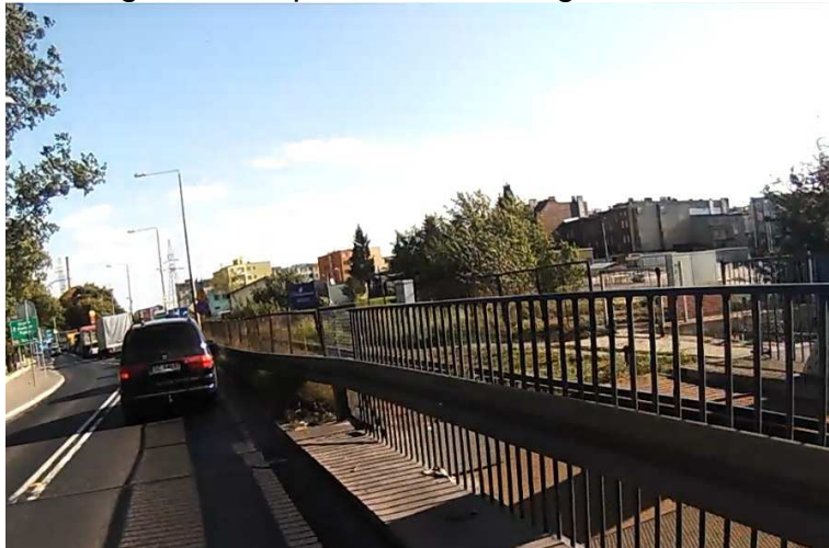
DK 16 (zabudowa na odcinku Dolna Grupa - Grudziądz)
