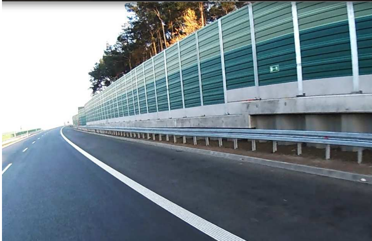
S 10a (ekran akustyczny oraz grunty leśne na odcinku tzw. południowej obwodnicy Torunia)
