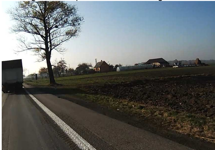
DK 1 (zabudowa na odcinku Lubień – Dąbrowice)
