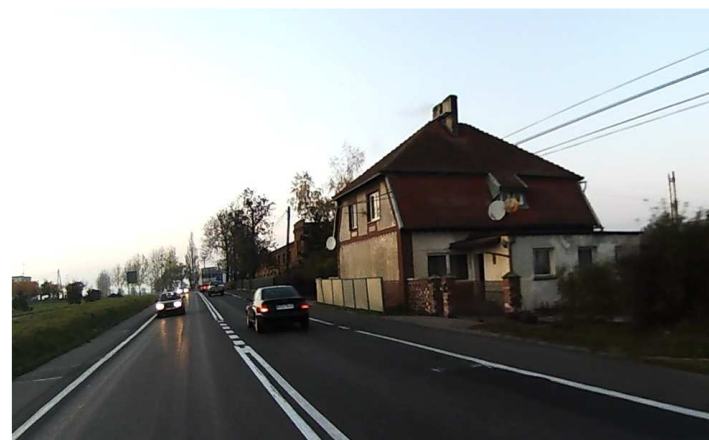
DK 1 (zabudowa na odcinku Chełmno - Stolno)
