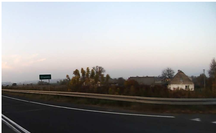
DK 1 (zabudowa na odcinku Chełmno - Stolno)
