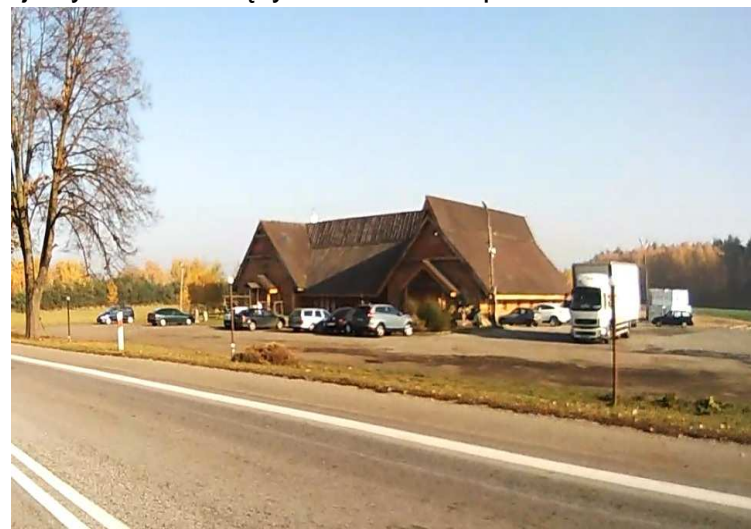
DK 1 (zabudowa na odcinku Lubień – Dąbrowice)
