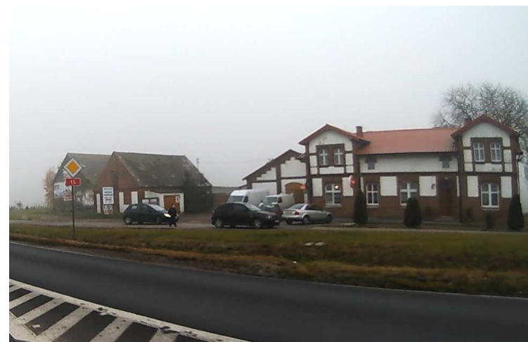
DK 15 (zabudowa na odcinku Łopnica - Kowalewo)
