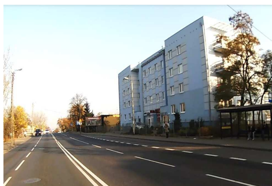
DK 80 (zabudowa na odcinku Bydgoszcz - Strzyżawa)
