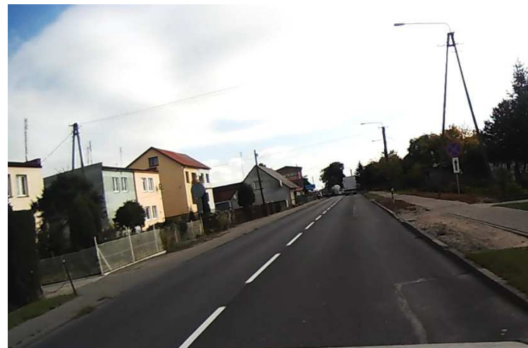
DK 10 (zabudowa na odcinku Nakło – gr. woj.)
