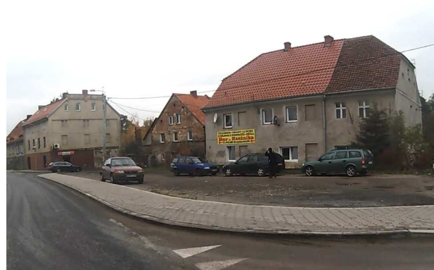
DK94 Zabudowa wielorodzinna na odcinku Wrocław – Środa Śląska
