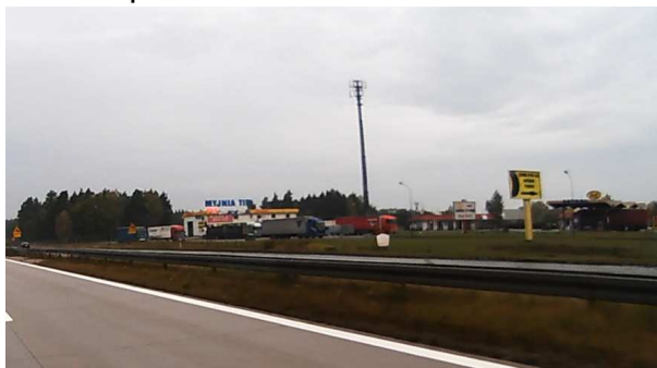
A18 Zabudowa usługowa na odcinku Golnice – Krzywa
