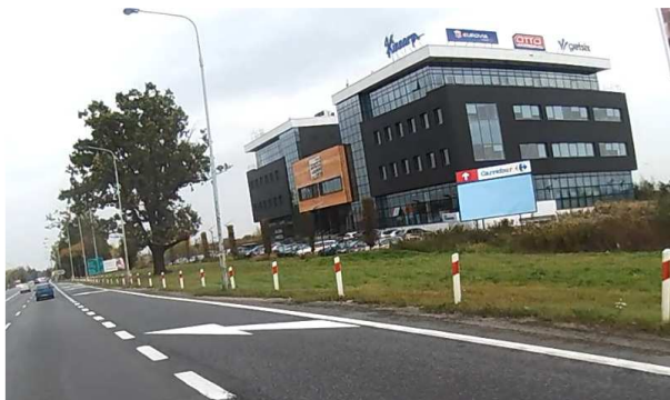
DK5 Zabudowa usługowa na odcinku Bielany Wrocławskie – Wrocław
