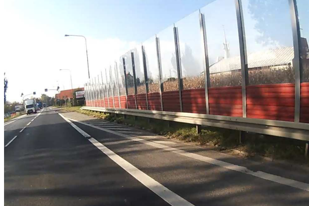
DK8 Ekranowana zabudowa na odcinku Polanka - Długoleka
