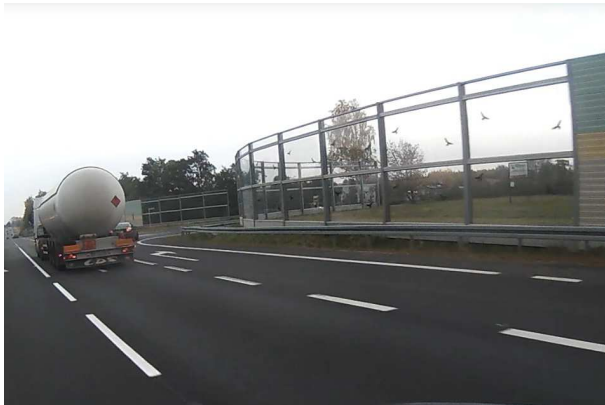
DK3 Ekranowana zabudowa w miejscowości Polkowice
