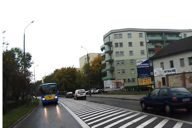
DK94 Zabudowa wielorodzinna w miejscowości Oława
