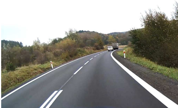
DK8 Lasy oraz nieużytki wzdłuż odcinka drogi krajowej
