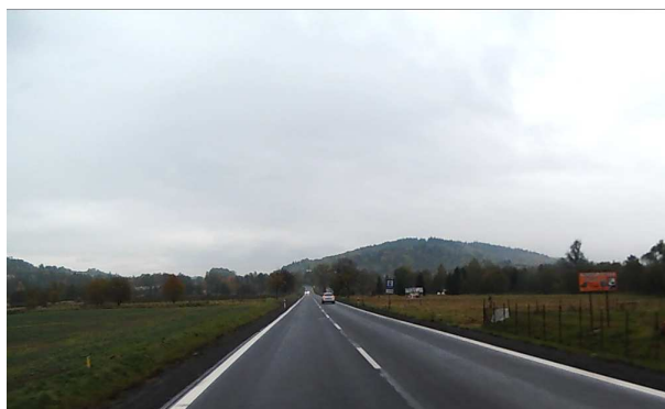
DK3 Pola uprawne, lasu oraz nieużytki wzdłuż odcinka drogi krajowej
