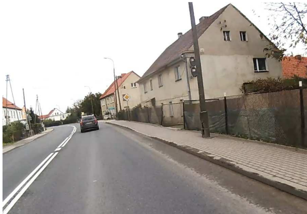
DK8 Zabudowa wielorodzinna na odcinku Ząbkowice - Łagiewniki
