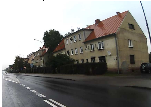
DK94 Zabudowa wielorodzinna w miejscowości Oława
