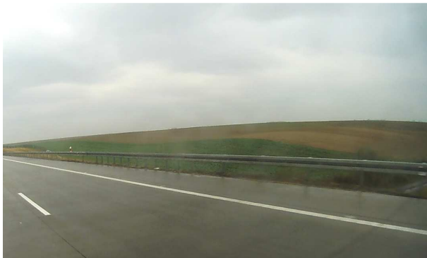
A4 Pola uprawne wzdłuż odcinka autostrady
