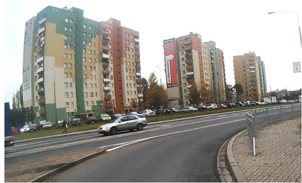
DK12 Zabudowa wielorodzinna i usługowa w miejscowości Głogów
