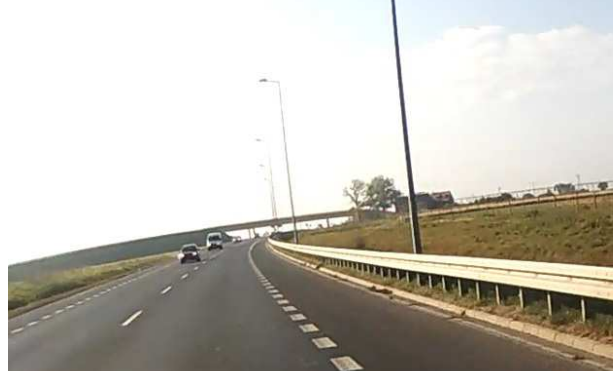
DK8 Nieużytki wzdłuż odcinka drogi krajowej
