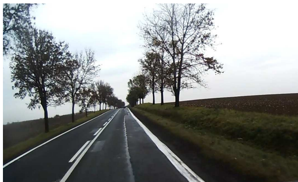
DK3 Zadrzewienia oraz pola uprawne wzdłuż odcinka drogi krajowej
