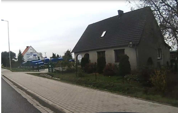
DK94 Zabudowa jednorodzinna na odcinku Wrocław – Środa Śląska
