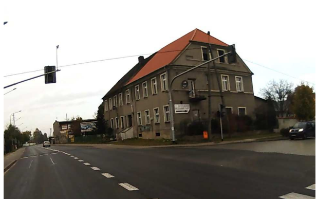
DK94 Zabudowa wielorodzinna na odcinku Wrocław – Groblice
