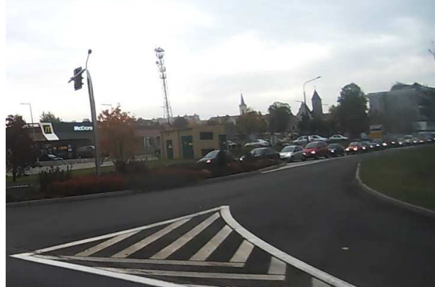
DK3 Zabudowa wielorodzinna i usługowa w miejscowości Polkowice
