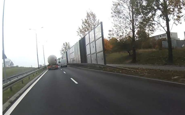
DK3 Ekranowana zabudowa wielorodzinna w miejscowości Polkowice
