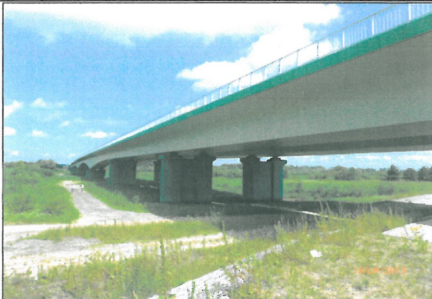
Fot. 1 Widok z boku od strony dolnej DW.
