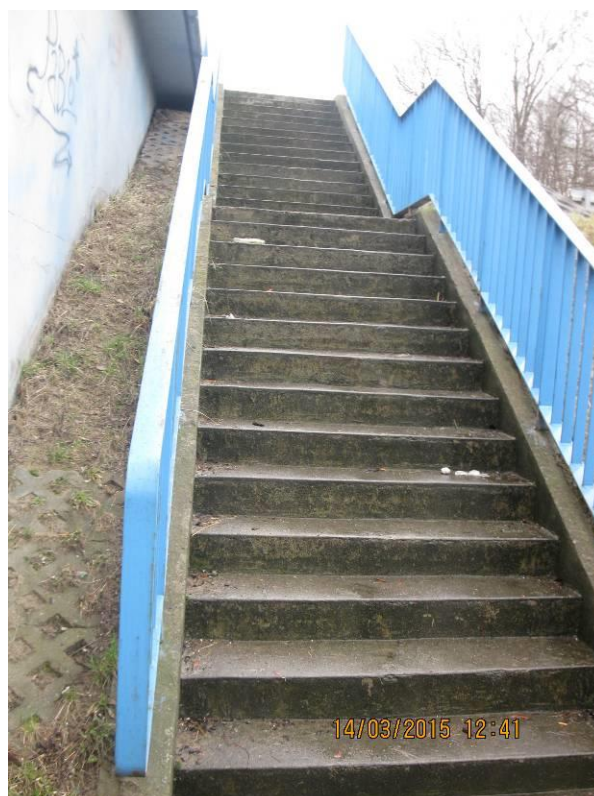
Fot. 36 Widok schodów skarpowych od strony m. Łochów (dolna woda). Bieg schodowy zanieczyszczony piaskiem i materiałem organicznym. Od strony obiektu umocnienie stożka prefabrykatami betonowymi, ażurowymi zanieczyszczone grubą warstwą piasku i roślinności.
