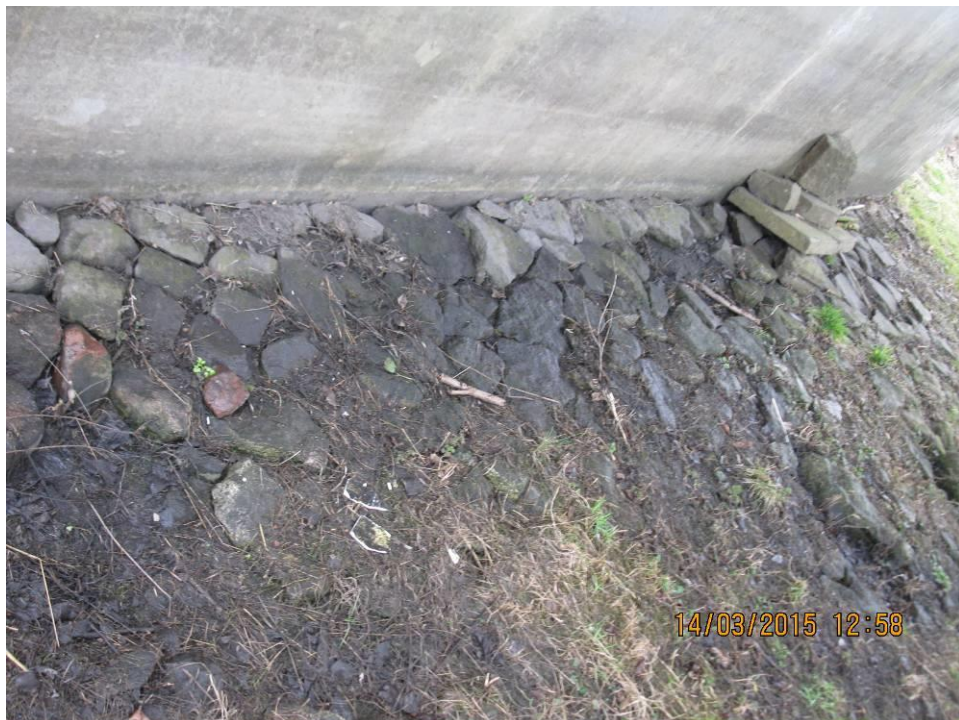
Fot. 31 Widok umocnienia narzutem kamiennym wokół podpór pośrednich. Widoczne ubytki w umocnieniu, nierówności umocnienia oraz zanieczyszczenie roślinnością trawiastą i fragmentami obumarłych gałęzi drzew.
