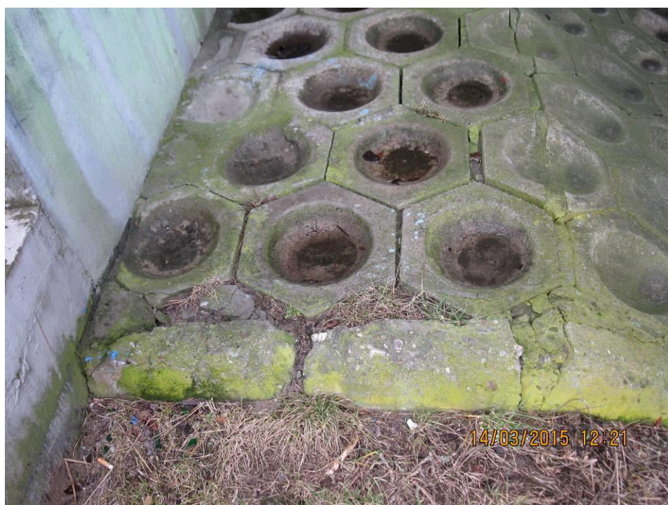
Fot. 38 Zbliżenie na umocnienie nasypu pod obiektem od strony m. Łochów. Widoczne zanieczyszczenia i ubytki spoin betonowych w rejonie prefabrykatów betonowych.
