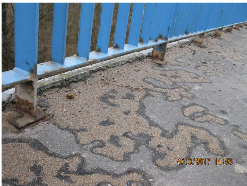
Fot. 14 Widok dolnej części balustrady szczepinkowej. Występuje silna korozja i zanieczyszczenie elementów balustrady w rejonie nawierzchni asfaltowej chodników dla pieszych.
