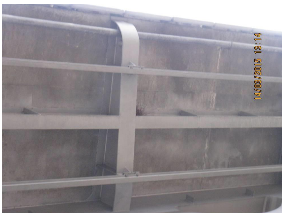
Fot. 22 Widok części wspornikowej płyty pomostu. Powierzchnia betonowa z niewielkimi punktowymi wapiennymi wykwitami. Widoczne siedliska ptaków w konstrukcji stalowej. Stan powierzchni betonowej i elementów stalowych jest dobry.
