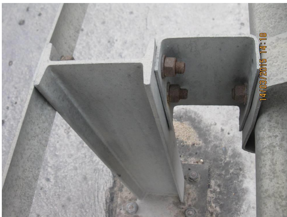
Fot. 12 Widok korozji śrub barier mostowych oraz zanieczyszczenia piaskiem i osadami w rejonie stopek barier.
