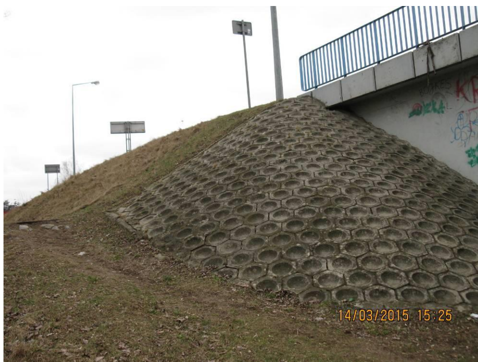
Fot. 40 Boczne umocnienie stożka nasypu drogowego. Umocnienie prefabrykatami betonowymi stożków nasypu są w dobrym stanie technicznym. Widoczne są niewielkie zanieczyszczenia piaskiem, materiałem organicznym i ciemnymi wykwitami. Pomiędzy prefabrykatami wykruszeniu uległo spoinowanie z zapraw cementowych.
