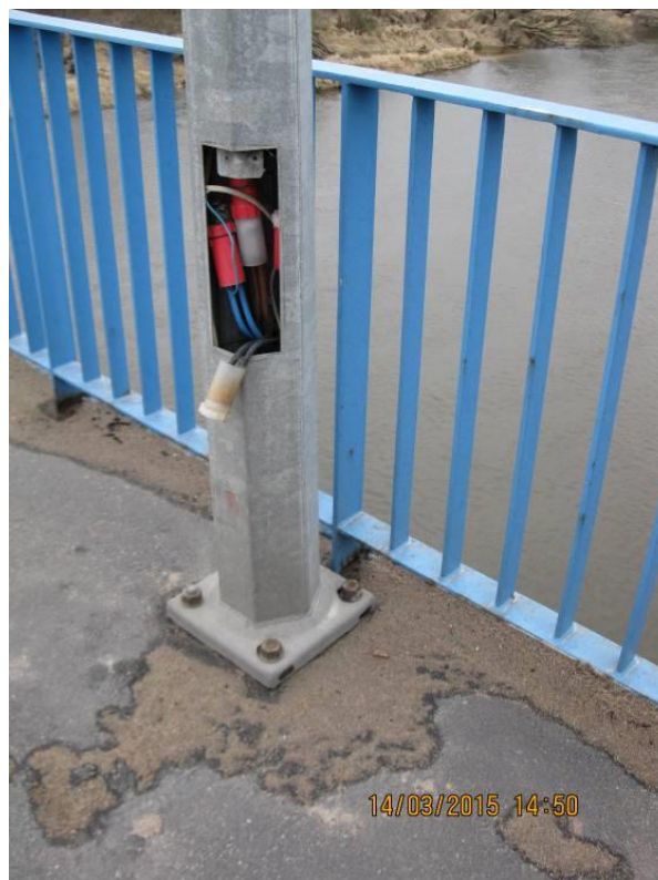
Fot. 15 Widok stalowego słupa oświetlenia ulicznego. Brak pokrywy rewizyjnej zabezpieczenia urządzeń elektrycznych. Postępująca korozja śrub mocowania słupa do konstrukcji mostu.
