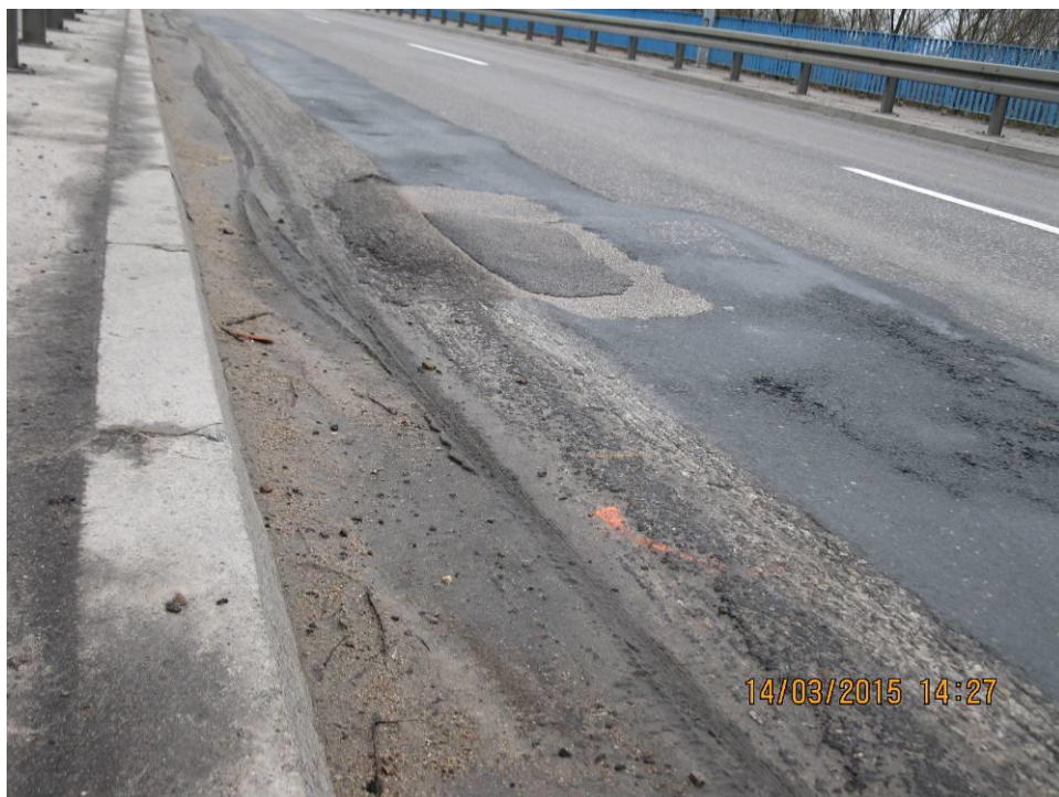
Fot. 7 Widok nawierzchni na obiekcie. Nawierzchnia z mas asfaltowych z widocznymi kilkucentymetrowymi skoleinowaniami, zaniżeniami i ubytkami. Widoczne ślady licznych napraw nawierzchni poprzez frezowanie i uzupełnianie uszkodzeń. W rejonie krawężników kamiennych zanieczyszczenie piaskiem i fragmentami organicznymi. Krawężniki zanieczyszczone ciemnymi wykwitami i piaskiem. Ogólny ich stan jest dobry.
