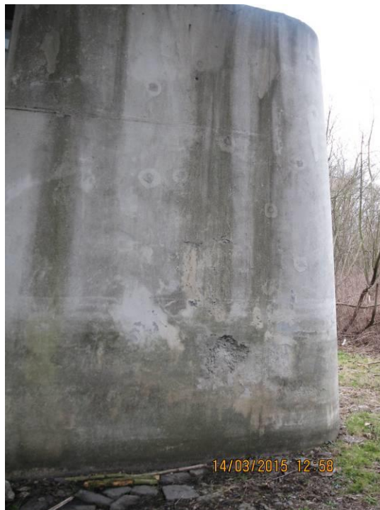
Fot. 29 Widok fragmentu podpory pośredniej mostu. Na powierzchni betonowej widoczne liczne ciemne wykwity, niewielkie złuszczenia górnej zewnętrznej struktury betonu oraz zawilgocenia w rejonie styku z podłożem.
