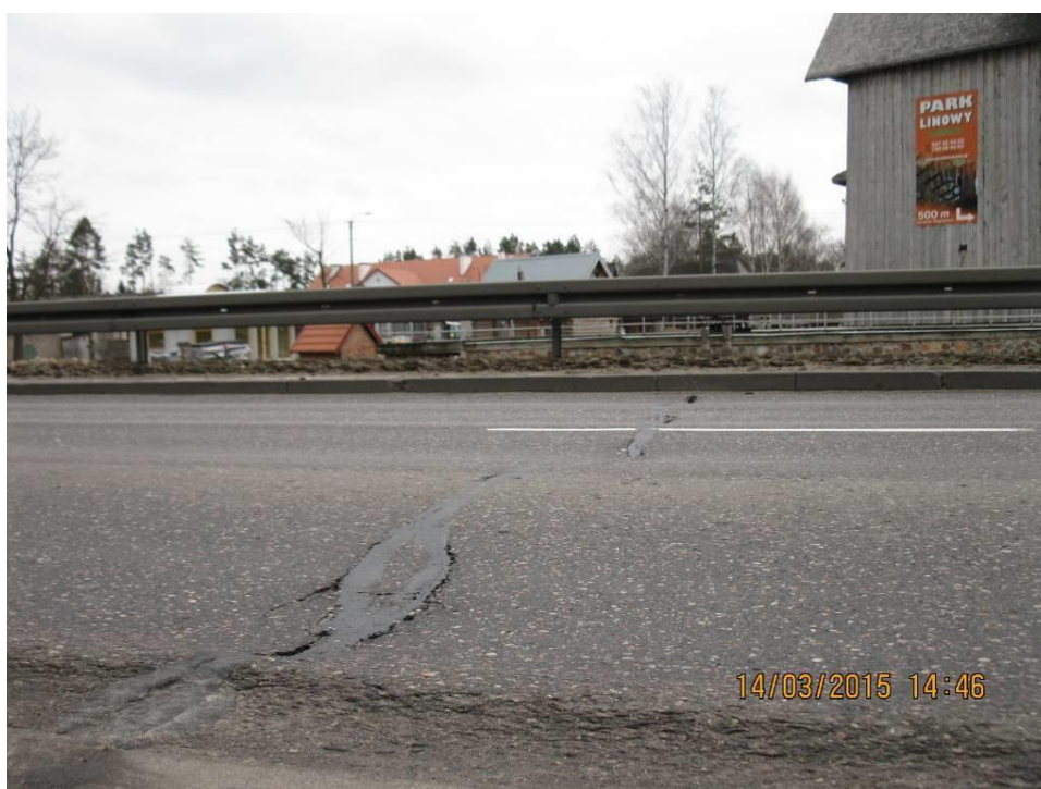
Fot. 2 Widok jezdni na dojazdach w zbliżeniu od str. m. Ostrów Maz.. Jezdnia uszkodzona pęknięciami poprzecznymi, którym towarzyszą ubytki mas bitumicznych. Kilkucentymetrowe zkleinowanie podłużne jezdni w rejonie ruchu kół pojazdów poruszających się po jezdni. Widoczne próby naprawy nawierzchni.
