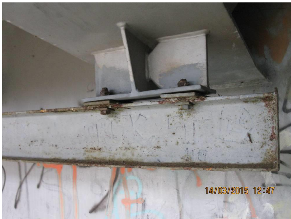
Fot. 17 Widok wieszaka i prowadnicy wózków technicznych do obsługi mostu. Występuje uszkodzenie powłok malarskich i korozja powierzchniowa elementów stalowych. Na dalszym planie zanieczyszczenie dźwigarów stalowych graffiti.
