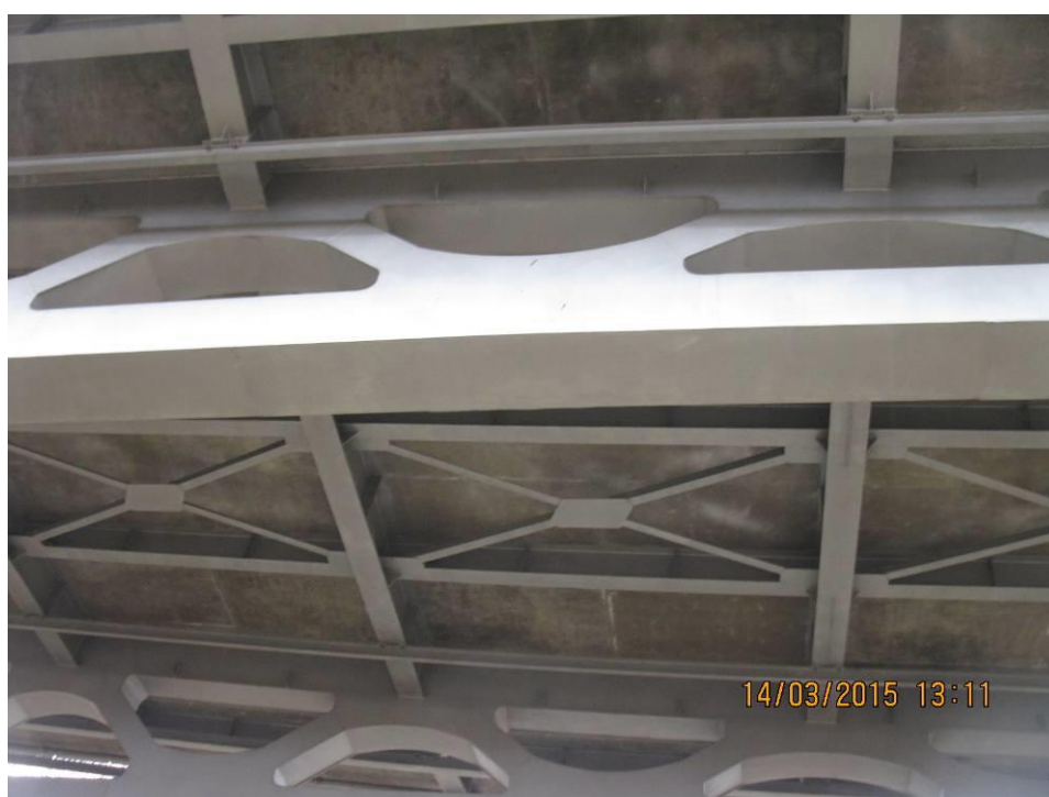
Fot. 16 Widok konstrukcji stalowej nośnej od spodu. Elementy konstrukcyjne w dobrym stanie technicznym. Jedynie lokalnie w rejonie styku elementów stalowych z płytą żelbetową występują niewielkie skupiska rdzy powierzchniowej.
