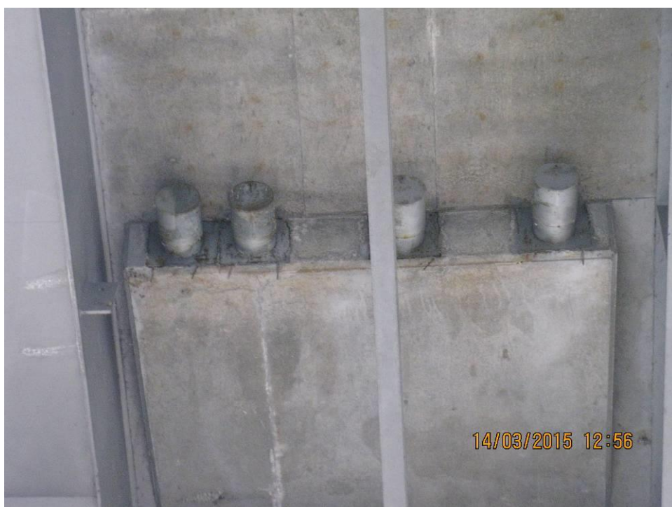
Fot. 20 Widok bloków osłonowych sprężenia żelbetowej płyty pomostu nad podporami. Stalowe osłony głowic kabli sprężających posiadają uszkodzone powłoki antykorozyjne, którym towarzyszą skupiska korozji powierzchniowej metalu. Na powierzchni betonowej niewielkie rdzawe i wapienne wykwity.
