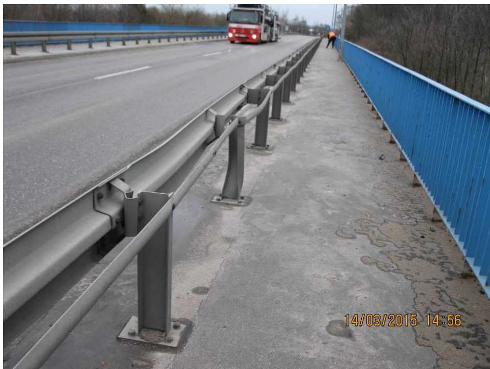
Fot. 13 Widok uszkodzenia bariery mostowej (dolna woda). Na skutek uderzenia pojazdu odkształceniu uległ fragment bariery tj. słupki, listwy, przekładki i taśmy.
