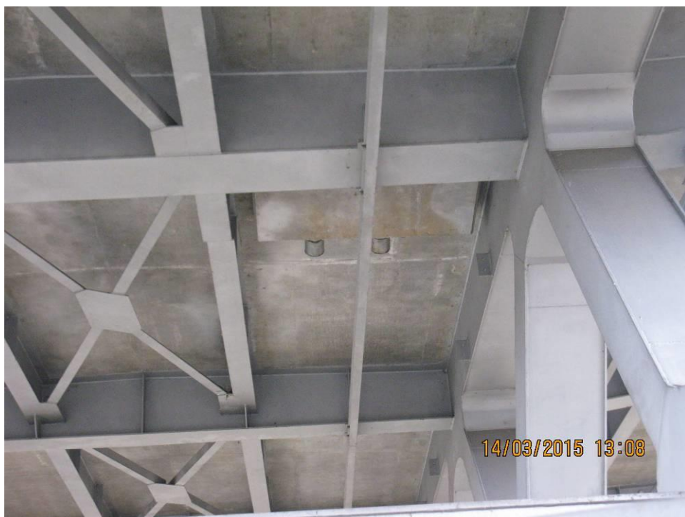
Fot. 19 Widok od spodu płyty pomostu w strefie betonowych bloków oporowych sprężenia płyty pomostu nad podporami. Powierzchnia betonu w rejonie bloków sprężających zanieczyszczona rudymi wykwitami korozji osłon głowic zakotwień kabli sprężających. Beton płyty pomostu w bardzo dobrym stanie technicznym. Widoczne siedliska (gniazda) ptaków na konstrukcji stalowej obiektu.
