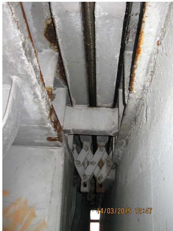
Fot. 5 Widok dylatacji od spodu od strony m. Łochów. Nisza dylatacyjna zanieczyszczona wapienno – rdzawymi wykwitami i przeciekami z dylatacji. Występuje lokalna intensywna korozja elementów stalowych dylatacji w strefie zmiany poziomu płyty pomostu (strefa krawężnikowa). W rejonie dylatacji zanieczyszczenia graffiti na powierzchniach betonowych przyczółków.
