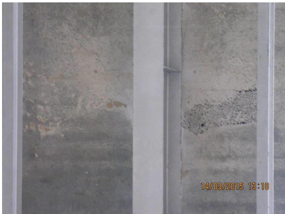
Fot. 21 Widok w zbliżeniu na powierzchnię spodnią płyty pomostu. Na powierzchni betonowej widoczne punktowe wapienne przebarwienia oraz tzw. „RAKI” powstałe podczas układania mieszanki betonowej przy betonowaniu płyty.
