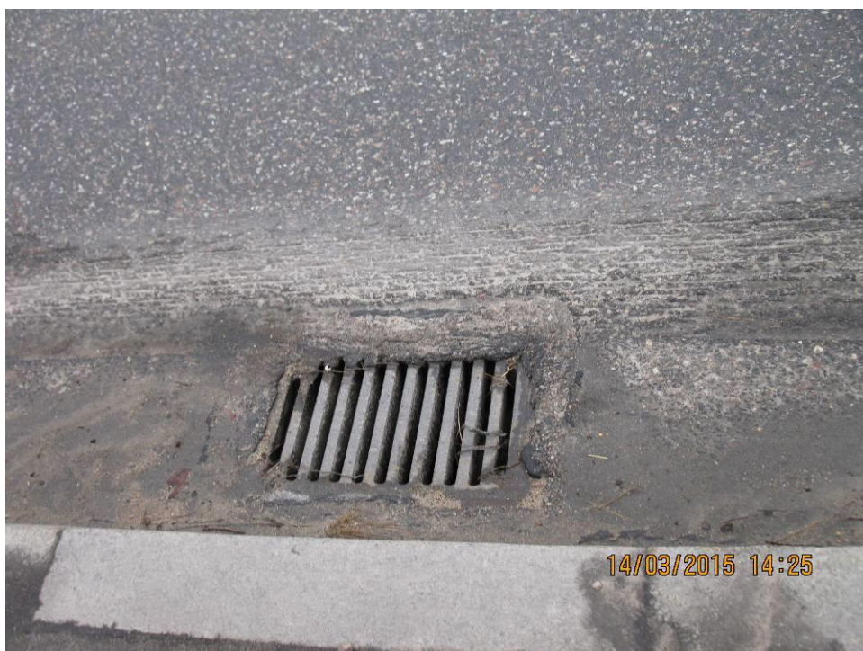
Fot. 10 Widok wpustu mostowego. Wlot wpustu częściowo ograniczony deformacją mas asfaltowych nawierzchni jezdni, piaskiem i fragmentami materiału organicznego utrudniającego sprawny odpływ wody z jezdni.
