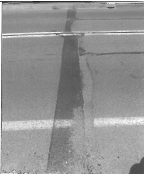
Fot. 18 Dylatacja od strony Myszyńca widoczne odspojenie masy, deformacja i ubytki.
