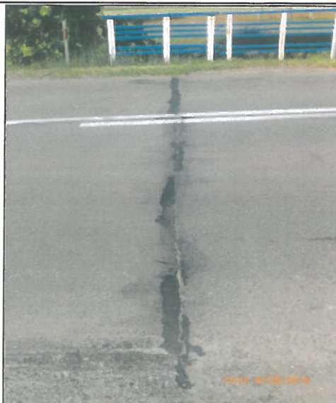
Fot. 10 Poprzeczna rysa na wysokości skrzydła od Ostrołeki.
