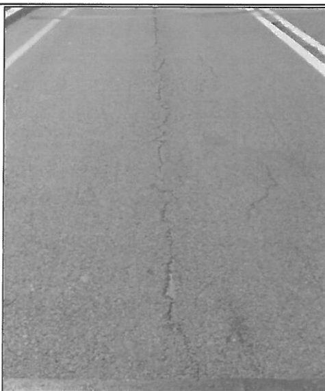
Fot. 8 Nawierzchnia na obiekcie z widocznymi rysami.
