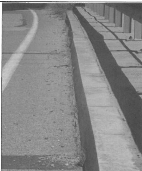
Fot. 6 Zanieczyszczenia i wegetacja roślin na nawierzchni w strefie przykrawężnikowej.
