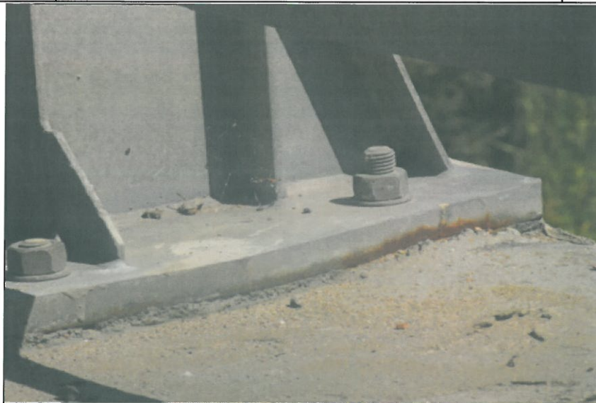
Fot. 9 korozja stopy słupka barieroporeczy. Widoczne ubytki w nawierzchnioizolacji belki podporęczowej.
