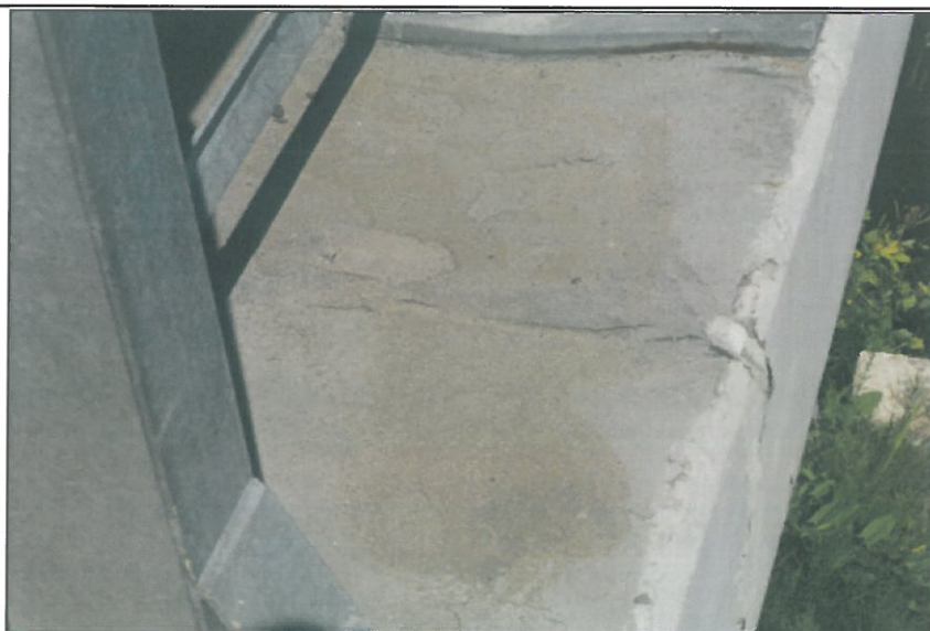
Fot. 14 Rysy i ubytki nawierzchnioizolacji oraz korozja stopy słupka na belce podporęczowej - strona lewa.
