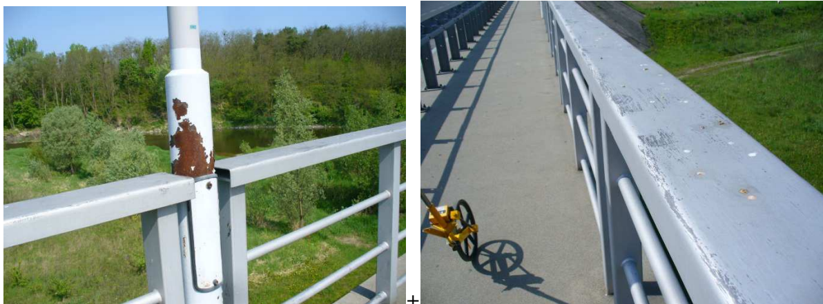
Uszkodzenia zabezpieczeń antykorozyjnych słupów latarni oraz balustrady.
