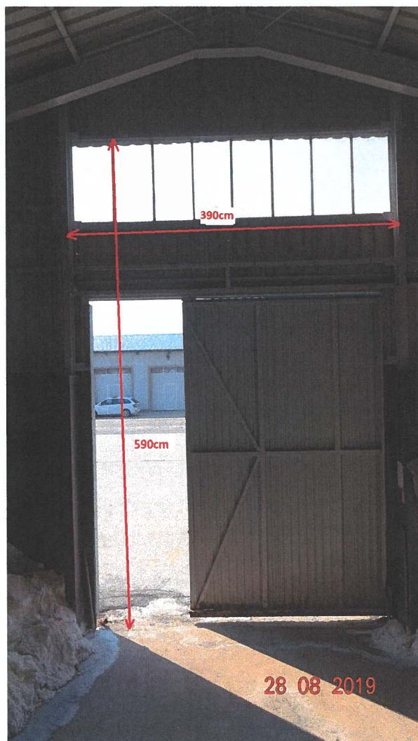
Widok bramy od wewnątrz magazynu z orientacyjnymi wymiarami otworu bramowego
