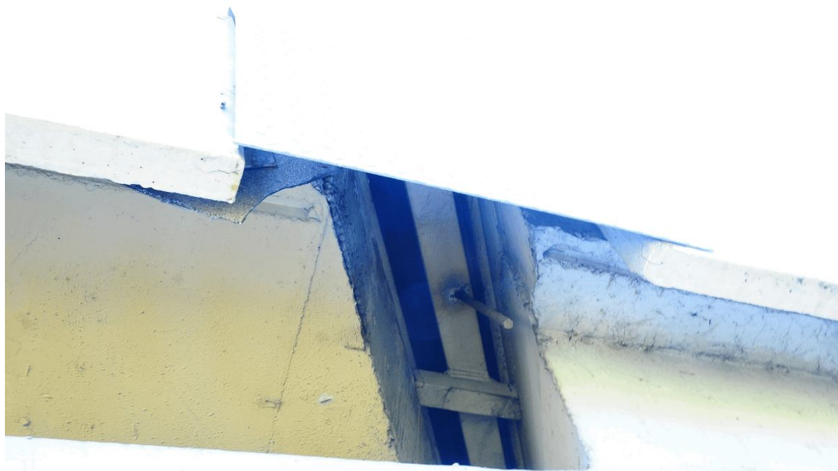
Fot. 39. Widok na urządzenie dylatacyjne na chodniku od strony Katowic nad przyczółkiem od strony Wieliczki. Rdzawe plamy na nawierzchni chodnika powstałe w wyniku korozji profili stalowych urządzenia.
