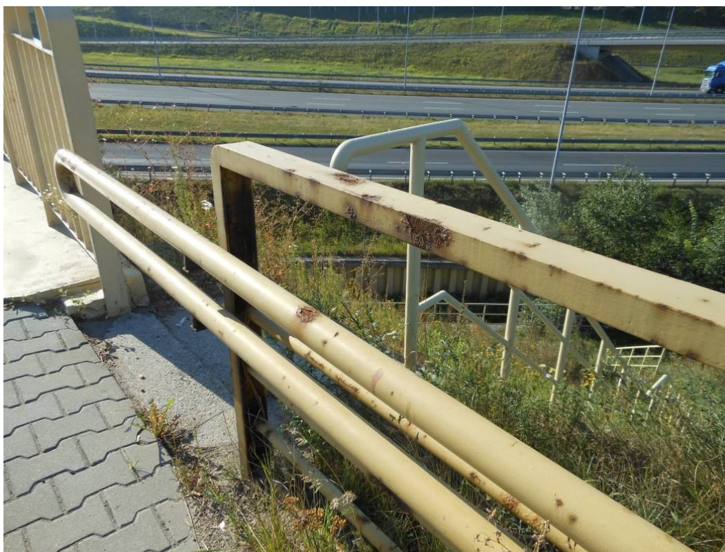
Fot. 28. Widok na balustradę od strony Katowic na dojeździe od strony Krakowa. Ubytki zabezpieczenia antykorozyjnego oraz ślady korozji.
