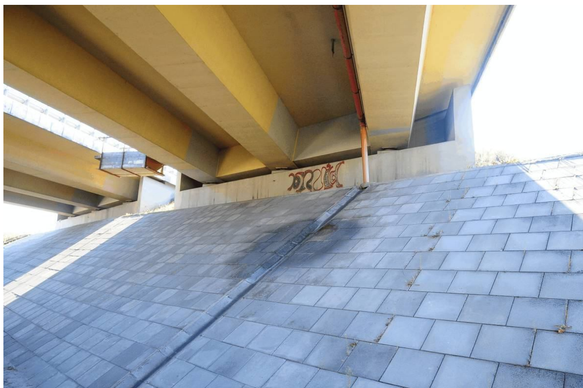
Fot. 64. Widok na przyczółek od strony Wieliczki. Zanieczyszczenia korpusu w postaci graffiti, zacieki na powierzchni umocnienia skarpy przyczółka ze ściekającej wody z sączka.
