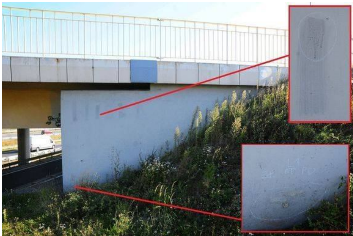
Fot. 65. Widok od strony Katowic na skrzydełko przyczółka od strony Wieliczki. Złuszczenia powłoki malarskiej w dolnej części skrzydełka, zanieczyszczenie w postaci graffiti.
