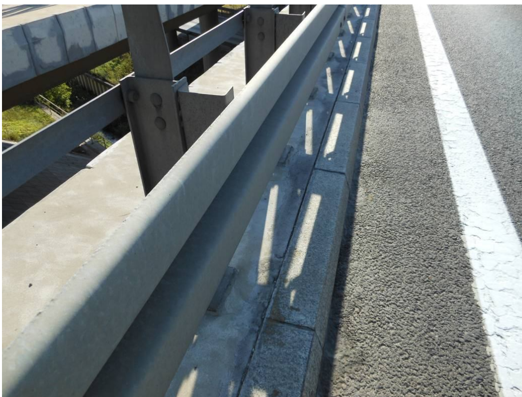
Fot. 10. Widok na pobocze techniczne od strony Tarnowa w prześle nr 1. Niedokończony remont nawierzchni pobocza. Brak wierzchniej nawierzchni oraz uszczelnienia styku kapy z krawężnikiem.
