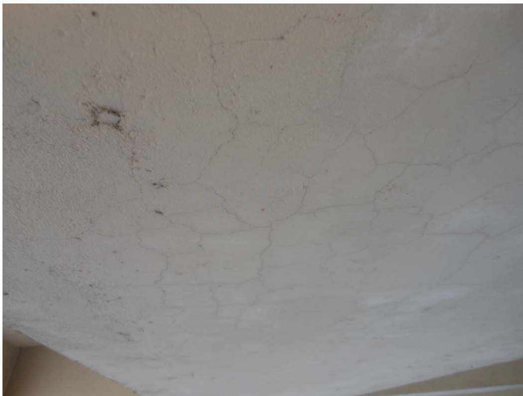
Fot. 47. Widok na spód dźwigara nr 2 w przęśle nr 6. Widoczna siatka zarysowań skurczowych o rozwarości 0,1 mm.
