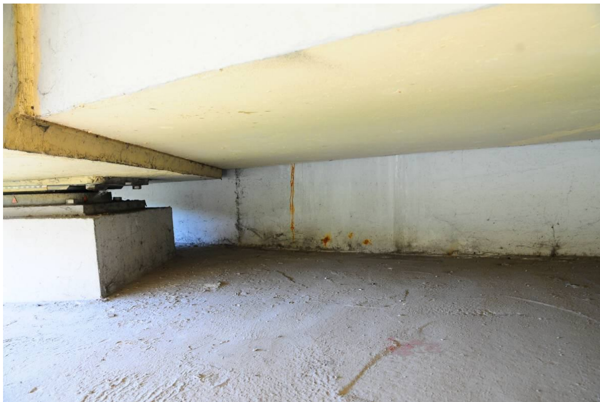
Fot. 61. Widok na ławę łożyskową oraz ściankę zapleczną przyczółka od strony Krakowa. Rdzawe zacieki na powierzchni ścianki zapleczej powstałe w wyniku korozji na styku urządzenia dylatacyjnego ze ścianką zapleczną. Rdzawe plamy wskazujące na korozję zbrojenia lub pozostawionych w betonie opórek do szalunków.
