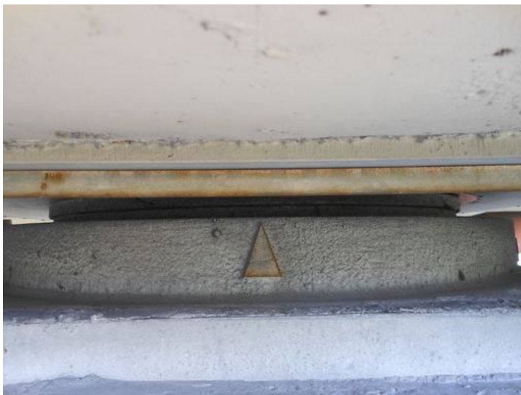
Fot. 79. Widok od strony Katowic na łożysko dźwigara nr 3 na podporze nr 6. Korozja skali przesuwu łożyska uniemożliwiająca odczyt.
