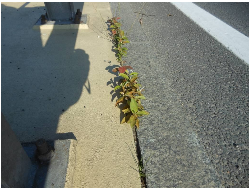
Fot. 9. Widok na chodnik i krawężnik od strony Katowic w prześle nr 1. Odspojenie krawężnika od kapy chodnikowej wypełnione roślinnością.
