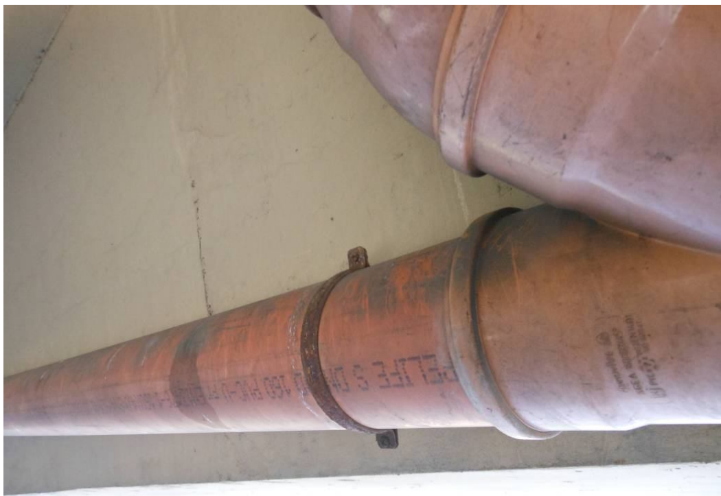
Fot. 29. Widok na kolektor odwodnienia w przęśle nr 1 od strony Katowic. Korozja elementu podwieszenia, zanieczyszczenia kolektora w postaci kurzu.
