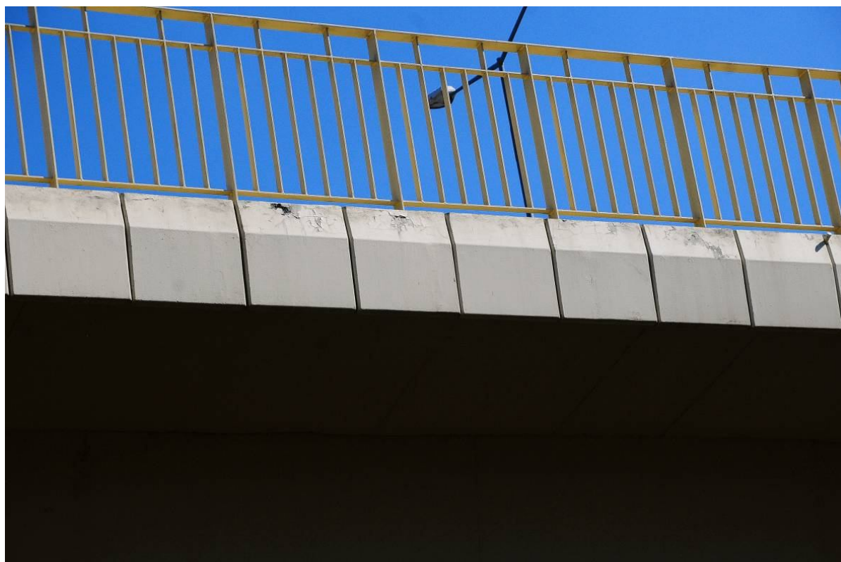
Fot. 17. Widok od strony Katowic na gzyms w nad podporą nr 5. Ubytki i spękania betonu w górnej części desek powstałe w wyniku korozji betonu.
