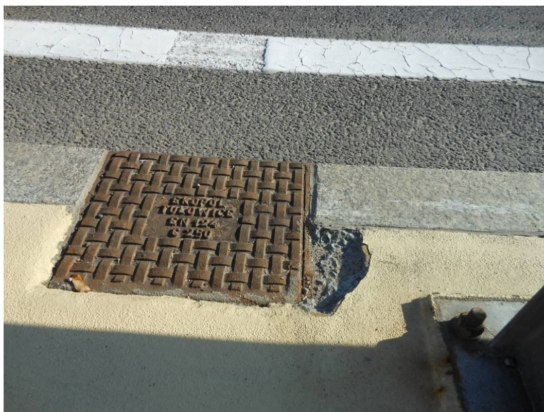
Fot. 8. Widok od strony Katowic na wpust krawężnikowy nr 10 w prześle nr 6. Ubytki betonu kapy chodnikowej przy wpuście powstałe w wyniku korozji betonu. Powierzchniowa korozja pokrywy wpustu.
