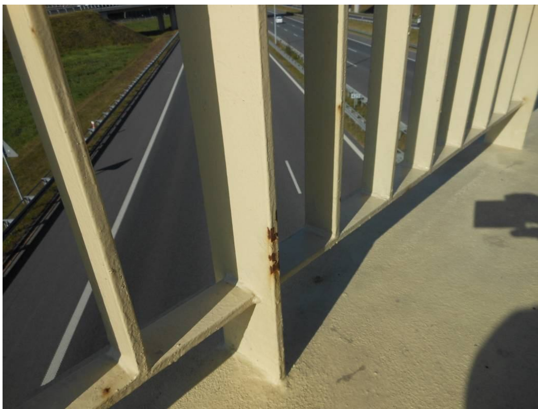
Fot. 23. Widok na balustradę od strony Katowic w przęśle nr 4. Ubytki zabezpieczenia antykorozyjnego oraz ślady korozji słupka spowodowane wadliwym wykonaniem zabezpieczenia.
