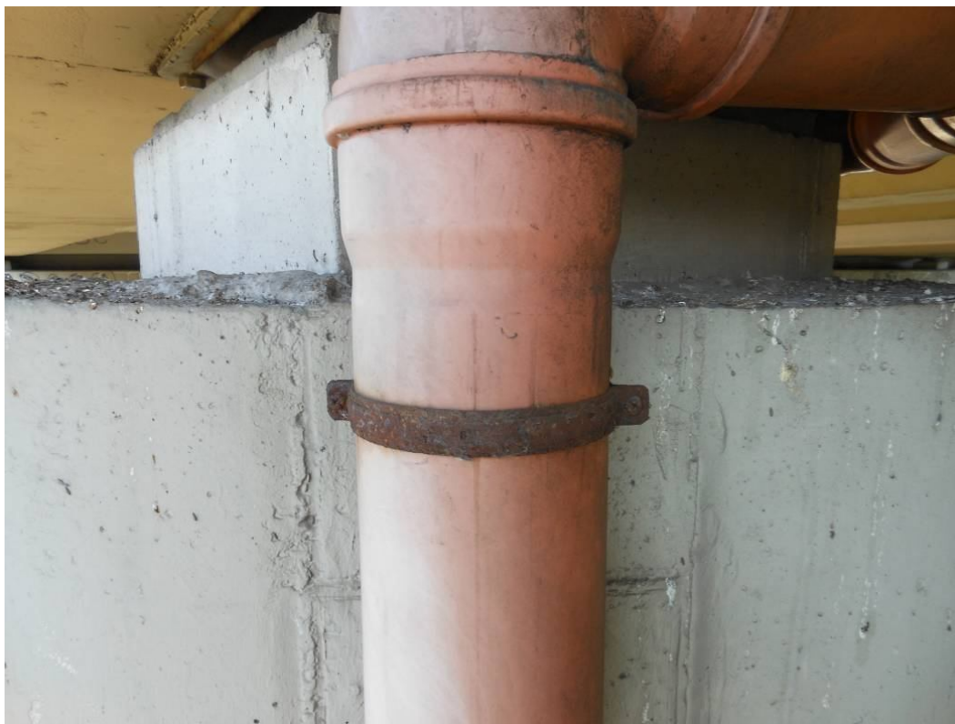
Fot. 31. Widok na rurę spustową odwodnienia od strony Katowic przy podporze nr 2. Korozja elementu mocującego rurę do filara.
