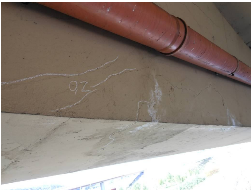
Fot. 43. Widok od strony Tarnowa na dźwigar nr 3 w przęśle nr 1. Zarysowania o rozwartości 0,2 mm, wapienne zacieki w zarysowaniach, ślady naprawy powierzchni betonu dźwigara sprężonego.
