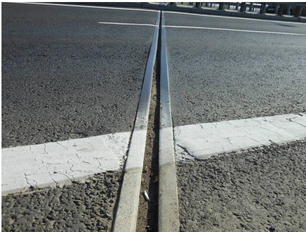
Fot. 37. Widok na urządzenie dylatacyjne na jezdni nad przyczółkiem od strony Krakowa. Zanieczyszczenie wkładki urządzenia, odspojenia profili stalowych od nawierzchni jezdni.
