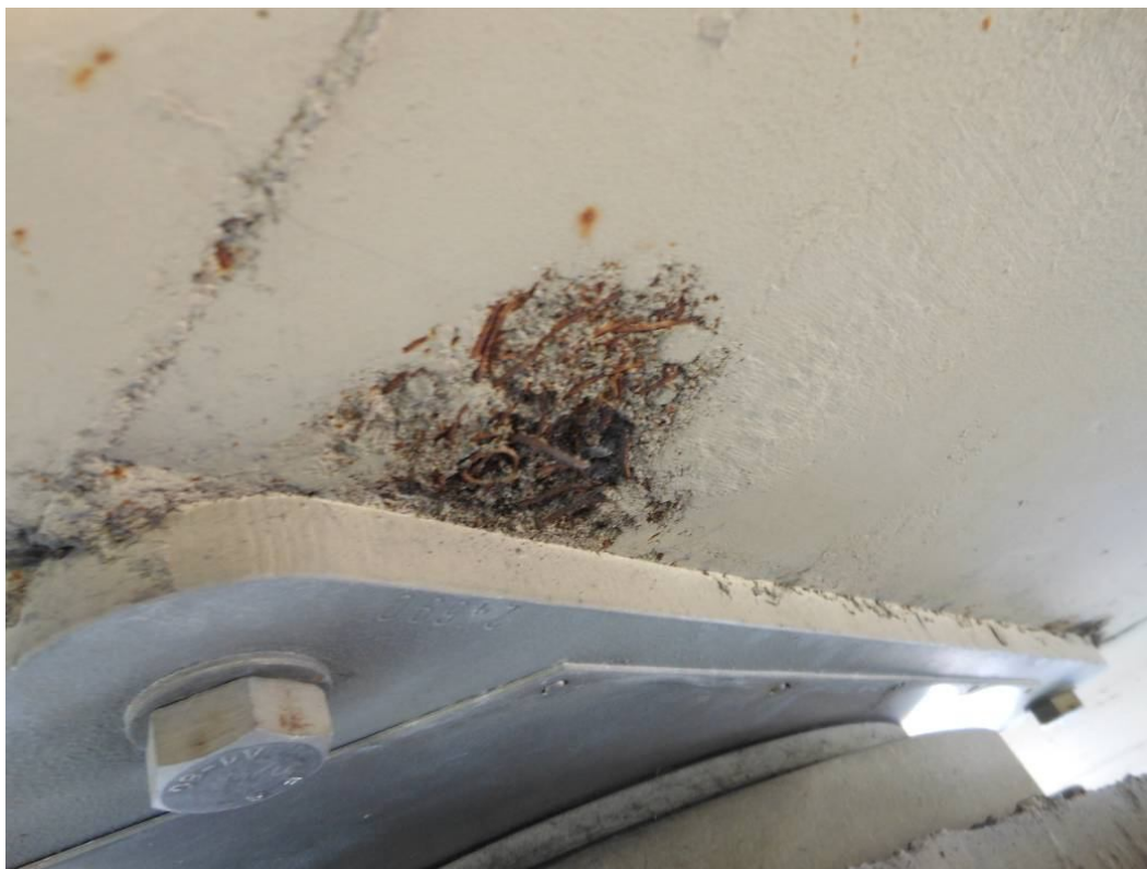
Fot. 41. Widok na spód dźwigara nr 2 nad podporą nr 2. Korozja zanieczyszczeń w postaci drutu wiążałkowego.
