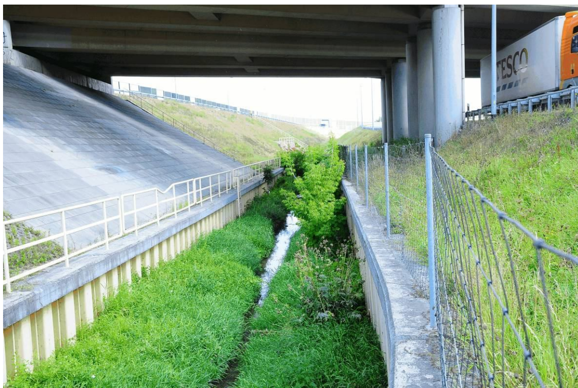
Fot. 90. Widok na koryto potoku pod przęsłem nr 1. Zanieczyszczenia koryta roślinnością.
