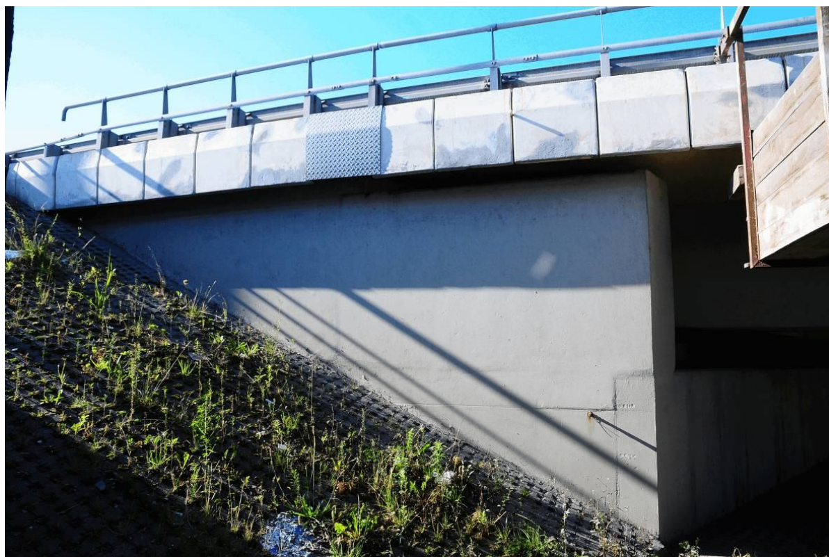
Fot. 66. Widok od strony Tarnowa na skrzydełko przyczółka od strony Wieliczki. Ślady naprawy powierzchniowej betonu w miejscu przerwy w betonowaniu, korozja reperu roboczego.
