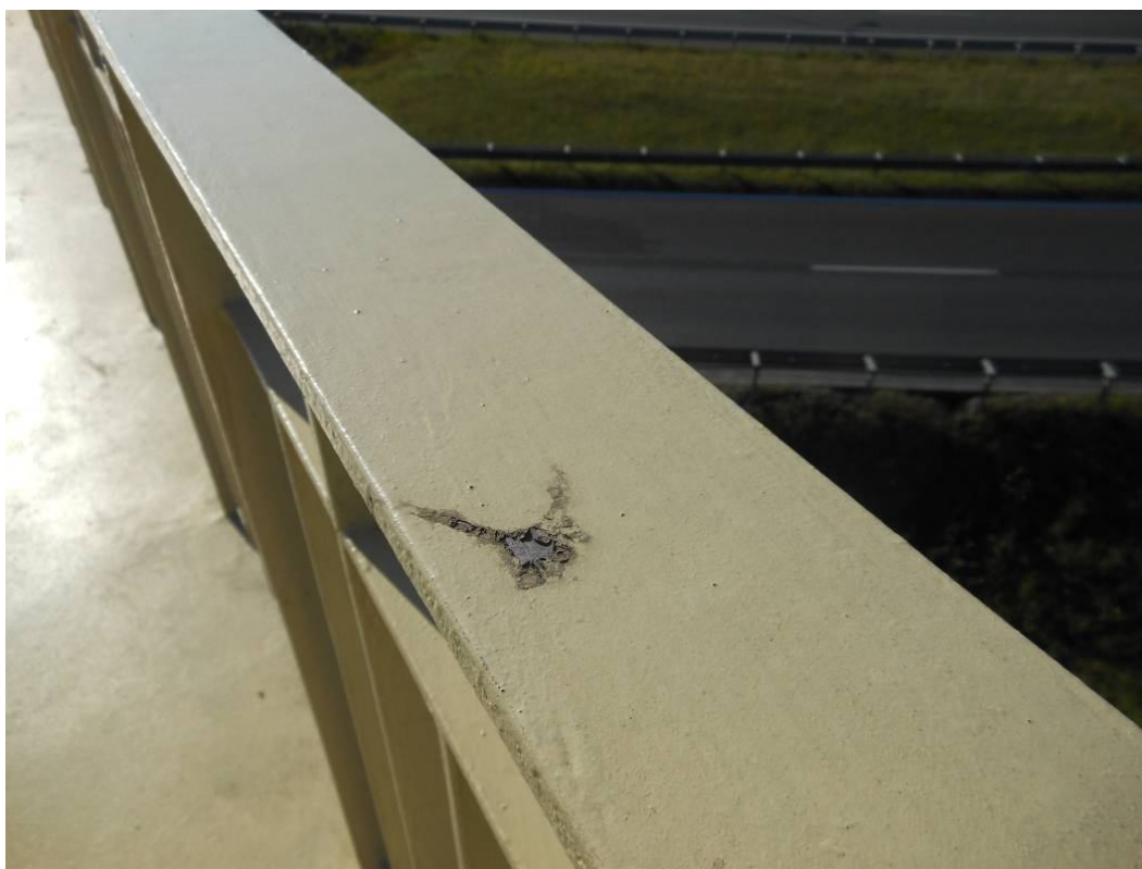
Fot. 24. Widok na balustradę od strony Katowic w przęśle nr 1. Ubytki zabezpieczenia antykorozyjnego pochwyty spowodowane wadliwym wykonaniem zabezpieczenia.
