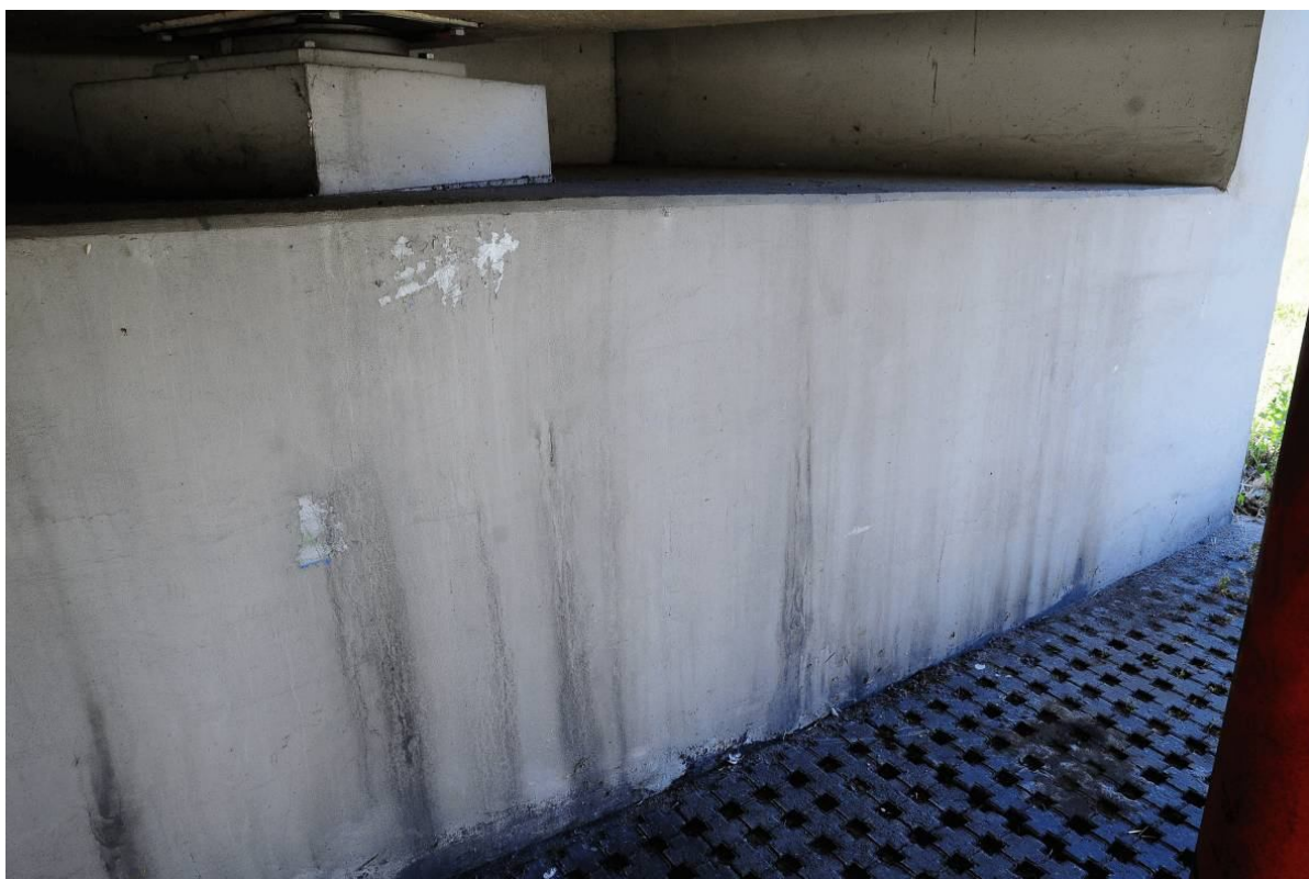
Fot. 70. Widok na korpus przyczółka od strony Wieliczki. Zanieczyszczenia oraz złuszczenia powłoki malarskiej powstałe w wyniku wadliwego wykonania.
