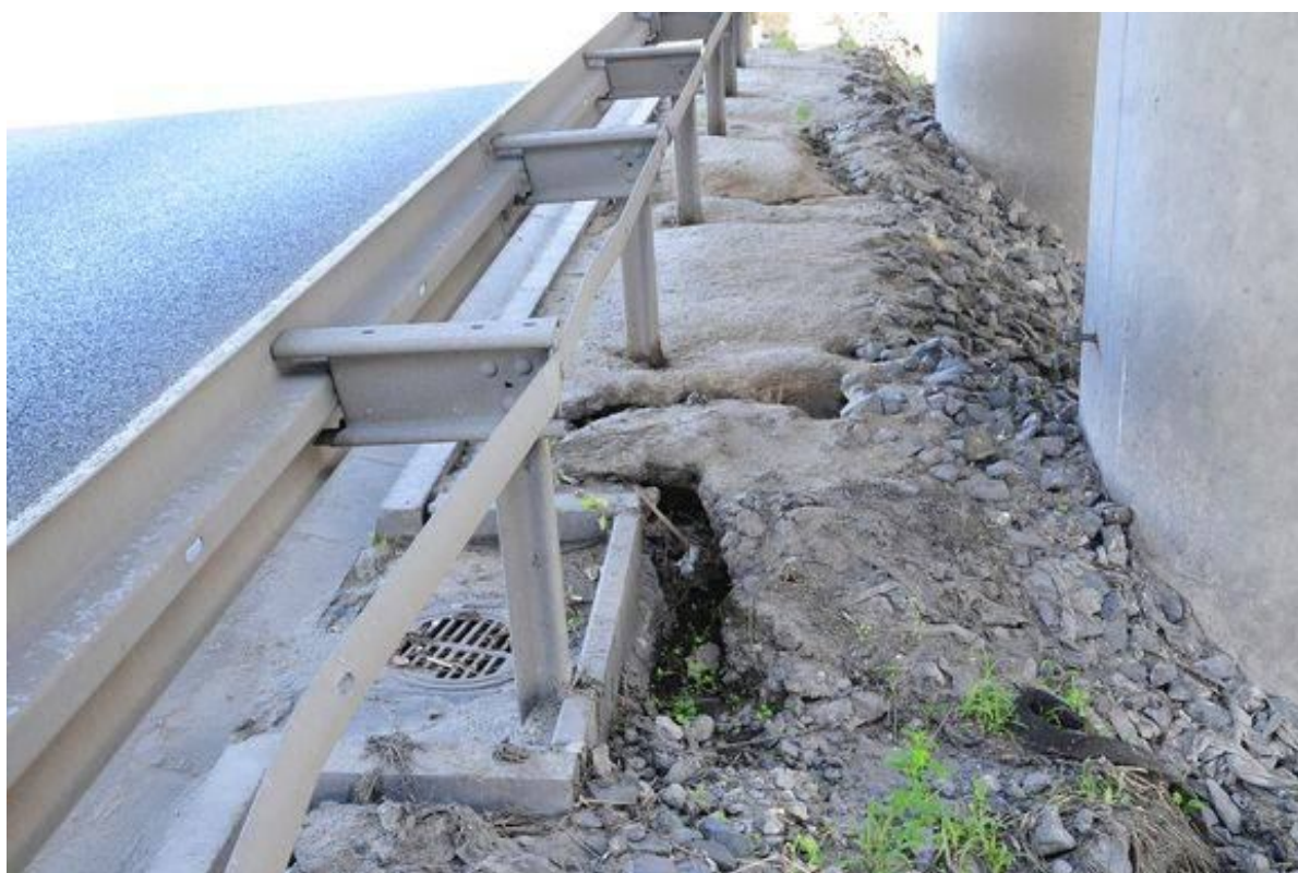
Fot. 88. Widok na przestrzeń podmostową w przęśle nr 2 przy podporze nr 2. Ubytki erozyjne skarpy powstałe w wyniku niekontrolowane spływu wód opadowych.
