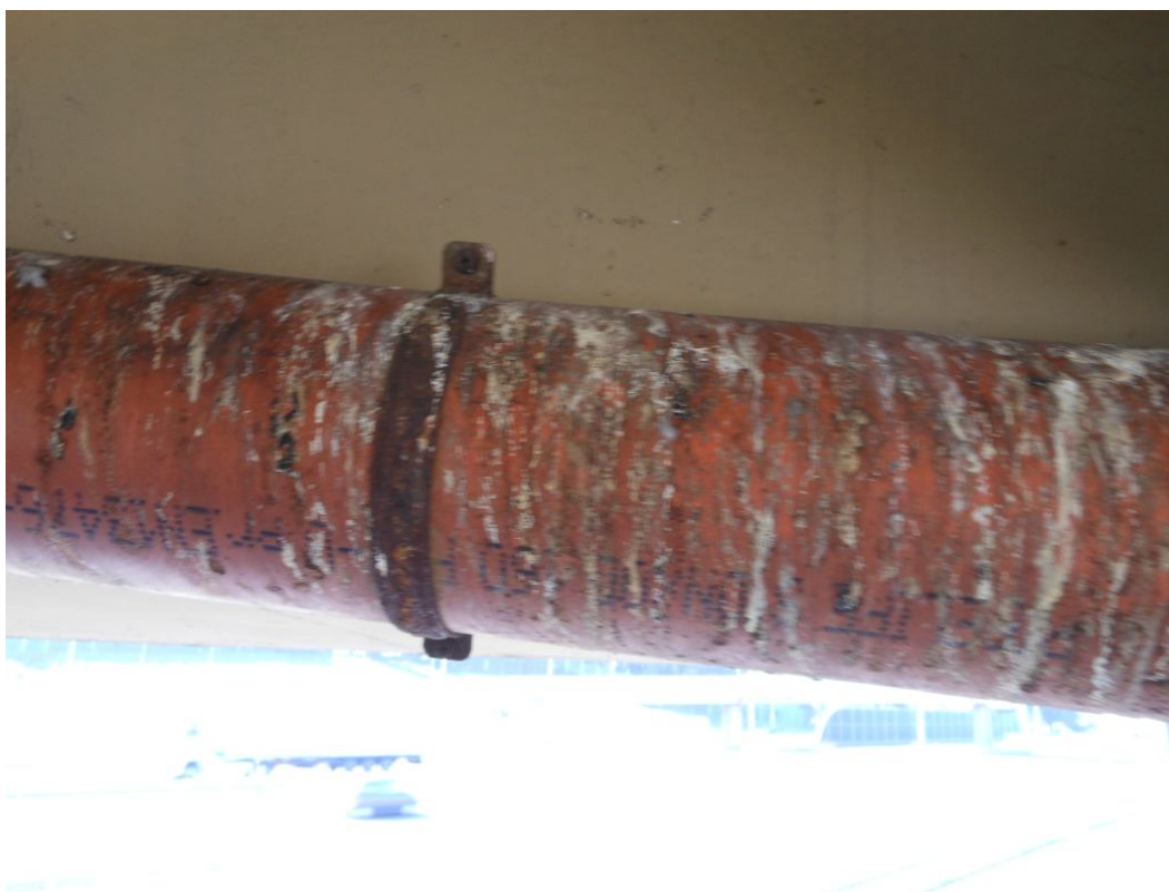
Fot. 30. Widok na kolektor odwodnienia w przęśle nr 1 od strony Katowic. Korozja elementu podwieszenia, zanieczyszczenia kolektora w postaci ptasich odchodów.
