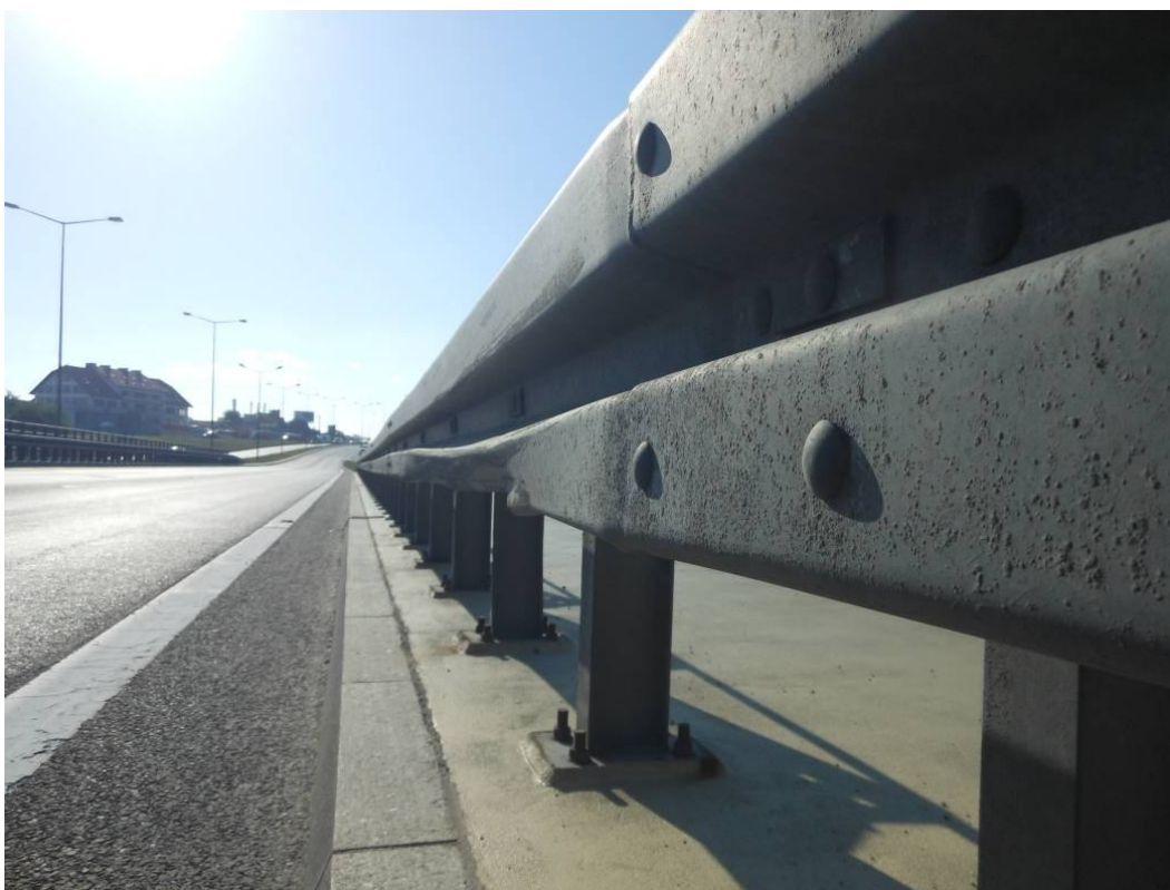
Fot. 22. Widok na barierę od strony Katowic nad podporą nr 6. Prowadnicy powstałe w wyniku uderzenia pojazdu.
