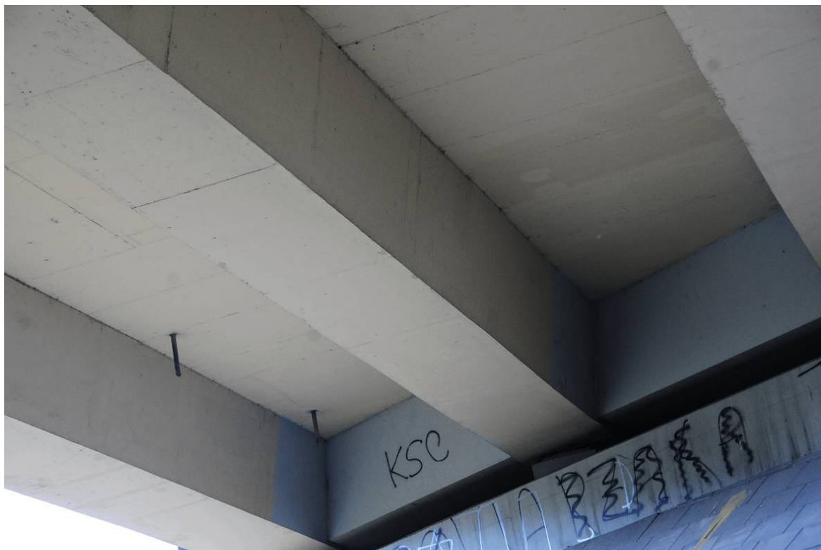
Fot. 53. Widok na oparcie pomostu na przyczółku od strony Krakowa. Ślady napraw powierzchniowych dźwigara i poprzecznicy, źle dobrany kolor powłoki malarskiej nałożonej po wykonanej naprawie, zanieczyszczenie poprzecznicy w postaci graffiti.
