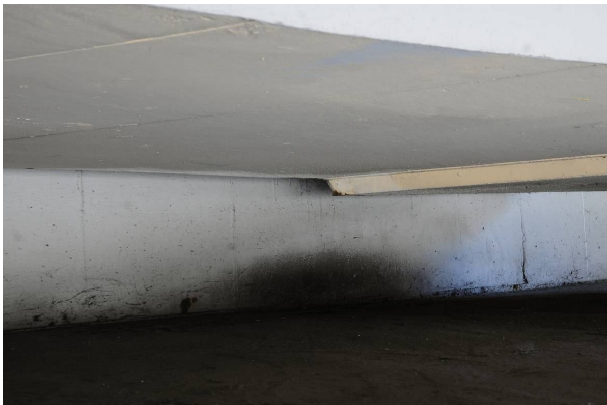
Fot. 69. Widok na ławę łożyskową i ściankę zapleczną przyczółka od strony Wieliczki. Zanieczyszczenia z pyłu zgromadzonego na ławie podłożyskowej rozbryzgiwanego przez wodę spływającą po zakończeniu przesła z nieszczelnego urządzenia dylatacyjnego.
