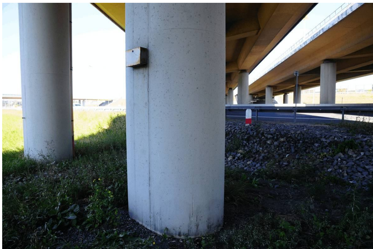
Fot. 73. Widok na podporę nr 5. Zanieczyszczenia powierzchni betonu. Skorodowana skrzynka będąca pozostałością po zdemontowanym urządzeniu obcym.
