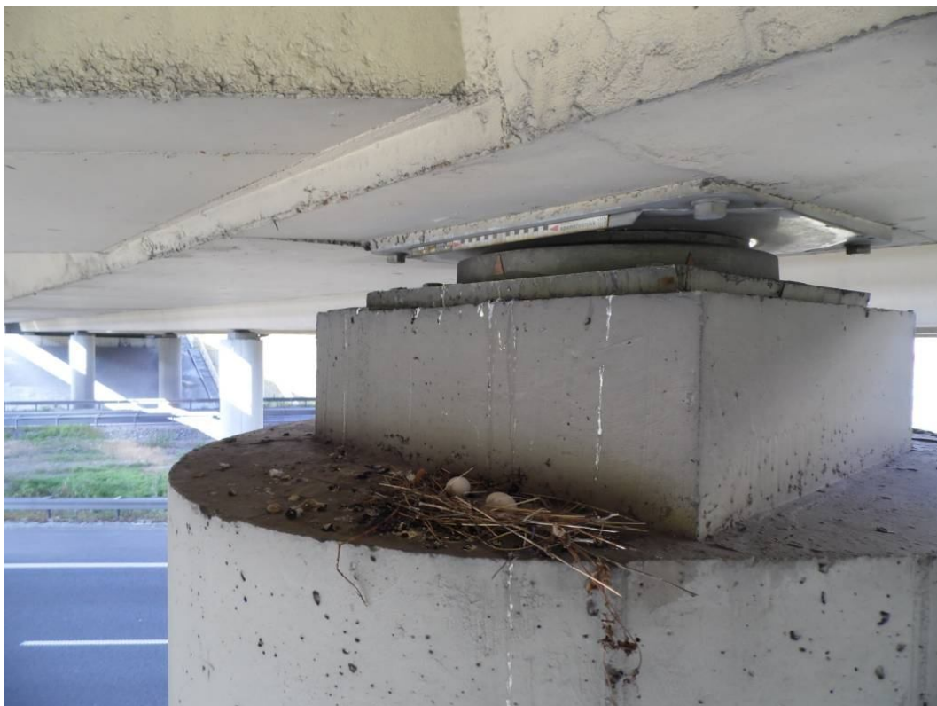
Fot. 75. Widok na słup od strony Tarnowa podpory nr 4. Zanieczyszczenia w postaci ptasich odchodów oraz gniazda.
