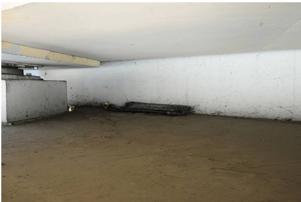
Fot. 68. Widok na ławę łożyskową przyczółka od strony Wieliczki. Zanieczyszczenia w postaci m. in. puszek.
