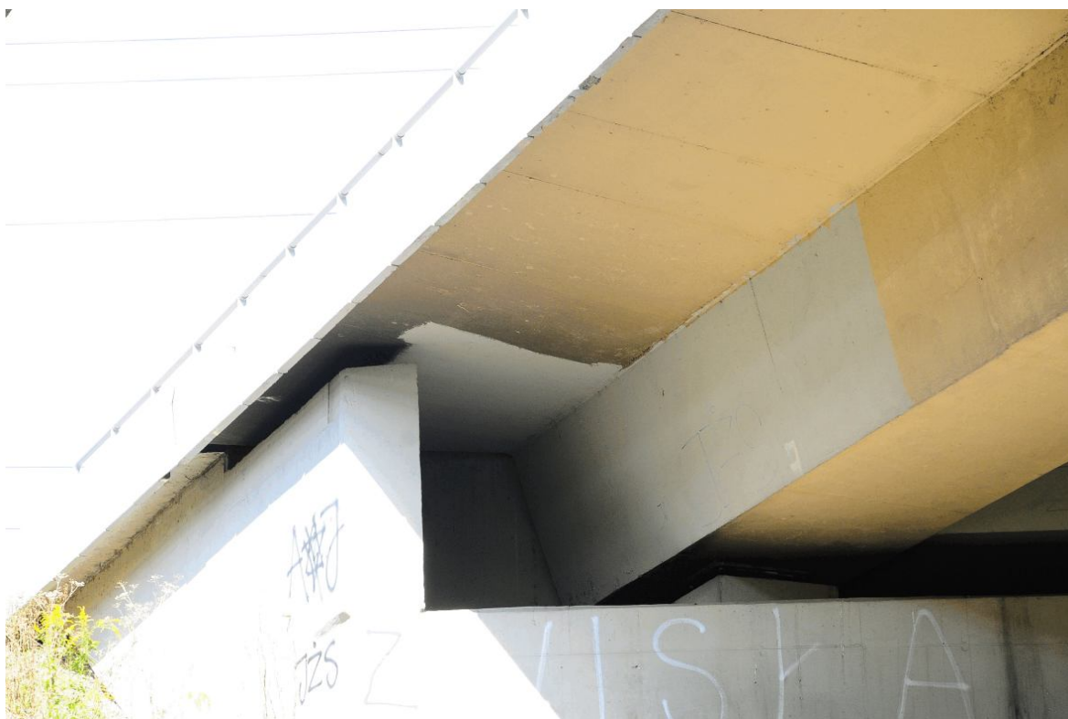
Fot. 54. Widok od strony Katowic na oparcie dźwigara nr 3 na przyczółku od strony Krakowa. Ślady napraw powierzchniowych dźwigara i wspornika podchodnikowego, źle dobrany kolor powłoki malarskiej nałożonej po wykonanej naprawie. Naprawa wykonana niedbale, bez wcześniejszego oczyszczenia powierzchni betonu.
