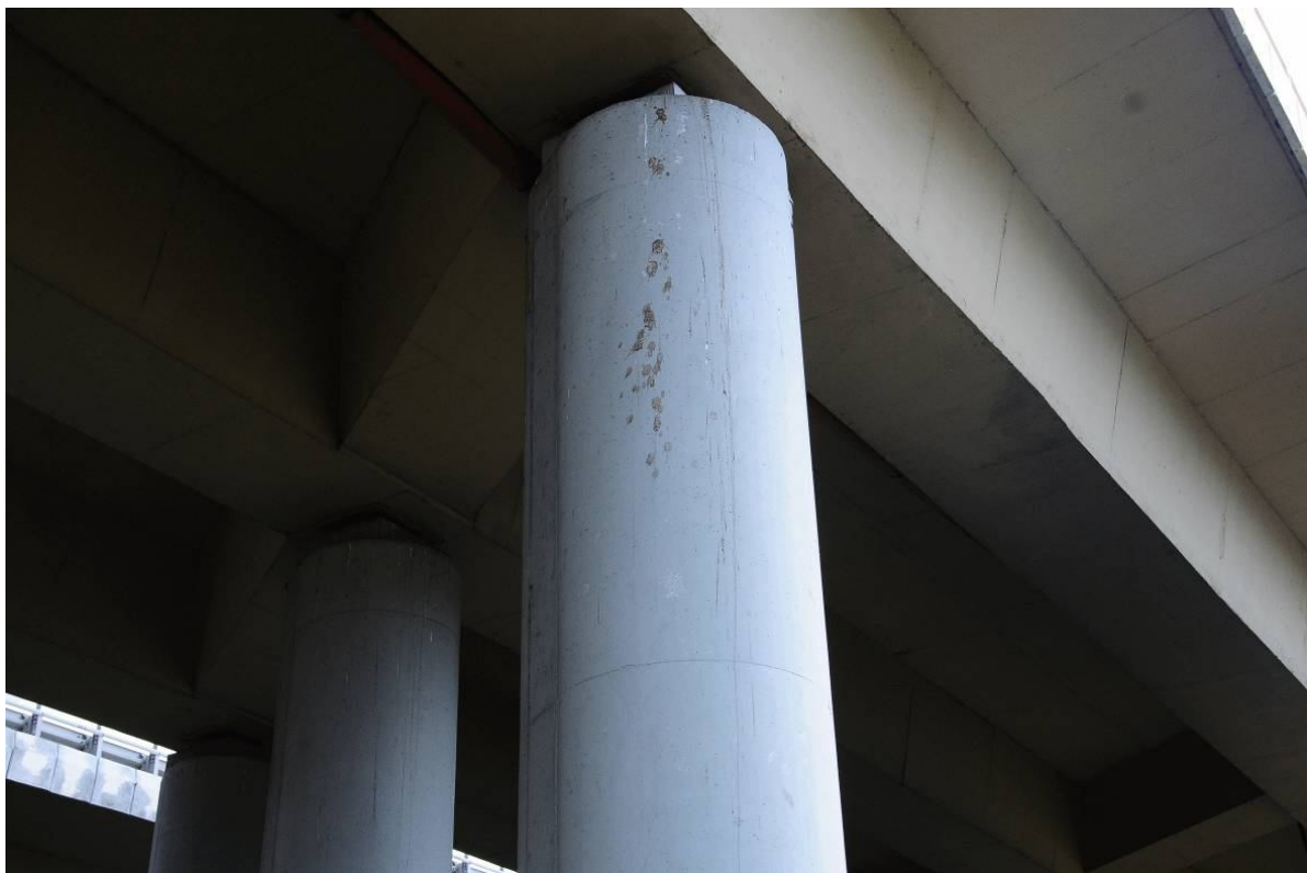
Fot. 71. Widok od strony Katowic na podpore nr 2. Zanieczyszczenia słupa powstałe prawdopodobnie podczas remontu kap chodnikowych.
