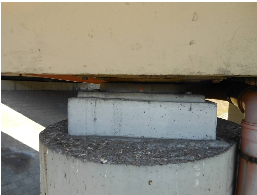
Fot. 72. Widok od strony Katowic na głowicę słupa podpory nr 2. Zanieczyszczenia w postaci pyłowych odchodów. Nierówna górna powierzchnia betonu.
