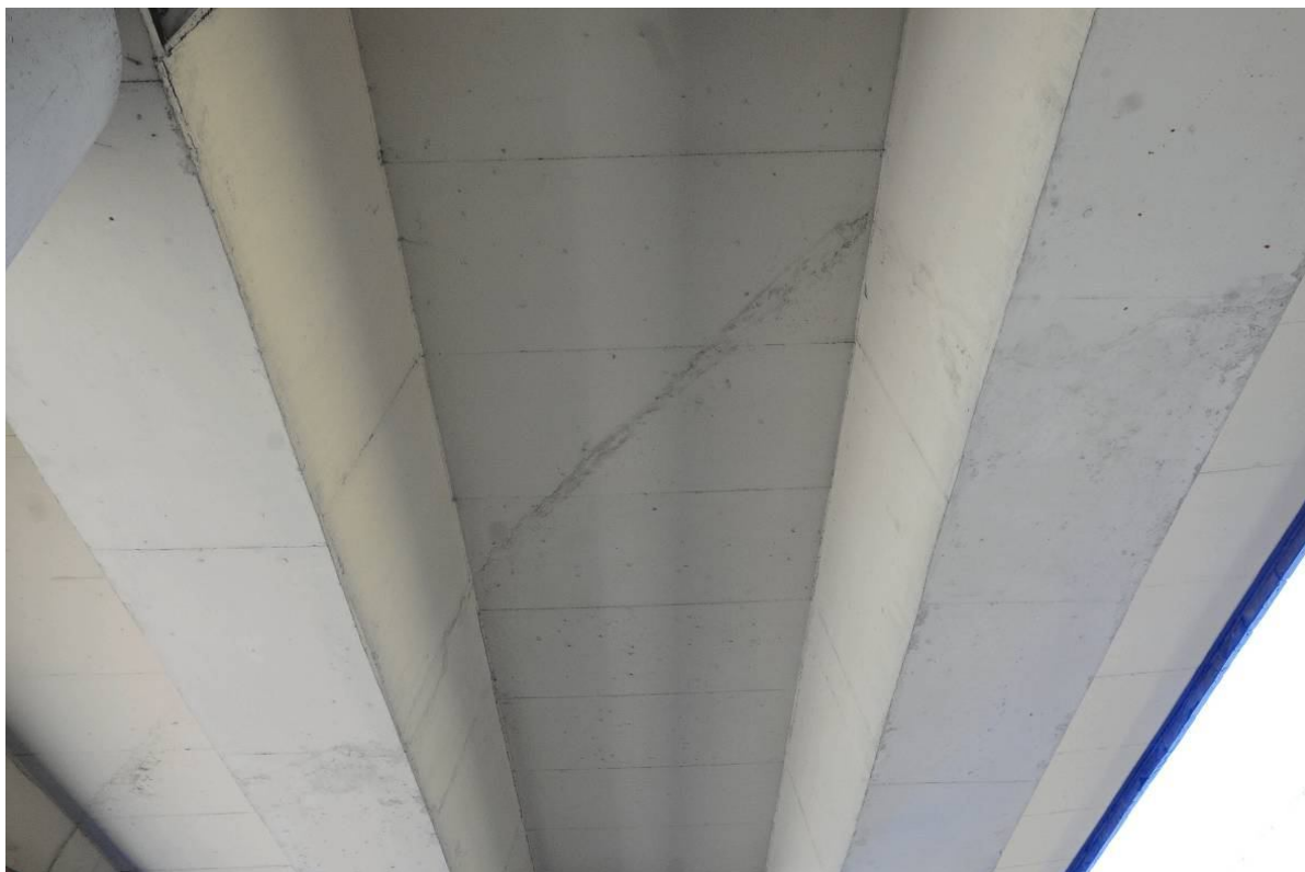
Fot. 55. Widok na płytę pomostu pomiędzy dźwigarem nr 2 i 1 w przęśle nr 4 przy podporze nr 5. Widoczne naprawy powierzchni betonu wzdłuż przerwy w betonowaniu.
