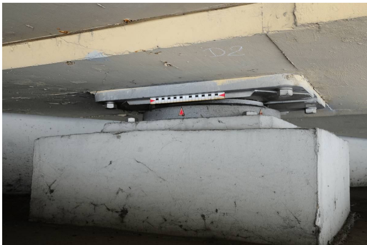
Fot. 80. Łożysko na przyczółku od strony Wieliczki. Nieprawidłowe przemieszczenie łożyska w wartość -10 mm przy temperaturze +23°C spowodowane przypuszczalnie nieprawidłowym ustawieniem wyprzedzenia łożyska w trakcie montażu.
