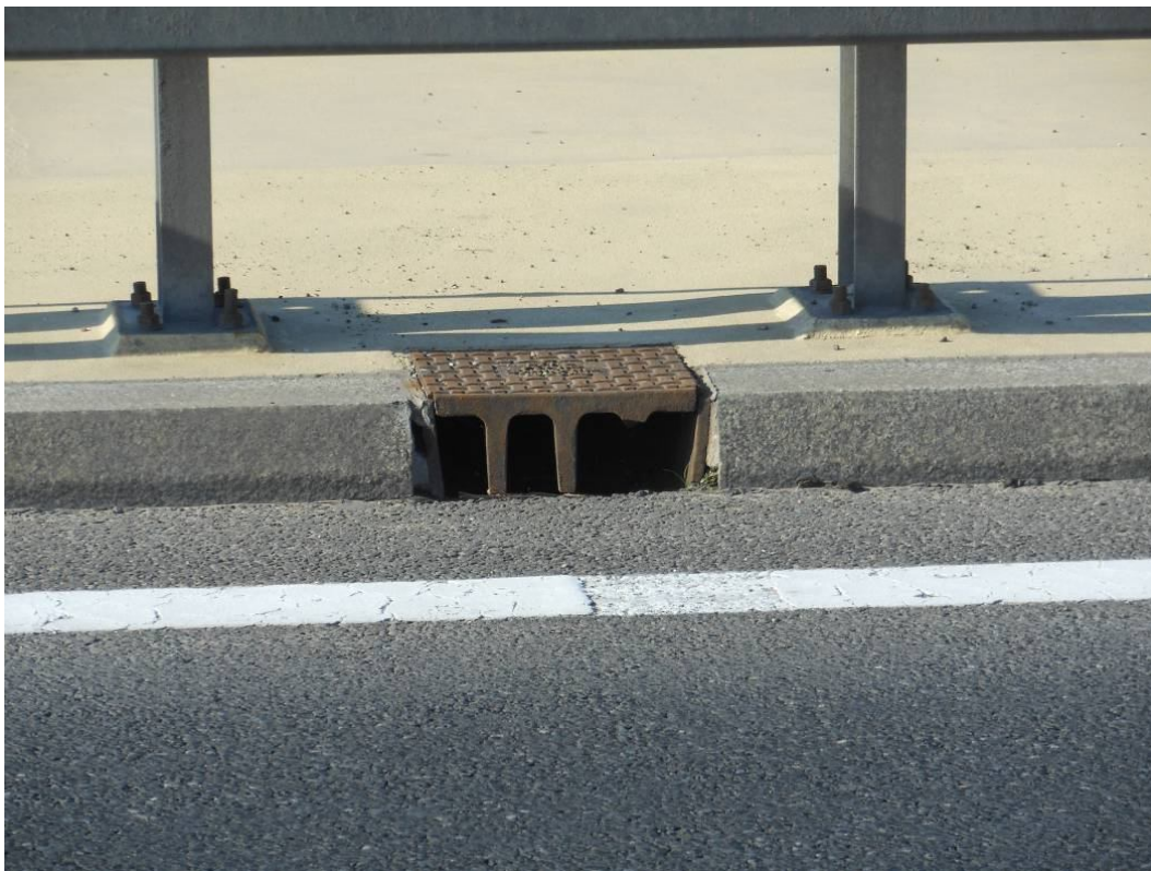
Fot. 34. Widok na wpust krawężnikowy od strony Katowic w prześle nr 2. Wyłamana część pokrywy wpustu, ślady powierzchniowej korozji.
