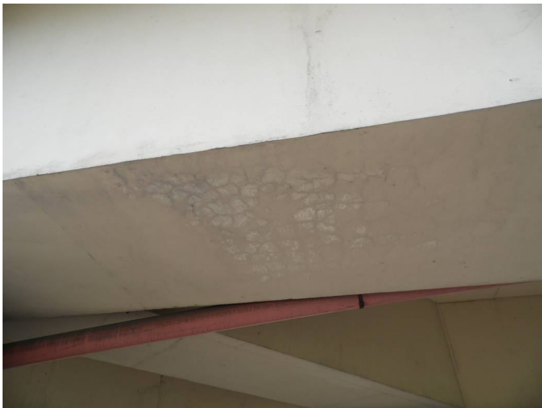
Fot. 49. Widok na spód dźwigara nr 3 (od strony Katowic) w przęśle nr 4. Siatka zarysowań skurczowych.
