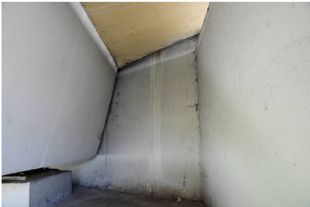
Fot. 62. Wapienne zacieki na powierzchni ścianki zapleczej przyczółka powstałe w wyniku nieszczelności styku ścianki zapleczej i urządzenia dylatacyjnego.
