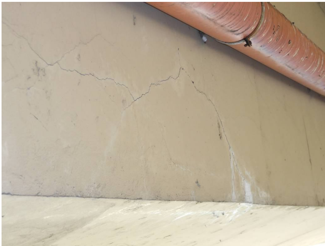
Fot. 44. Widok od strony Tarnowa na dźwigar nr 3 w przęśle nr 1. Zarysowania przeciążeniowe o rozwartości ponad 0,2 mm (brak dostępu uniemożliwił pomiar), wapienne zacieki w zarysowaniach.
