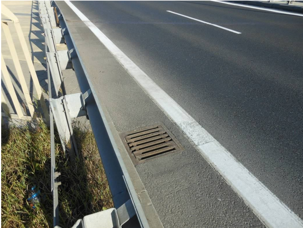
Fot. 33. Widok od strony Wieliczki na wpust drogowy od strony Katowic. Brak uszkodzeń.
