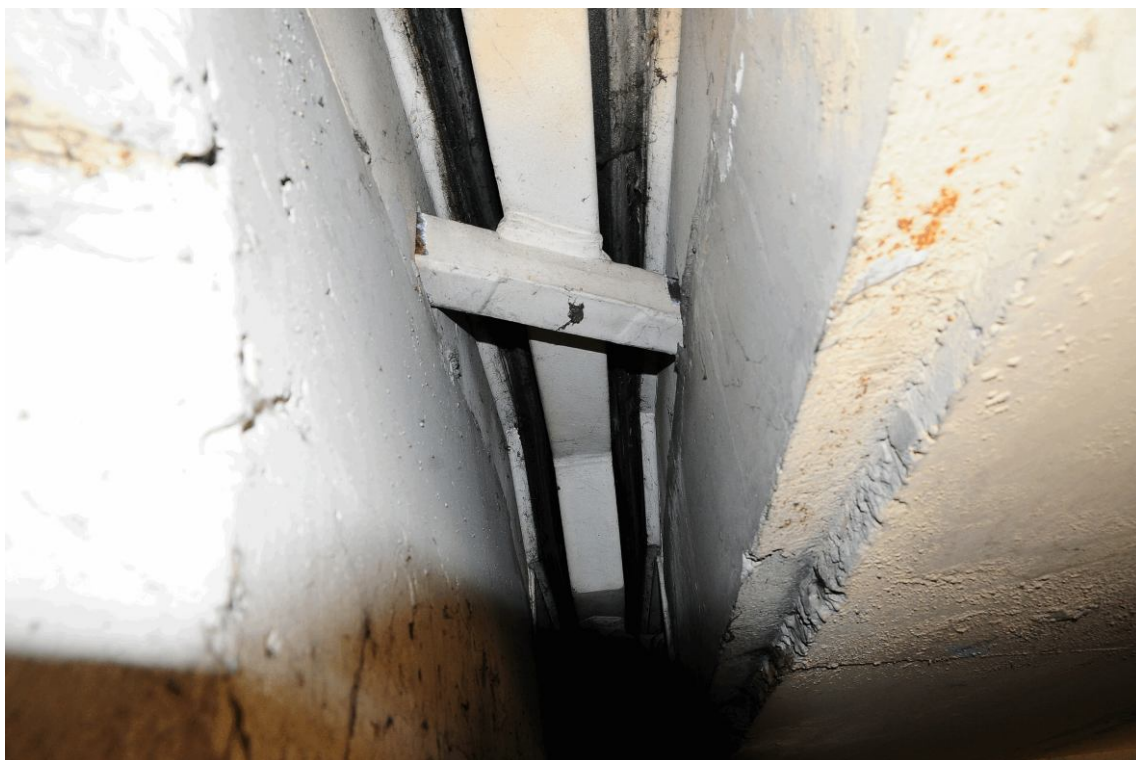
Fot. 92. Widok na dolną część urządzenia dylatacyjnego nad przyczółkiem od strony Wieliczki. Brak uszkodzeń urządzenia dylatacyjnego, rdzawe plamy na powierzchni betonu dźwigara powstałe w wyniku korozji stalowych zanieczyszczeń betonu.
