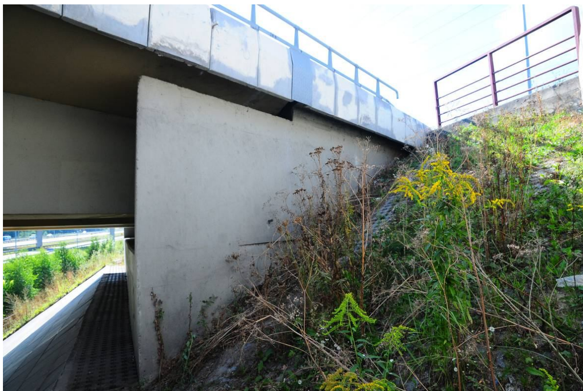
Fot. 63. Widok od strony Tarnowa na skrzydełko przyczółka od strony Krakowa. Zabrudzenie w poziomym zarysowaniu skrzydełka w miejscu przerwy w betonowaniu.
