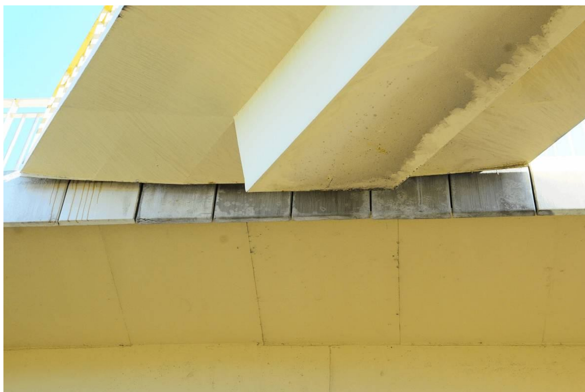
Fot. 18. Widok od strony Katowic na gzyms w przęśle 5 na styku z kładką dla pieszych. Ubytki zabezpieczenia antykorozyjnego oraz zacieki żywicy powstałe podczas remontu nawierzchni chodników. Pęknięcie trzeciej deski o lewej strony.
