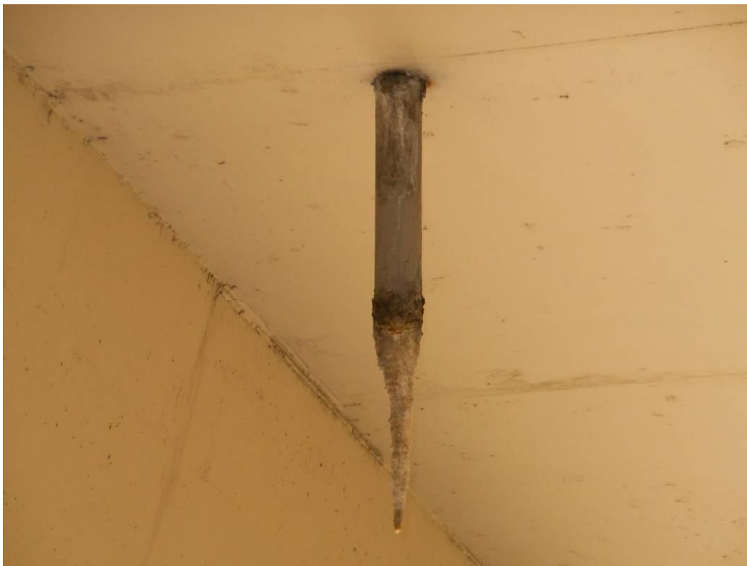
Fot. 32. Widok na rurkę wypływową sącza od strony Katowic w prześle nr 5 przy podporze nr 6. Stalaktyt ograniczający światło rurki, zacieki na powierzchni rurki powstałe wskutek nieszczelności izolacji wokół sącza.
