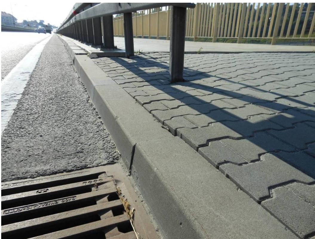
Fot. 82. Widok na chodnik i krawężnik od strony Katowic na dojeździe od strony Krakowa. Deformacja chodnika z kostki betonowej oraz krawężników powstała w wyniku osiadania nasypu.
