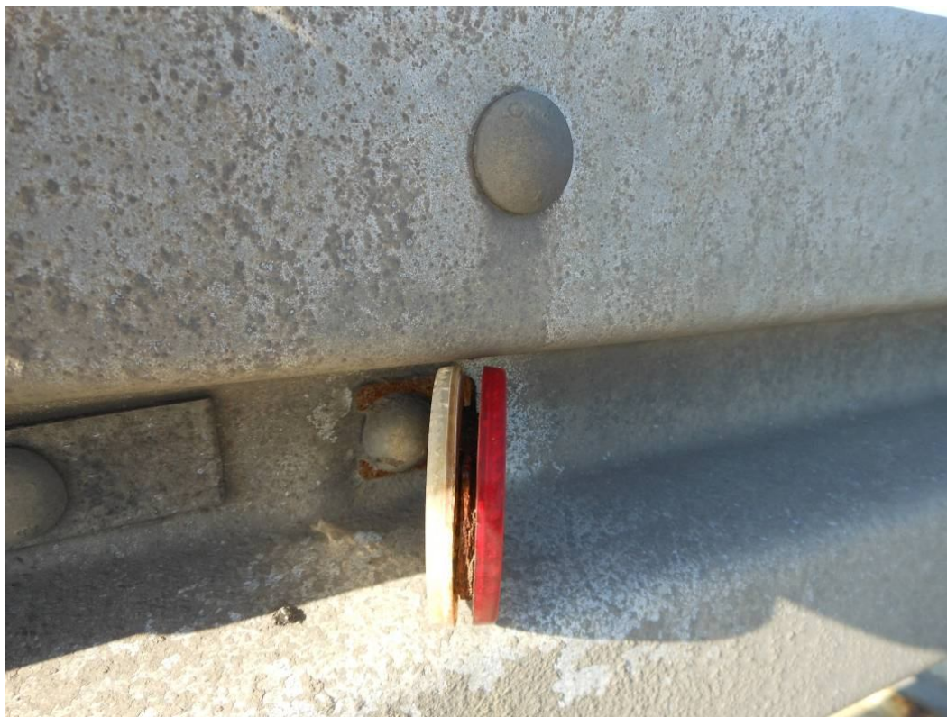
Fot. 27. Widok na prowadnicę bariery od strony Katowic nad przyczółkiem od strony Krakowa. Korozja i wygięcie łącznika światła odbłaskowego.
