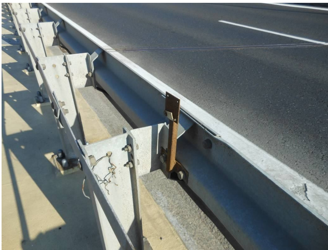
Fot. 19. Widok od strony Katowic na barierę na dojeździe od strony Wieliczki. Brak zasadniczej części słupka hektometrowego, korozja dolnej części słupka, pozostawiony drut przeciągnięty przez otwór w pasie profilowym.
