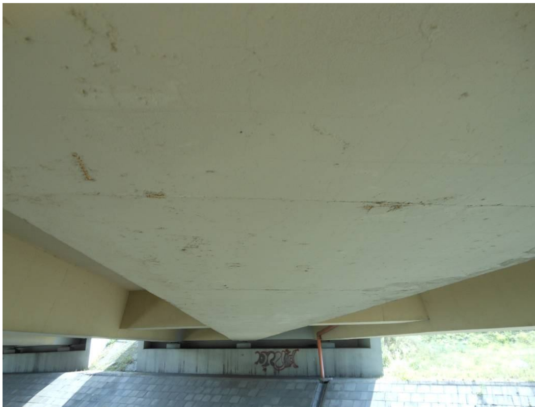
Fot. 48. Widok na spód dźwigara nr 2 w przęśle nr 6. Odsłonięte korodujące zanieczyszczenia stalowe betonu dźwigara.
