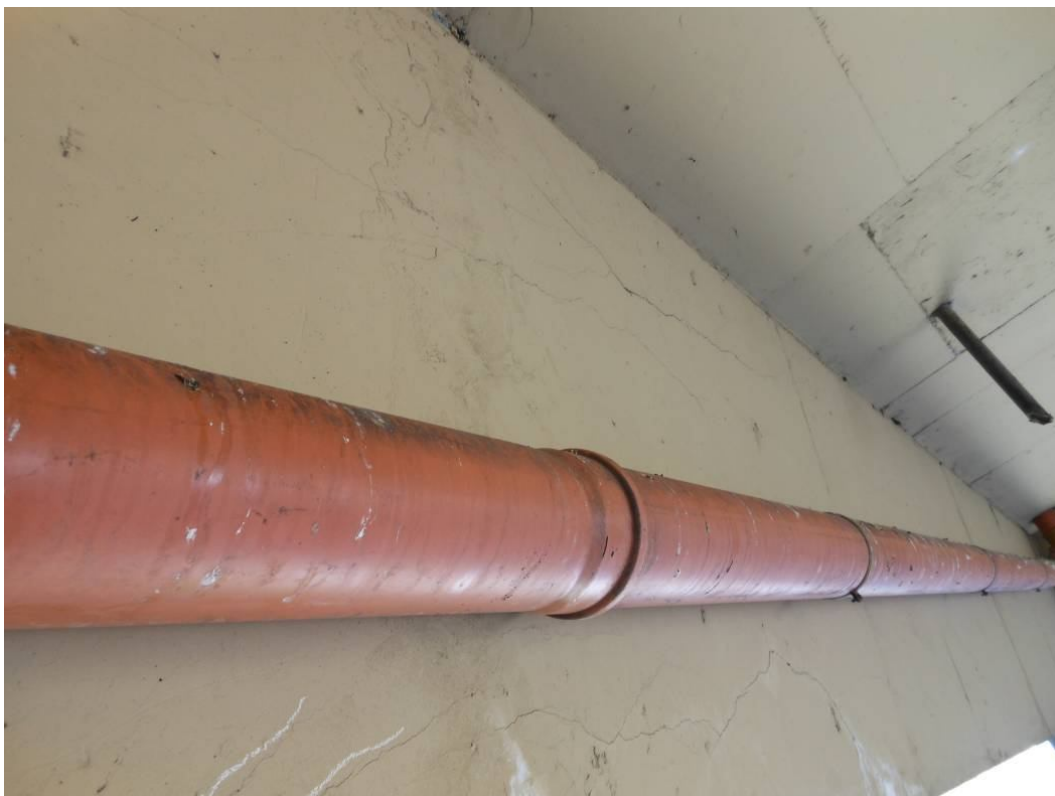
Fot. 45. Widok od strony Tarnowa na górną część dźwigara nr 3 w przęśle nr 1. Zarysowania przeciążeniowe o rozwartości ponad 0,2 mm (brak dostępu uniemożliwił pomiar).
