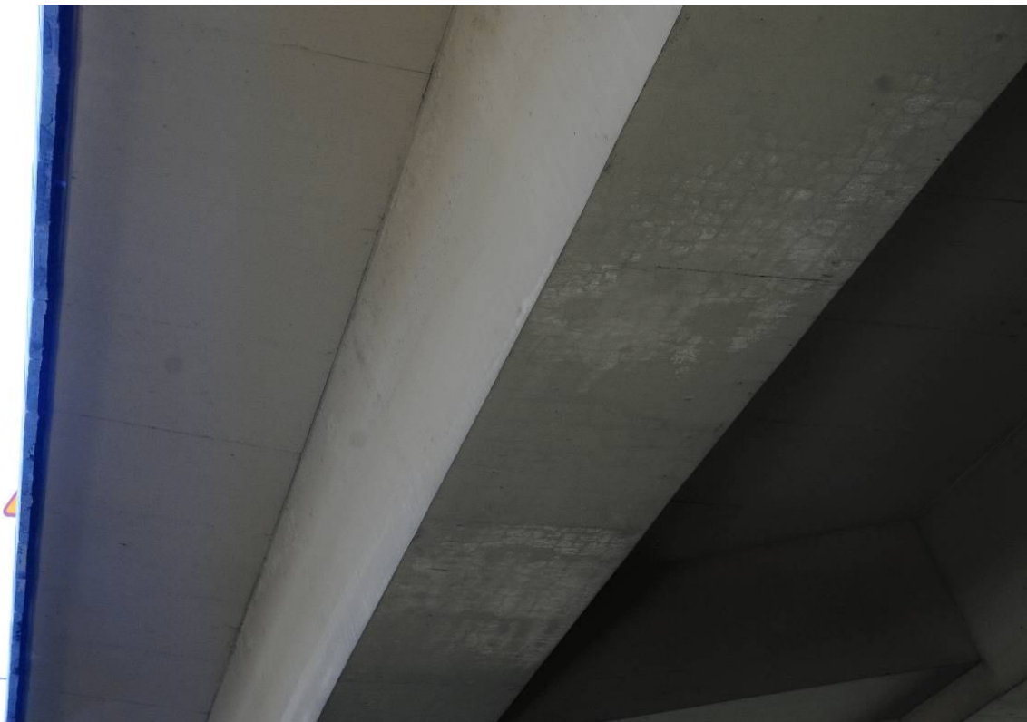
Fot. 52. Widok od strony Tarnowa na dźwigar nr 1 w przęśle nr 4. Zarysowania skurczowe dźwigara.
