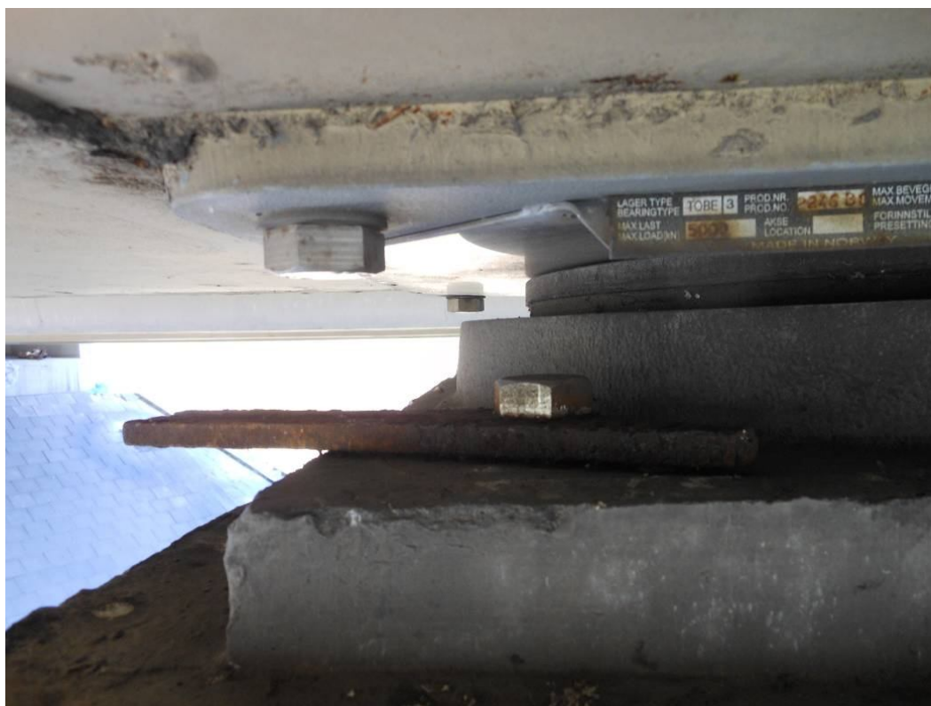
Fot. 77. Widok na łożysko dźwigara nr 1 na podporze nr 2. Pozostawiony podczas budowy korodujący płaskownik.
