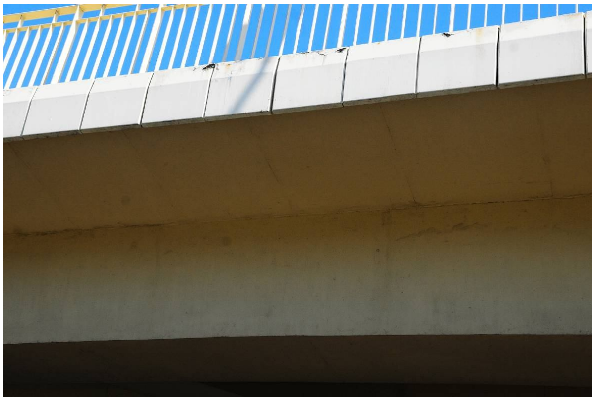
Fot. 16. Widok od strony Katowic na gzyms w przęśle nr 3. Ubytki w górnej części desek powstałe w wyniku korozji betonu.
