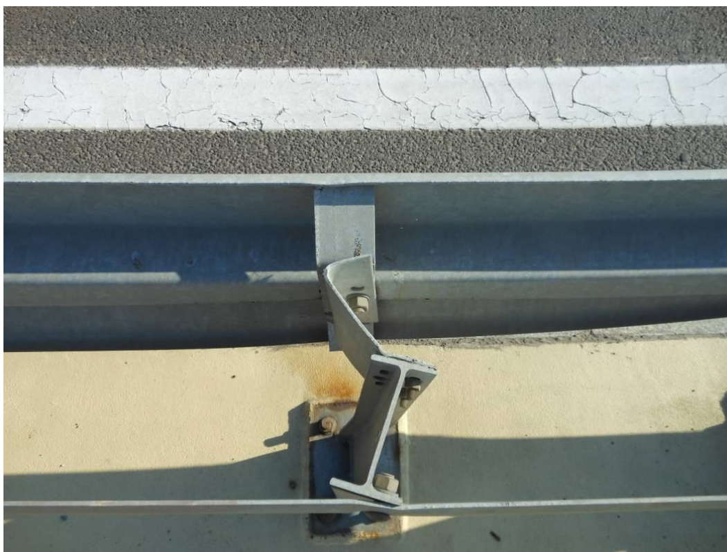
Fot. 21. Widok na barierę od strony Katowic nad podporą nr 6. Deformacja przekładki, słupka oraz prowadnicy powstałe w wyniku uderzenia pojazdu.
