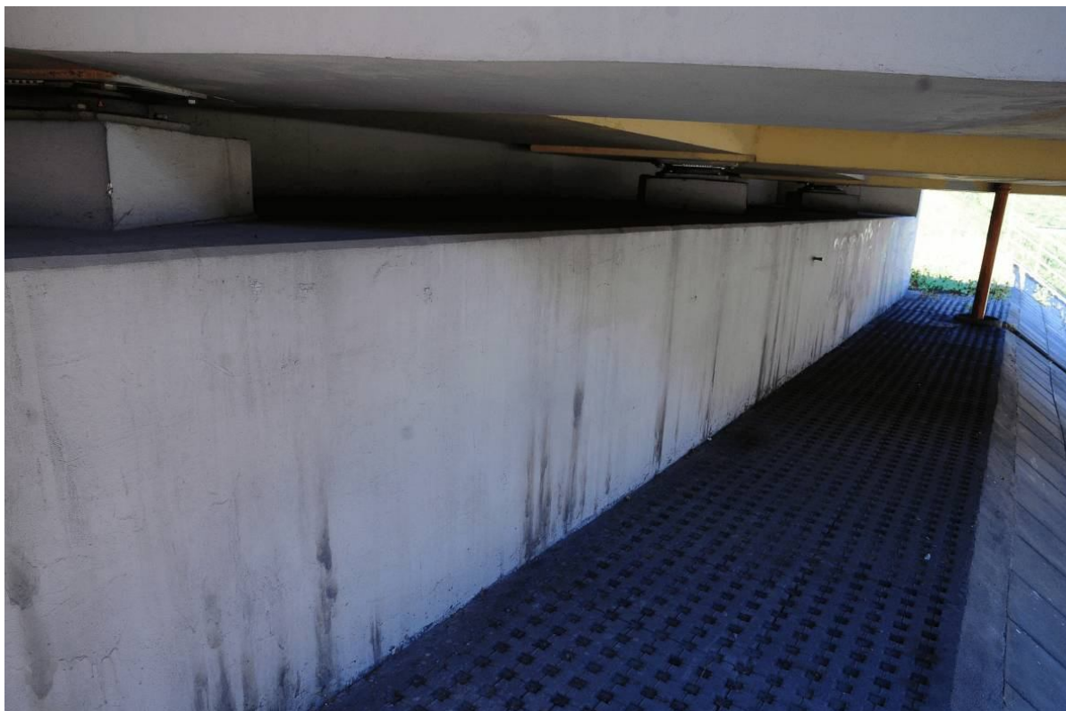
Fot. 67. Widok na korpus przyczółka od strony Wieliczki. Zanieczyszczenia korpusu przyczółka w postaci. Zacieki z pyłu na ławie podłożyskowej.
