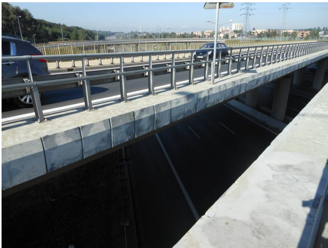
Fot. 13. Widok od strony Tarnowa na gzyms w przęśle nr 4. Ślady licznych napraw powierzchniowych wypastowanych desek gzymsowych (zdjęcia robione podczas remontu gzymsów).
