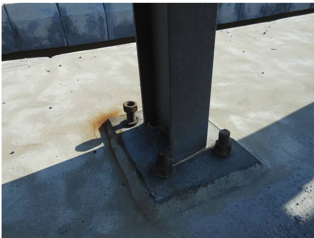
Fot. 26. Widok na zakotwienie słupka bariery od strony Tarnowa w prześle nr 2. Brak kapturków ochronnych oraz korozja nakrętek i kotew słupka bariery, niedokręcona nakrętka na etapie montażu prawdopodobnie w wyniku uszkodzenia gwintu na kotwie, rdzawe plamy na nawierzchni chodnika powstałe wskutek korozji blachy podstawy słupka.
