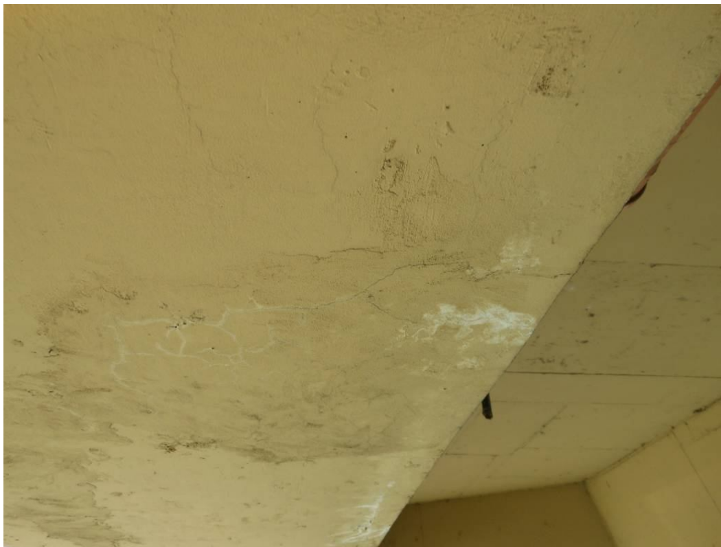
Fot. 42. Widok na spód dźwigara nr 3 (od strony Katowic) w prześle nr 1. Zarysowania skurczowe, wapienne zacieki w zarysowaniach, ślady naprawy powierzchni betonu dźwigara sprężonego.
