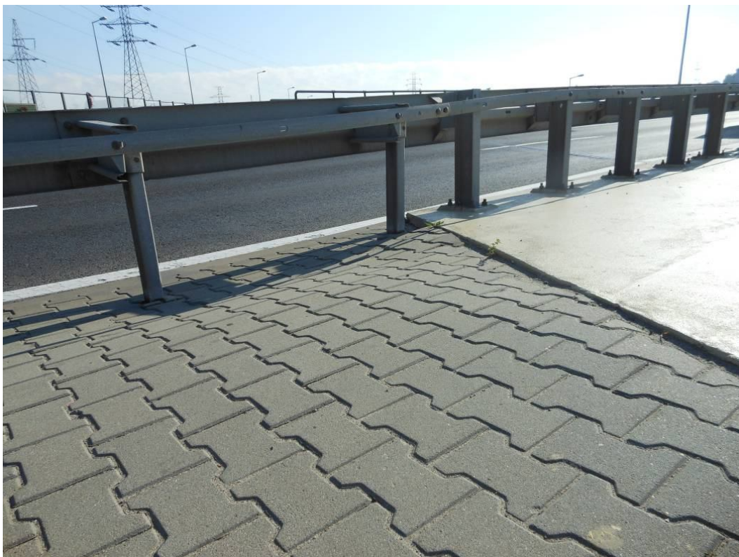
Fot. 81. Widok na chodnik od strony Katowic na dojeździe od strony Krakowa. Deformacja chodnika z kostki betonowej powstała w wyniku osiadania nasypu.
