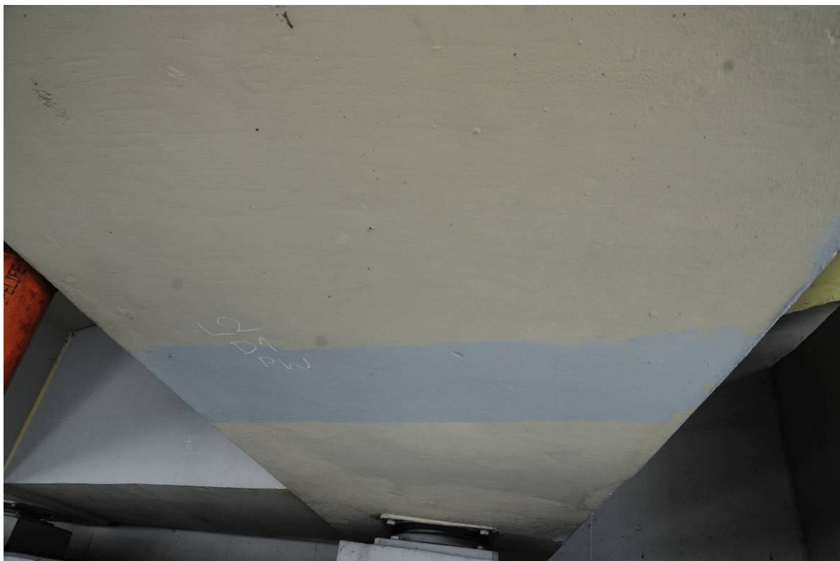
Fot. 51. Widok na spód dźwigara nr 2 przy przyczółku od strony Wieliczki. Ślady napraw powierzchniowych dźwigara, źle dobrany kolor powłoki malarskiej nałożonej po wykonanej naprawie.
