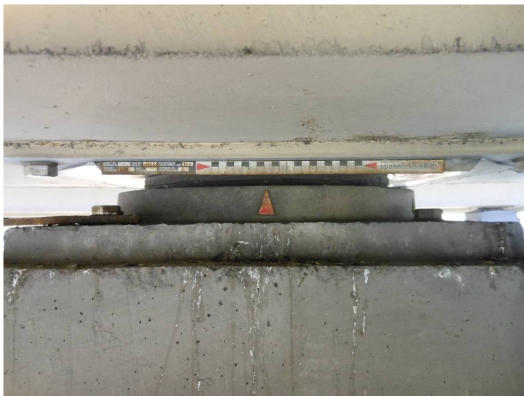
Fot. 76. Widok na łożysko dźwigara nr 1 na podporze nr 2. Zanieczyszczenia ciosu ptasimi odchodami, brak uszkodzeń na łożysku, widoczne wychylenie łożyska o wartości 25 mm.
