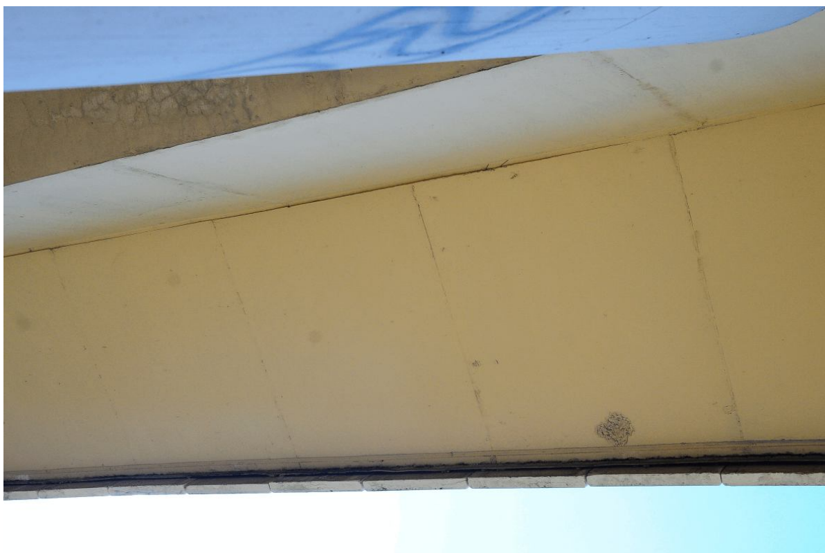
Fot. 56. Widok na wspornik podchodnikowy od strony Katowic w przęśle przy podporze nr 4. Ubytek betonu powstały prawdopodobnie podczas demontażu, wystające skorodowane gwoździe na styku dźwigara ze wspornikiem.
