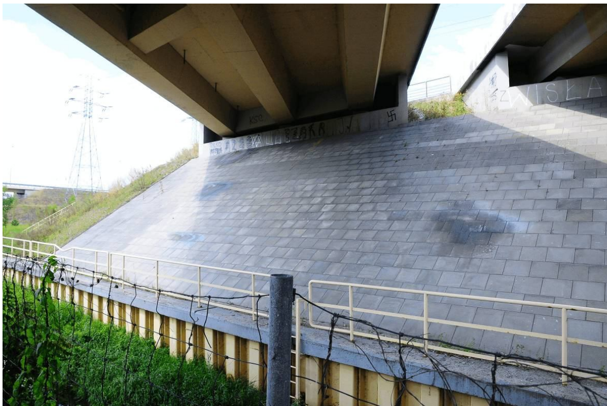
Fot. 58. Widok na przyczółek od strony Krakowa. Zanieczyszczenia korpusu w postaci graffiti, zacieki na powierzchni umocnienia skarpy przyczółka ze ściekającej wody z sączków.
