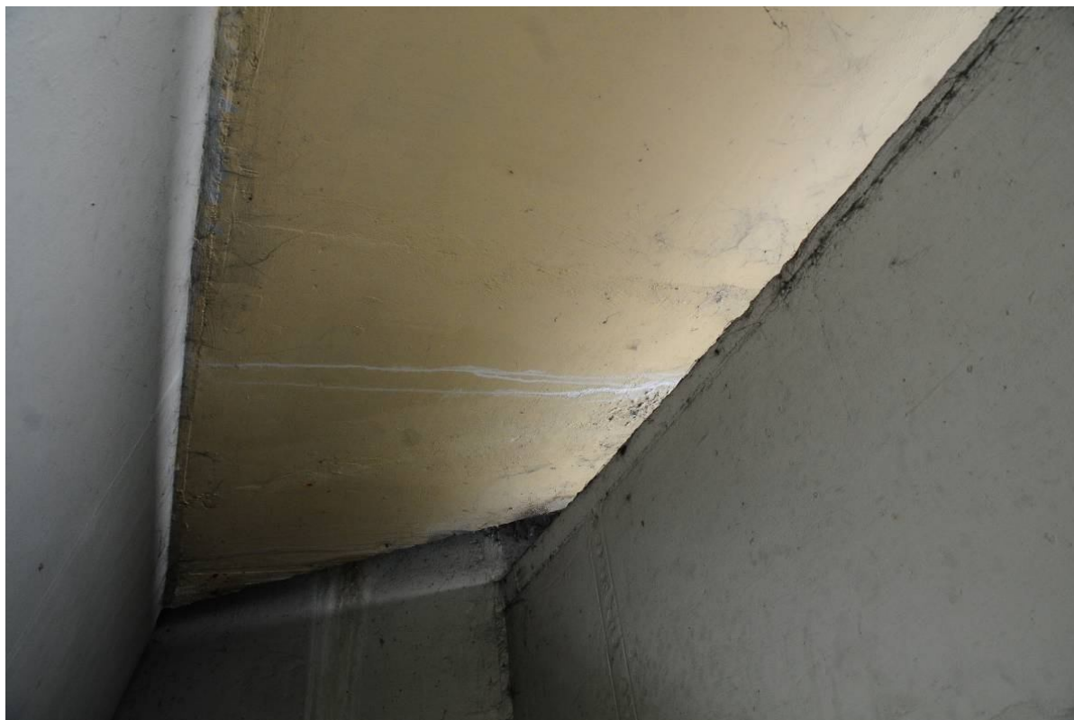
Fot. 57. Widok na wspornik podchodnikowy od strony Tarnowa nad przyczółkiem od strony Krakowa. Wapienne zacieki powstałe w wyniku nieszczelności na styku deski gzymsowej i kapy chodnikowej, rdzawe plamy na styku wspornika w dźwigarem powstałe w wyniku korozji przypowierzchniowych zanieczyszczeń stalowych w betonie.
