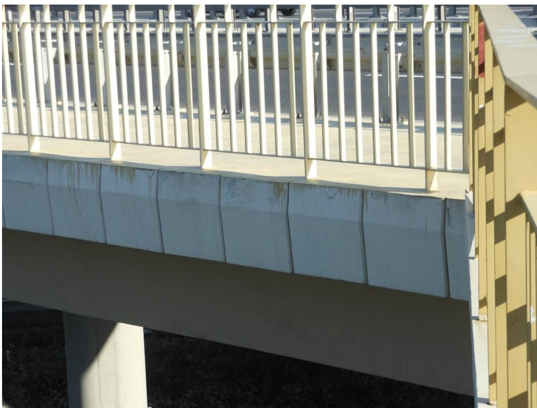
Fot. 14. Widok od strony Katowic na gzyms w przęśle nr 5. Zacieki żywicy na powierzchni desek powstałe podczas remontu nawierzchni chodników.
