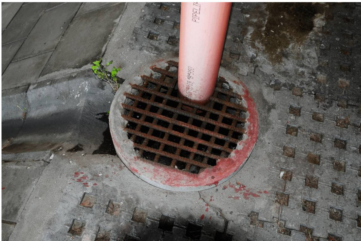
Fot. 35. Widok od strony Katowic na wylot rury spustowej przy przyczółku od strony Wieliczki. Korozja prętów kratki wpadowej wykonanej, wegetacja roślinności pomiędzy studzienką, a elementem ścieku.
