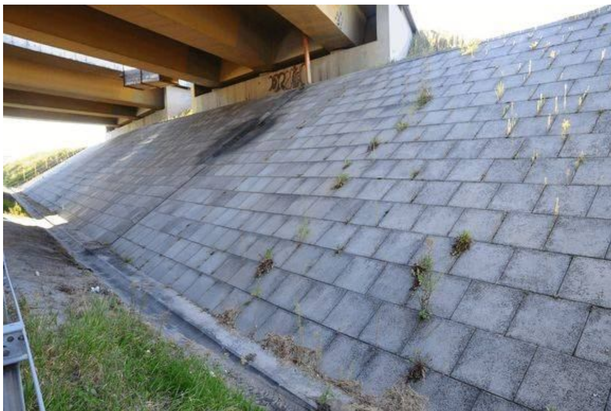
Fot. 86. Widok od strony Katowic na umocnienie skarpy przyczółka od strony Wieliczki. Zacieki na powierzchni umocnienia z wody ściekające z sączka, lokalna wegetacja roślinności pomiędzy elementami umocnienia. Zamulenie ścieku pod umocnieniem skarpy przyczółka.
