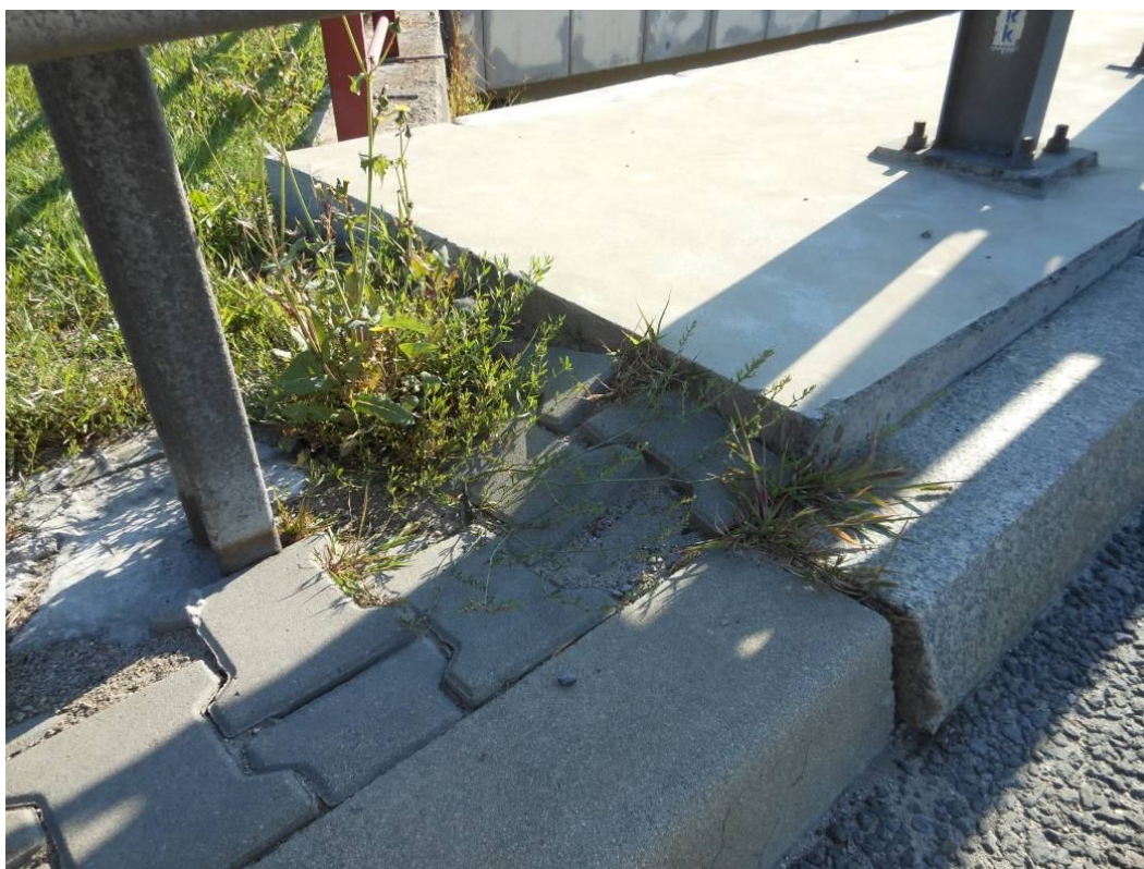
Fot. 83. Widok na pobocze od strony Tarnowa na dojeździe od strony Krakowa. Wegetacja roślinności oraz zaniżenie krawężników i kostki betonowej powstałe w wyniku osiadania nasypu.
