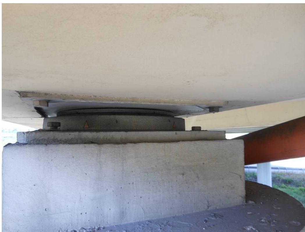
Fot. 78. Widok od strony Wieliczki na łożysko dźwigara nr 3 na podporze nr 6. Niedokręcona śruba mocująca łożysko.
