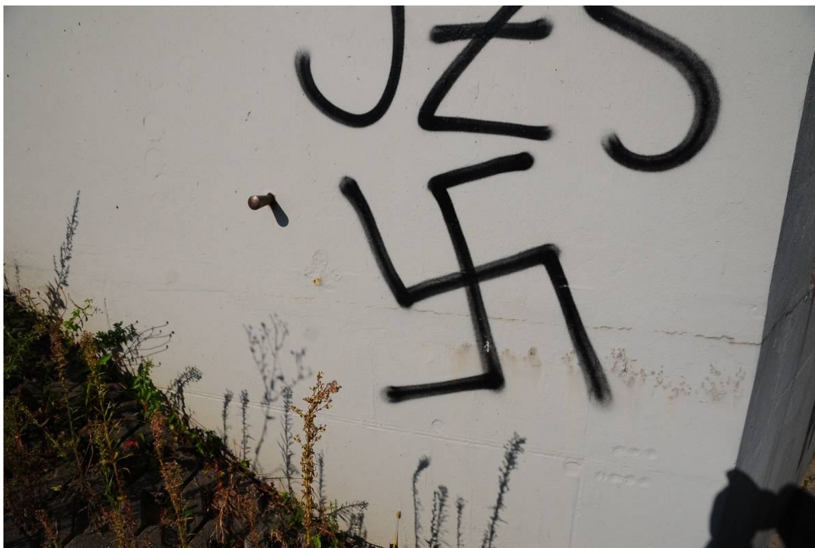
Fot. 60. Widok od strony Katowic na skrzydełko przyczółka od strony Krakowa. Zanieczyszczenia w postaci graffiti, zarysowanie poziome w miejscu przerwy w betonowaniu.
