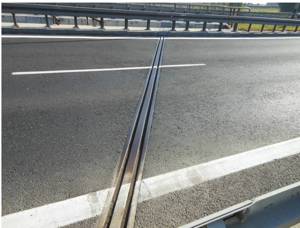
Fot. 38. Widok na urządzenie dylatacyjne na jezdni nad przyczółkiem od strony Wieliczki. Zanieczyszczenie wkładki urządzenia, odspojenia profili stalowych od nawierzchni jezdni.
