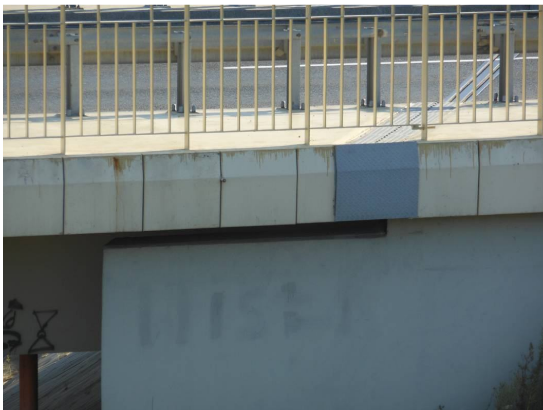
Fot. 15. Widok od strony Katowic na gzyms w przyczółka od strony Wieliczki. Zacieki żywicy na powierzchni desek powstałe podczas remontu nawierzchni chodników oraz rdzawa plama na górnej powierzchni deski powstała w wyniku korozji stalowych zanieczyszczeń w betonie.
