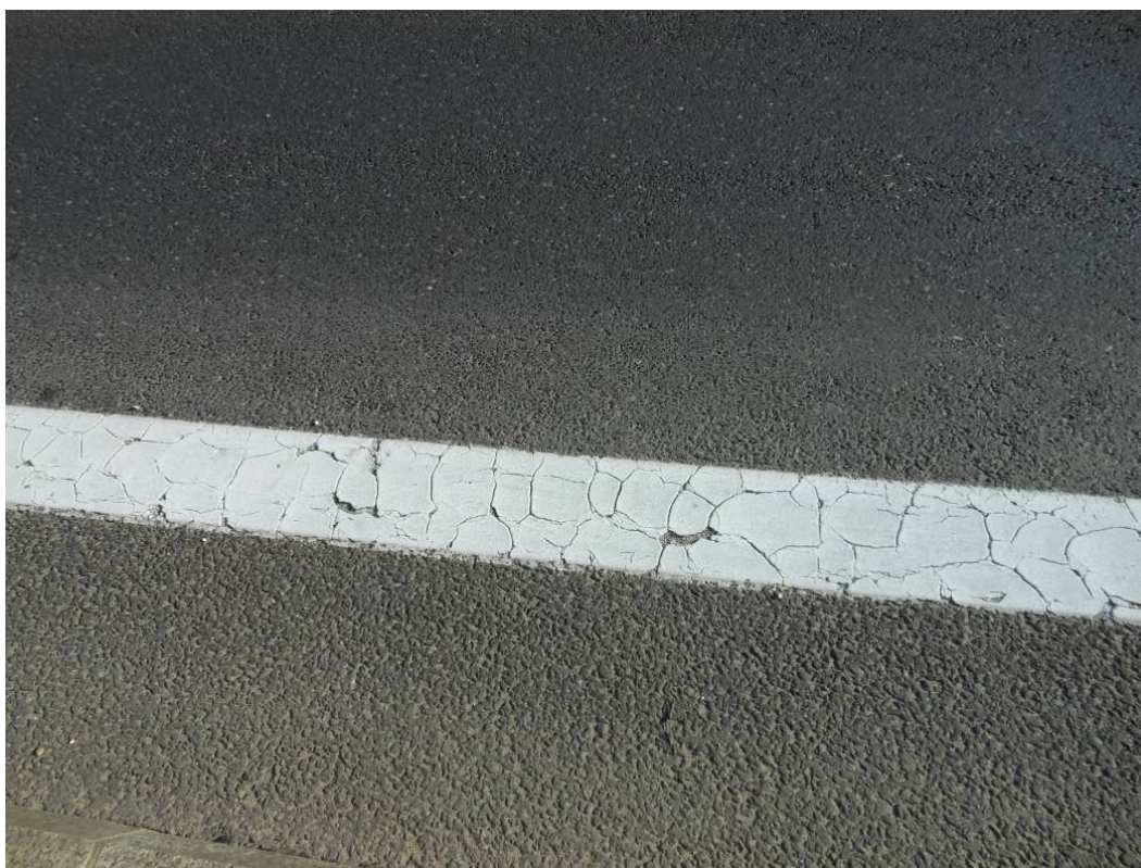
Fot. 6. Widok na oznakowanie poziome przy krawężniku od strony Katowic w przęśle nr 5. Spękania warstwy oznakowania poziomego, uszkodzenie występujące na całej długości obiektu.
