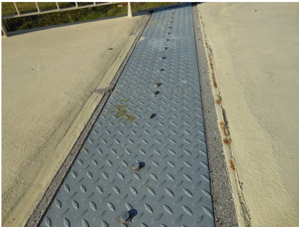
Fot. 39. Widok na urządzenie dylatacyjne na chodniku od strony Katowic nad przyczółkiem od strony Wieliczki. Rdzawe plamy na nawierzchni chodnika powstałe w wyniku korozji profili stalowych urządzenia.
