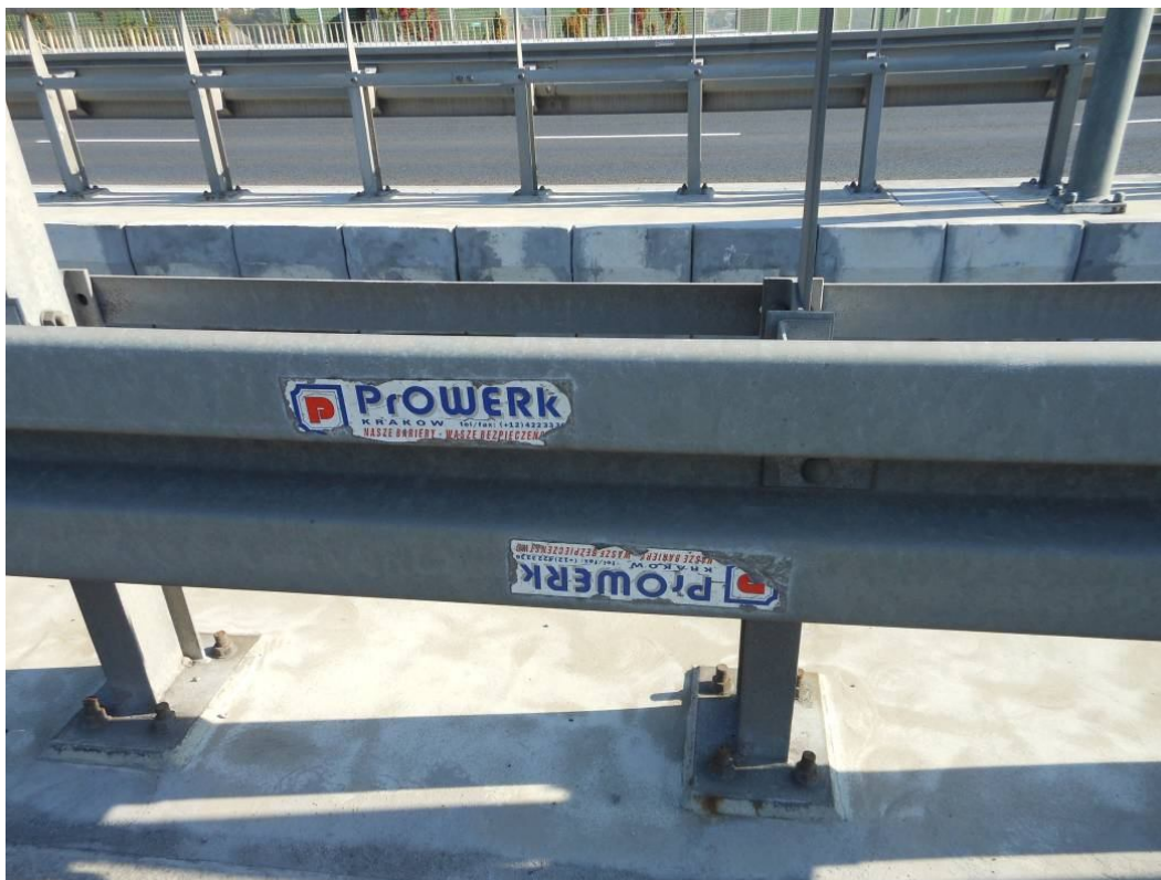
Fot. 25. Widok na barierę od strony Tarnowa w prześle nr 2. Brak kapturków ochronnych oraz korozja nakrętek i kotew słupka bariery, pozostawione nalepki producenta na prowadnicy.
