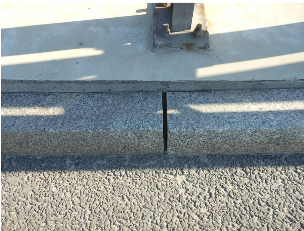
Fot. 84. Widok na krawężnik od strony Tarnowa na dojeździe od strony Krakowa. Zaniżenie krawężnika na długości skrzydełka przyczółka powstałe w wyniku osiadania nasypu, brak spoiny pomiędzy czołami krawężników.
