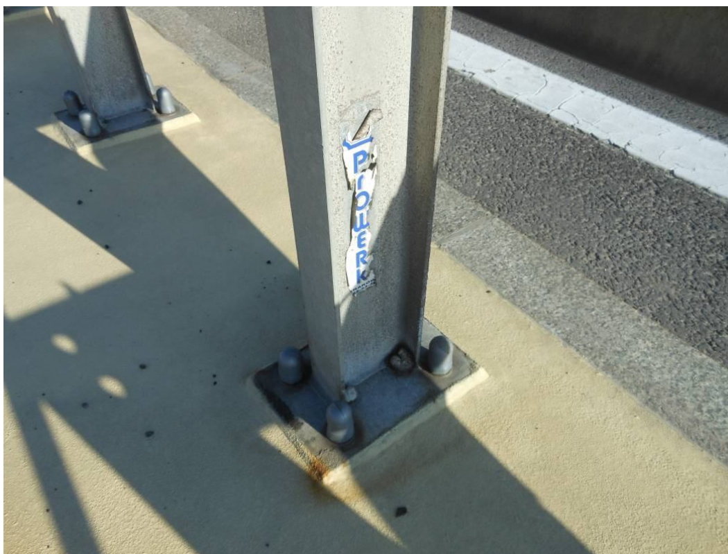
Fot. 20. Widok na słupek bariery od strony Katowic w przęśle nr 6. Ślady powierzchniowej korozji blachy kotwienia słupka, rdzawe zacieki na nawierzchni kapy oraz pozostawiona nalepka producenta na słupku.
