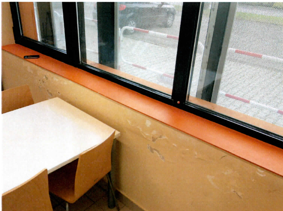
Fot.8 – Widok powierzchni do malowania w pomieszczeniu socjalnym na parterze. Konieczność montażu zewnętrznego parapetu ze spadkiem na zewnątrz budynku.
