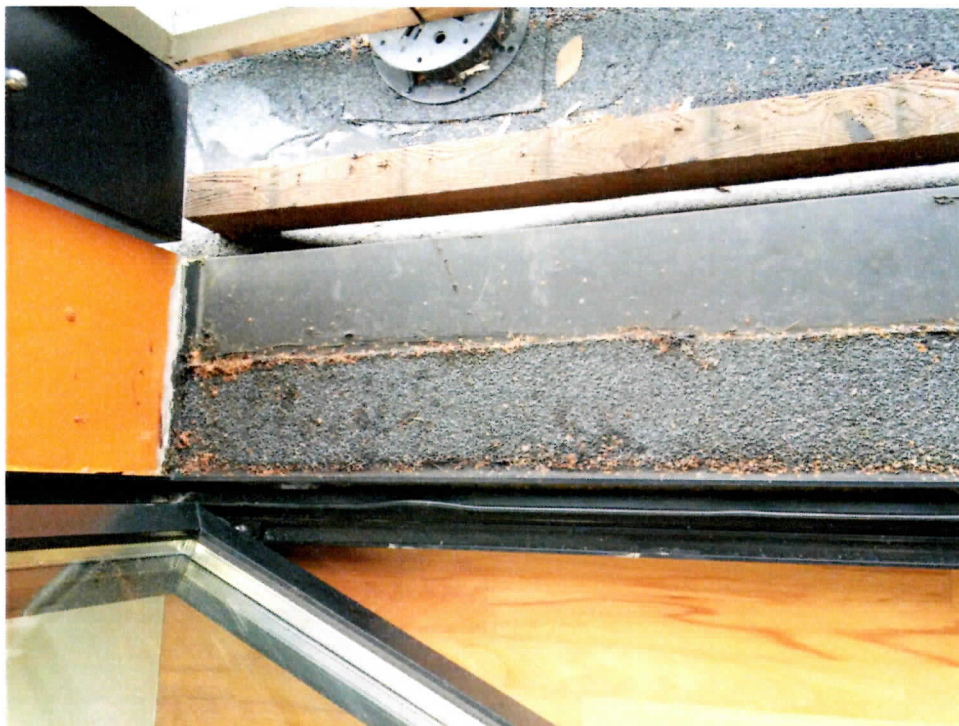
Fot.8 – Widok powierzchni do malowania w pomieszczeniu socjalnym na parterze. Konieczność montażu zewnętrznego parapetu ze spadkiem na zewnątrz budynku.
