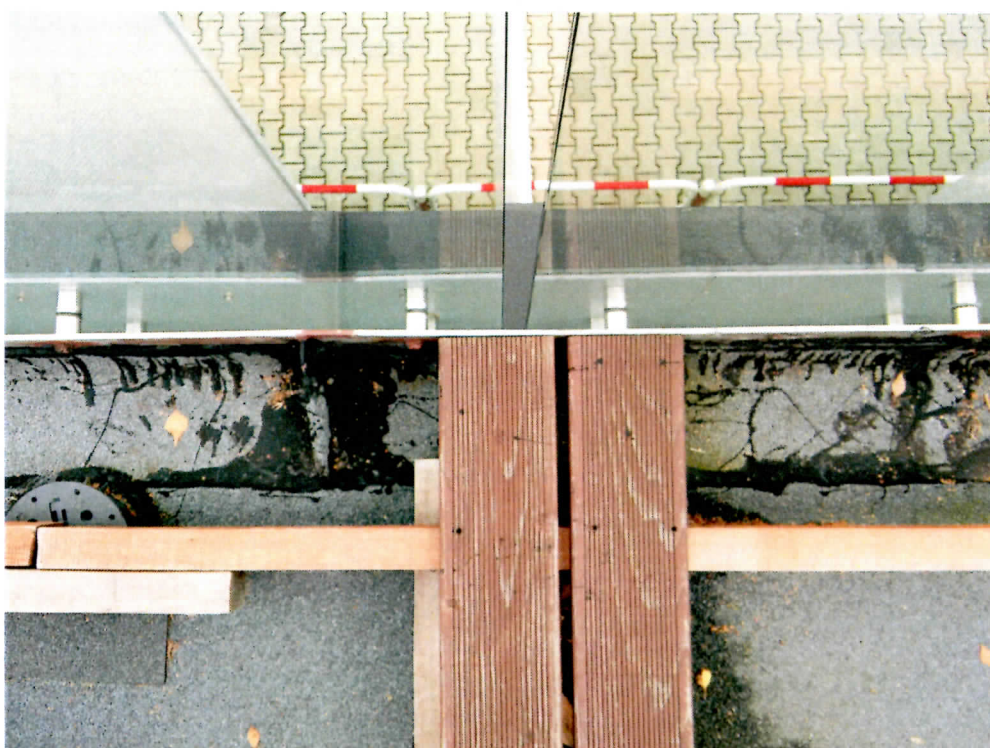
Fot.2 – Widok desek do obcięcia. Szerokość szeliny 1,0 cm – 1,5 cm.
