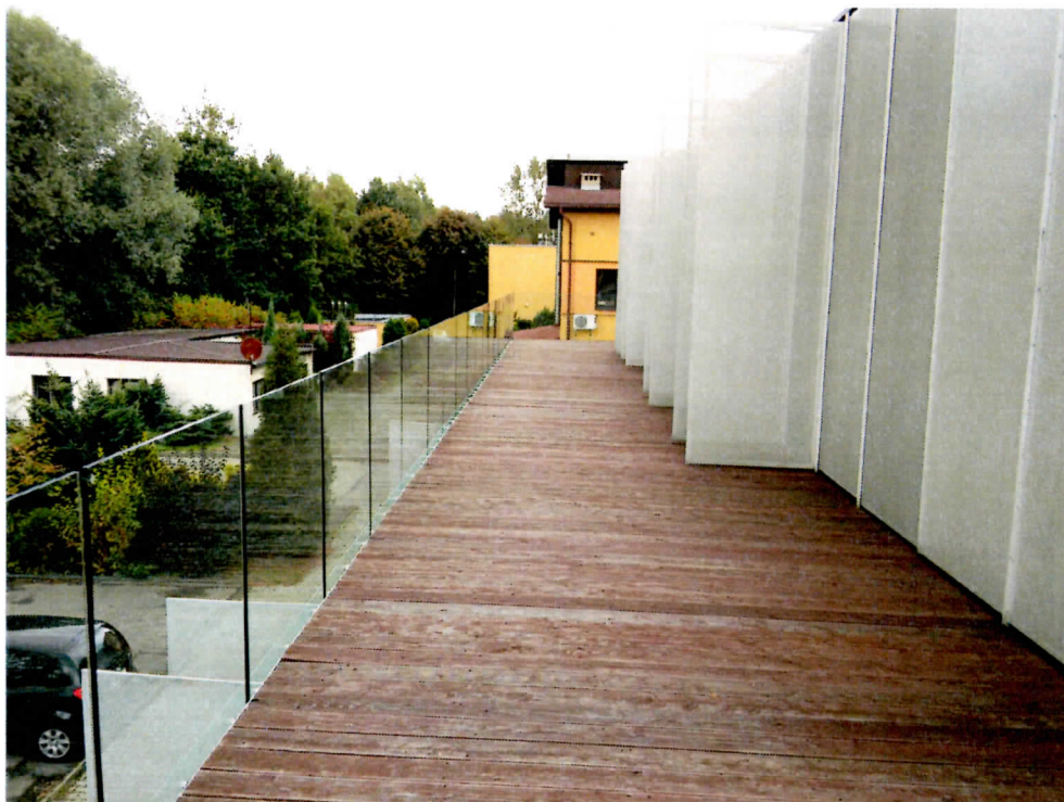
Fot.2 – Widok desek do obcięcia. Szerokość szeliny 1,0 cm – 1,5 cm.
