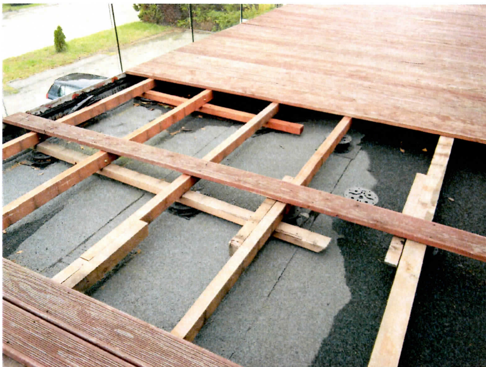
Fot.3 - Widok konstrukcji nośnej tarasu.
