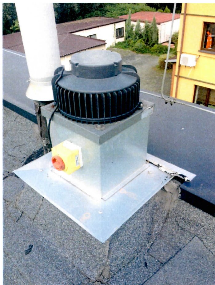
Fot.12 – Widok uszkodzonego wentylatora dachowego.
