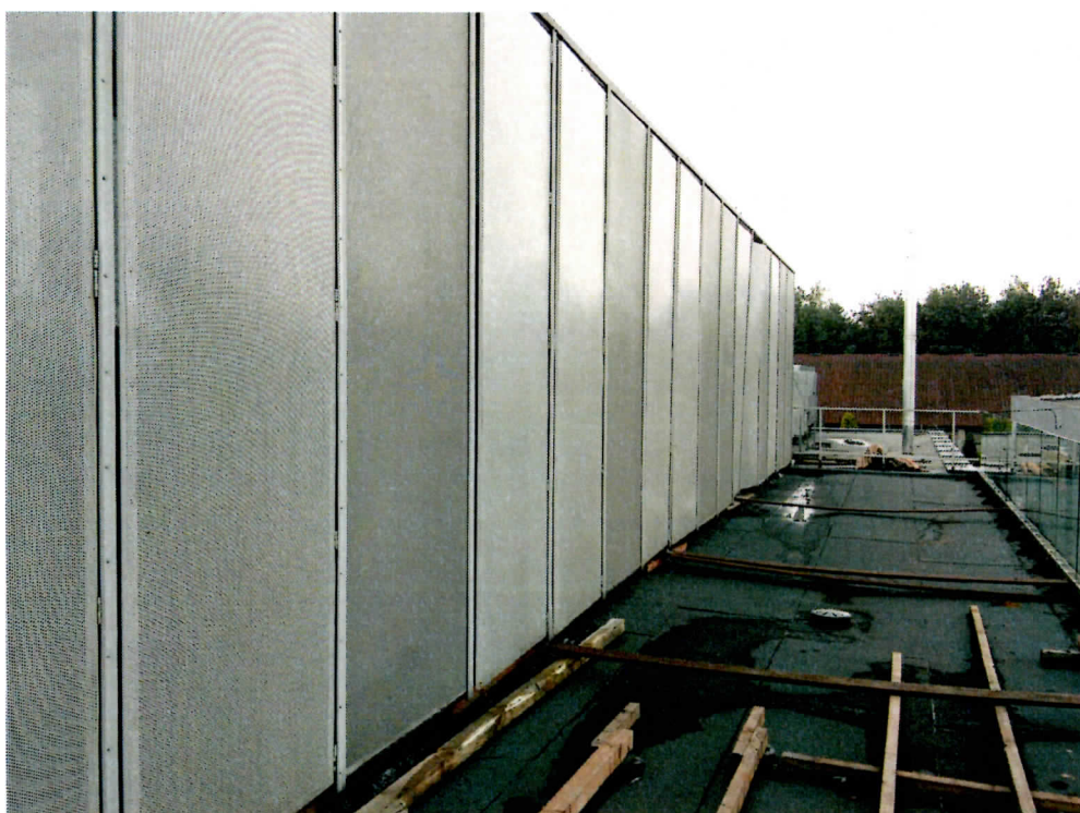
Fot.4 – Widok żaluzji zewnętrznych – do regulacji po zakończeniu robót.
