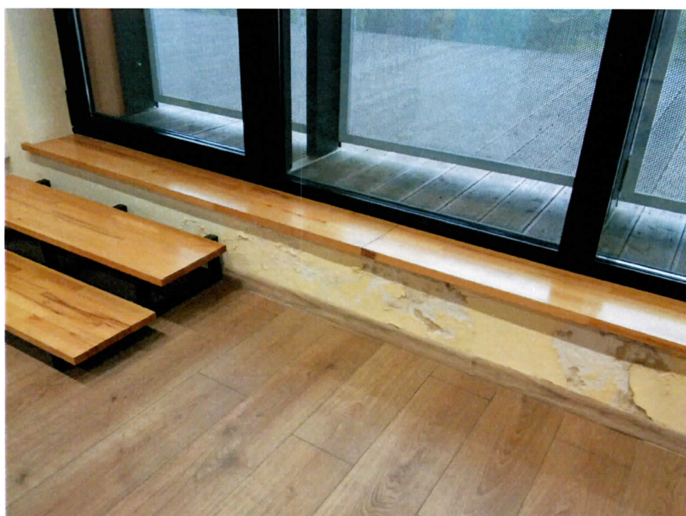
Fot.6 – Widok uszkodzonej powłoki malarskiej – do renowacji
