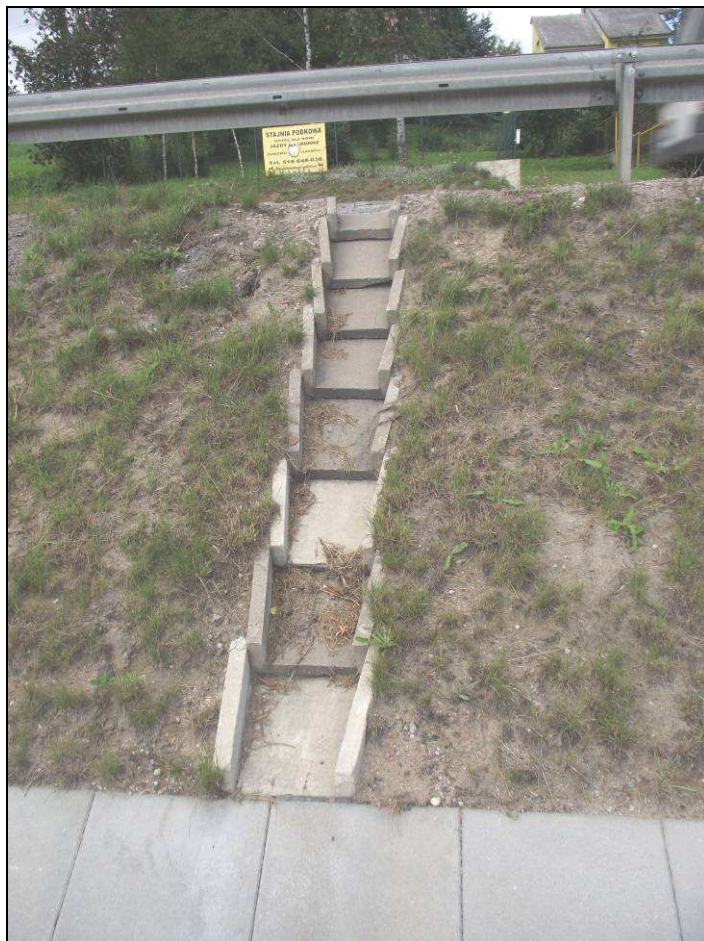
Fot. 1. Ściek skarpowy z którego wody opadowe kierowane są do wybetonowanego ścieku.
