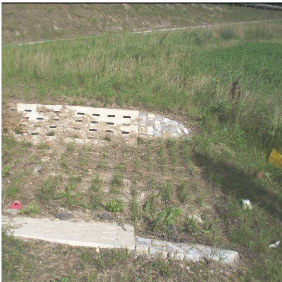
Fot. 3. Wyloty ścieku betonowego na teren działki nr 719/2 i 721/5.
