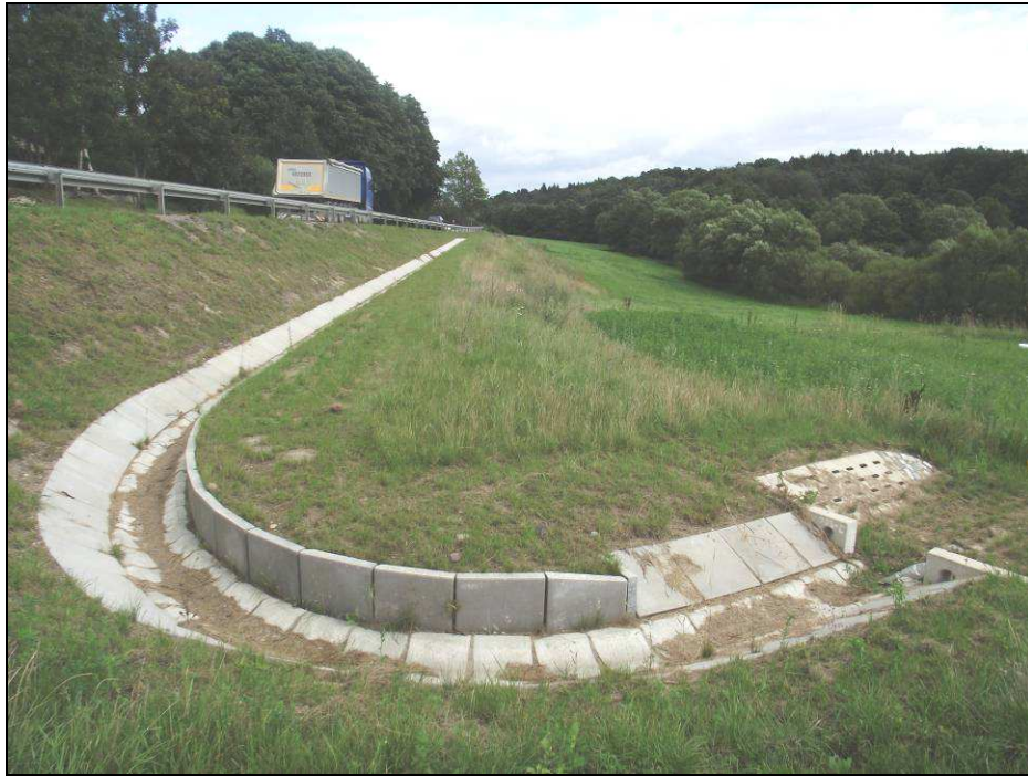
Fot. 2. Ściek betonowy odprowadzający wody opadowe na teren działki nr 719/2.
