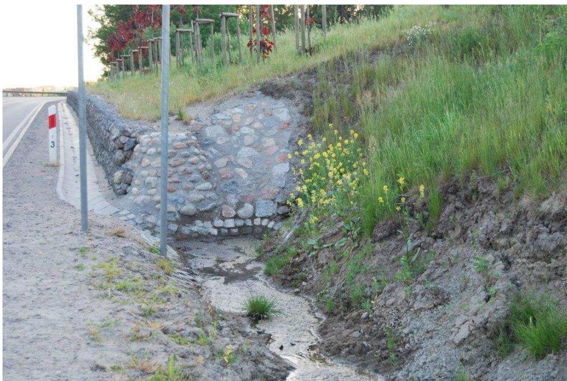
Fot. 4. Zakończenie istniejącego umocnienia z koszy gabionowych.
