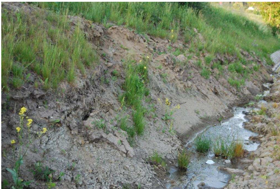
Fot. 3. Zniszczona powierzchnia przeciwskarpy.
