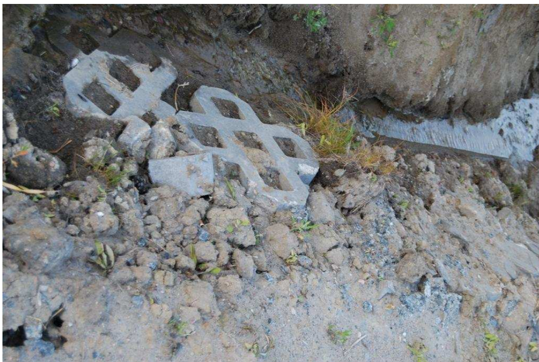
Fot. 2. Zniszczona powierzchnia skarpy od strony jezdni.
