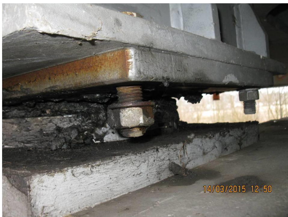
Fot. 18 Widok łożyska mostu. Stalowe elementy łożysk uległy lokalnie powierzchniowej korozji. Konstrukcja betonowa ciosu podłożyskowego zanieczyszczona zużytymi smarami i zanieczyszczeniami z pyłu i kurzu. Śruba mocująca konstrukcję łożyska do konstrukcji dźwigarów głównych nie dokręcona.
