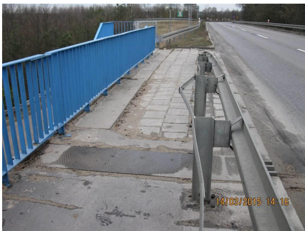
Fot. 6 Widok dylatacji w części chodnikowej od strony m. Łochów. Osłona dylatacji wykonana z ryflowanej blachy stalowej skorodowana i zanieczyszczona piaskiem. Nad dylatacją widoczne wyboczenie listew barier wywołane pracą obiektu i brakiem odpowiedniego połączenia stalowych elementów barier..
