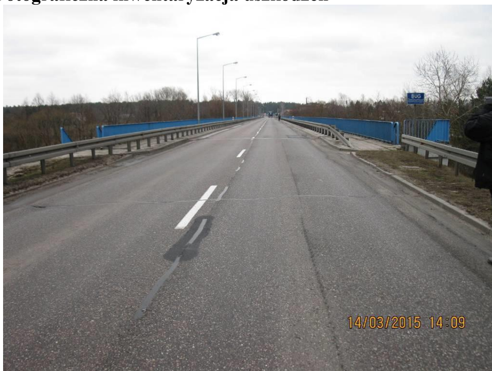
Fot. 1 Widok nawierzchni na dojeździe do obiektu od strony m. Łochów. Nawierzchnia asfaltowa popękana poprzecznie i podłużnie, koleiny w jezdni od ruchu pojazdów, w rejonie krawężników zanieczyszczenie jezdni piaskiem. Widoczne próby naprawy nawierzchni. Krawężniki betonowe na dojeździe uległy zklawiszowaniu, posiadają liczne ubytkami betonu, zanieczyszczenia piaskiem i roślinnością trawiastą. Pobocza znacznie zawyżone w stosunku do poziomemu krawężników.
