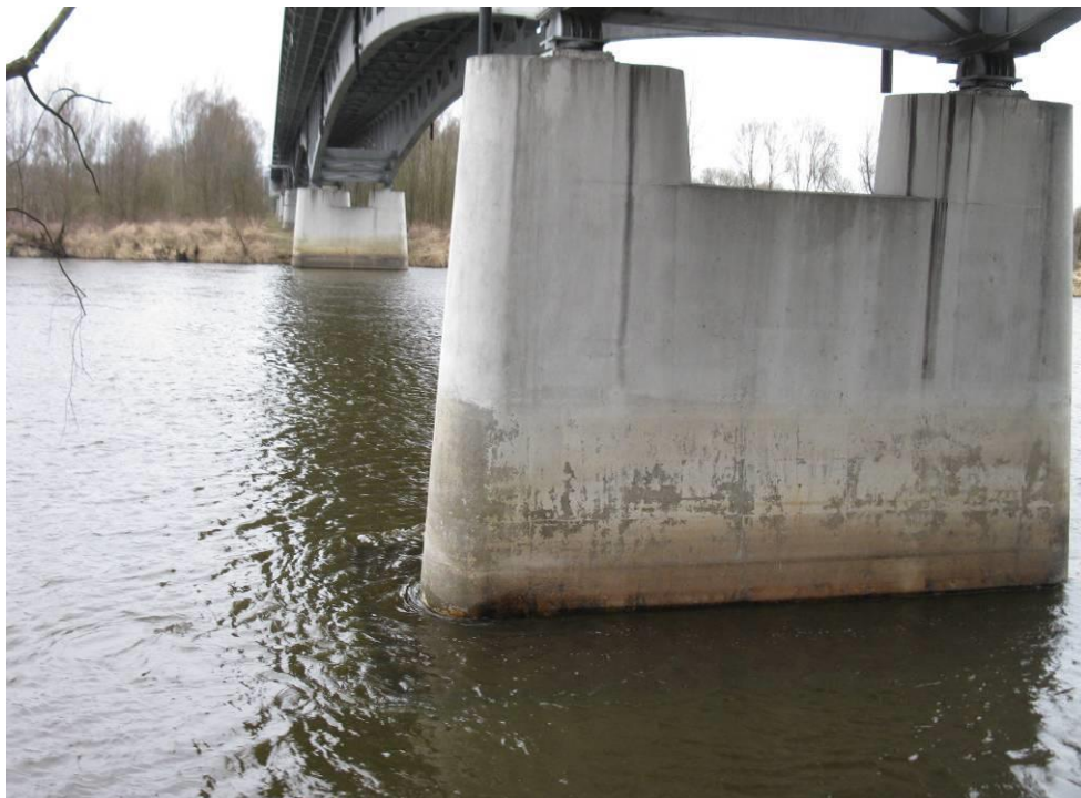
Fot. 25 Widok podpory pośredniej od strony m. Brok. W rejonie wahań lustra wody powłoki antykorozyjne podpory uległy złuszczeniu, a powierzchnia betonowa podpory pokryła się rdzawym osadem. Na powierzchni betonowej podpory występują niewielkie rysy.
