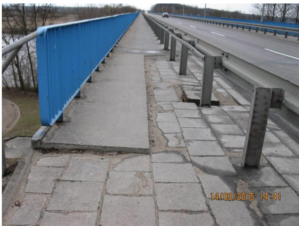
Fot. 32 Widok chodnika na dojściu do mostu od strony m. Brok (górna woda). Wstępuje kilkucentymetrowe zaniżenie nawierzchni z płytek w stosunku do konstrukcji górnej skrzydełka mostu. Nawierzchnia chodnika z płytek popękana z nierównościami i zanieczyszczeniami piaskiem. W rejonie barier widoczne uszkodzenie pokrywy studzienki urządzeń obcych.
