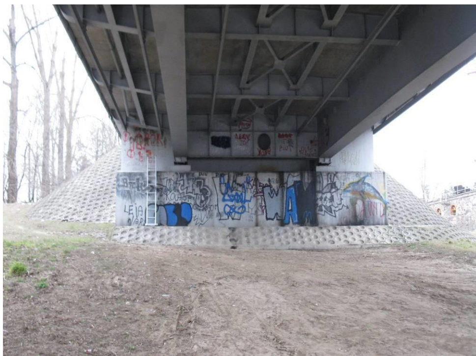
Fot. 24 Widok przyczółka od strony m. Brok. Powierzchnia betonowa przyczółka oraz elementy konstrukcji stalowej pokryte graffiti. Na powierzchni betonowej występują obszary złuszczenia powłok antykorozyjnych betonu oraz pojedyncze rysy.
