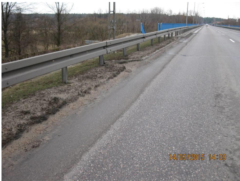
Fot. 3 Widok krawężników na dojeździe. Krawężniki betonowe na dojeździe posiadają liczne ubytkami betonu oraz uległy zklawiszowaniu. Zostały zanieczyszczone grubą warstwą piasku i materiału organicznego na którym rozwinęła się roślinność trawiasta. Nawierzchnia w rejonie krawężników została zanieczyszczona piaskiem, posiada głębokie koleiny i pęknięcia. Pobocza gruntowe zawyżone w stosunku do poziomu krawężników.
