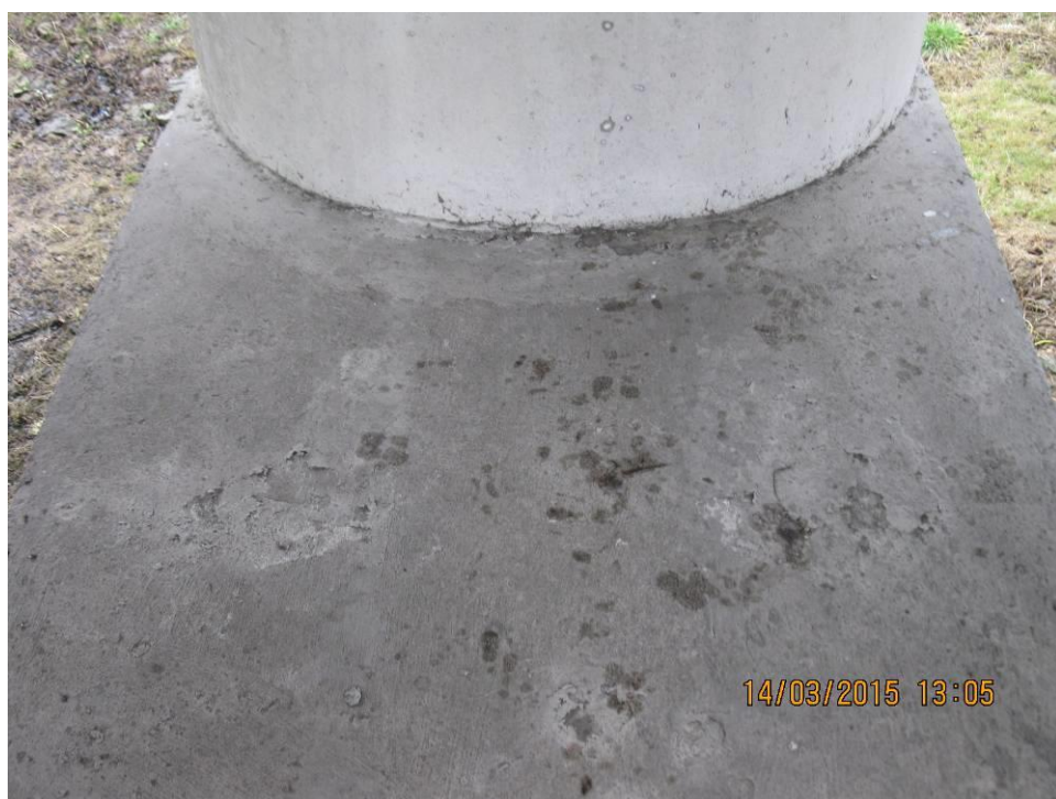
Fot. 28 Widok od góry oczepu podpory pośredniej. Powierzchnia betonu z niewielkimi nierównościami i złuszczeniami oraz zanieczyszczeniami pyłem i kurzem. Ogólny stan podpory jest dobry.
