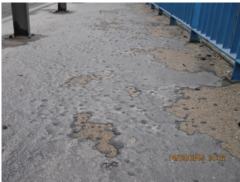
Fot. 8 Widok nawierzchni w części chodnikowej. Nawierzchnia z lanych mas asfaltowych pokryta licznymi kilkucentymetrowymi pęcherzami powodującymi zaleganie wody opadowej oraz piasku zwłaszcza w rejonie balustrad szczelinkowych i barier mostowych.
