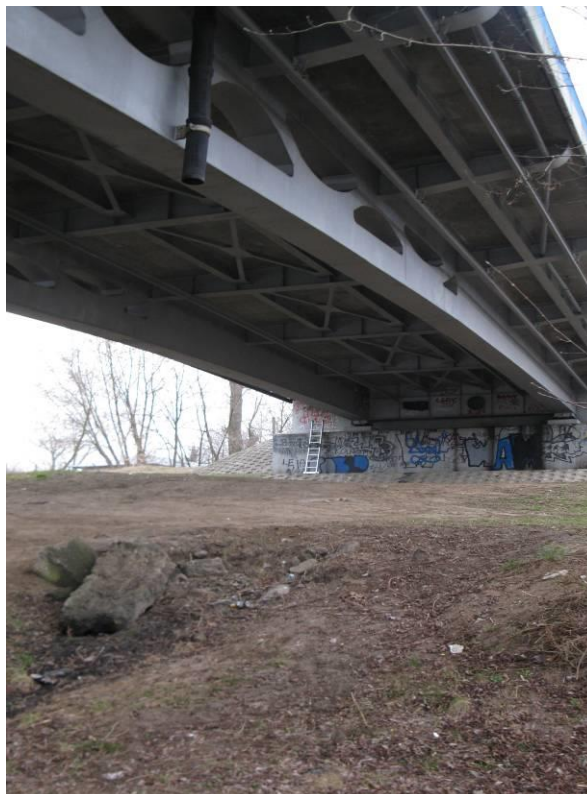
Fot. 39 Widok umocnienia nasypu drogowego pod obiektem od strony m. Brok. Umocnienie nasypu wykonane jedynie w obrębie przyczółka. W wyniku braku umocnienia skarpy w kierunku rzeki Bug następuje rozmywanie nasypu wodą opadową. W miejscu zrzutu wody opadowej z rury wpustu mostowego zabezpieczenie nasypu przed rozmywaniem wykonano gruzem betonowym.
