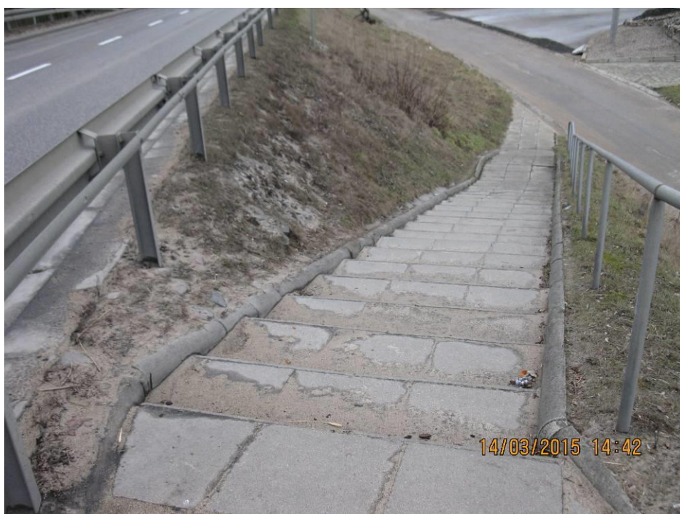
Fot. 34 Widok schodów skarpowych od strony m. Brok (górna woda). Nawierzchnia schodów wykonana z prefabrykowanych płytek betonowych chodnikowych zanieczyszczona piaskiem. W rejonie obrzeży betonowych zanieczyszczenia piaskiem i roślinnością trawiastą. Nieprzepisowe balustrady od strony skarpy nasypu drogowego.
