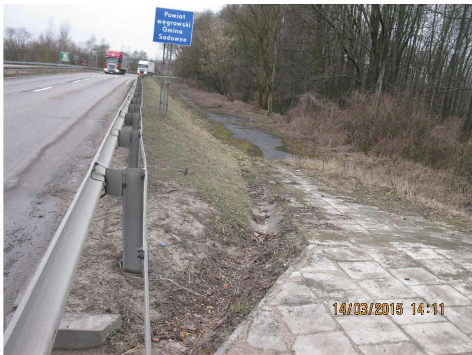
Fot. 41 Widok ścieku korytkowego od strony m. Łochów (dolna woda). Ściek zanieczyszczony grubą warstwą piasku i fragmentami obumarłej roślinności..
