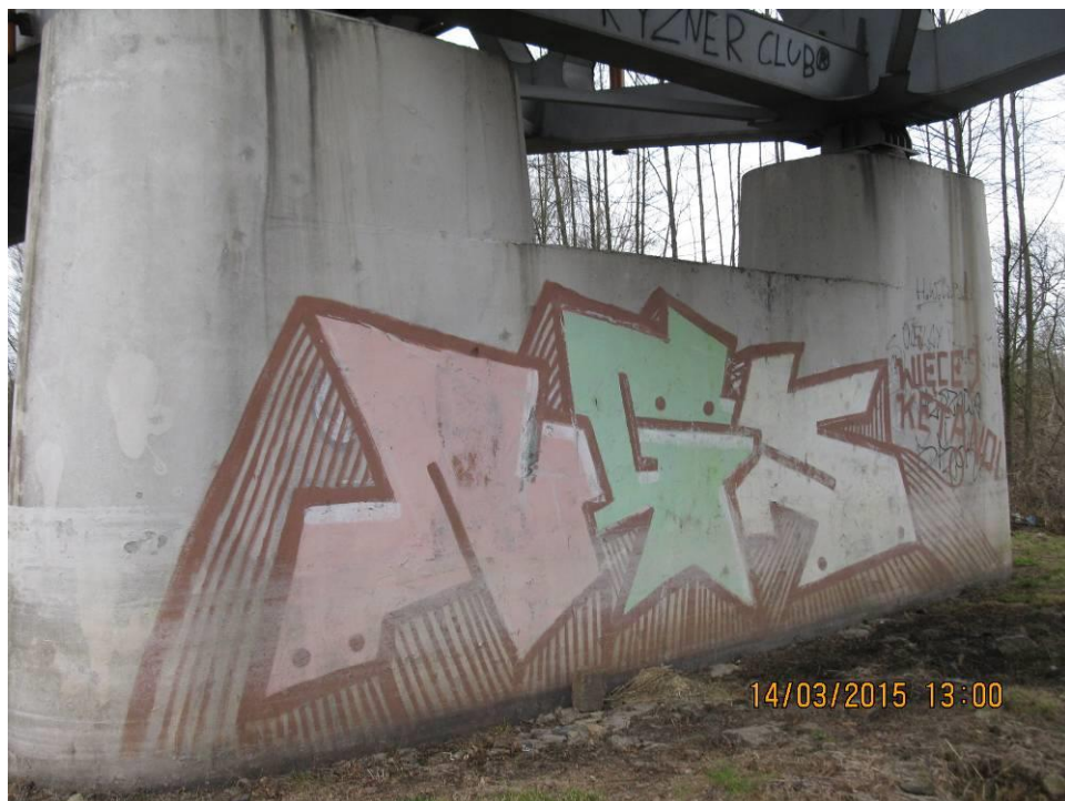
Fot. 27 Widok podpory pośredniej od strony m. Łochów. Powierzchnia podpory zanieczyszczona graffiti oraz ciemnymi wykwitami powstałymi podczas spływu wody opadowej po powierzchni podpory.
