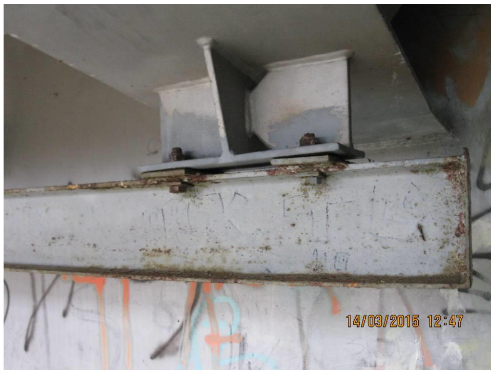
Fot. 17 Widok wieszaka i przewodnicy wózków technicznych do obsługi mostu. Występuje uszkodzenie powłok malarskich i korozja powierzchniowa elementów stalowych. Na dalszym planie zanieczyszczenie dźwigarów stalowych graffiti.
