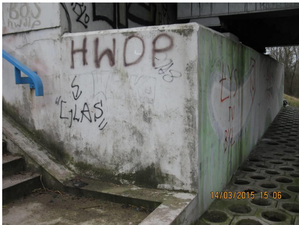
Fot. 23 Widok przyczółka mostu od strony m. Łochów. Powierzchnia betonowa pokryta graffiti, zawilgocona, z ciemnymi wykwitami i wegetacją roślinności mszastej. Na powierzchni betonowej widoczne pojedyncze rysy na poziomie skrzydełek i obszary złuszczenia powłok antykorozyjnych betonu.
