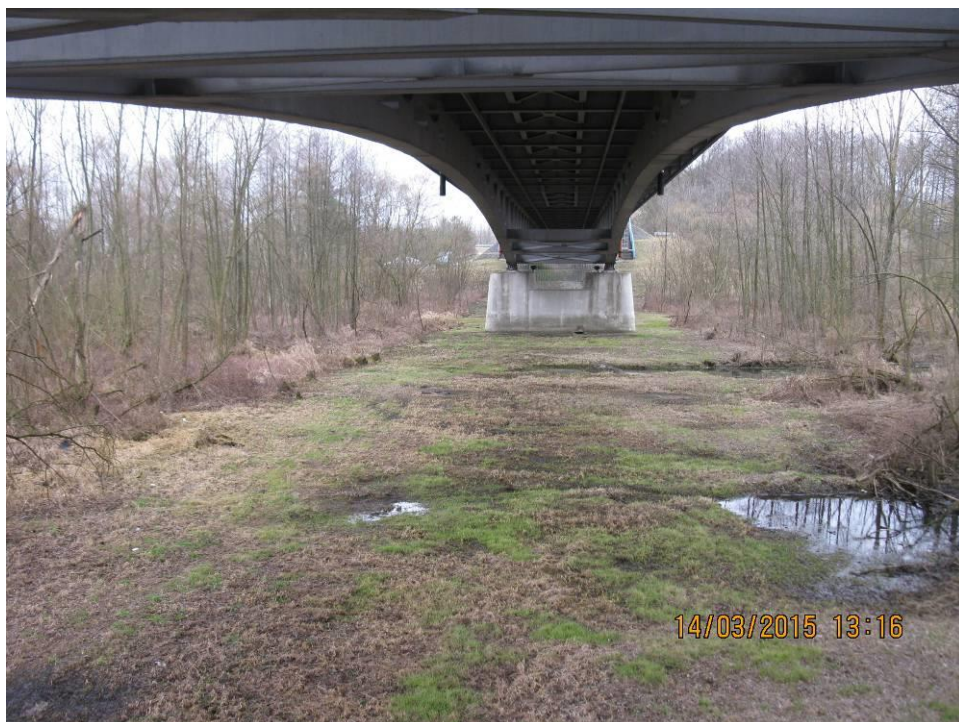
Fot. 43 Widok części podmostowej. Pod obiektem występuje uporządkowana roślinność trawiasta. Teren jest niewyrównany, a w zagłębieniach zalega woda. Wstępujące poza pasem podmostowym drzewa koronami przysłaniają elementy obiektu powodując jego ograniczoną wentylację, a tym samym jego przyspieszoną degradację.
