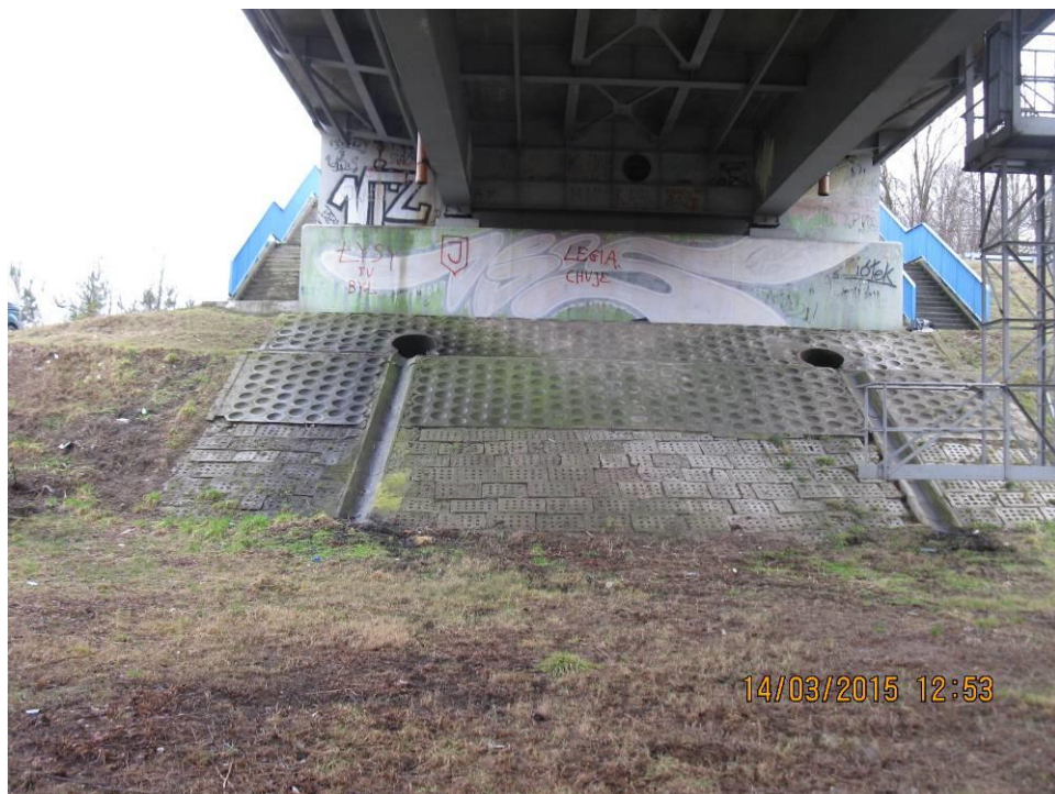
Fot. 37 Widok umocnienia nasypu drogowego pod obiektem od strony m. Łochów. Występują nierówności w umocnieniu spowodowane klawiszowaniem prefabrykatów betonowych umocnienia.
