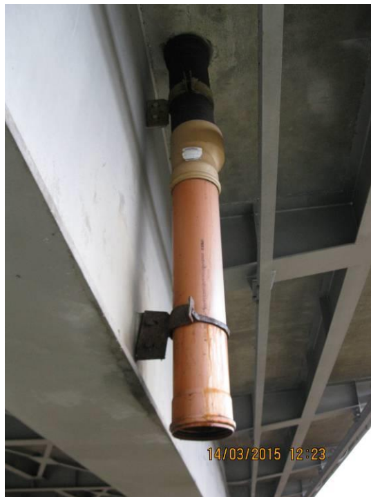
Fot. 11 Widok mocowania i rury odwodnienia wpustu mostowego. Żeliwna rura odprowadzenia wody z wpustu oraz wieszaki rury silnie powierzchniowo skorodowane. „Rude” wykwity korozji zanieczyszczają sąsiednie współpracujące elementy mostu.
