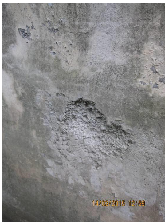
Fot. 30 Widok w zbliżeniu powierzchni betonowej podpory pośredniej. Widoczne złuszczenie górnej struktury betonu oraz pojedyncze tzw. „RAKI” powstałe podczas robót betoniarskich na etapie wykonawstwa mostu.
