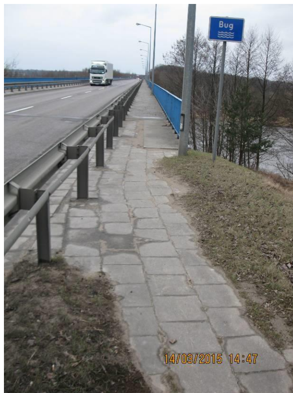
Fot. 35 Widok bezpośredniego dojścia dla pieszych od strony m. Brok (dolna woda). Nawierzchnia z płytek zanieczyszczenia piaskiem i roślinnością oraz zdeformowana. Brak balustrad zabezpieczających od strony skarpy nasypu drogowego.
