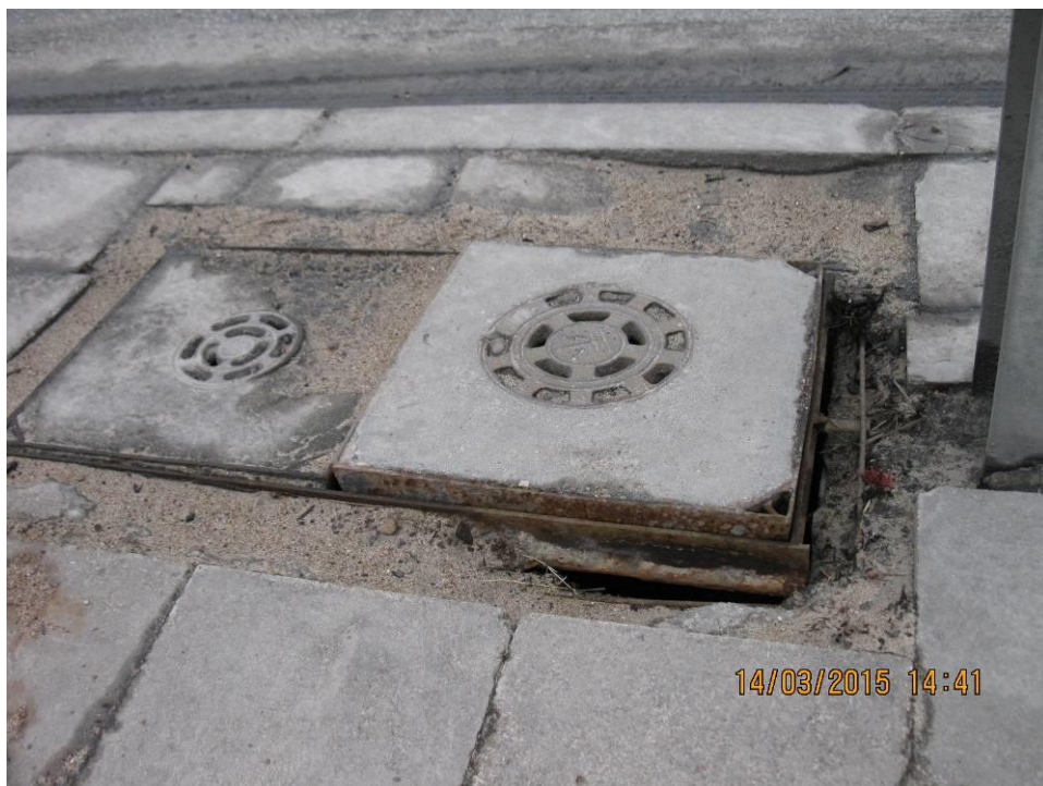
Fot. 33 Zbliżenie na studzienkę urządzeń obcych od strony m. Brok (górna woda). Uszkodzone osadzenie komory pokrywy studzienki urządzeń obcych w konstrukcji chodnika. W rejonie studzienki widoczne zaniżenia oraz ubytki elementów nawierzchni chodnika.
