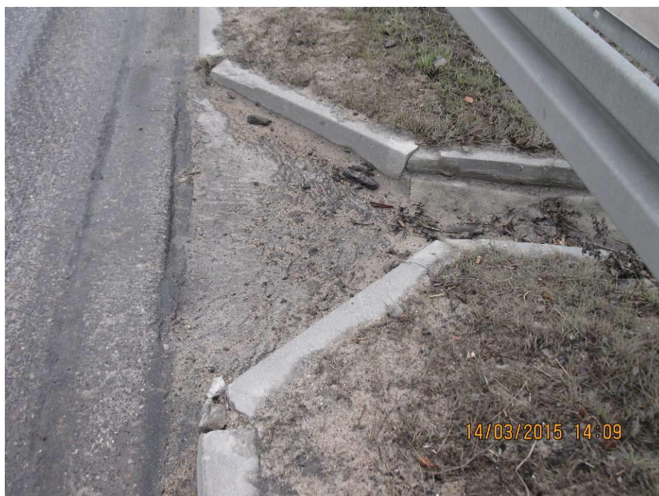
Fot. 42 Widok wlotu wody z jezdni do ścieku skarpowego. Nastąpiło uszkodzenie prefabrykatów betonowych oraz ich spoinowania zaprawami cementowymi. Wlot zanieczyszczony piaskiem i fragmentami obumarłej roślinności.
