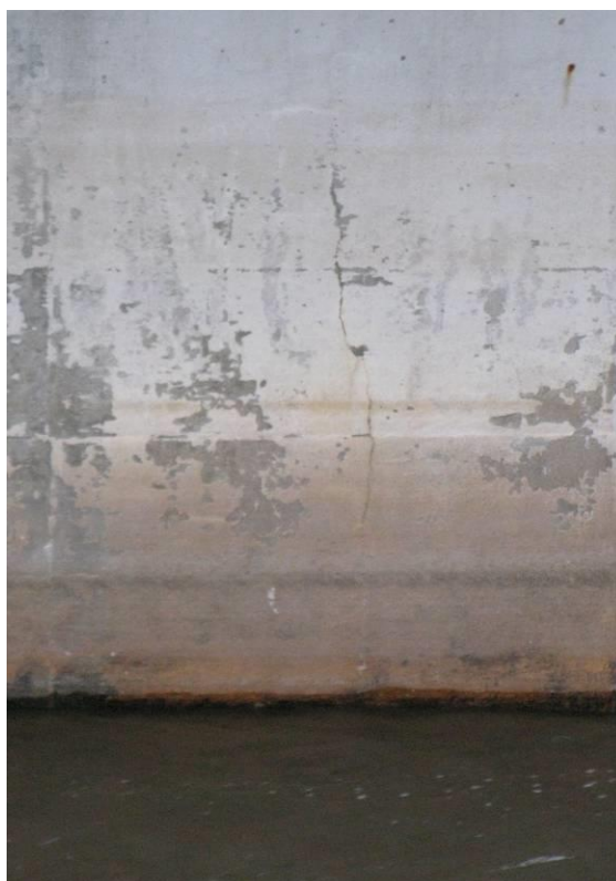
Fot. 26 Widok w zbliżeniu podpory pośredniej usytuowanej w korycie rz. Bug. Na powierzchni betonowej podpory widoczna rysa pionowa oraz rdzawe osady pozostawione przez przepływającą wodę.
