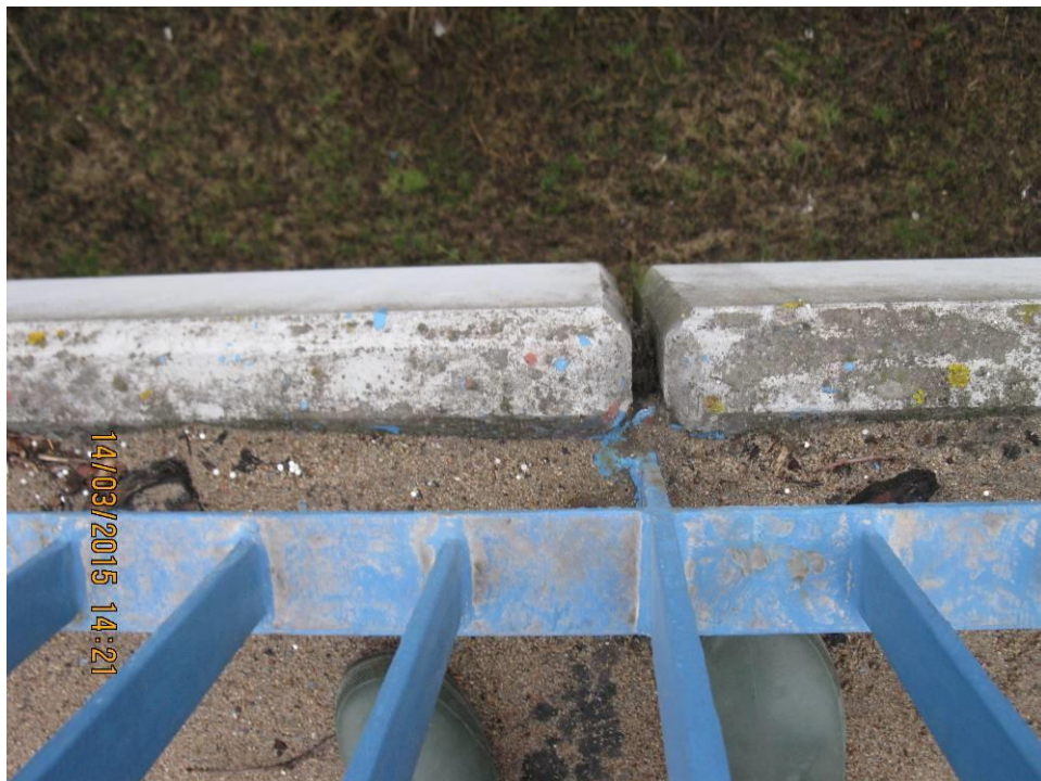
Fot. 9 Widok gzymsu od strony balustrad szczelinkowych. W rejonie gzymsu następuje zaleganie dużych ilości piasku powodując przyspieszoną korozję marek i stopek balustrad. Gzymsy pokryte zanieczyszczeniami i skupiskami mchu.
