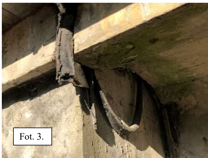
Fot. 3. Wkładka dylatacyjna; Fot. 4. Styk przęsła ze ścianką zapleczną
