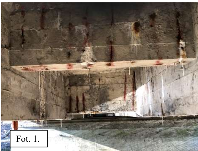
Fot. 1. Degradacja poprzecznic przęsła zawieszonego; Fot. 2. Ubytki betonu belki gzymsowej, widoczne fragmenty gruzu.
