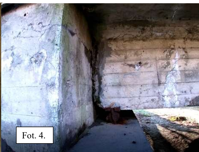
Fot. 3. Wkładka dylatacyjna; Fot. 4. Styk przęsła ze ścianką zapleczną
