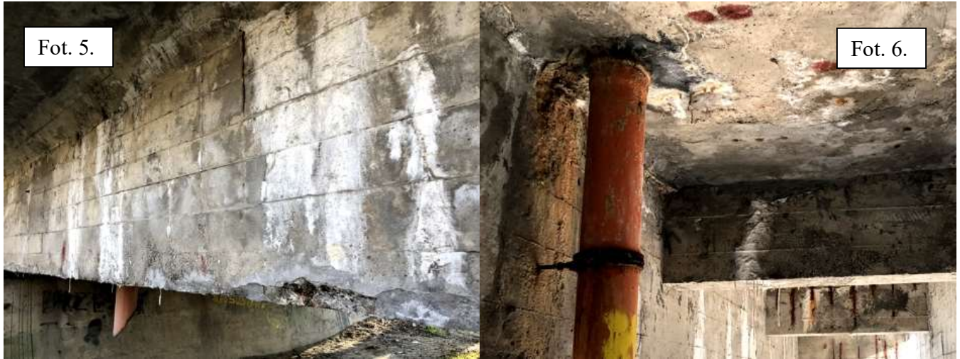
Fot. 5. Zacieki i wykwity na dźwigarze zewnętrznym; Fot. 6. Uszkodzenia konstrukcji w obrębie rury spustowej
