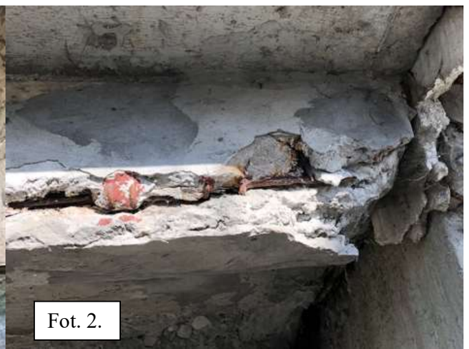
Fot. 1. Degradacja poprzecznic przęsła zawieszonego; Fot. 2. Ubytki betonu belki gzymsowej, widoczne fragmenty gruzu.
