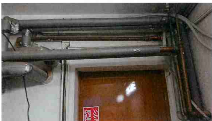
Foto 8 Widok instalacji bez wykonanych przepustów instalacji przez ściany konstrukcyjne i strop
