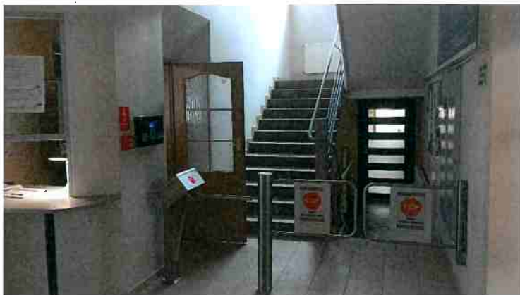
Foto 1 Widok wejścia na parterze - do wydzielenia ścianką EI 60 i drzwiami EI 30
