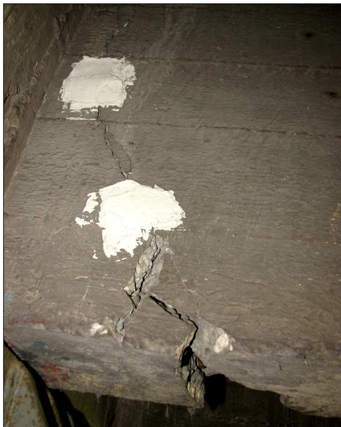
Fot. 38. Przęsło B-C, poprzecznica nad podporą C. Zarysowanie ukośne o rozwartości do 1,5 mm z ubytkami betonu. Brak propagacji rysy na plombę gipsową.
