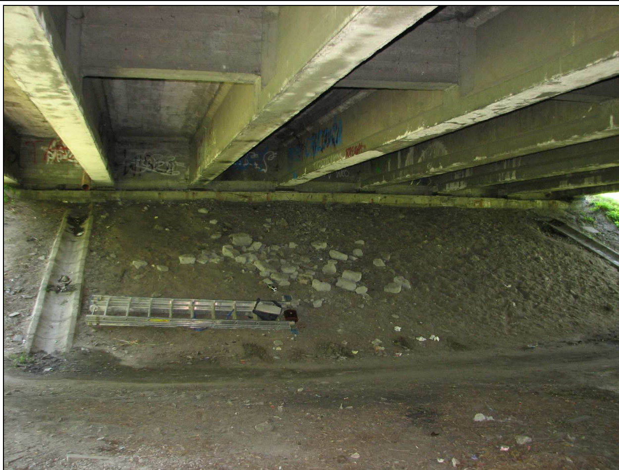
Fot. 80. Brak umocnienia i zanieczyszczenie skarpy przed przyczółkiem od Sr. Chrzanowa (podpora P)
