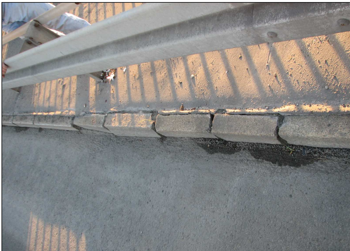
Fot. 27. Typowe uszkodzenie krawężników na długości przęseł stalowych – obluzowania i niewielkie deformacje krawężników spowodowane brakiem zespolenia z podłożem i konstrukcją chodnika. Uszkodzenie występuje łącznie na ok. 20 mb krawężnika.
