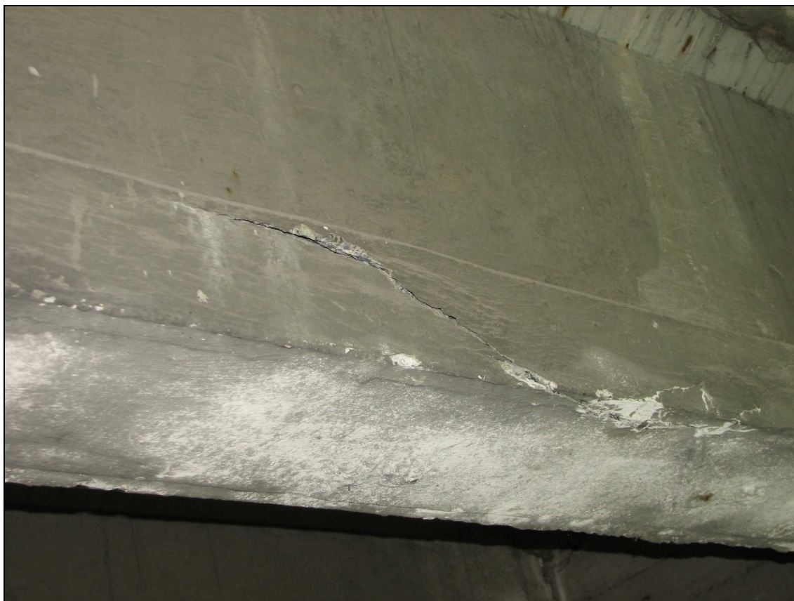
Fot. 35. Przęsło O-P, belka nr 7. Zarysowanie podłużne i odprysk betonu – uszkodzenie jest prawdopodobnie wadą wytwórczą belki.
