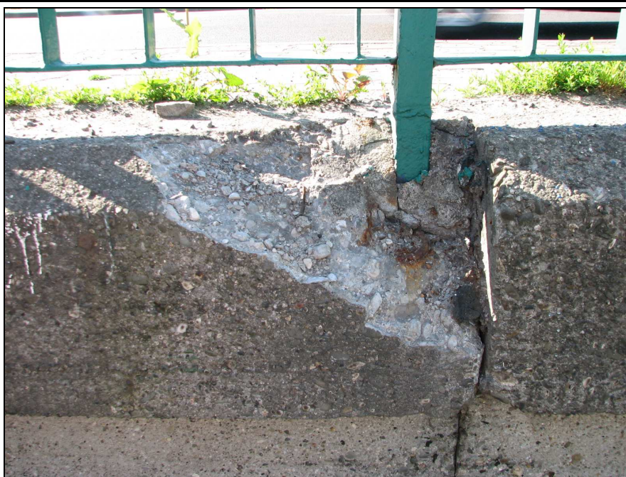
Fot. 78. Mur oporowy zachodni. Duży ubytek betonu w gzymsie zagrażający stateczności słupka balustrady.
