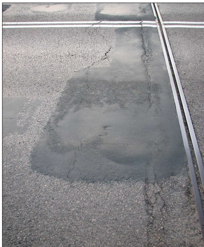
Fot. 18. Dylatacja skrajna nad podporą P. Deformacje i spękania nawierzchni jezdni od str. dojazdu. Zanieczyszczona wkładka dylatacyjna.
