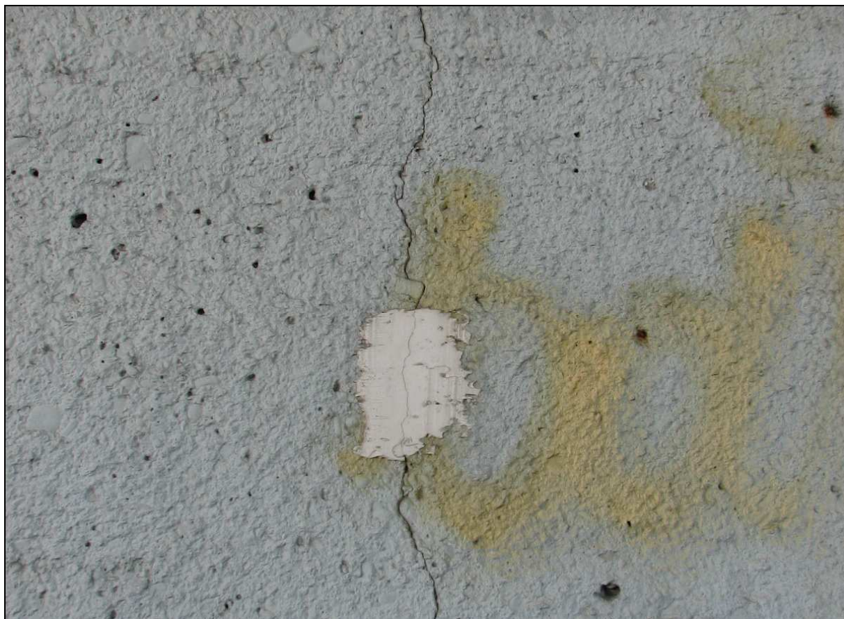
Fot. 65. Podpora E. Rysa pionowa o rozwarości 0,4 mm w połowie szerokości filara. Widoczna propagacja rysy na plombę gipsową.
