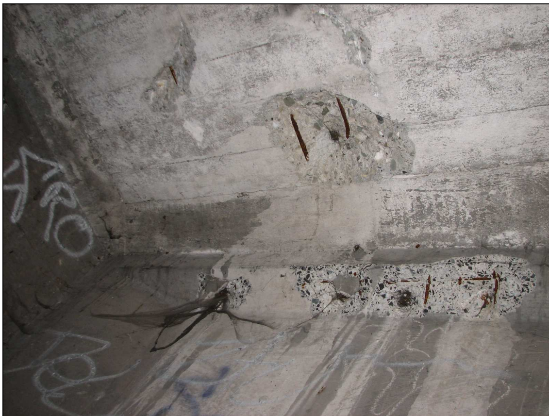
Fot. 36. Przęsło O-P, belka nr 3. Ubytki betonu odsłaniające korodujące zbrojenie półki górnej. Ubytek betonu w płycie pomostu.
