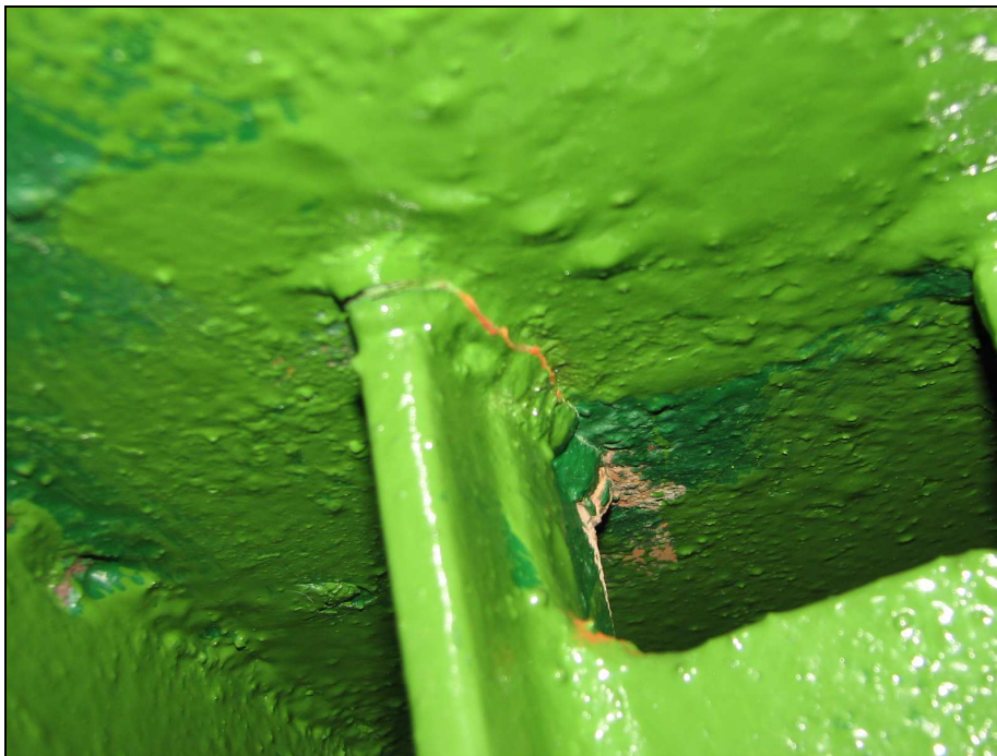
Fot. 55. Typowe uszkodzenie przekroju stalowego. W ok. 70% połączeń żeber pionowych przy zewnętrznych średnicach przekroju skrzynkowego występuje pęknięcie spoiny łączącej półkę żebra z blachą pomostu
