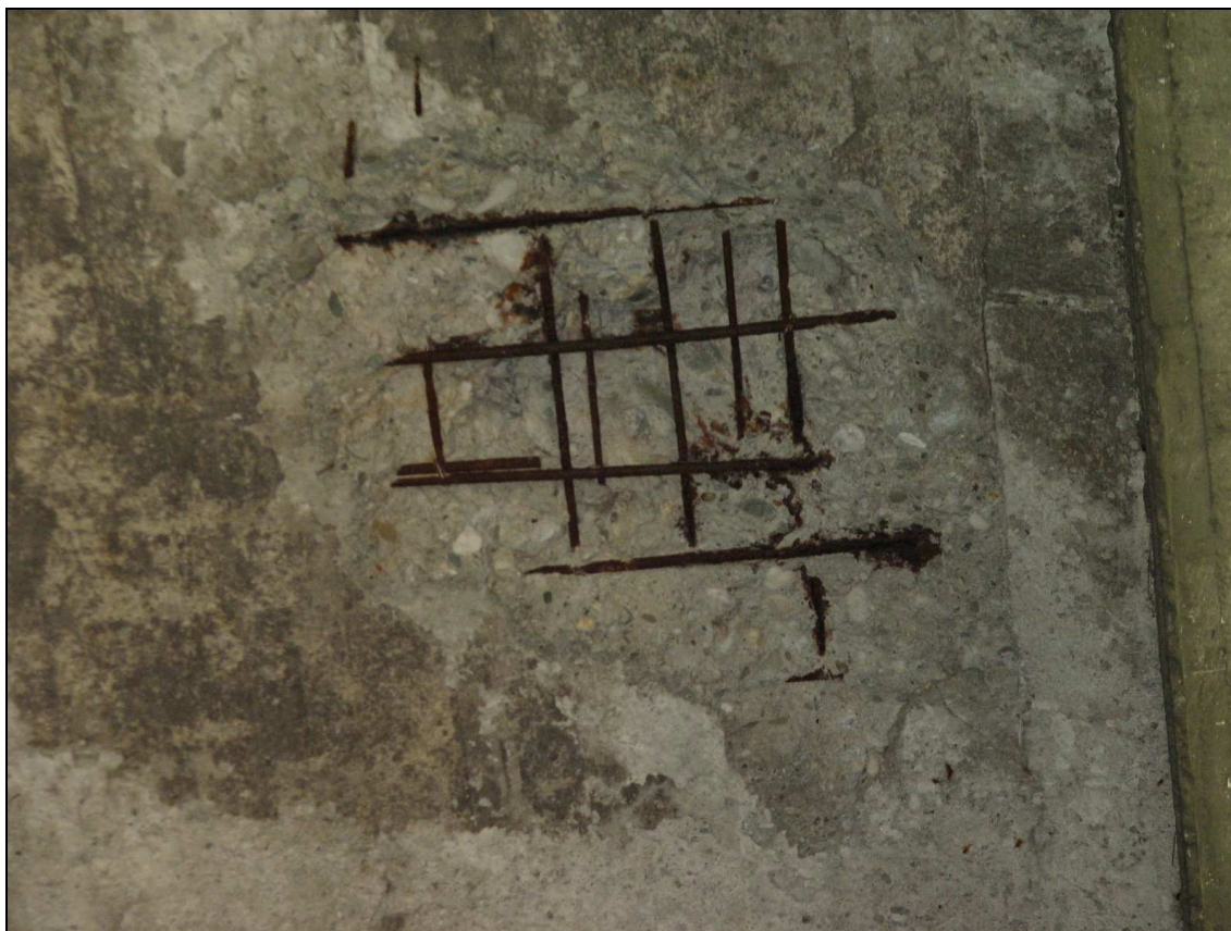
Fot. 45. Przęsło I-J. Szczegół jednego z większych ubytków betonu płyty (pomiędzy belkami nr 6 i 7). Głębokość ubytku do 4 cm, odsłonięte zbrojenie powierzchniowo skorodowane.
