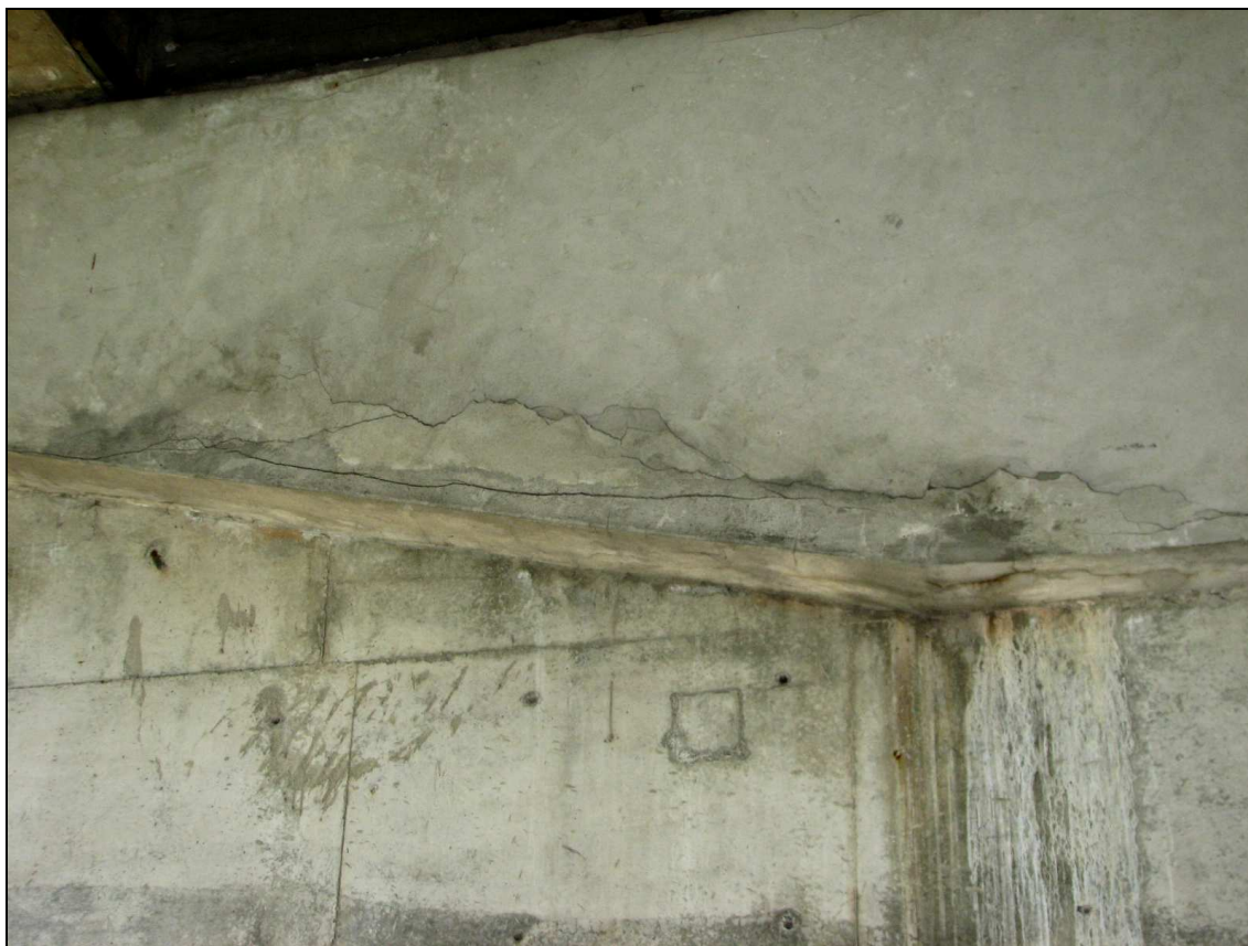
Fot. 62. Typowe uszkodzenia filarów w części betonowej wiaduktu: przykład spękań o rozwartości sięgającej 5 mm wzdłuż dolnej krawędzi oczepu. Widoczne również wykwyty świadczące o przeciekach przez oczep (na fotografii podpora L).
