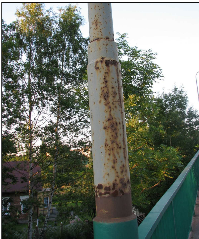
Fot. 74. Typowe uszkodzenie słupów latarni: korozja powyżej poziomu balustrady
