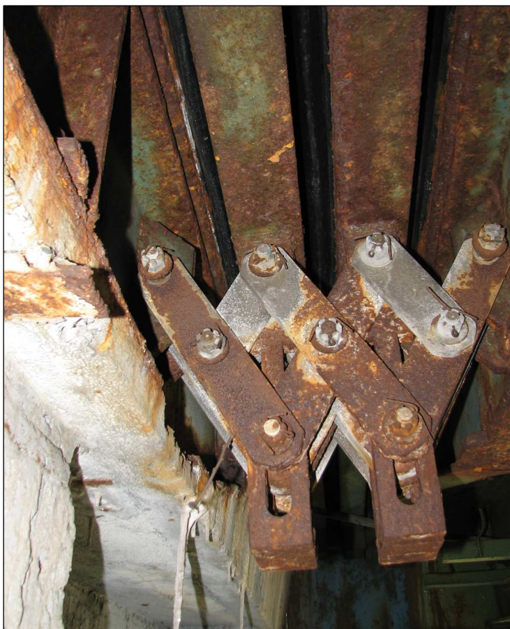
Fot. 29. Typowy stan wielomodułowych urządzeń dylatacyjnych nad podporą E i H – zaawansowana korozja profili dylatacyjnych i elementów mechanicznych („nożyc”), powodująca częściowe blokowanie możliwości odkształcenia dylatacji .
