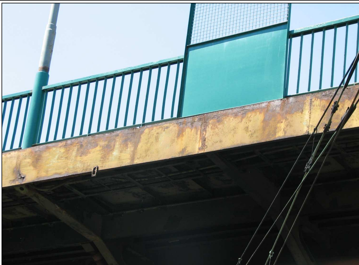
Fot. 28. Typowe uszkodzenie gzymsu na przęsłach stalowych. Korozja na ok. 70 % powierzchni, lokalnie wżerowa, powodująca perforację blachy.
