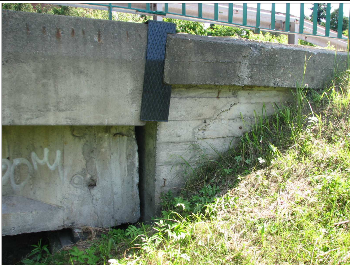
Fot. 58. Podpora P, przyczółek od str. Chrzanova. Zaleganie gruntu na ławie podłożyskowej. Raki i nierówności betonu na skrzydle. Korozja zbrojenia w prefabrykacie gzymsu.
