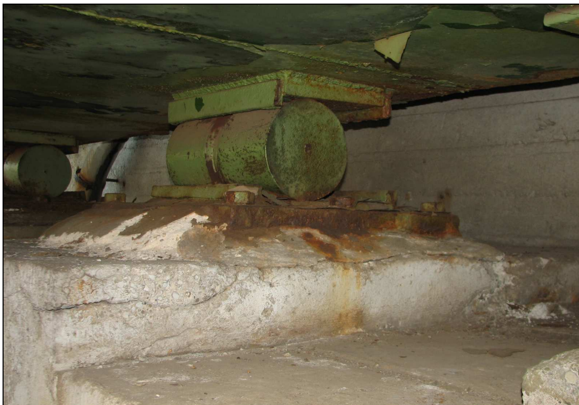
Fot. 71. Łożysko przedskrajne wschodnie konstrukcji stalowej na podporze H. Położenie ogranicznika przesuwu na blasze górnej względem wałka odpowiada położeniu skrajnemu i oznacza brak możliwości dalszego swobodnego wydłużenia przęsła. W pozostałych łożyskach na tej podporze wzajemne położenie elementów łożysk zapewnia możliwość dalszych przemieszczeń. Widoczne spękania i ubytki podlewki oraz ciosu łożyskowego.
