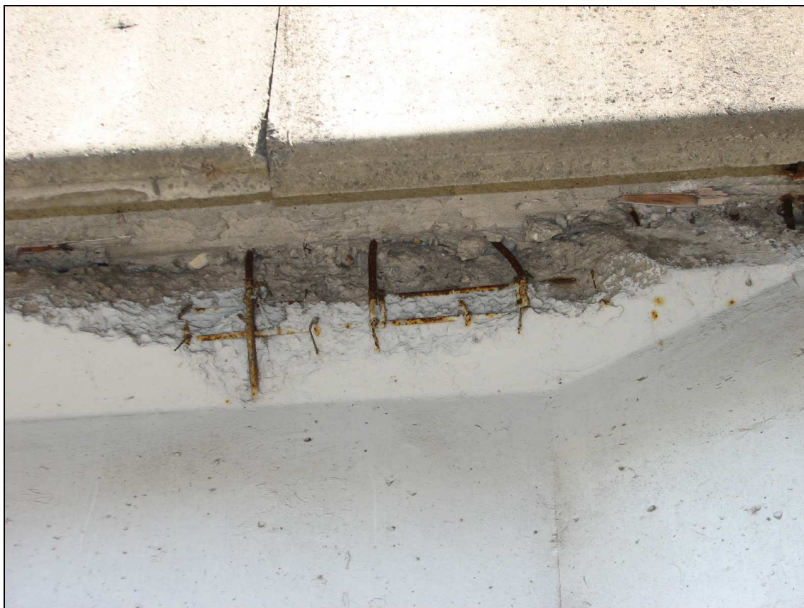
Fot. 31. Przęsło A-B. Ubytek betonu w półce górnej belki nr 8 przy podporze A. (Uwaga: numeracja belek w przekroju poprzecznym wg rys. 1.2)
