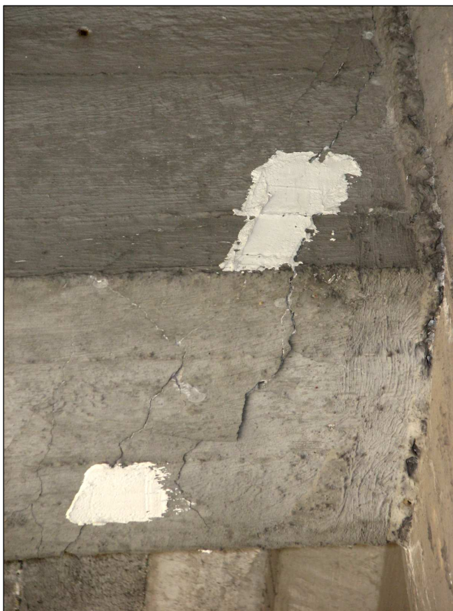
Fot. 37. Przęsło B-C, poprzecznica przęsłowa. Zarysowanie ukośne o rozwartości do 0,6 mm z ubytkami betonu. Brak propagacji rysy na plombę gipsową.
