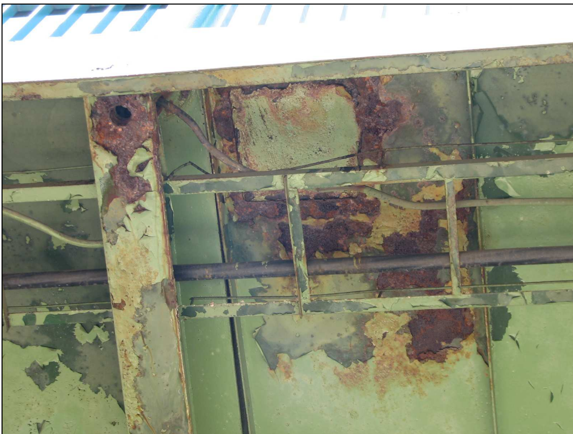
Fot. 51. Typowe uszkodzenia przęseł stalowych. Intensyfikacja korozji wspornika podchodnikowego w rejonie wjazdu przy latarni.
