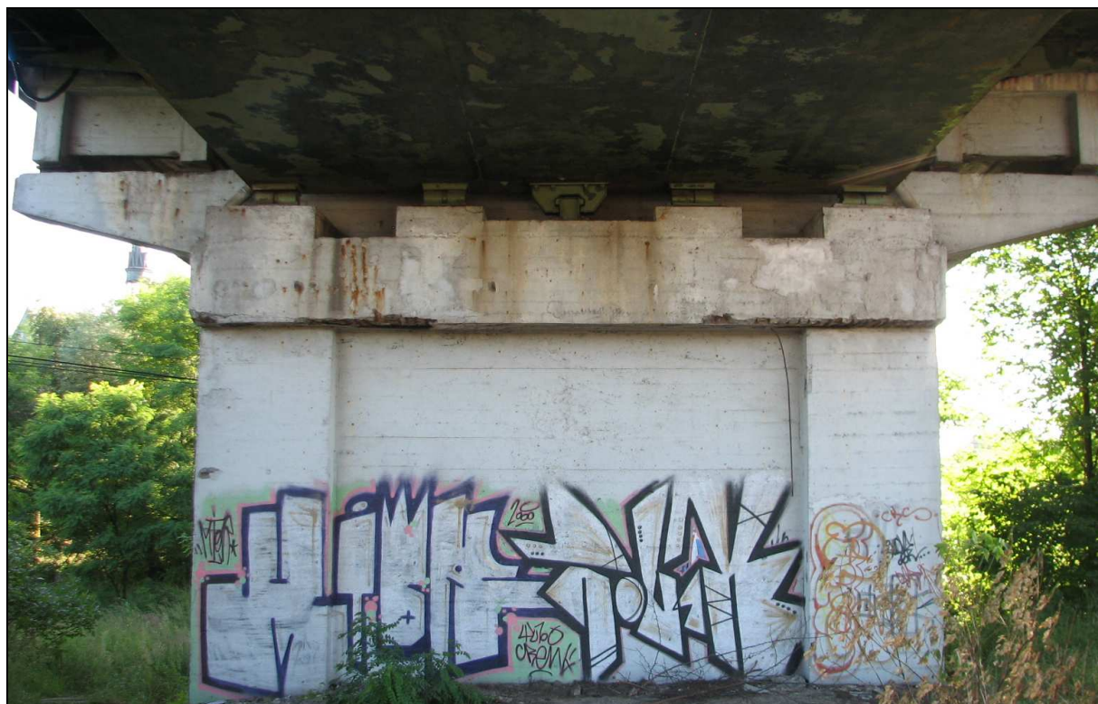
Fot. 66. Podpora H (pośrednia pomiędzy częścią stalową i betonową od str. Chrzanowa). Przebarwienia i wykwyty na betonie oczepu świadczące o jego okresowym zawilgoceniu. Intensywna korozja zbrojenia oraz odpryski otuliny. Zarysowania poziome na ciosach podłożyskowych (patrz fot. 67).
