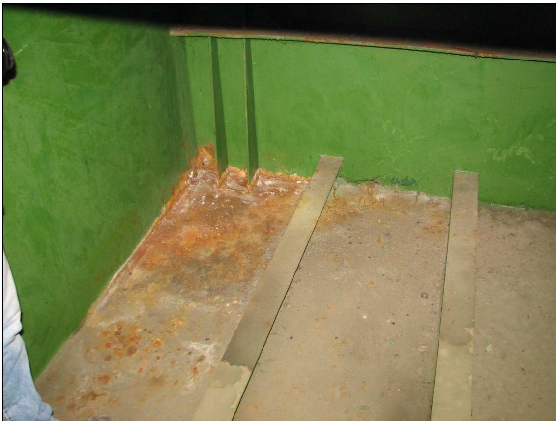
Fot. 53. Intensywna korozja blachy dolnej przekroju skrzynkowego nad podporą E.
