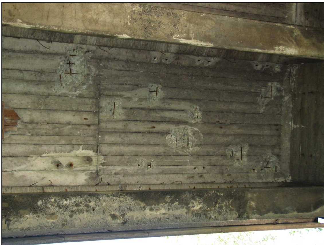
Fot. 43. Przęsło H-I. Liczne ubytki betonu o głębokości do 4 cm odsłaniające korodujące powierzchniowo zbrojenie płyty pomiędzy belkami nr 1 i 2. Przebarwienia betonu płyty i dźwigarów w wyniku „starych” przecieków.
