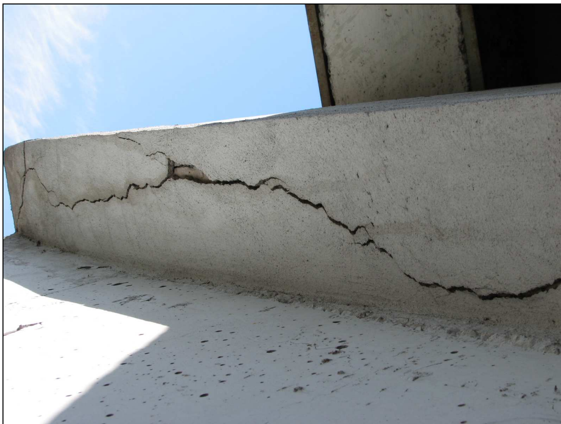
Fot. 61. Typowe uszkodzenia filarów w części betonowej wiaduktu: przykład spękań o rozwartości sięgającej 4 mm wzdłuż dolnej krawędzi oczepu (na fotografii podpora B).
