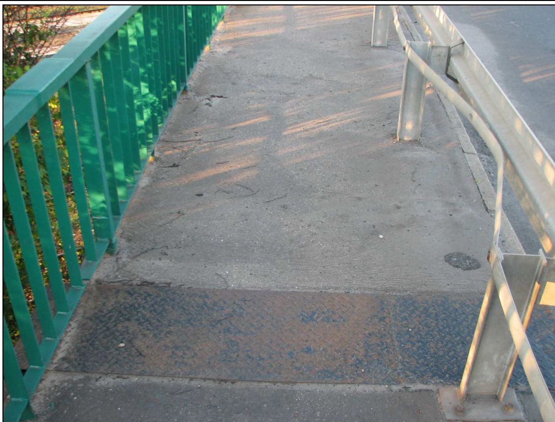
Fot. 20. Dylatacja chodnika nad podporą H. Korozja powierzchniowa blachy dylatacyjnej (typowa dla wszystkich dylatacji). Deformacja pasa bariery ochronnej (brak zdylatowania).
