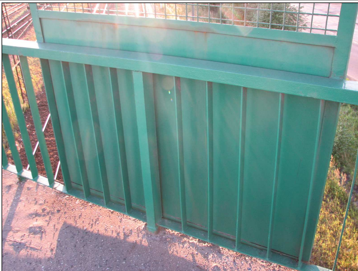
Fot. 76. Typowe uszkodzenie osłon przeciwporażeniowych – niewielkie ogniska korozji powierzchniowej.
