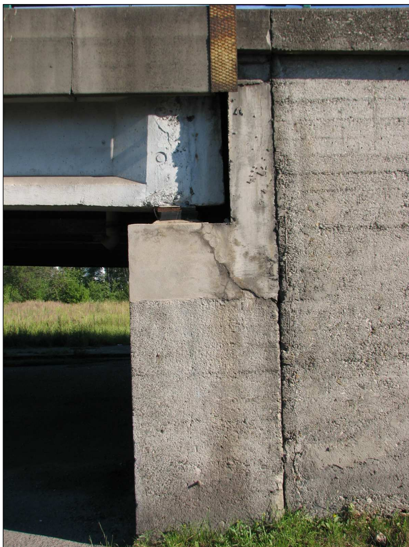
Fot. 56. Podpora A, przyczółek od str. Trzebini. Zarysowanie ukośne na ławie podłożyskowej o rozwartości 0,2 mm.
