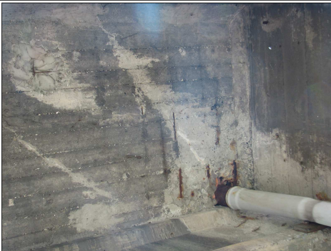
Fot. 42. Przęsło C-D, płyta pomostu pomiędzy belkami nr 7 i 8 przy podporze C. Korozja zbrojenia płyty wokół wpustu. Przebarwienia betonu świadczące o okresowym namakaniu.
