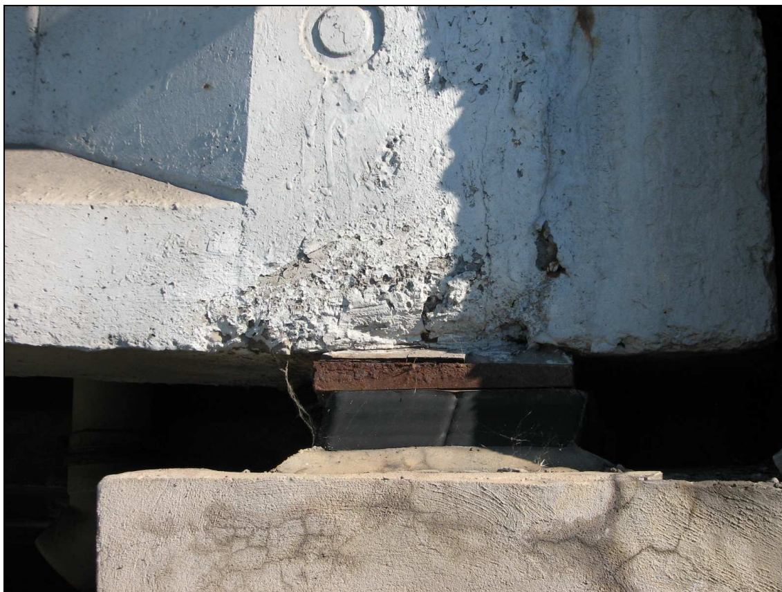
Fot. 69. Łożysko skrajne wschodnie na podporze A. Widoczne nadmierne trwałe odkształcenie (znacznie większe od odkształcenia pozostałych łożysk na tej podporze) oraz brak pełnego styku pomiędzy blachą górną a blokiem elastomerowym.
