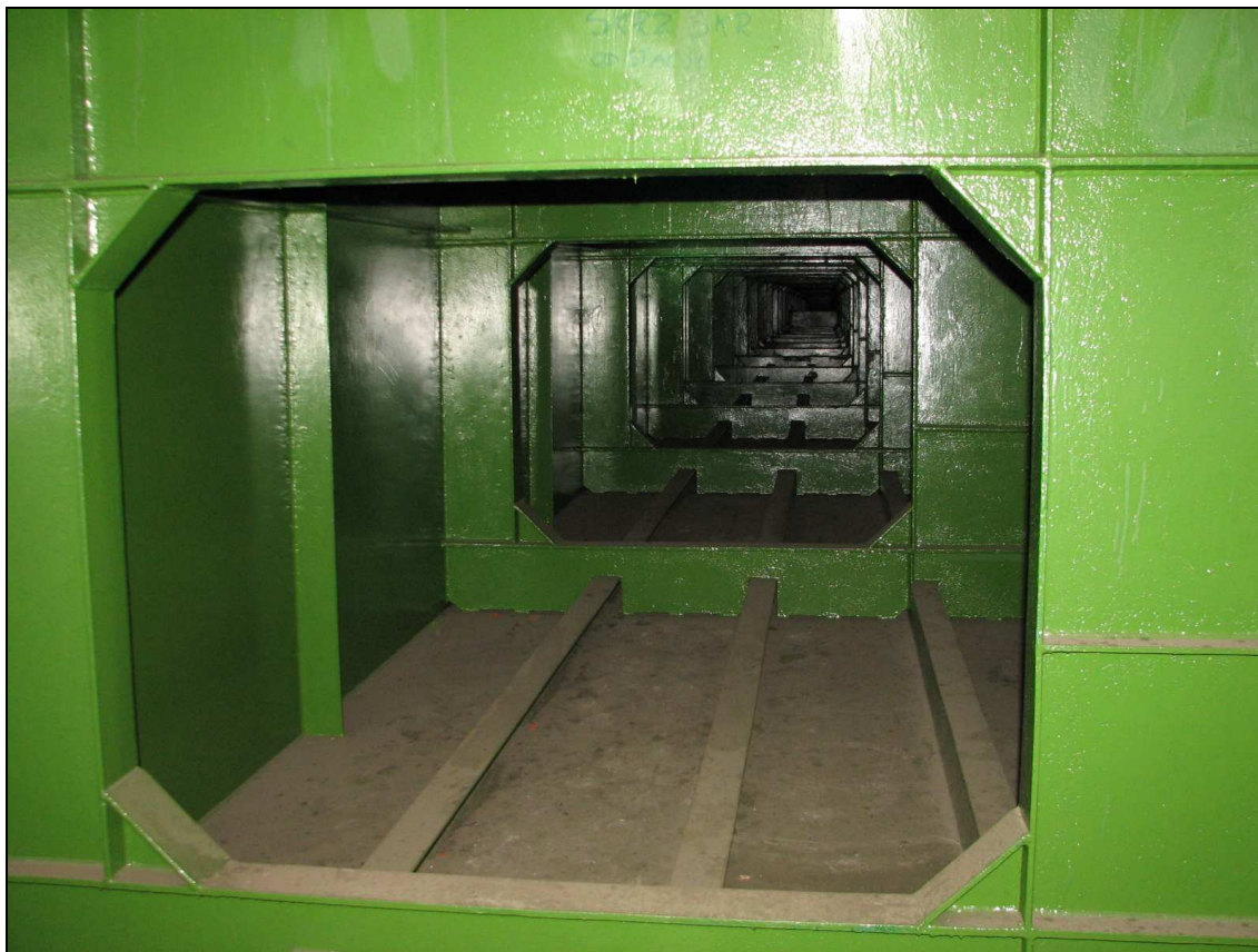
Fot. 11. Część stalowa wiaduktu – widok wnętrza przekroju skrzynkowego
