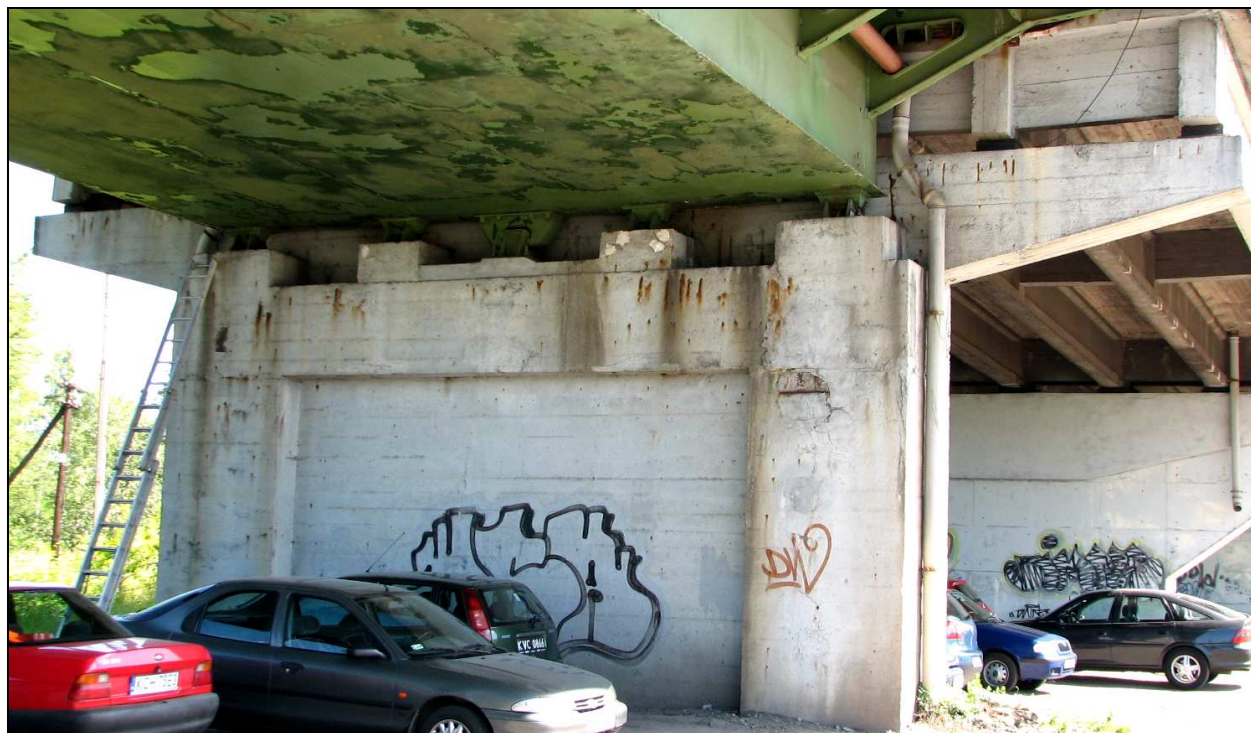
Fot. 63. Podpora E (pośrednia pomiędzy częścią stalową i betonową od str. Trzebini). Przebarwienia i wykwyty na betonie świadczące o jego okresowym zawilgoceniu. Intensywna korozja zbrojenia oraz odpryski otuliny w ławie podłożyskowej i na słupach. Pęknięcia na ciosach podłożyskowych (patrz fot. 64).
