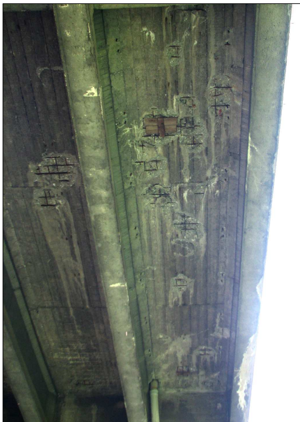
Fot. 48. Przęsło K-L. Liczne ubytki betonu i odsłonięte zbrojenie w płycie pomostu pomiędzy belkami nr 1, 2 i 3. Widoczne deski pozostawione po naprawie ubytków betonu.
