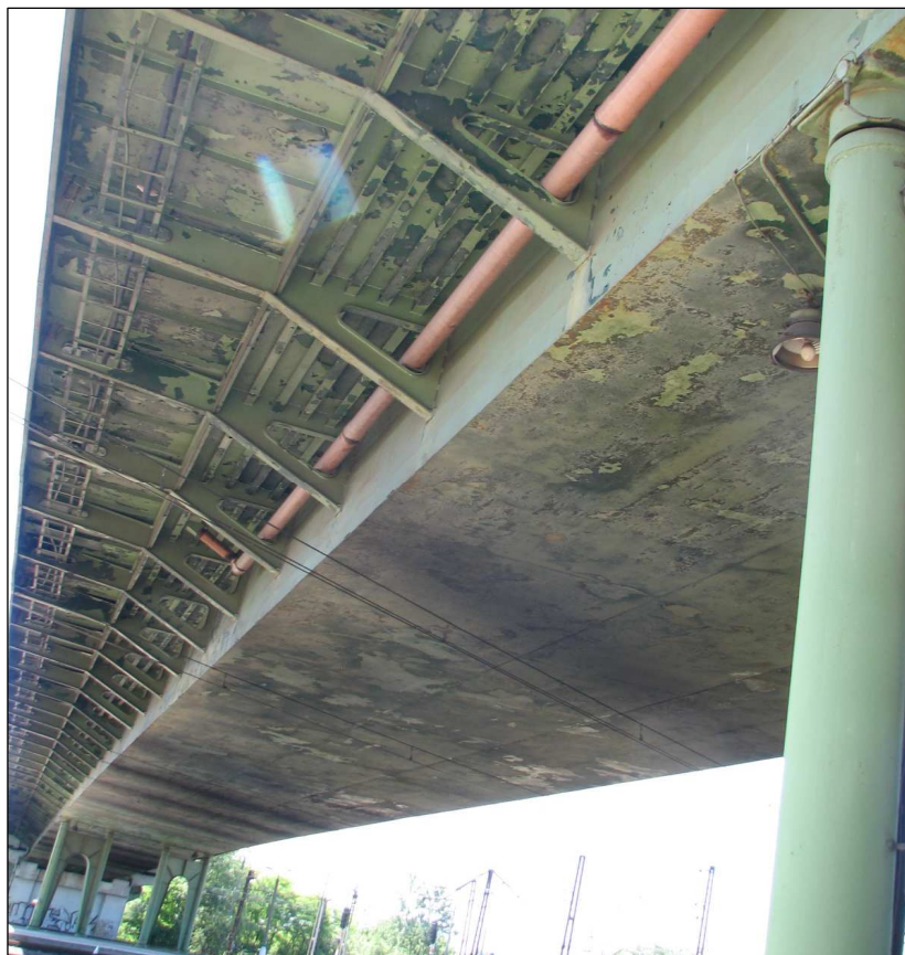
Fot. 50. Typowe uszkodzenia przęseł stalowych: złuszczenia powłok malarskich i lokalna korozja powierzchniowa na dolnej powierzchni dźwigara skrzynkowego i wspornika podchodnikowego. Na fotografii przęsło F-H.
