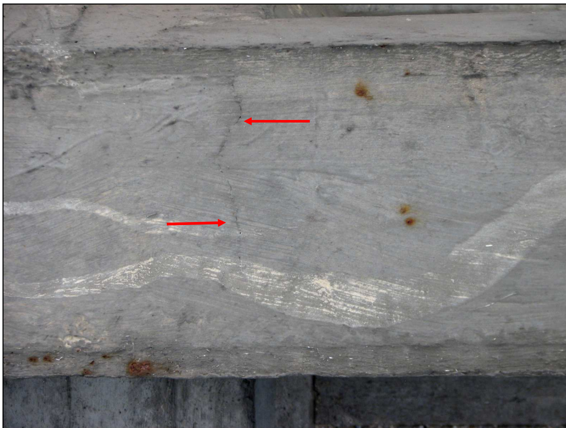
Fot. 33. Przęsło B-C, belka nr 7. Jedna z kilku nieaktywnych rys o rozwartości nie przekraczającej 0,05 mm. Brak propagacji rysy na powłokę ochronną betonu świadczy o braku aktywności rys, które powstały prawdopodobnie na etapie produkcji belek. Rdzawe plamy świadczące o korozji zbrojenia belki.
