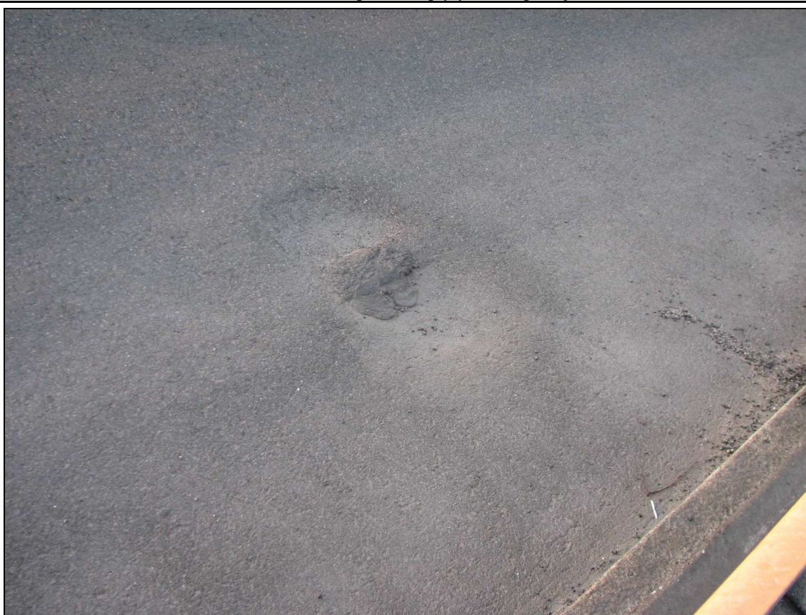
Fot. 24. Lokalna deformacja nawierzchni przęsła stalowego nad podporą G przy krawężniku wschodnim. Powierzchnia 0,4 m 2 , głębokość do 3 cm. Uszkodzenie zwiększa oddziaływanie dynamiczne pojazdów na konstrukcję.
