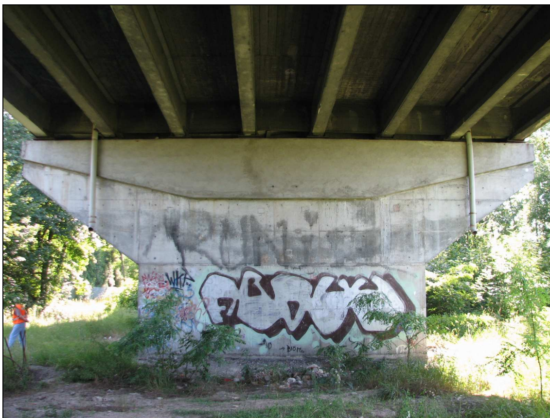
Fot. 8. Część betonowa wiaduktu – widok typowego filara
