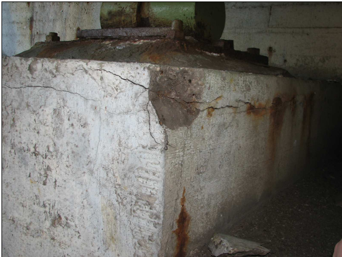
Fot. 67. Podpora H. Spękania poziome ciosu łożyskowego spowodowane korozją zbrojenia. Korozja łożyska.
