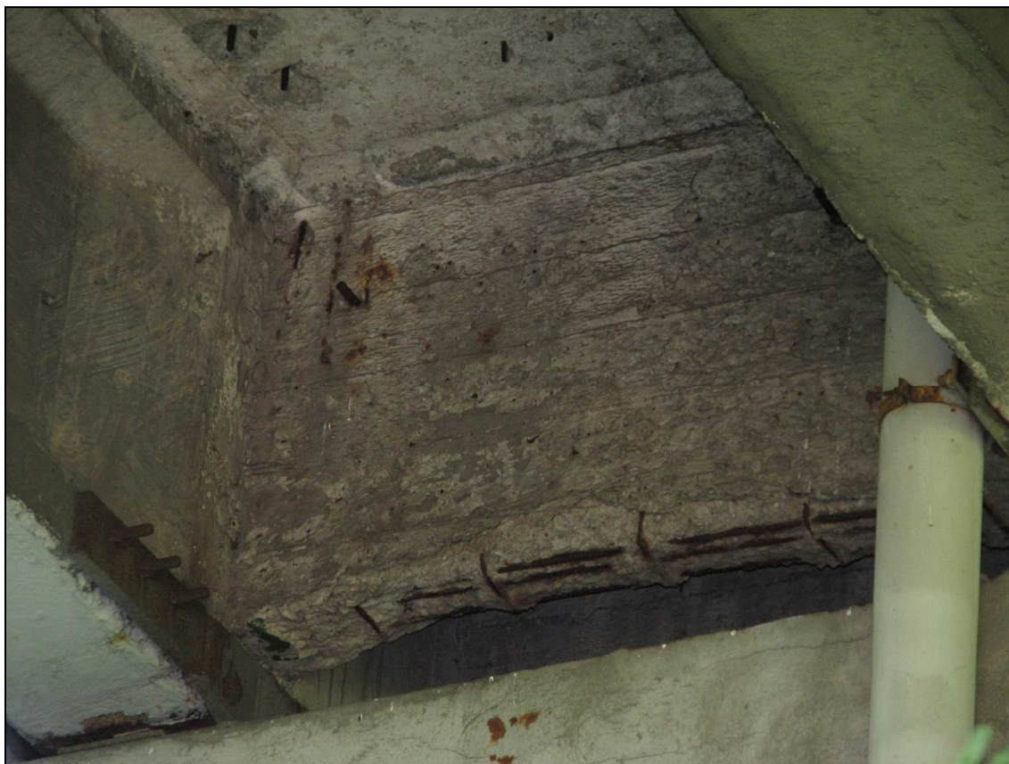
Fot. 40. Przęsło I-J, poprzecznica nad podporą J pomiędzy belką nr 7 i 8. Rozległe ubytki otuliny zbrojenia.
