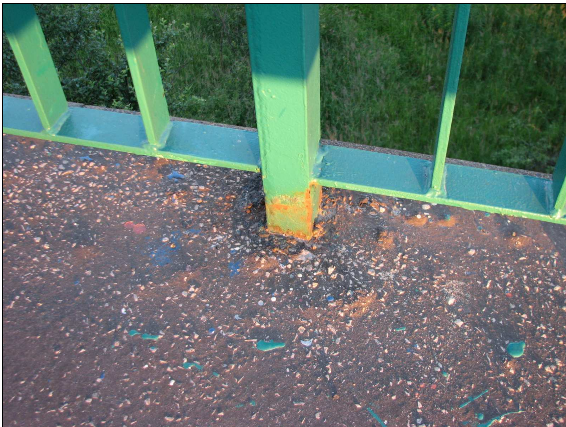
Fot. 75. Typowe uszkodzenie balustrady – korozja powierzchniowa w dolnej części słupków. Występuje na większości słupków.
