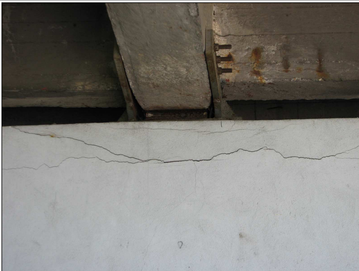
Fot. 60. Typowe uszkodzenia filarów w części betonowej wiaduktu: przykład spękań o rozwartości sięgającej 4 mm wzdłuż górnej krawędzi oczepu (na fotografii podpora B). Widoczna również korozja zbrojenia w poprzecznicy.
