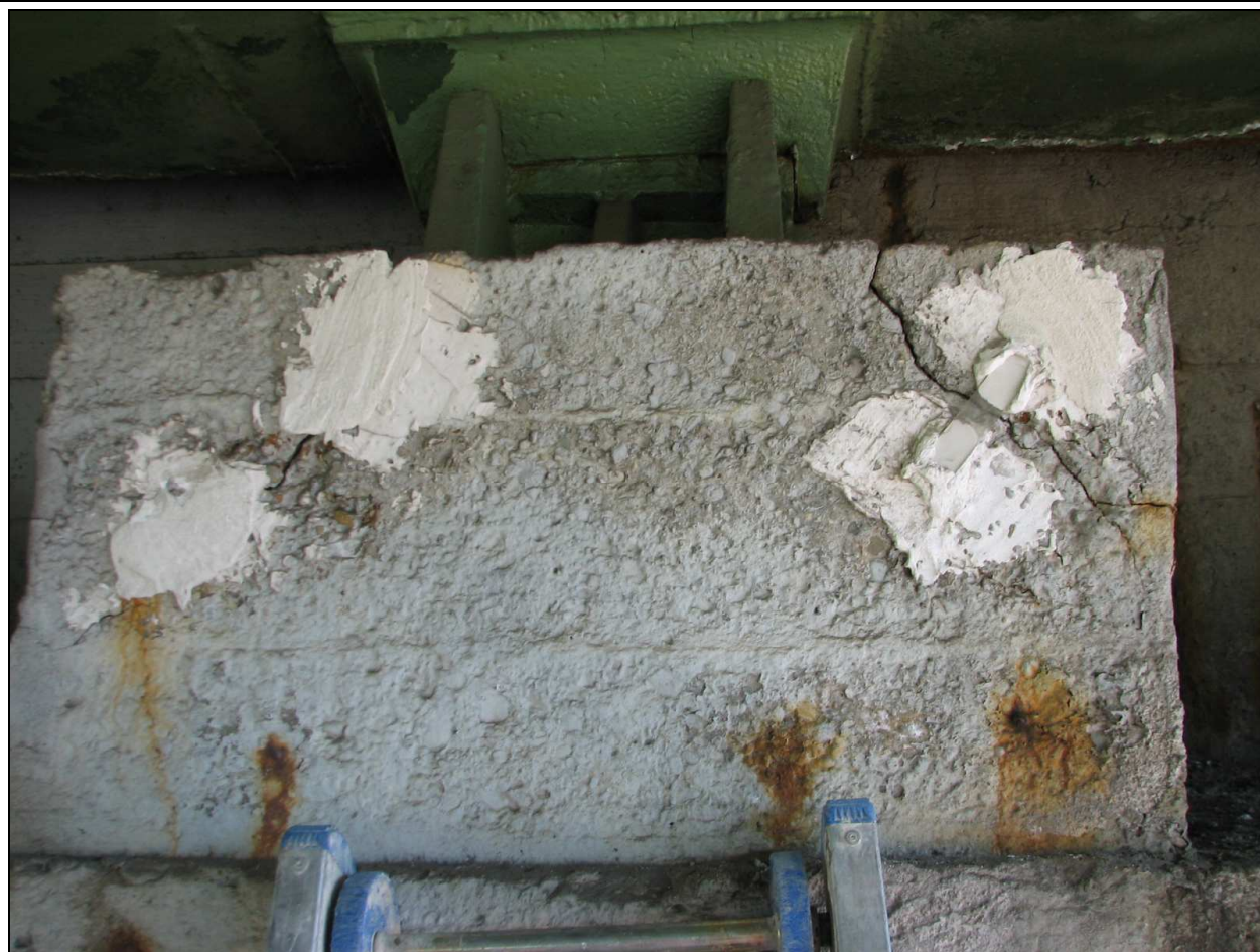
Fot. 64. Podpora E. Spękania ciosu łożyskowego. Stan plomb nie wykazuje propagacji uszkodzenia.
