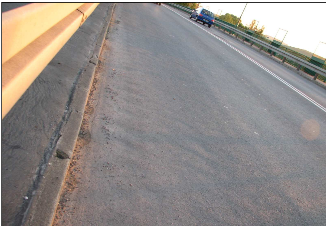
Fot. 23. Niewielkie deformacje (sfalowania) podłużne nawierzchni jezdni przy krawężniku wschodnim na długości przęseł stalowych E-F i F-G. Uszkodzenia spowodowane prawdopodobnie niewystarczającą przyczepnością nawierzchni do podłoża (płyty ortotropowej).
