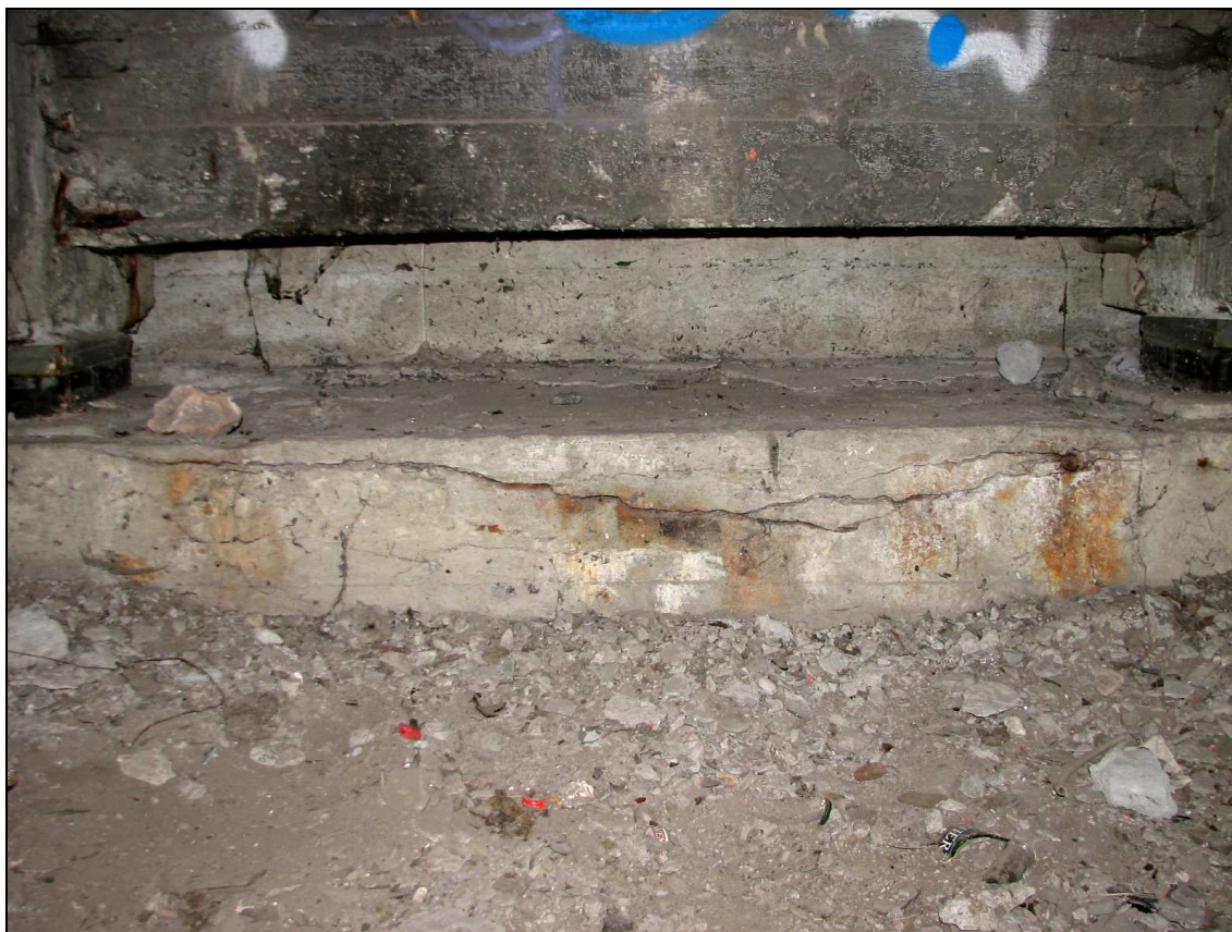
Fot. 57. Podpora P, przyczółek od str. Chrzanova. Spękania poziome betonu ławy podłożyskowej spowodowane korozją zbrojenia. Występują na 3/4 szerokości ściany czołowej.
