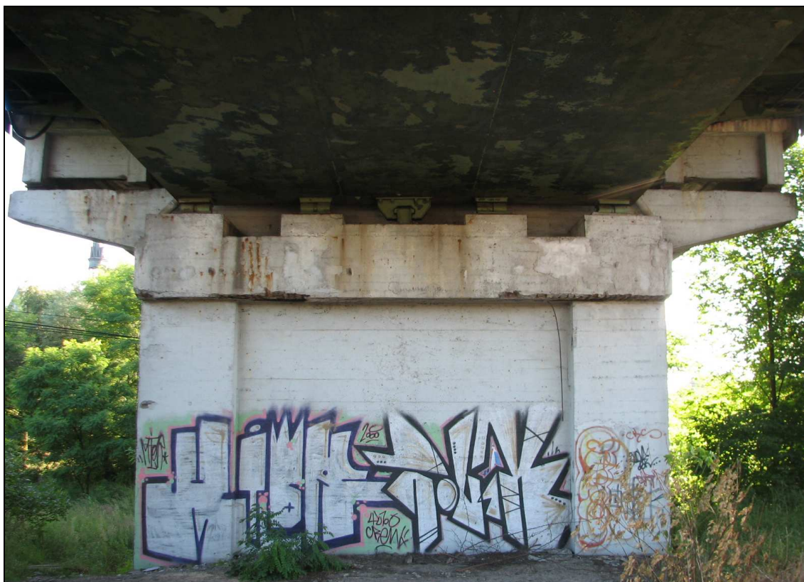
Fot. 14. Podpora pośrednia pomiędzy częścią stalową i betonową od str. Chrzanowa, z łożyskami wałkowymi dla części stalowej
