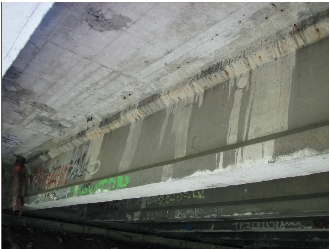
Fot. 34. Przęsło O-P, belka nr 7. Rdzawe plamy świadczące o korozji zbrojenia w półce górnej belki. Zacieki świadczące o korozji ługującej w płycie pomostu. Widoczne również ubytki betonu w płycie pomostu.
