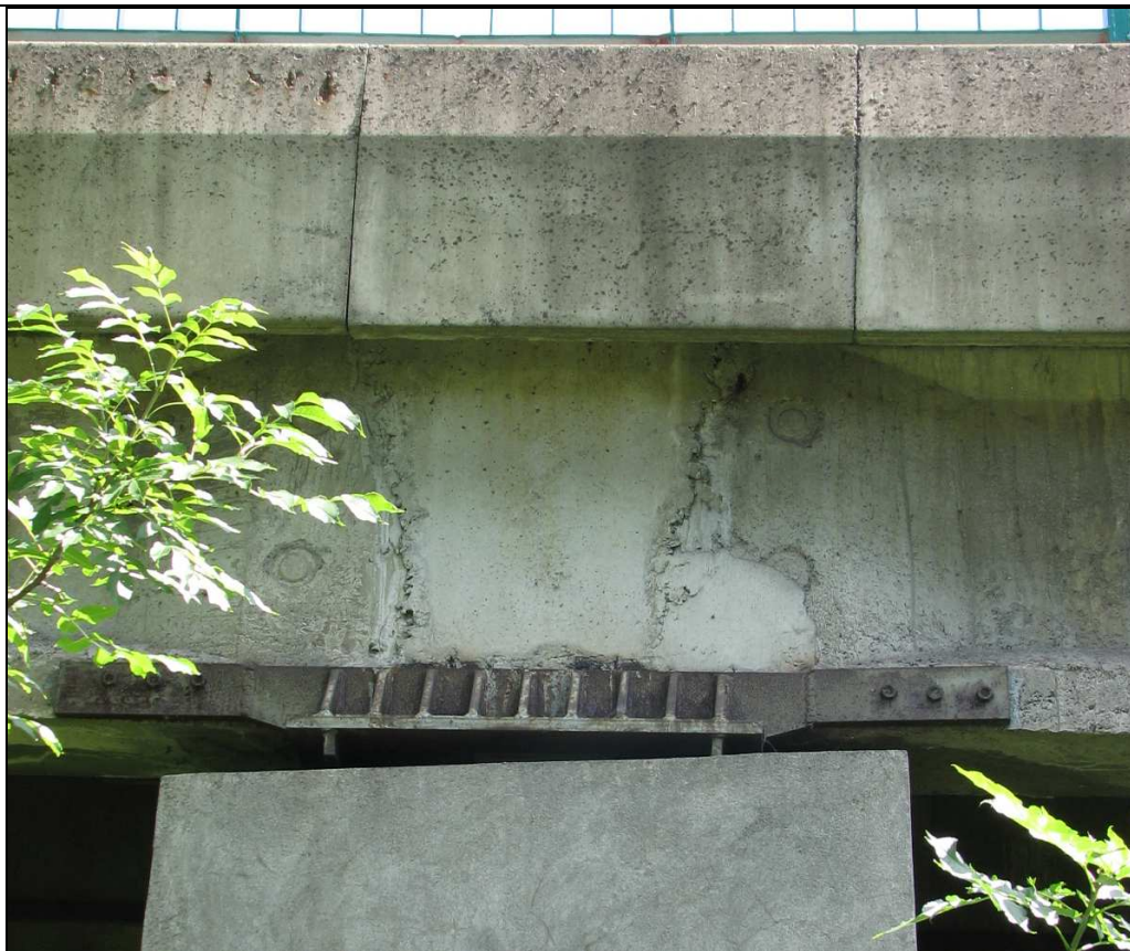
Fot. 6. Część betonowa wiaduktu – widok węzła uciągającego nad filarem
