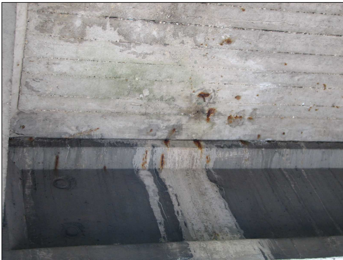
Fot. 41. Przęsło B-C, płyta pomostu pomiędzy belkami nr 7 i 8. Korozja betonu i zbrojenia w miejscu „starego” przecieku przez płytę. Korozja zbrojenia w półce górnej dźwigara.
