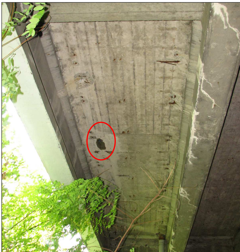
Fot. 49. Przęsło M-N. Ubytki betonu i odsłonięte zbrojenie w płycie pomostu pomiędzy belkami nr 7 i 8. Widoczna wilgotna plama świadcząca o aktywnym przecieku przez płytę.
