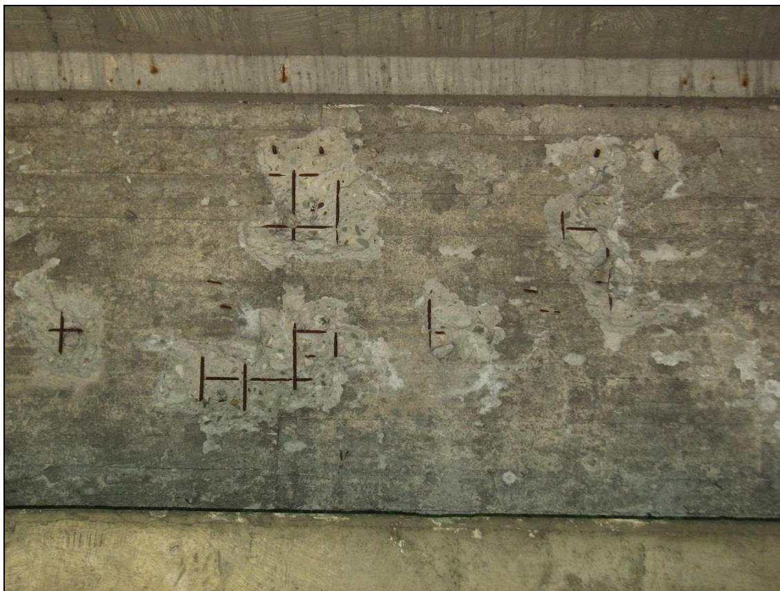
Fot. 44. Przęsło I-J. Liczne ubytki betonu o głębokości do 4 cm odsłaniające korodujące powierzchniowo zbrojenie płyty pomiędzy belkami nr 7 i 8.
