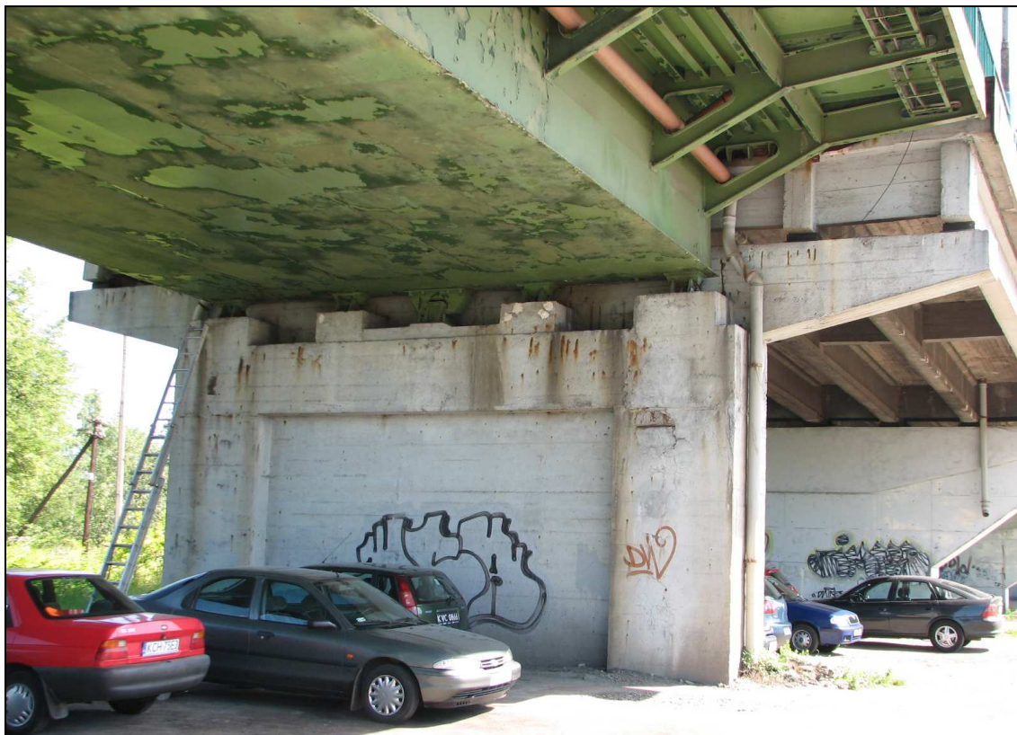
Fot. 13. Podpora pośrednia pomiędzy częścią stalową i betonową od str. Trzebini, z łożyskami stałymi dla części stalowej
