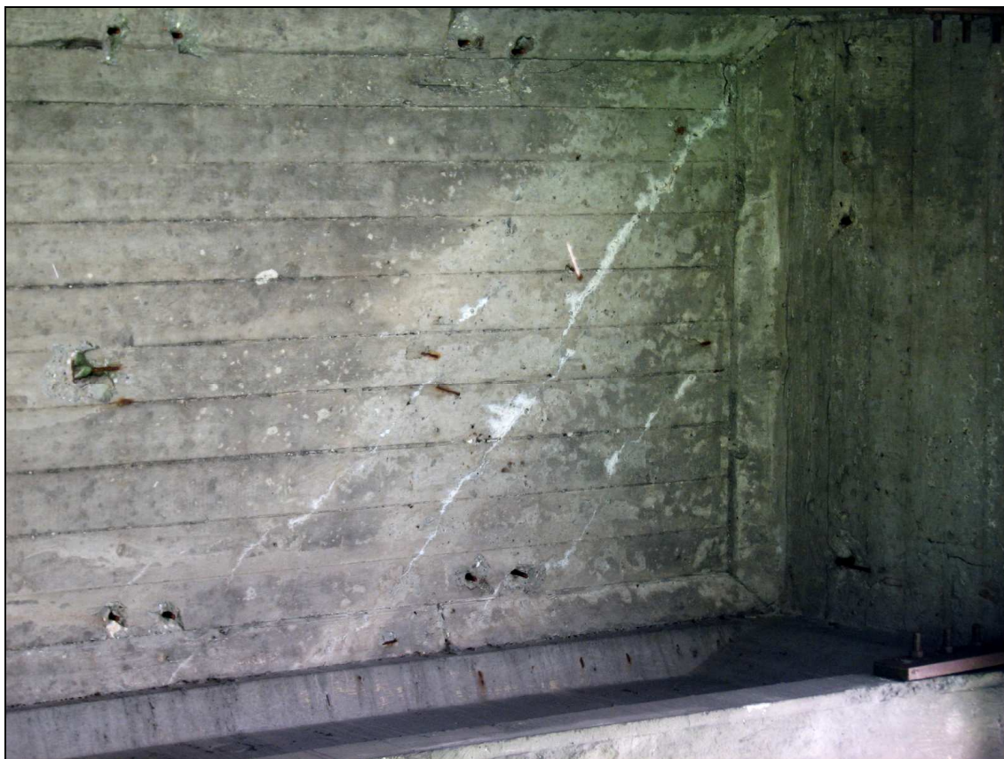
Fot. 47. Przęsło J-K, płyta pomiędzy belkami nr 1 i 2 nad podporą J. Przykład zarysowania ukośnego płyty pomostu (występuje w kilku narożnych polach płyty na długości wiaduktu), Widoczne wystające z płyty korodujące końcówki prętów.
