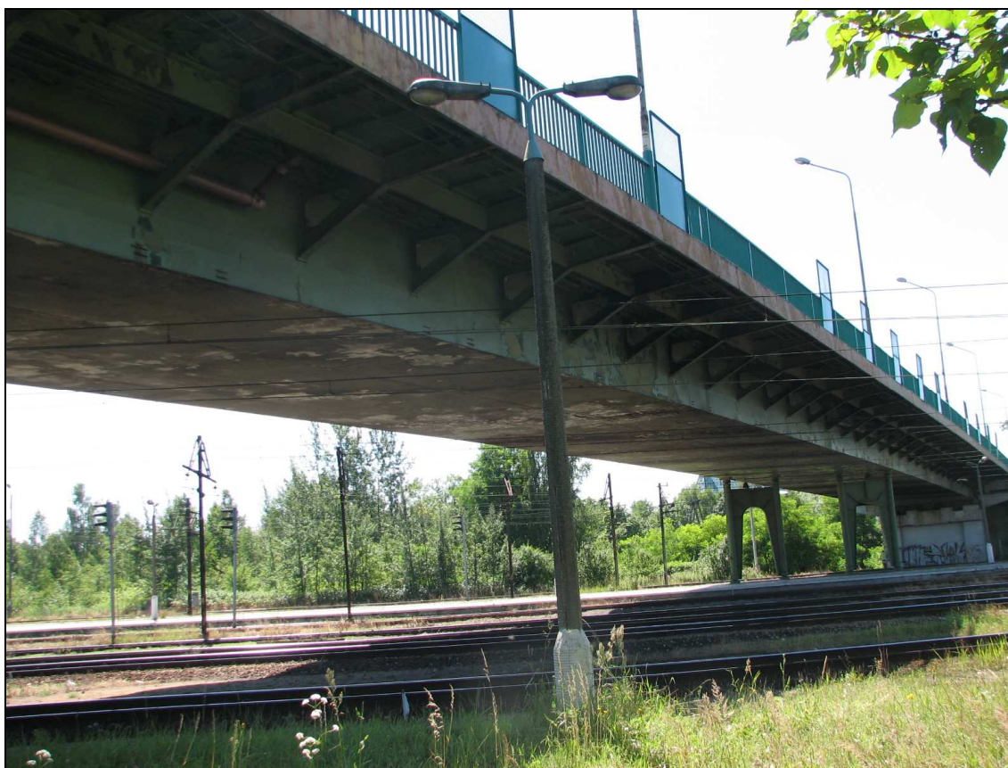
Fot. 10. Część stalowa wiaduktu – widok od spodu.
