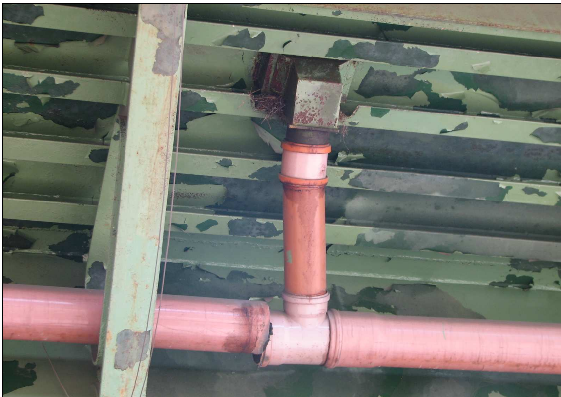
Fot. 30. Przerwany kolektor odwodnienia w prześle E-F nad ul. Dworcową
