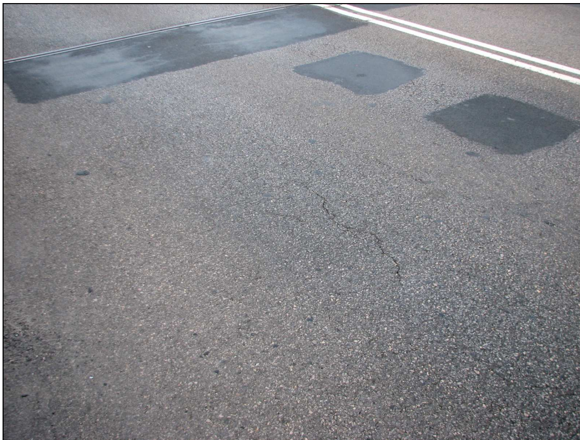
Fot. 19. Dojazd od str. Chrzanowa. Liczne spękania podłużne i poprzeczne nawierzchni na całej szerokości jezdni
