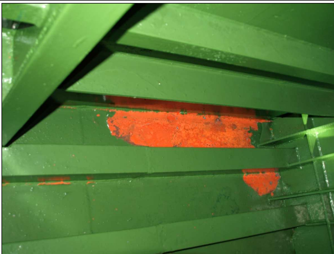
Fot. 54. Typowe uszkodzenie powłoki malarskiej wewnątrz przekroju skrzynkowego. Odpryski o powierzchni jednostkowej do 0,5 m 2 występują z różną intensywnością na całej długości konstrukcji. Łączna powierzchnia odprysków wynosi ok. 15 m 2 .
