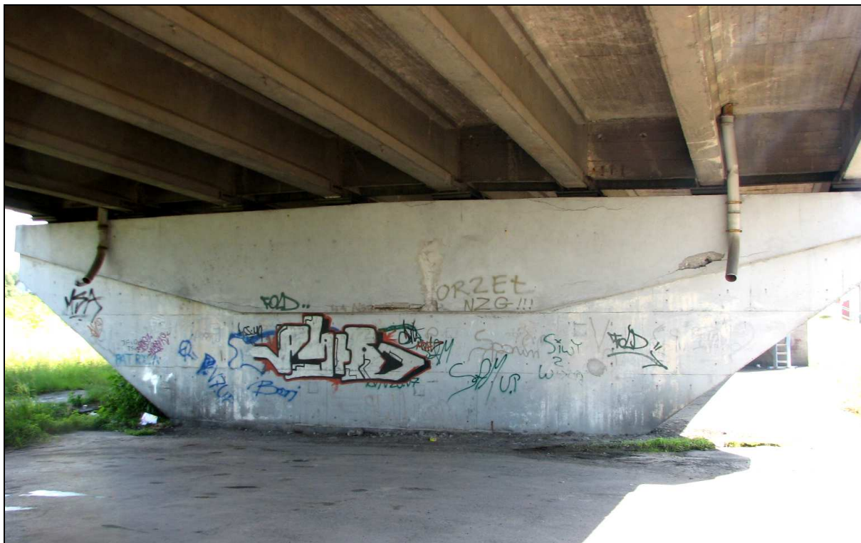
Fot. 59. Typowe uszkodzenia filarów w części betonowej wiaduktu: spękania równoległe do krawędzi górnej i dolnej oczepu oraz lokalne ubytki betonu spowodowane korozją zbrojenia (na fotografii podpora B).
