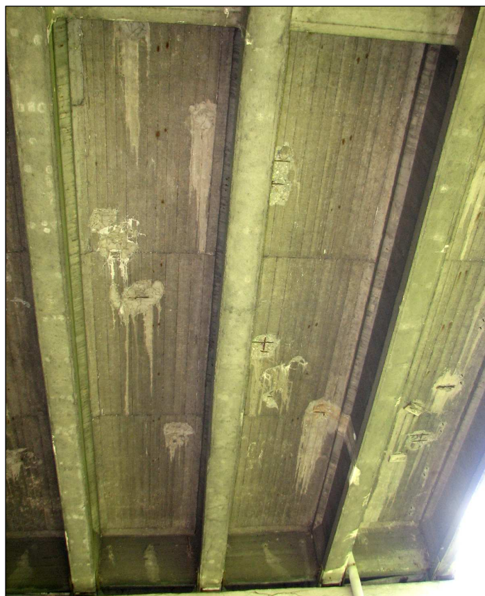
Fot. 46. Przęsło J-K. Liczne ubytki betonu i odsłonięte zbrojenie w płycie pomostu pomiędzy belkami nr 1, 2 i 3. Widoczne deski pozostawione po naprawie ubytków betonu.
