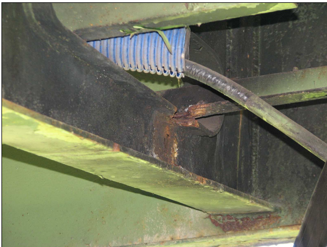
Fot. 72. Przepalony w czasie awarii kabla energetycznego element wspornika podchodnikowego - wspornik wschodni nad podporą H
