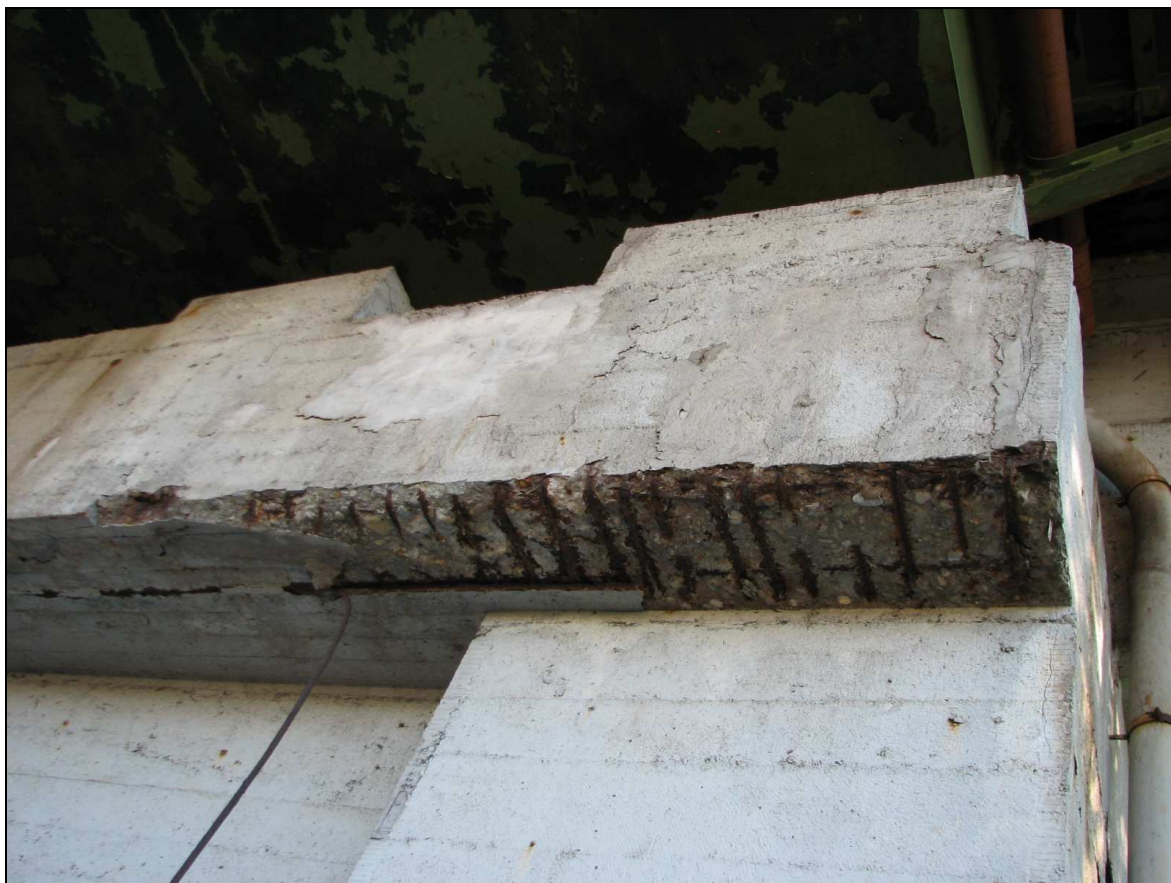
Fot. 68. Podpora H. Rozległe ubytki otuliny spowodowana korozją zbrojenia. Ubytki korozyjne zbrojenia sięgają 20% przekroju.
