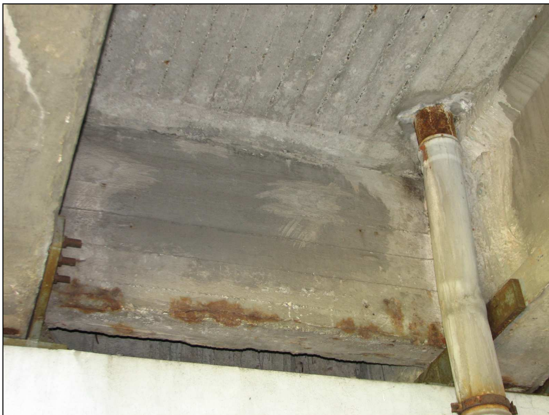
Fot. 39. Przęsło B-C, poprzecznica nad podporą B pomiędzy belką nr 1 i 2. Rdzawe plamy świadczące o korozji zbrojenia dolnego poprzecznicy. Przecieki przy wpuście, korozja rury spustowej.
