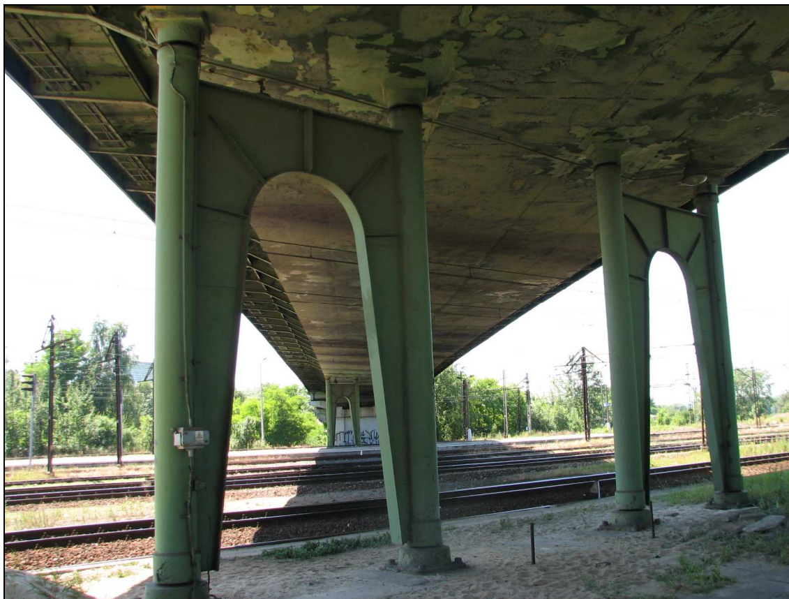
Fot. 12. Część stalowa wiaduktu – widok filara słupowego
