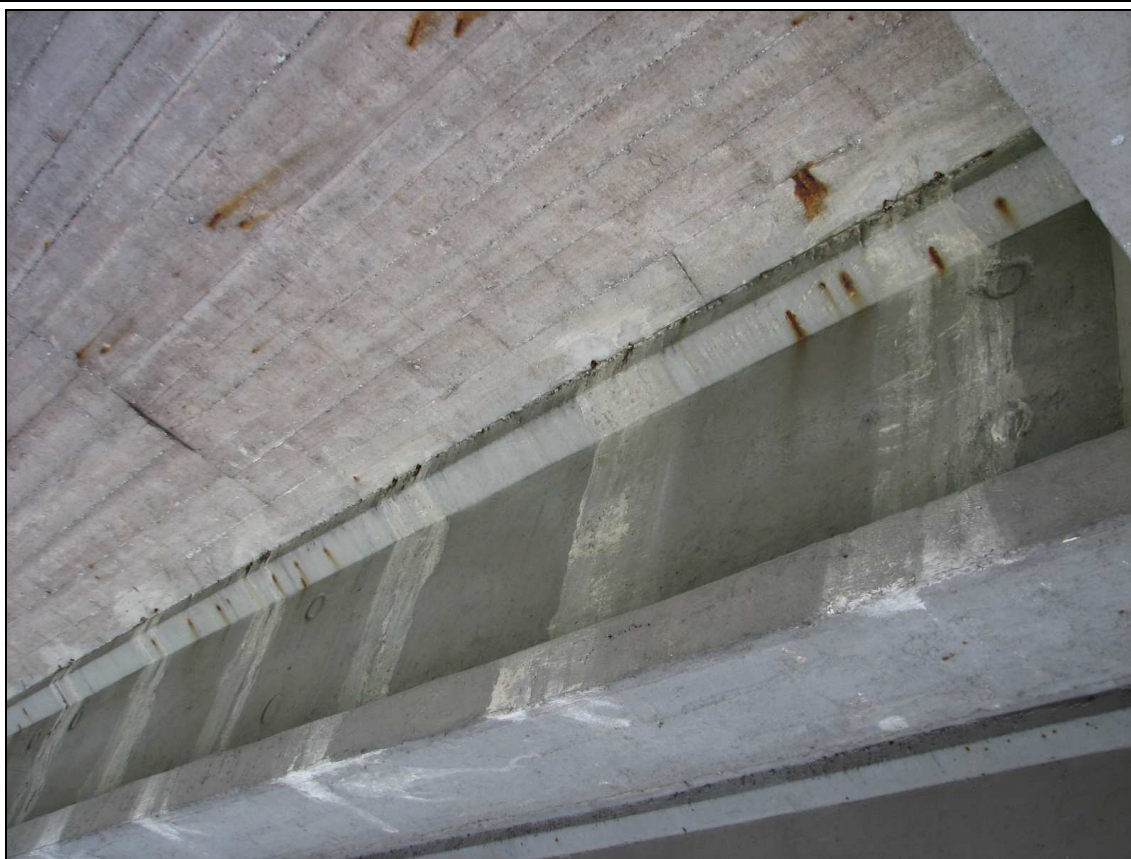
Fot. 32. Przęsło A-B, belka nr 7. Rdzawe plamy świadczące o korozji zbrojenia w półce górnej belki. Zacieki na belce z otworów w płycie pomostu. Korozja zbrojenia w płycie.
