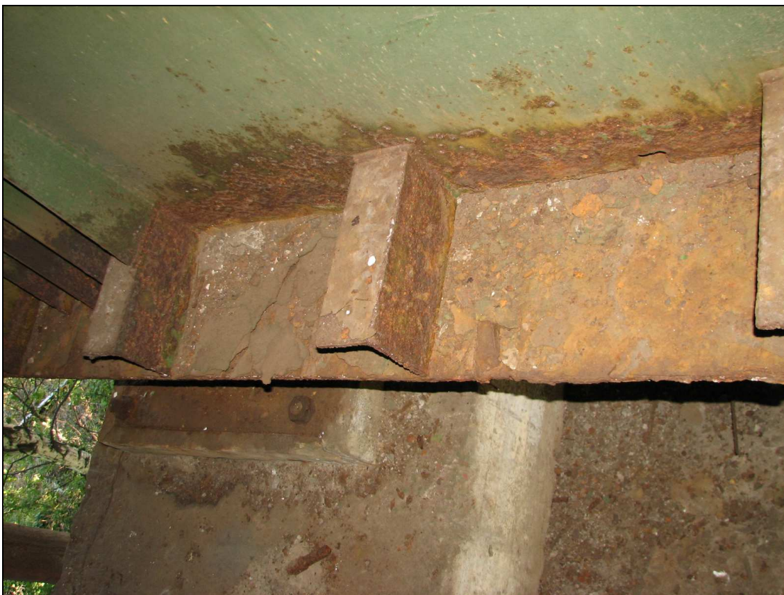
Fot. 52. Intensywna korozja konstrukcji stalowej nad podporą H, spowodowana przeciekami przez dylatację.
