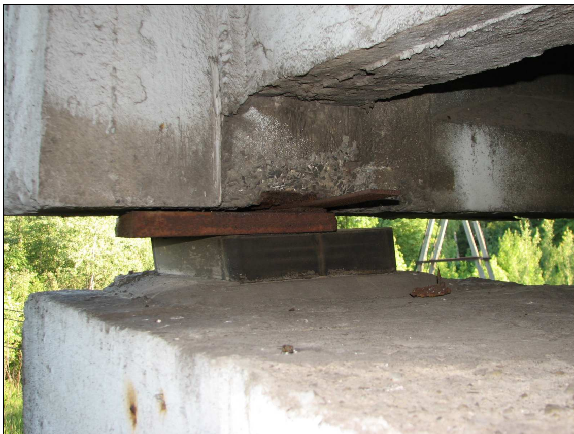
Fot. 70. Łożysko skrajne wschodnie części betonowej na podporze H. Wysunięta z nad łożyska górna blacha stalowa, nie zapewniająca odpowiedniego podparcia dźwigara.
