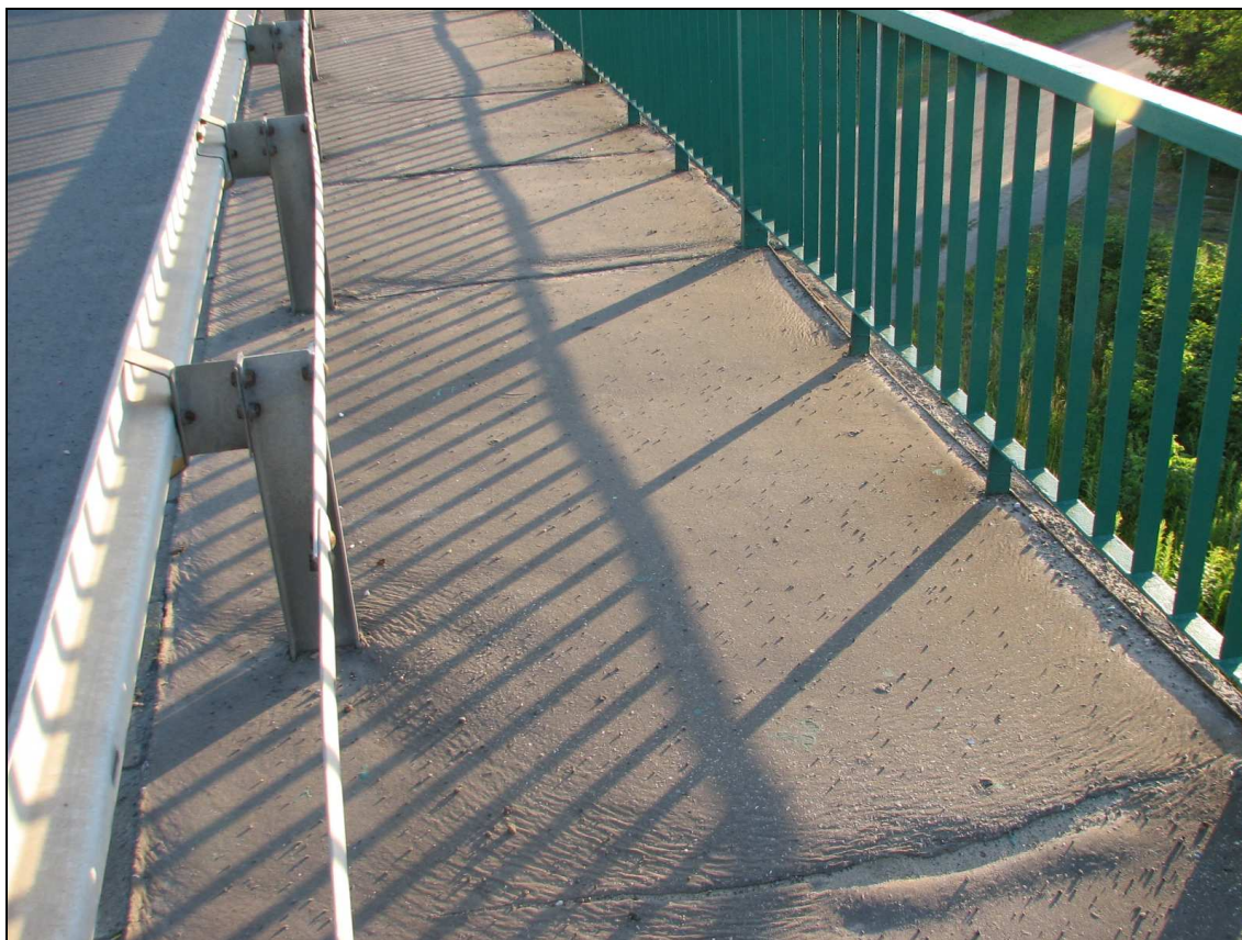
Fot. 25. Typowe uszkodzenie nawierzchni chodników na długości przęseł stalowych – regularne spękania i spływy podłużne.
