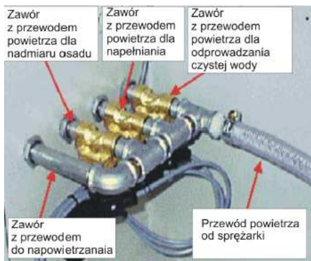
Zdjęcie 5 Dystrybucja sprężonego powietrza w szafie sterowniczej ( przykład wykonania)
